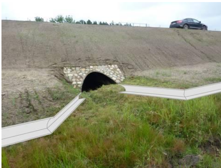
Ryc. 10. Schemat wbudowania płotka przy przejściu dla małych zwierząt w km 92+975
