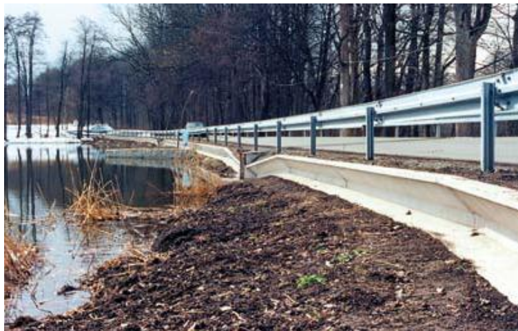
Ryc.2. Ogrodzenie ochronno – naprowadzające z prefabrykatów betonowych
