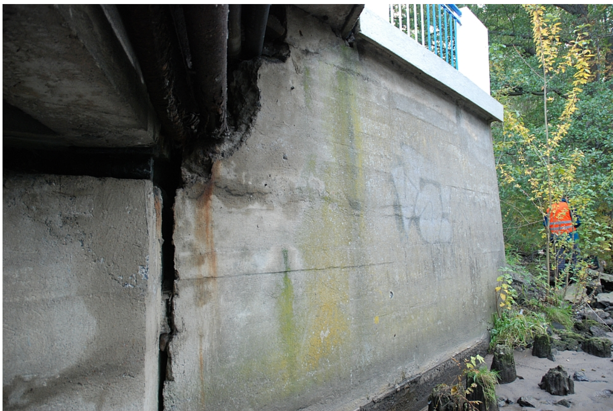
Fot. 8. Zniszczone połączenie przyczółków ze ścianami oporowymi
