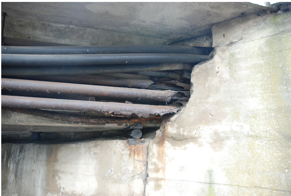
Fot. 10. Zniszczone osłony kablowe
