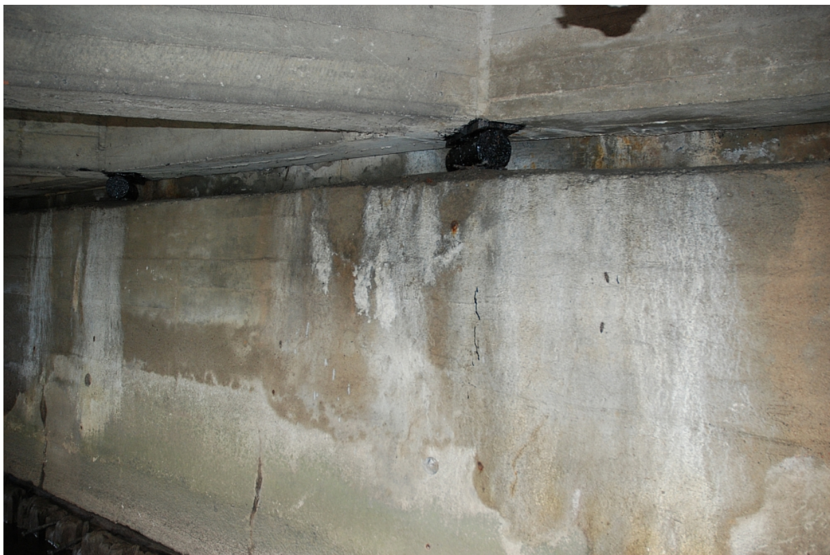
Fot. 6. Zacieki na przyczółku (nieszczelna dylatacja)
