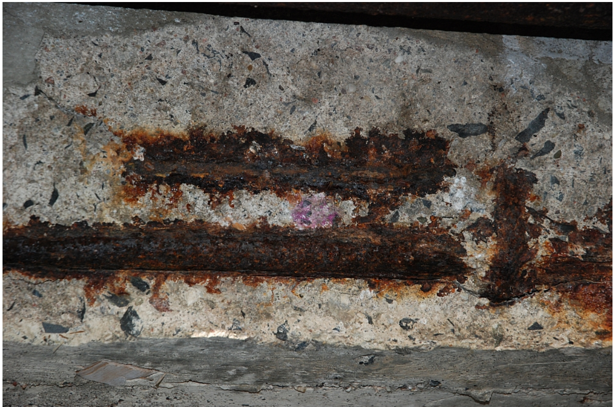
Fot. 4. Zniszczona otulina, skorodowane zbrojenie
