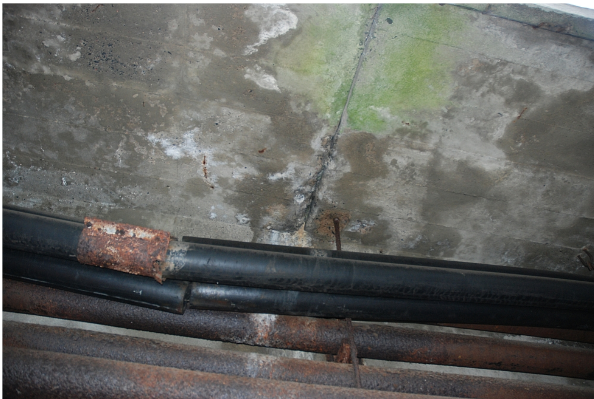
Fot. 9. Nieszczelna szczelina dylatacyjna wsporników pochodnikowych
