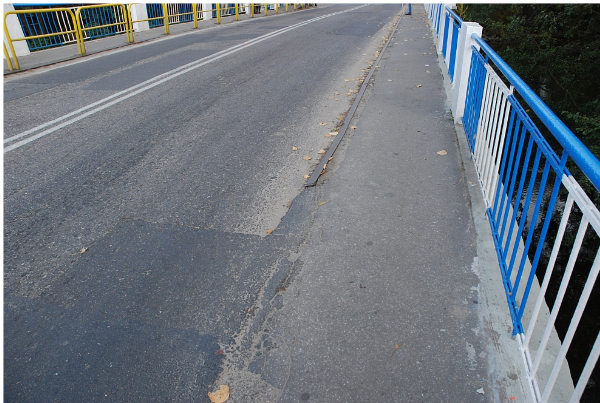
Fot. 11. Zniszczona nawierzchnia i krawężniki
