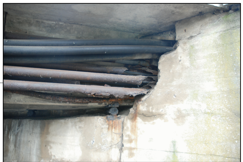
Zniszczone osłony kablowe
