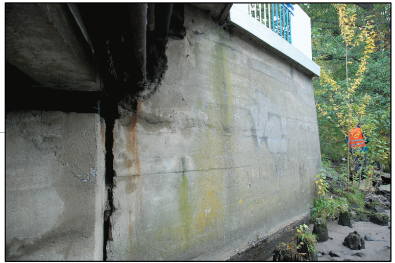
Zniszczone połączenia ścian oporowych z przyczółkami
