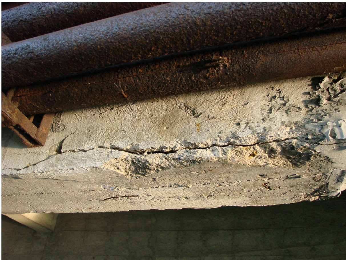
Fot. 5. Zniszczona otulina zbrojenia
