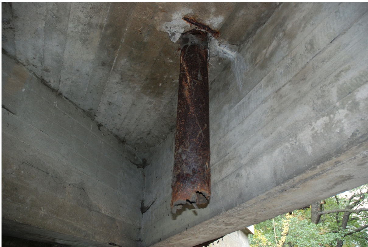
Fot. 7. Odprowadzenie wody z obiektu bezpośrednio do rzeki
