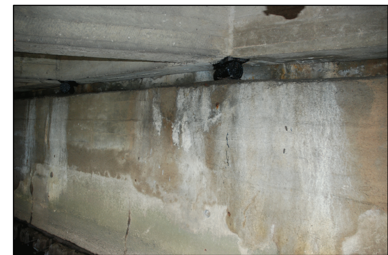
Nieszczelna dylatacja, zacieki na przyczółkach
