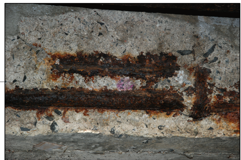
Zniszczona otulina i skorodowane zbrojenie
