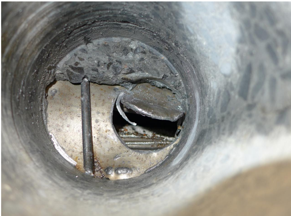
Fot. 3. Odwiert rdzeniowy do kanału kablowego z otwarciem osłony kabla sprężającego. Widoczne pęknięcia w betonie w górnej części przed kanałem kablowym. Odspojenie betonu od osłony łącznika. Widoczny brak iniekcji oraz punktowa korozja lin sprężających.
