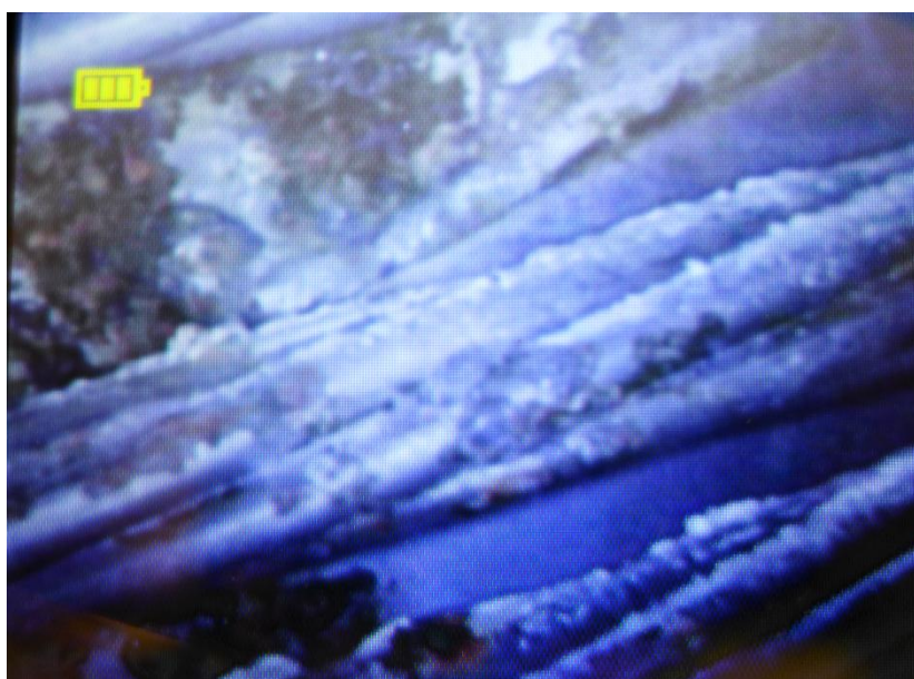
Fot. 7. Obraz wewnątrz kanału kablowego. Brak iniekcji kanału kablowego. Korozja osłonki łącznika.
