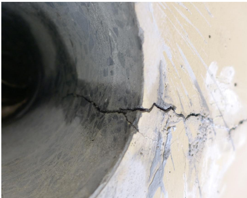
Fot. 4. Odwiert do kanału kablowego od strony zewnętrznej. Widoczna szczelina w betonie biegnąca od lica belki do kanału kablowego. Rozwartość szczeliny 1.5mm.
