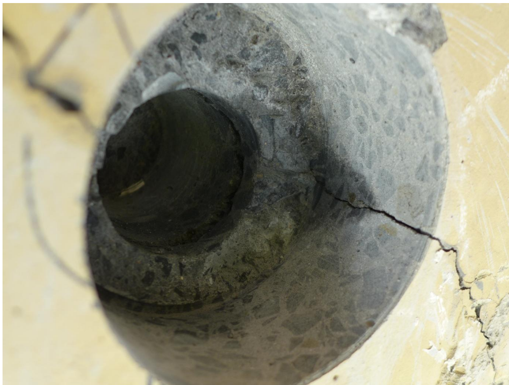
Fot. 5. Odwiert w dolnej części belki do kanału. Widoczna szczelina w betonie biegnąca od lica belki w głąb na głębokość około 8cm. Widoczna szczelina pionowa wewnętrzna na głębokości około 8cm od lica belki.
