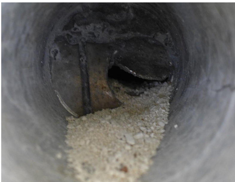
Fot. 6. Obraz iniekcji kanału kablowego. Luźny materiał zalegający w kanale kablowym.
