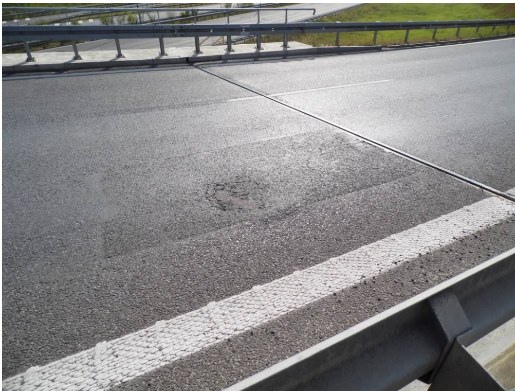
Fot. 6. Widok na nawierzchnię jezdni na wiadukcie w przęśle nr 4 nad przyczółkiem od strony Krakowa. Spękania na wadliwie wykonanej naprawie nawierzchni jezdni, deformacje nawierzchni jezdni wzdłuż profili stalowych urządzenia dylatacyjnego.
