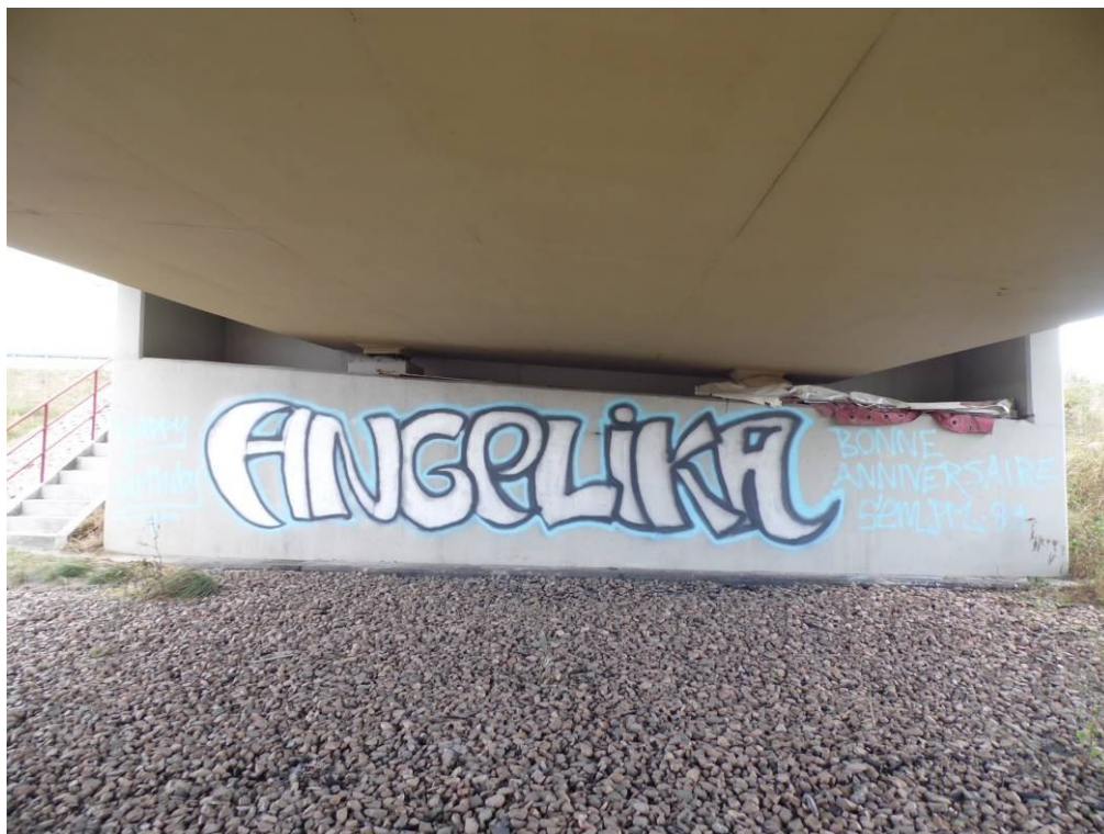
Fot. 41. Widok na przyczółek od strony Wieliczki – zanieczyszczenia w postaci graffiti oraz pozostawiony na ławie łóżyskowej namiot służący do piaskowania.
