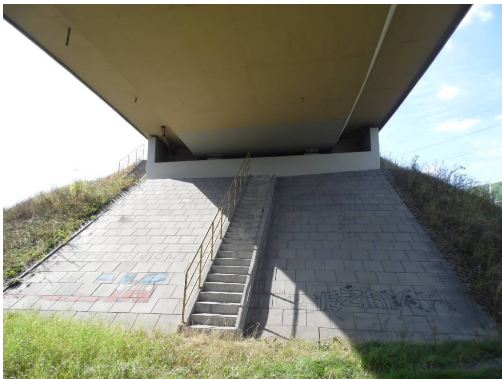
Fot. 44. Widok na przyczółek od strony Krakowa – brak uszkodzeń przyczółka, zanieczyszczenia umocnienia skarpy przyczółka w postaci graffiti.
