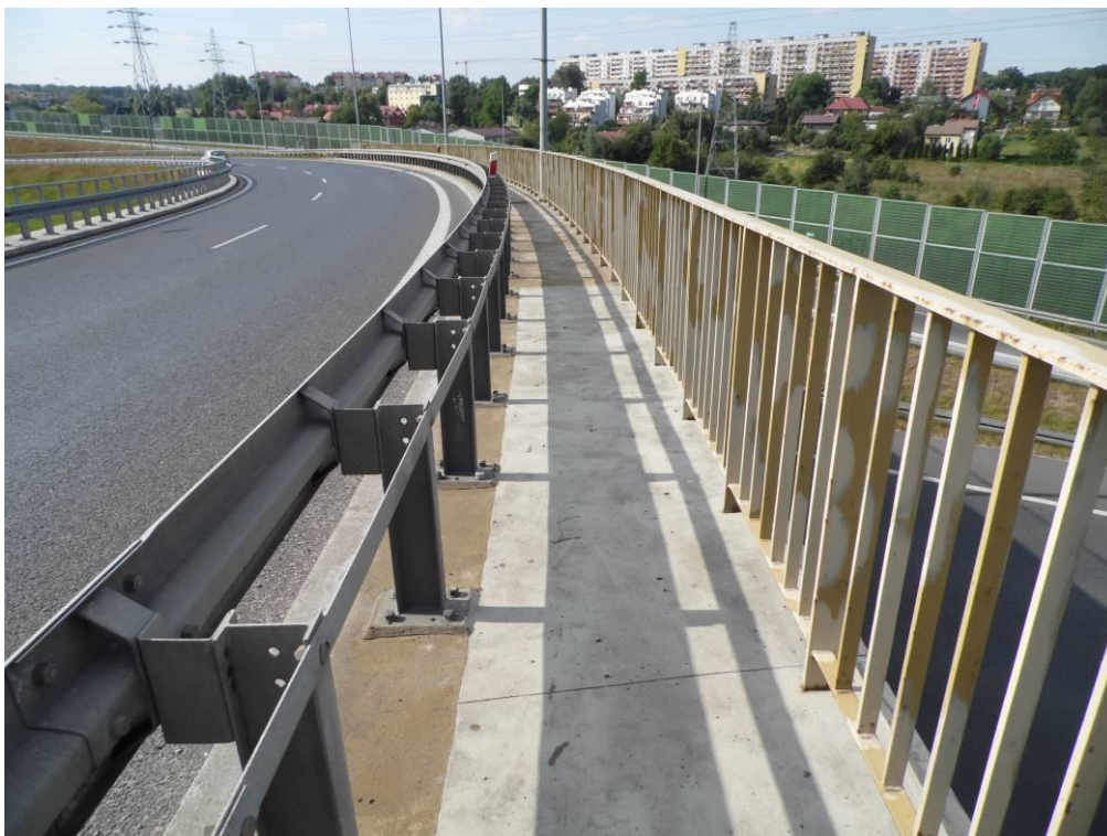
Fot. 21. Widok na balustradę oraz barierę od strony Tarnowa w prześle nr 2. Wstępne przygotowanie balustrady do malowania.
