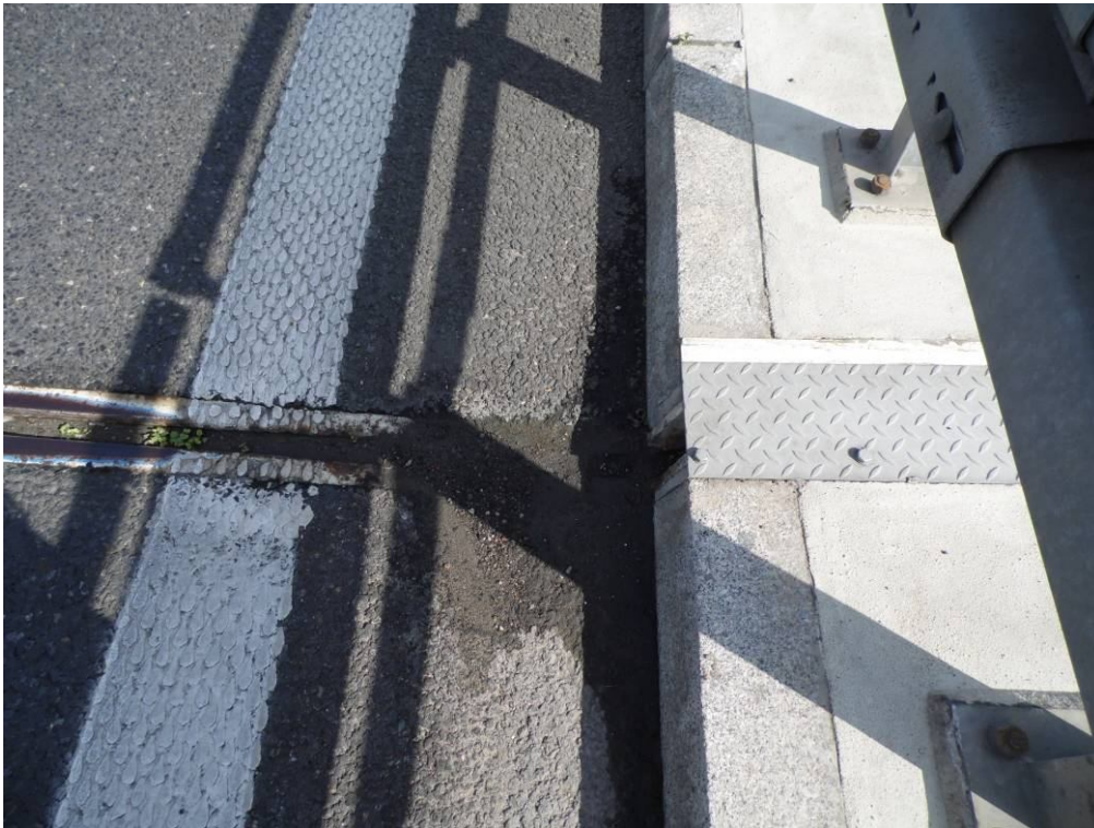
Fot. 33. Widok na urządzenie dylatacyjne nad przyczółkiem od strony Krakowa – zanieczyszczenia wkładki urządzenia dylatacyjnego.
