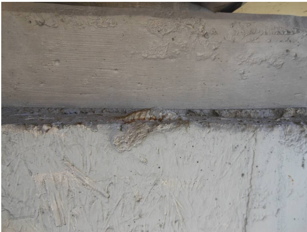
Fot. 52. Widok na głowicę słupa podpory nr 4 – korodujący odsłonięty częściowo montażowy pręt zbrojeniowy, nierówna powierzchnia betonu słupa.
