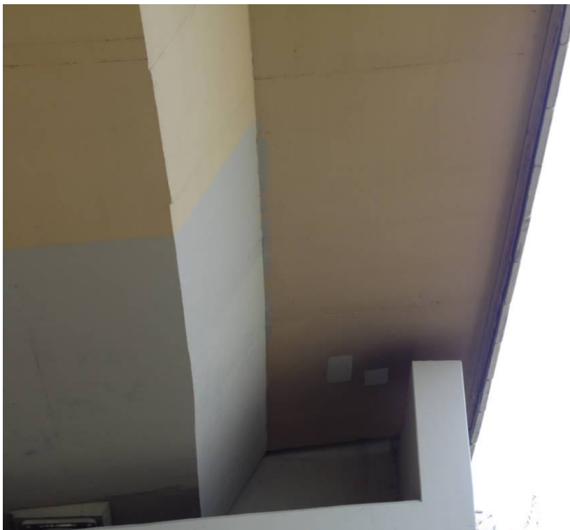
Fot. 38. Widok na oparcie dźwigara na przyczółku od strony Krakowa – widoczne ślady napraw dźwigara, które zostały przykryte powłoką malarską o źle dobranym kolorze.
