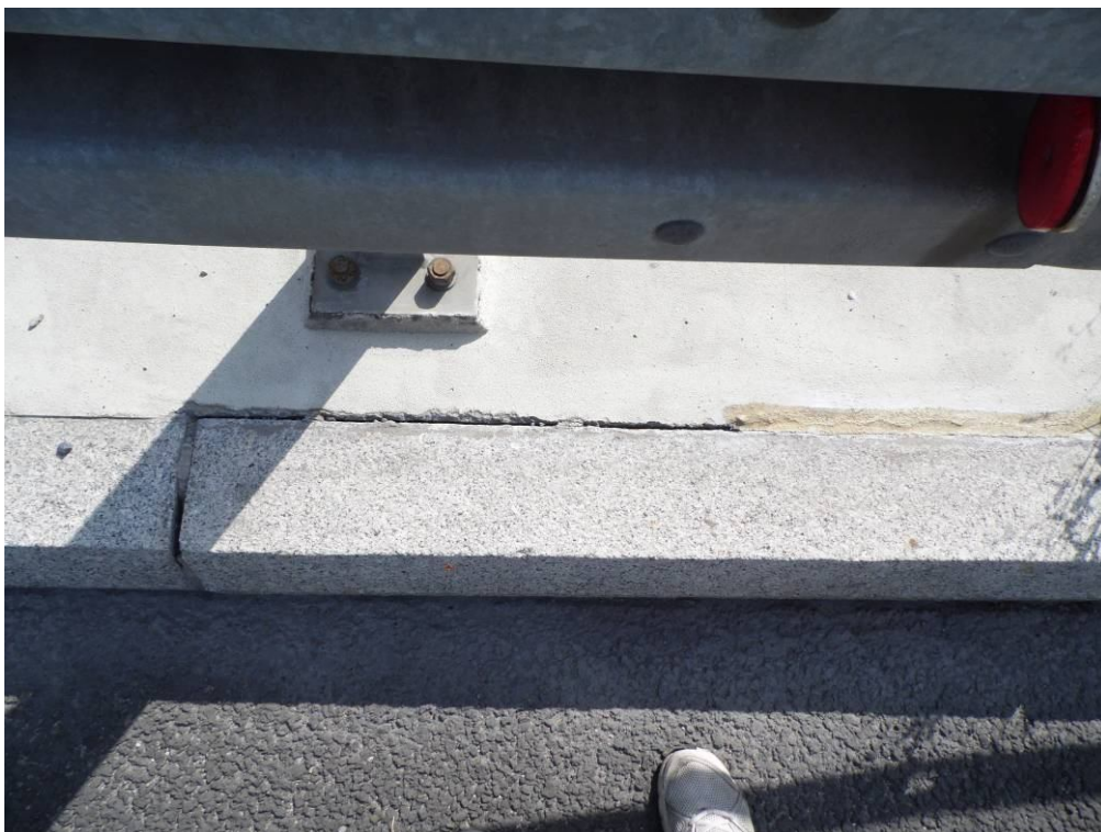
Fot. 7. Widok na pierwszy krawężnik na kapie chodnikowej od strony Katowic na dojeździe od strony Krakowa. Ubytki wypełnienia szczeliny pomiędzy kapą chodnikową a krawężnikiem oraz na styku krawężników.
