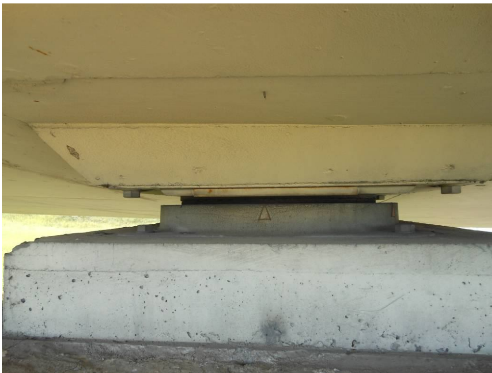
Fot. 55. Widok na łożysko na podporze nr 2 – korozja oraz przykrycie powłoką malarską blachy skali przesuwu łożyska.
