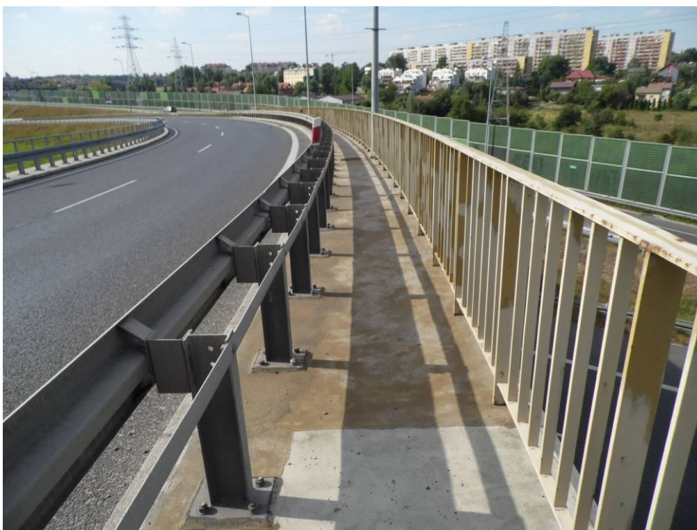
Fot. 12. Widok na chodnik od strony Tarnowa w przejściu nr 2. Widoczne ślady napraw nawierzchni chodnika.
