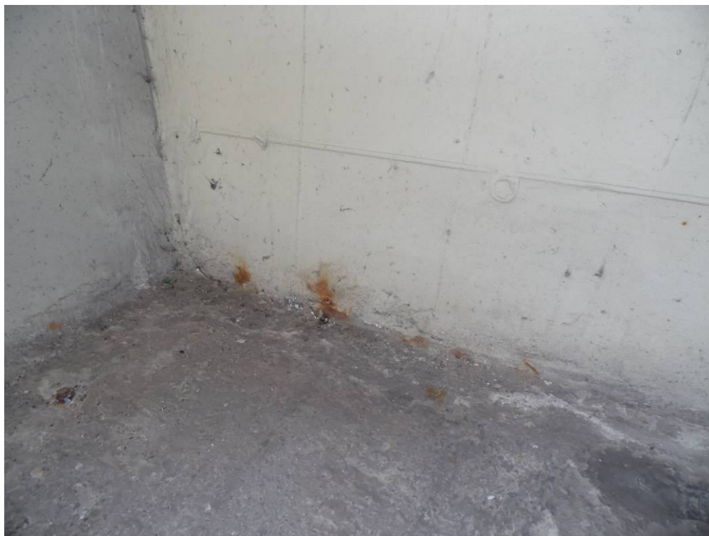
Fot. 47. Widok na styk ścianki zapleczej i ławy łóżyskowej przyczółka od strony Krakowa – rdzawe plamy powstałe w wyniku korozji stalowych zanieczyszczeń w betonie.
