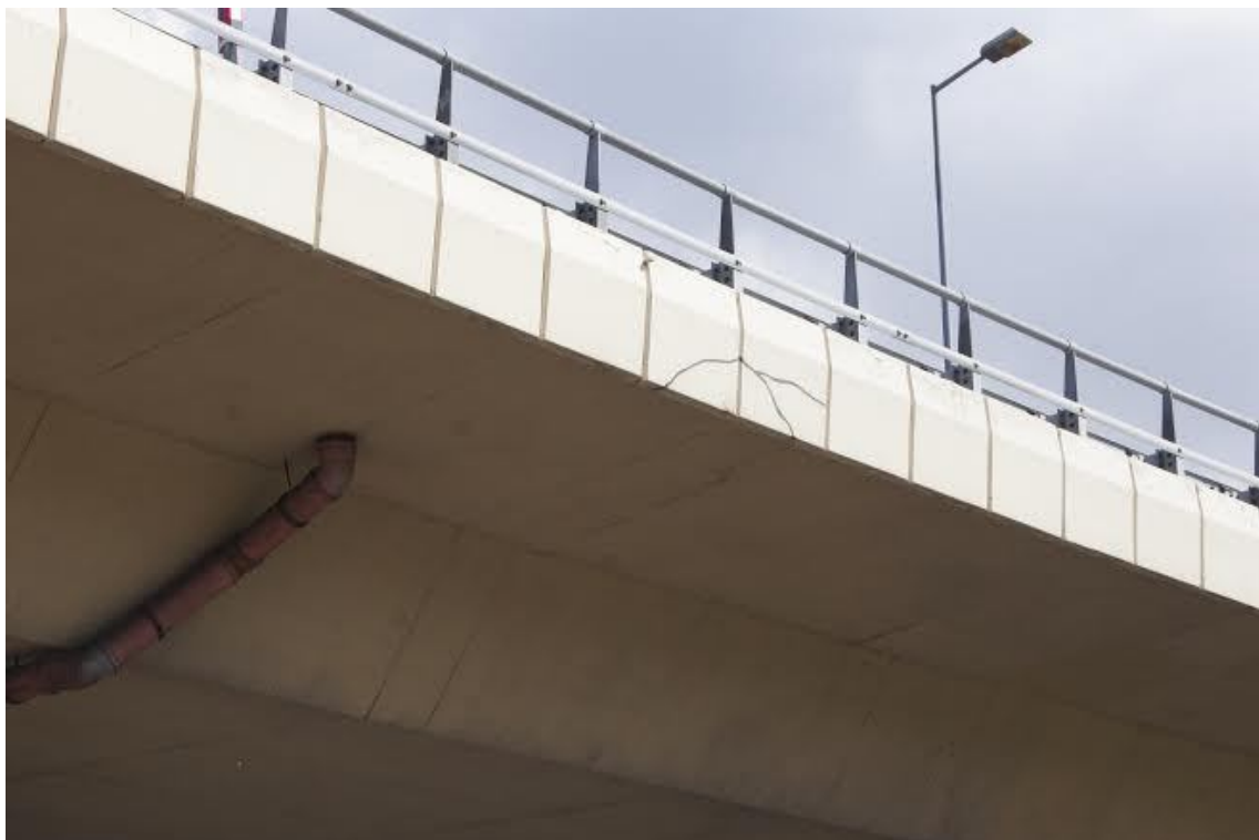
Fot. 15. Widok od strony Katowic na gzyms w przęśle nr 2. Pęknięcia dwóch desek gzymsowych powstałe wskutek nieostrożnej pracy sprzętu przy budowie autostrady.
