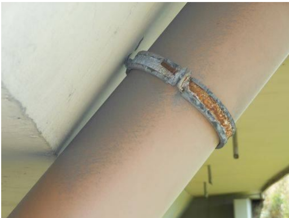
Fot. 27. Widok na kolektor odwodnienia od strony Katowic przy podporze nr 2 – korozja elementów mocowania kolektora.
