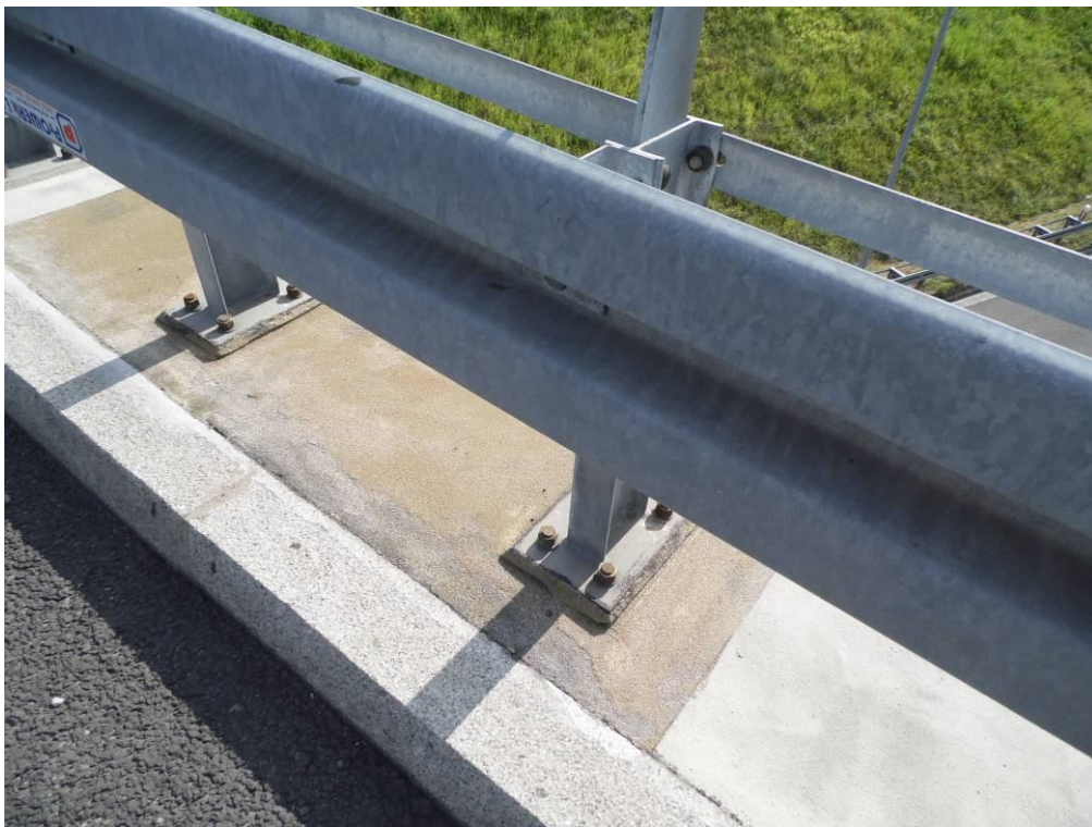
Fot. 10. Widok na barierę od strony Katowic w prześle nr 2. Ślady naprawy nawierzchni chodnika, ubytki wypełnienia szczeliny pomiędzy kapą, a krawężnikiem.
