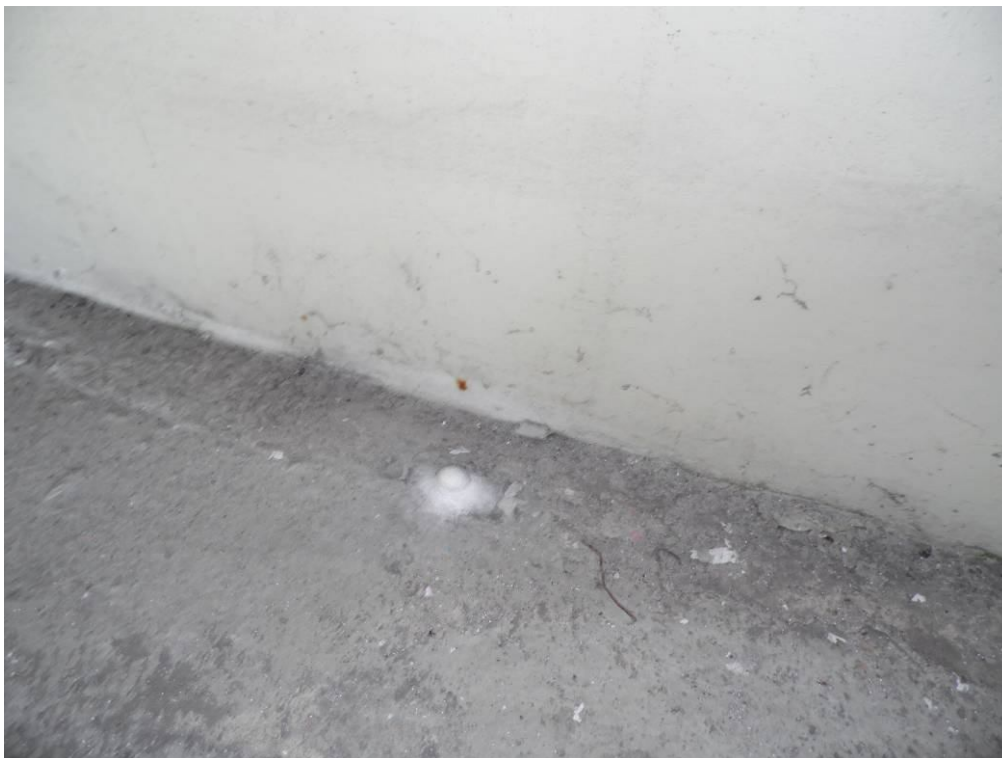
Fot. 46. Widok na styk ścianki zapleczej i ławy żyzyskowej przyczółka od strony Krakowa – rdzawa plama powstała w wyniku korozji stalowych zanieczyszczeń w betonie, wapienny naciek na powierzchni ławy żyzyskowej.
