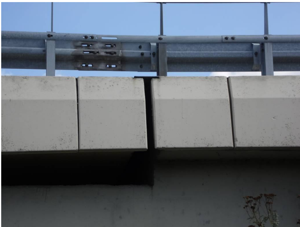
Fot. 31. Widok od strony Katowic na szczelinę dylatacyjną na przyczółku od strony Wieliczki – brak blachy zakrywającej szczelinę.
