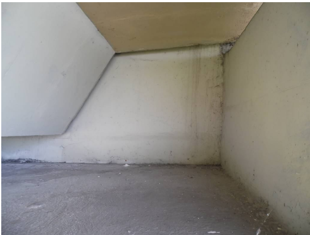
Fot. 45. Widok na ściankę zapleczną przyczółka od strony Krakowa – zacieki na ścianie zapleczej powstałe w wyniku pęknięć nawierzchni jezdni przy urządzeniu dylatacyjnym.
