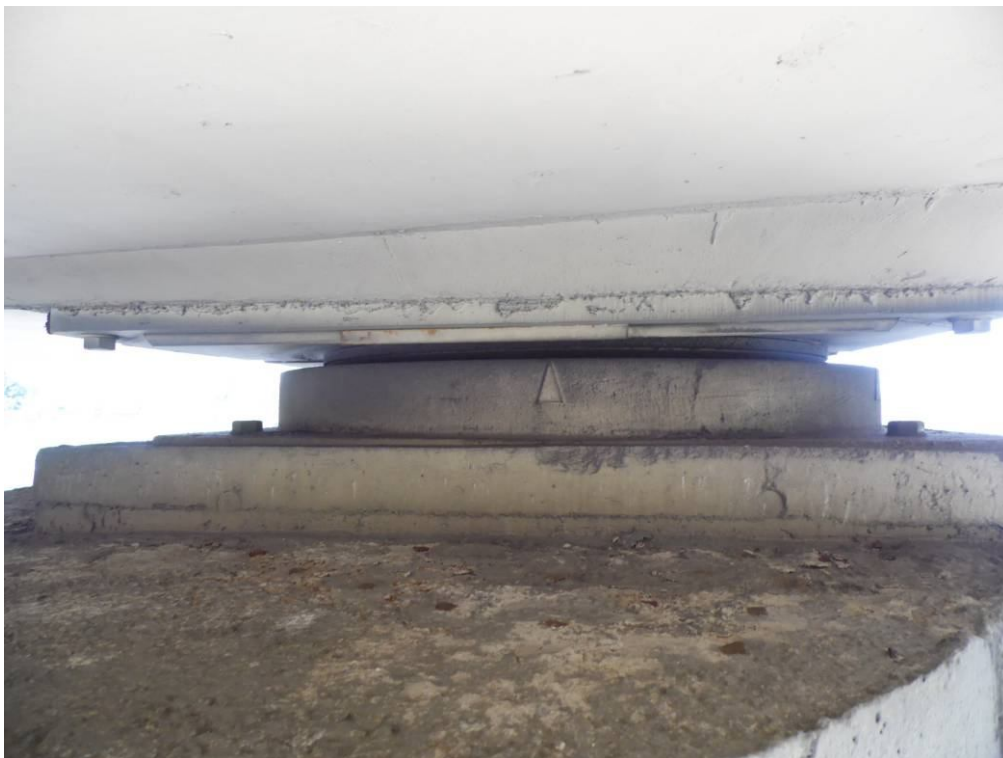
Fot. 56. Widok na łożysko na podporze nr 2 – korozja oraz przykrycie powłoką malarską blachy skali przesuwu łożyska.
