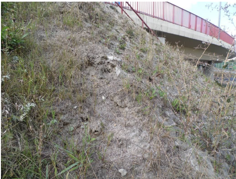
Fot. 59. Widok od strony Tarnowa na umocnienie stożka przyczółka od strony Wieliczki – erozja skarpy tuż za umocnieniem.
