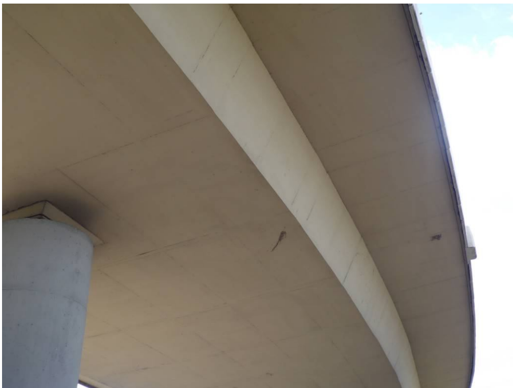
Fot. 37. Widok na pomost w przęśle nr 3 – uszkodzenie mechaniczne na powierzchni dźwigara oraz ubytek betonu na wsporniku podchodnikowym powstałe prawdopodobnie podczas demontażu szalunku.
