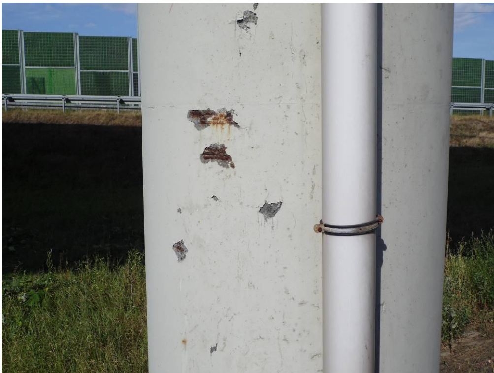
Fot. 54. Widok od strony Katowic na podpórę nr 4 – ubytki betonu wynikające ze zbyt małej otuliny betonu, korozja odsłoniętych prętów zbrojeniowych w wyniku braku otuliny. Przeprowadzony pomiar grubości otuliny zbrojenia wykazał wartości 17-26 mm.
