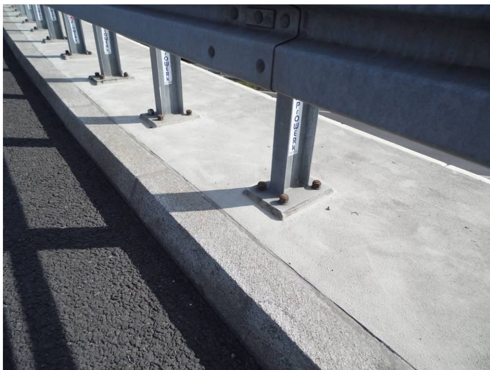
Fot. 17. Widok na balustradę na kapie od strony Katowic. Brak kapturek ochronnych, korozja nakrętek i kotew oraz pozostawione nalepki producenta na słupkach.
