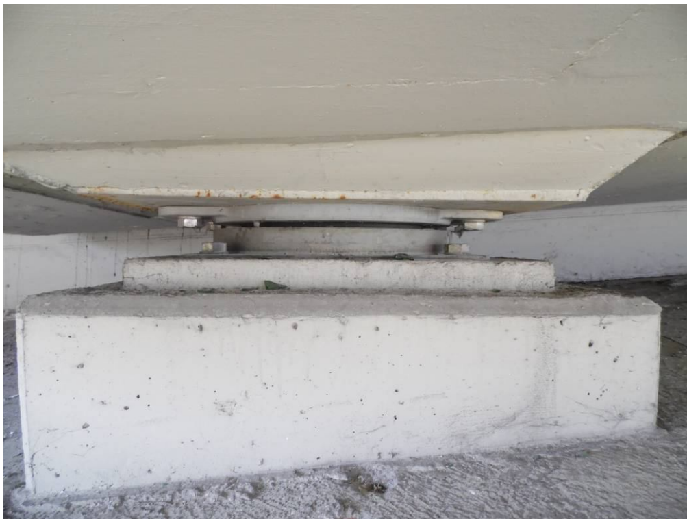
Fot. 58. Widok na łożysko przyczółka od strony Krakowa – rdzawe przecieki powstałe w wyniku korozji blachy kotwiącej łożysko w dźwigarze.
