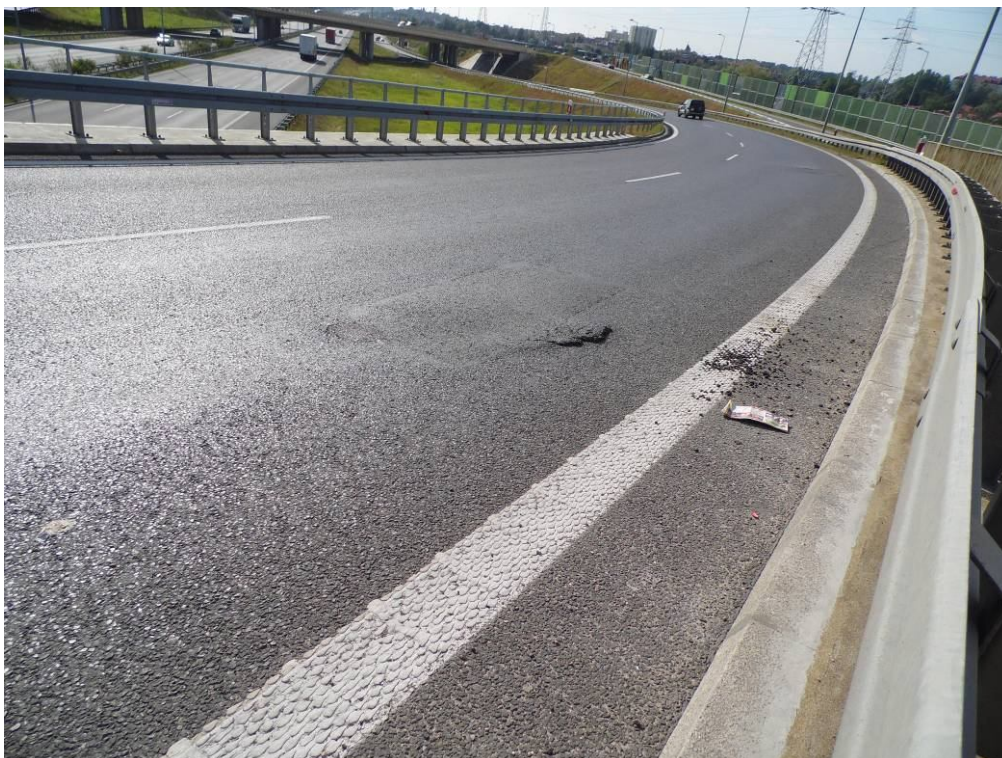
Fot. 5. Widok na nawierzchnię jezdni na wiadukcie w przęśle nr 4. Deformacja na wadliwie wykonanej naprawie nawierzchni jezdni, zanieczyszczenia na powierzchni jezdni.
