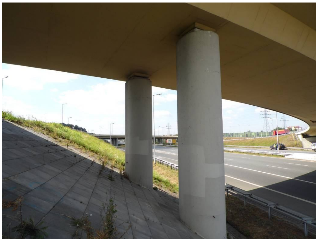
Fot. 48. Widok od strony Tarnowa na podporę nr 2 – widoczne ślady napraw powierzchniowych betonu.
