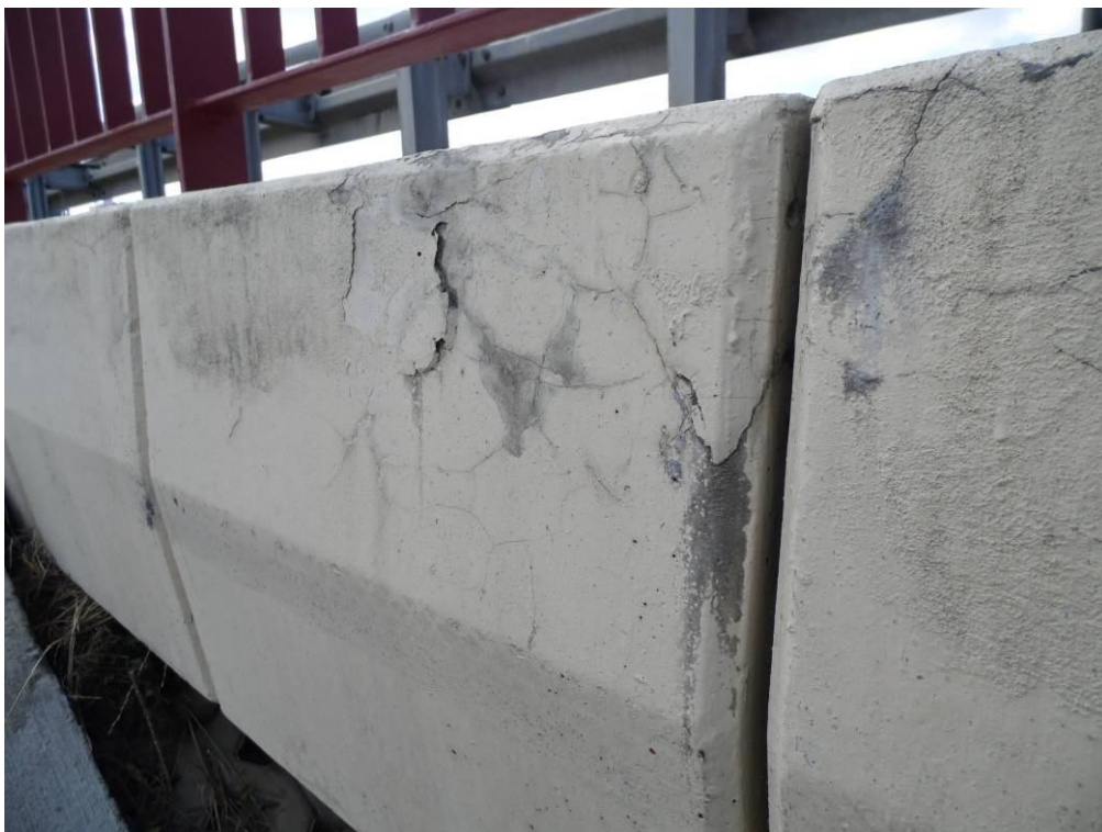
Fot. 13. Widok na gzyms od strony Tarnowa przy przyczółku od strony Wieliczki. Zarysowania skurczowe wyprawy cementowej oraz złuszczenia zabezpieczeń antykorozyjnych deski gzymsowej.
