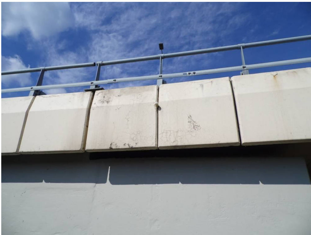
Fot. 14. Widok na gzyms od strony Katowic przy przyczółku od strony Krakowa. Zarysowania skurczowe wyprawy cementowej oraz złuszczenia zabezpieczeń antykorozyjnych deski gzymsowej.
