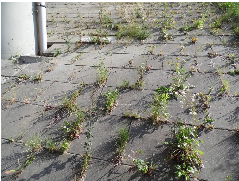
Fot. 63. Widok na umocnienie skarpy przy podporze nr 2 – wegetacja roślinności pomiędzy elementami umocnienia.
