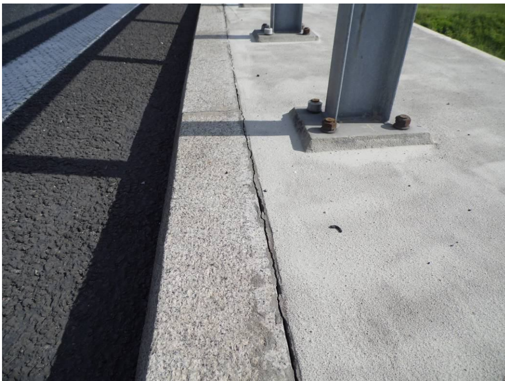
Fot. 9. Widok na chodnik od strony Katowic w prześle nr 2. Odspojenie krawężnika od kapy chodnikowej.
