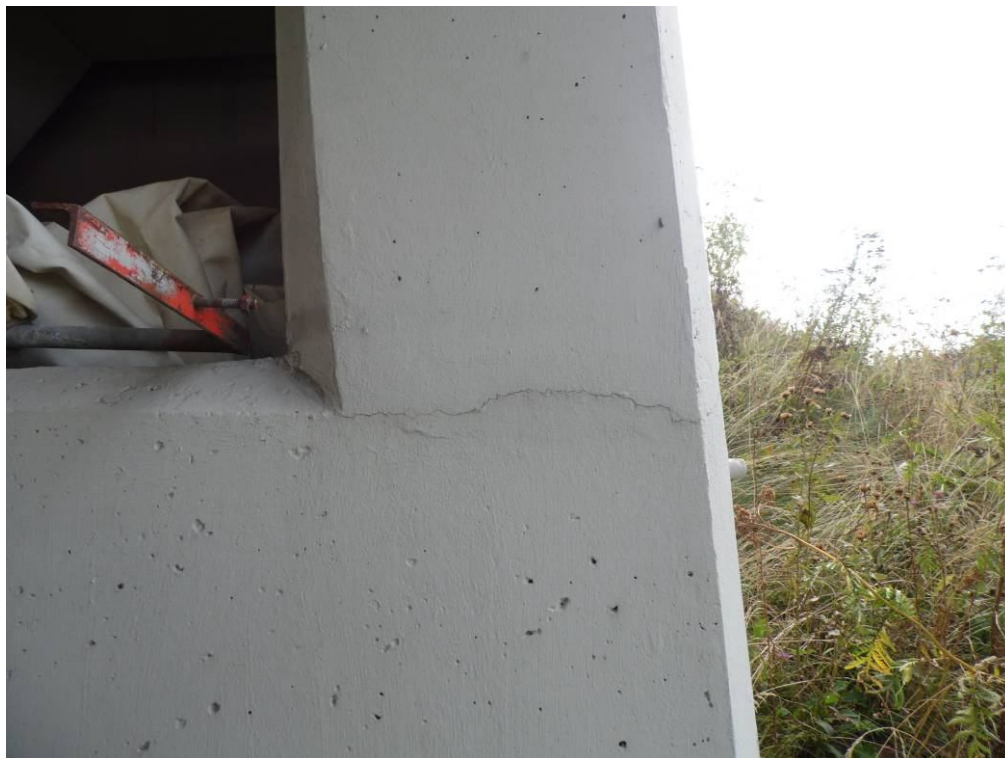
Fot. 42. Widok na ściankę boczną przyczółka od strony Wieliczki – zarysowanie skurczowe na styku ławy łóżyskowej i ścianki bocznej przyczółka.
