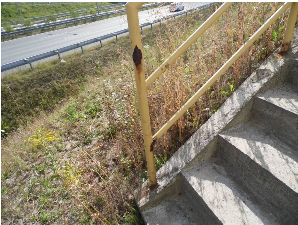
Fot. 67. Widok na balustradę schodów naskarpowych przy przyczółku od strony Wieliczki – uszkodzenia powłoki malarskiej oraz korozja słupka balustrady.
