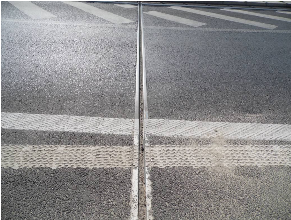
Fot. 34. Widok na urządzenie dylatacyjne nad przyczółkiem od strony Wieliczki – zanieczyszczenia wkładki urządzenia dylatacyjnego.
