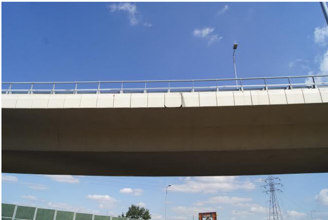
Fot. 16. Widok od strony Katowic na gzyms w przęśle nr 3. Ubytki betonu w dolnej części deski gzymsowej oraz zacieki na powierzchni gzymsu.
