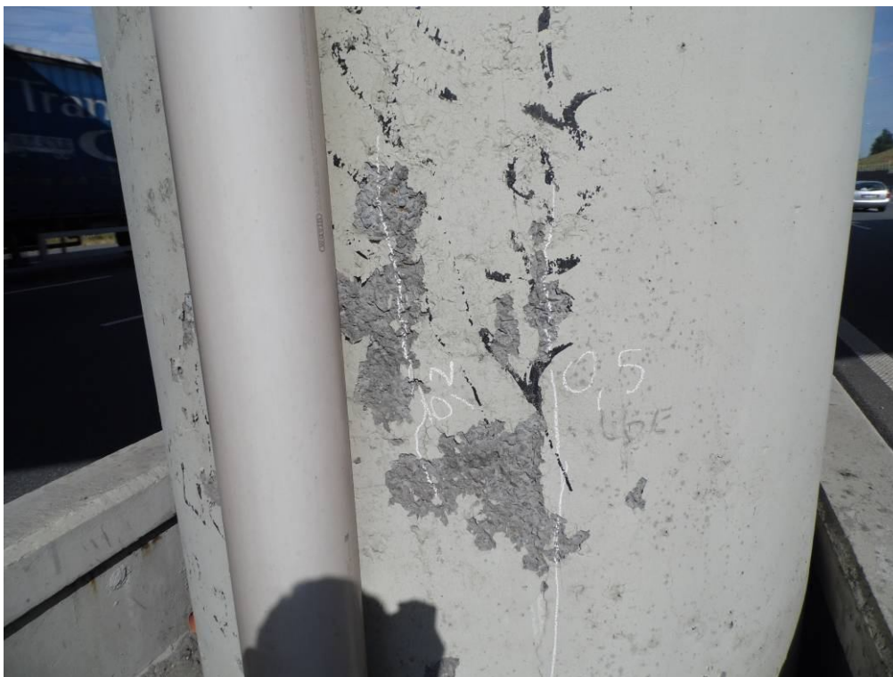
Fot. 51. Widok od strony Katowic na słup od strony Katowic podpory nr 3 – ubytki betonu do głębokości ok. 1 cm, zarysowania pionowe o rozwarości 0,5 mm.
