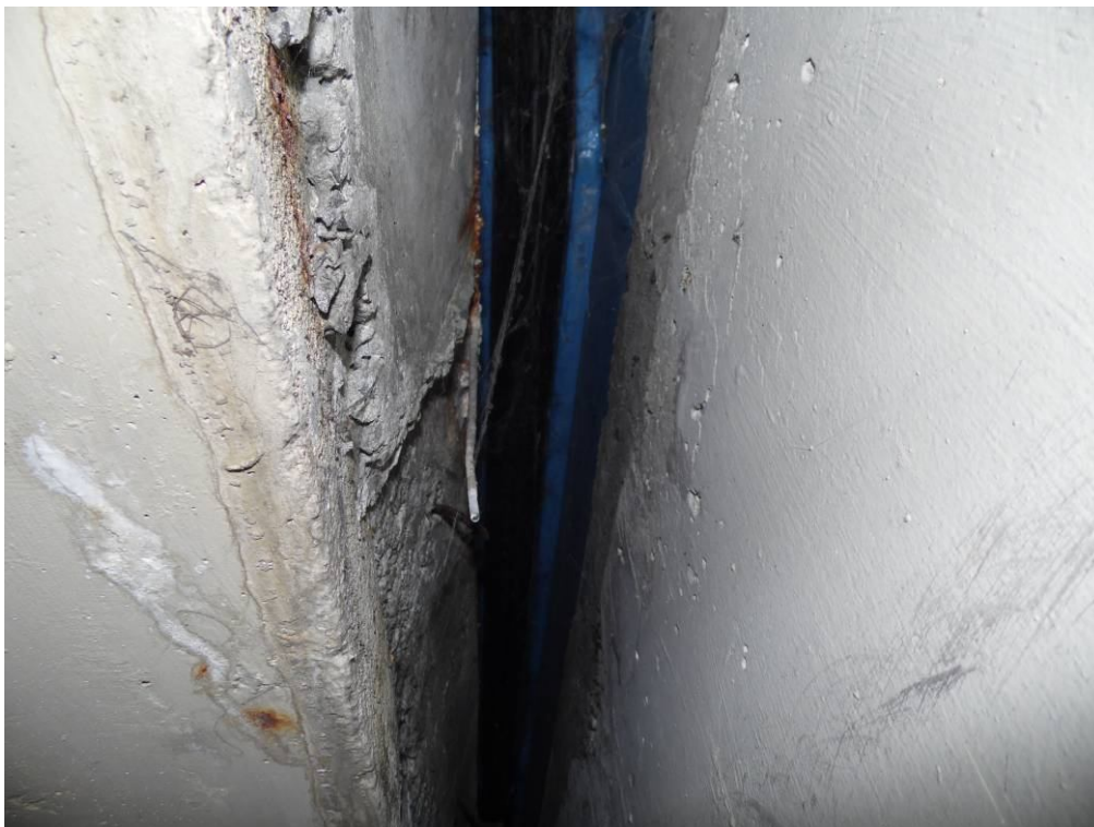
Fot. 32. Widok od spodu na urządzenie dylatacyjne nad przyczółkiem od strony Krakowa – brak uszkodzeń urządzenia dylatacyjnego, ubytki betonu, odkryte korodujące zbrojenie oraz rdzawe plamy powierzchni czołowej dźwigara.
