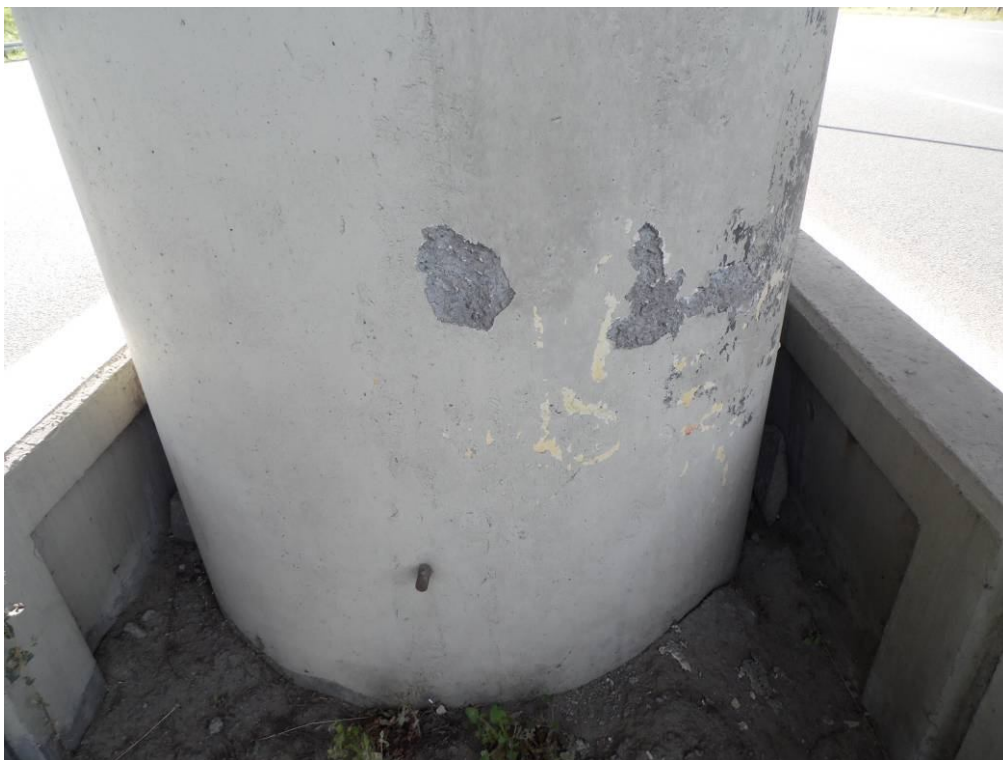
Fot. 49. Widok od strony Tarnowa na słup od strony Katowic podpory nr 3 – złuszczenia powłoki malarskiej powstałe w wyniku wadliwego wykonania.
