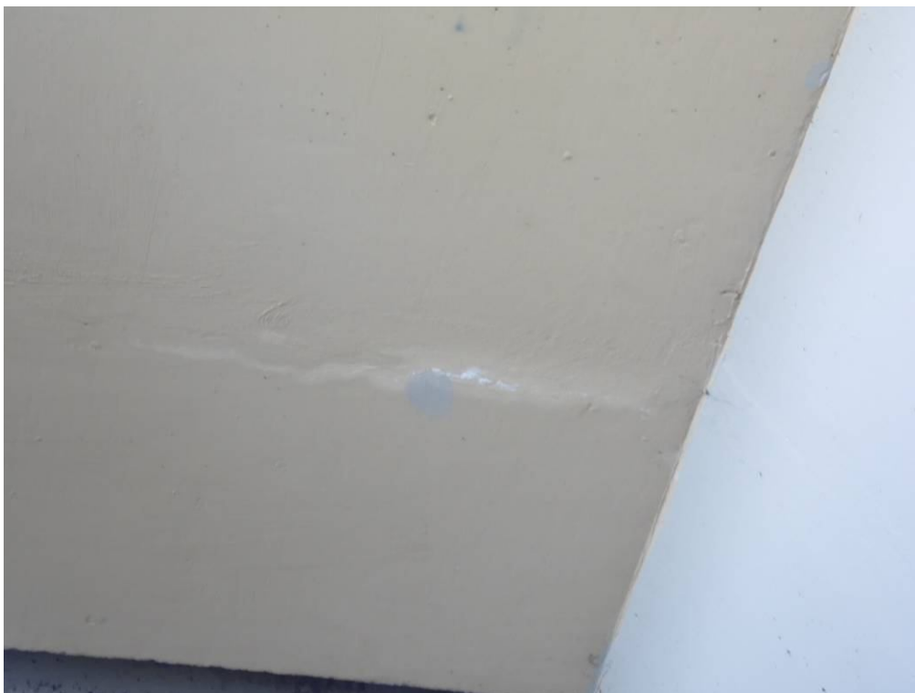
Fot. 39. Widok na wspornik podchodnikowy od strony Tarnowa nad przyczółkiem od strony Wieliczki – wapienne wykwity w miejscu naprawy powierzchniowej betonu powstałe w wyniku wadliwego wykonania.
