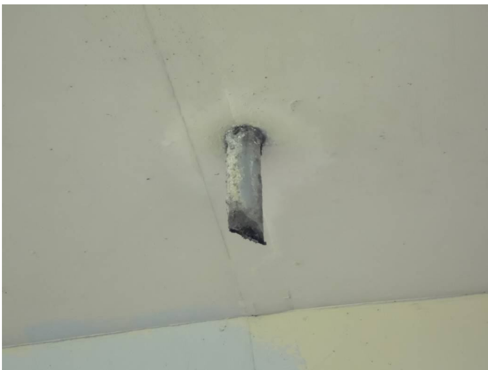
Fot. 28. Widok na rurkę wypływową sączka od strony Katowic przy przyczółku od strony Wieliczki – wapienne zacieki na rurce oraz zacieki na powierzchni wspornika pochodnikowego wokół rurki wypływowej sączka powstałe w wyniku lokalnej nieszczelności izolacji.
