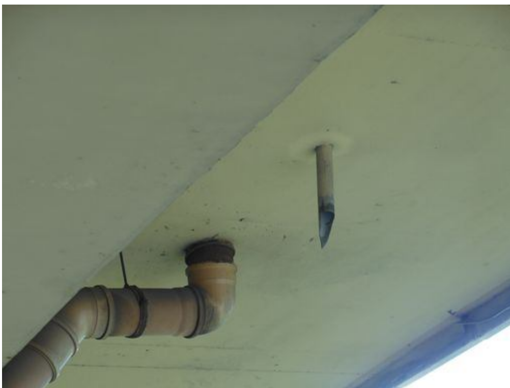
Fot. 26. Widok na rurę spustową oraz rurkę wypływową sączka od strony Katowic przy podporze nr 2 – korozja rury spustowej wpustu, zanieczyszczenia kolektora oraz rurki wypływowej, korozja elementów podwieszenia kolektora, zacieki na powierzchni wspornika pochodnikowego wokół rurki wypływowej sączka powstałe w wyniku lokalnej nieszczelności izolacji.
