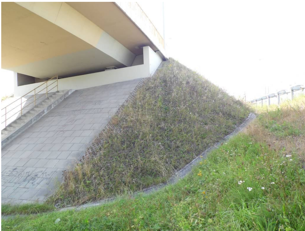
Fot. 64. Widok na umocnienie stożka przyczółka od strony Krakowa – wegetacja roślinności.
