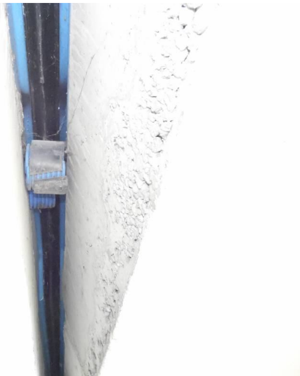
Fot. 30. Widok od spodu na urządzenie dylatacyjne nad przyczółkiem od strony Wieliczki – brak uszkodzeń urządzenia dylatacyjnego, raki na powierzchni czołowej dźwigara powstałe w wyniku wadliwego wykonania.
