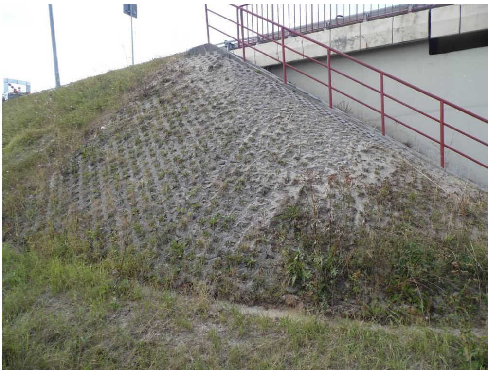
Fot. 60. Widok od strony Tarnowa na umocnienie stożka przyczółka od strony – wegetacja roślinności.
