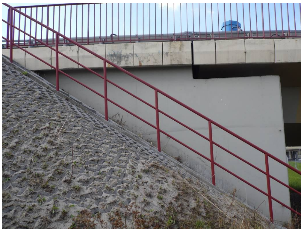
Fot. 43. Widok od strony Tarnowa na skrzydełko przyczółka od strony Wieliczki – nierówności na powierzchni betonu w miejscu w miejscu przerwy technologicznej.
