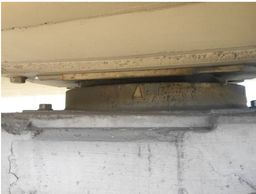
Fot. 57. Widok na łożysko na podporze nr 4 – korozja oraz przykrycie powłoką malarską blachy stali przesuwu łożyska, korozja łożyska.
