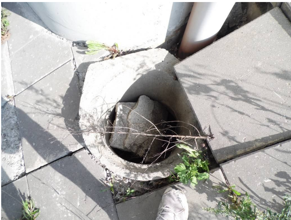
Fot. 29. Widok od strony Katowic na krąg betonowy przy podporze nr 2 – zanieczyszczenia studzienki kanalizacyjnej, do której podpięty jest przykanalik odprowadzający wodę z rury spustowej do ścieku skarpowego.
