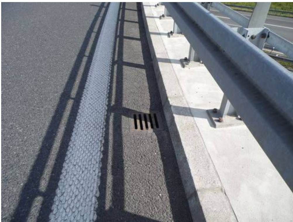
Fot. 19. Widok na balustradę na kapie od strony Katowic. Brak kapturek ochronnych, korozja nakrętek i kotew.
