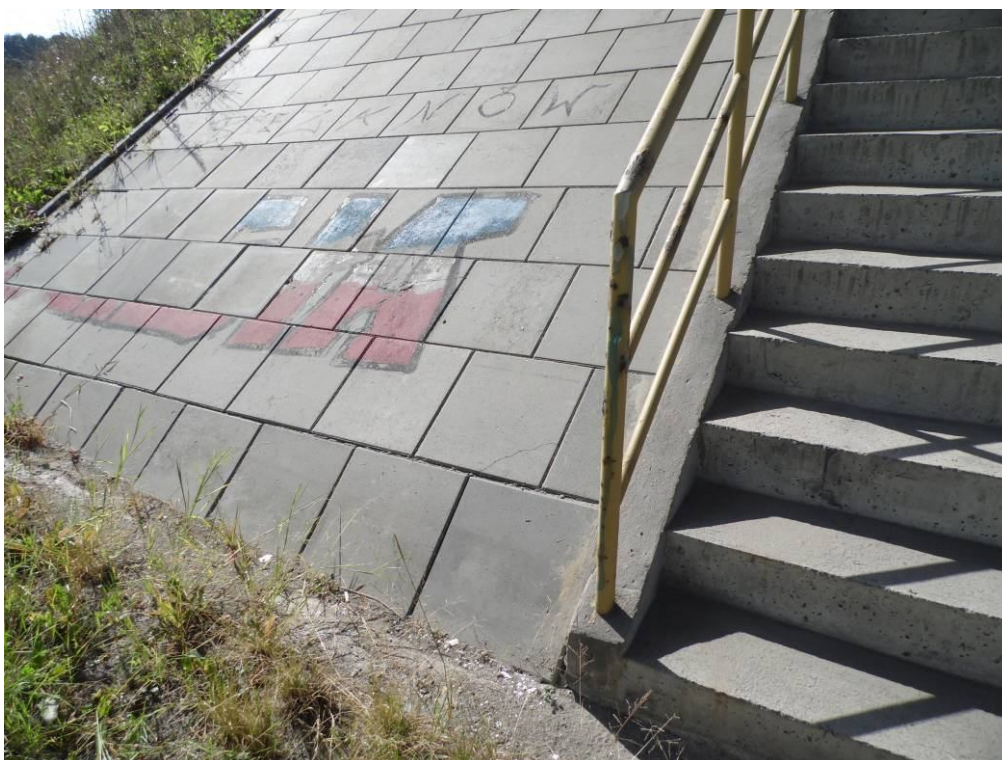
Fot. 65. Widok na umocnienie skarpy przyczółka od strony Krakowa – zanieczyszczenia w postaci graffiti, uszkodzenia powłoki malarskiej oraz korozja słupka balustrady.
