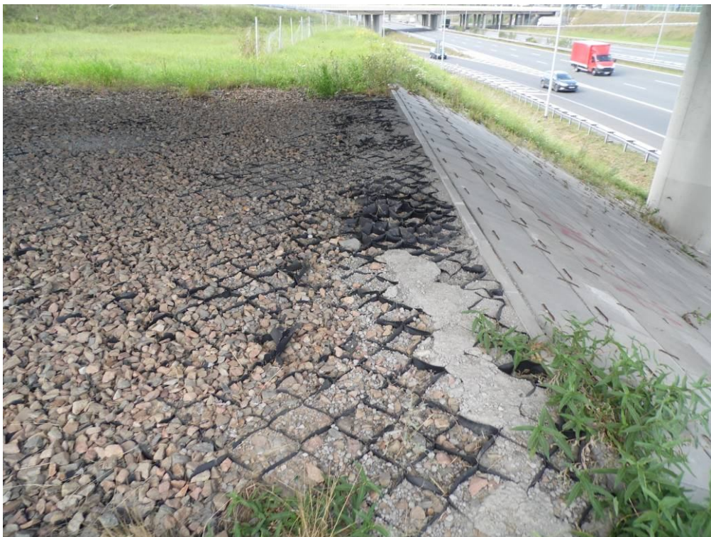
Fot. 62. Widok na umocnienie przestrzeni podmostowej pod przęsłem nr 1 – ubytki kruszywa oraz uszkodzenia geokraty, wegetacja roślinności.
