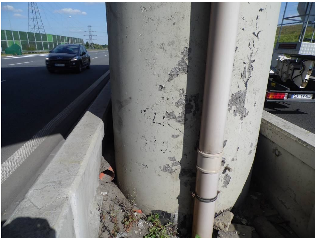
Fot. 50. Widok od strony Katowic na słup od strony Katowic podpory nr 3 – ubytki betonu do głębokości ok. 1 cm.
