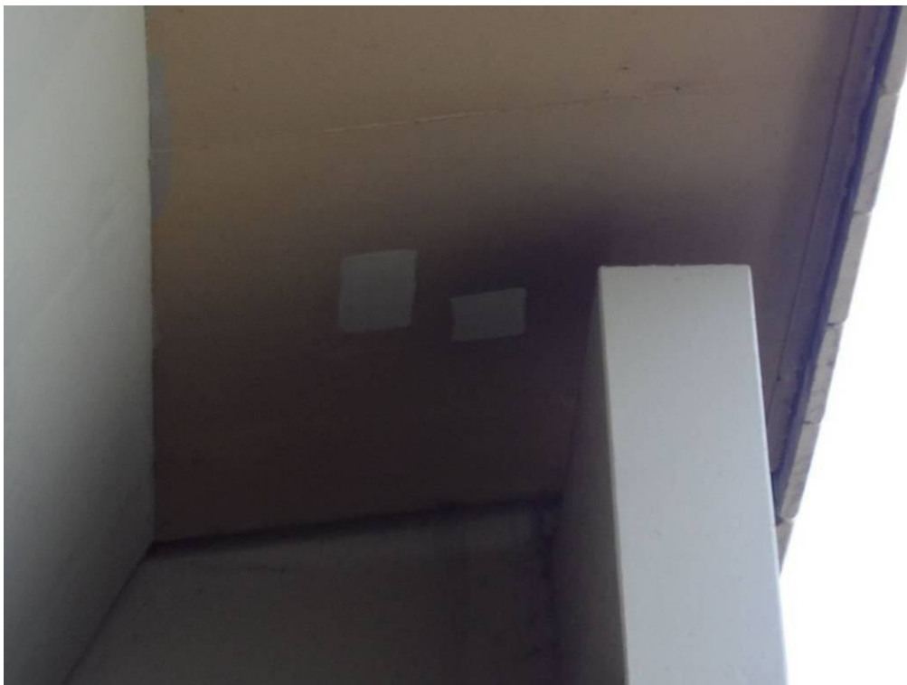
Fot. 40. Widok na wspornik chodnikowy od strony Tarnowa przy przyczółku od strony Krakowa – widoczne ślady napraw wspornika, które zostały przykryte powłoką malarską o źle dobranym kolorze.
