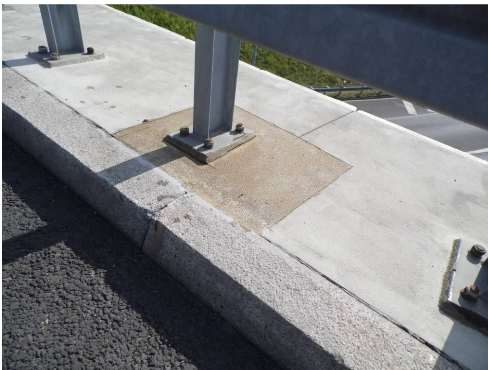
Fot. 8. Widok na chodnik od strony Katowic w prześle nr 3. Wykruszenia naroży krawężników kamiennych, ubytki wypełnienia szczeliny pomiędzy kapą, a krawężnikiem, widoczna wymieniona część nawierzchni chodnika.
