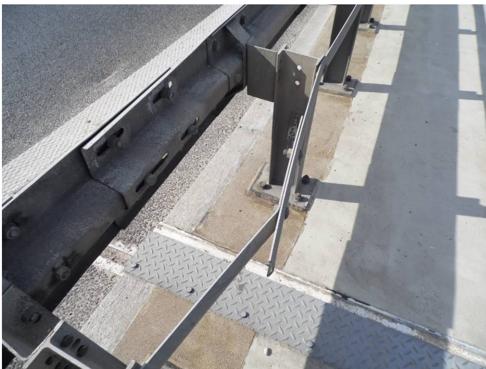
Fot. 20. Widok na barierę od strony Tarnowa nad przyczółkiem od strony Wieliczki. Deformacja pasa profilowego bariery powstała w wyniku przemieszczeń przęsła i zbyt mocnego dokręcenia śrub.
