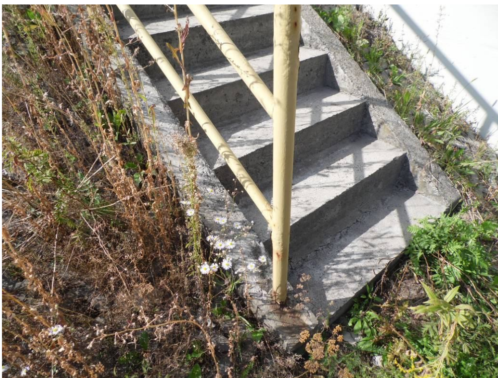
Fot. 66. Widok na balustradę schodów naskarpowych przy przyczółku od strony Wieliczki – korozja słupka balustrady.
