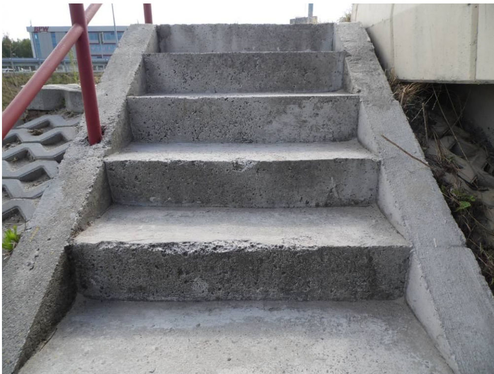
Fot. 61. Widok na schody naskarpowe przy przyczółku od strony Wieliczki – korozja i ubytki betonu schodów.
