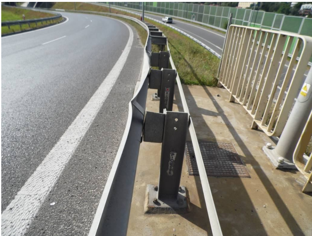
Fot. 24. Widok na barierę od strony Tarnowa na dojeździe od strony Wieliczki. Deformacja prowadnicy powstała w wyniku uderzenia pojazdu, pozostawione nalepki producenta na słupkach barier.
