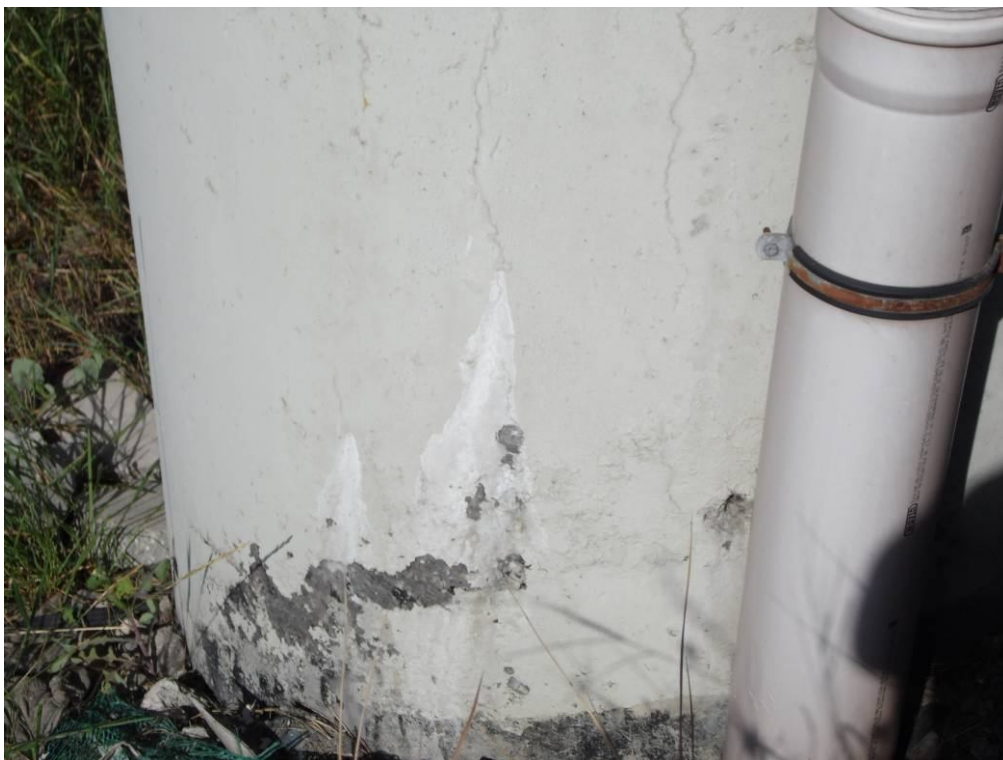
Fot. 53. Widok od strony Katowic na podpórę nr 4 – ubytki betonu do głębokości ok. 1 cm, pionowe zarysowania skurczowe o rozwartości 0,1 mm.
