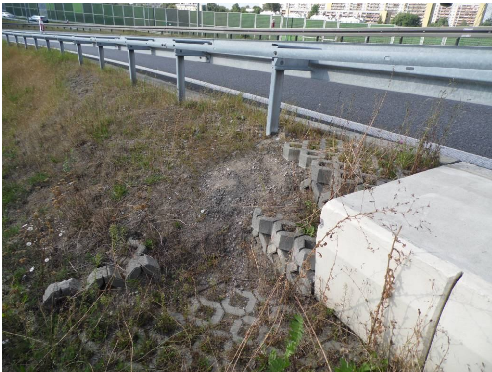
Fot. 68. Widok na pobocze przed skrzydełkiem przyczółka od strony Krakowa – uszkodzenia betonowych elementów umocnienia powstałe w wyniku osiadania podbudowy.
