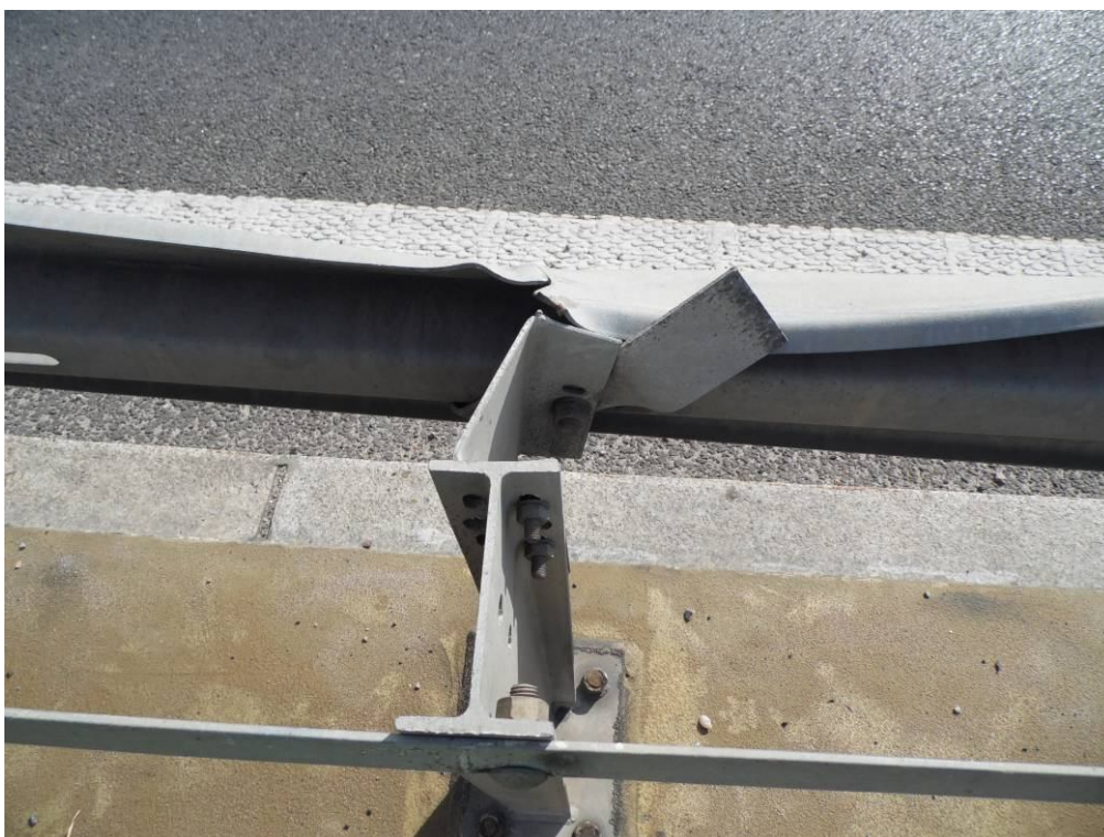
Fot. 25. Widok na barierę od strony Tarnowa na dojeździe od strony Wieliczki – deformacja prowadnicy i przekładki powstała w wyniku uderzenia pojazdu.
