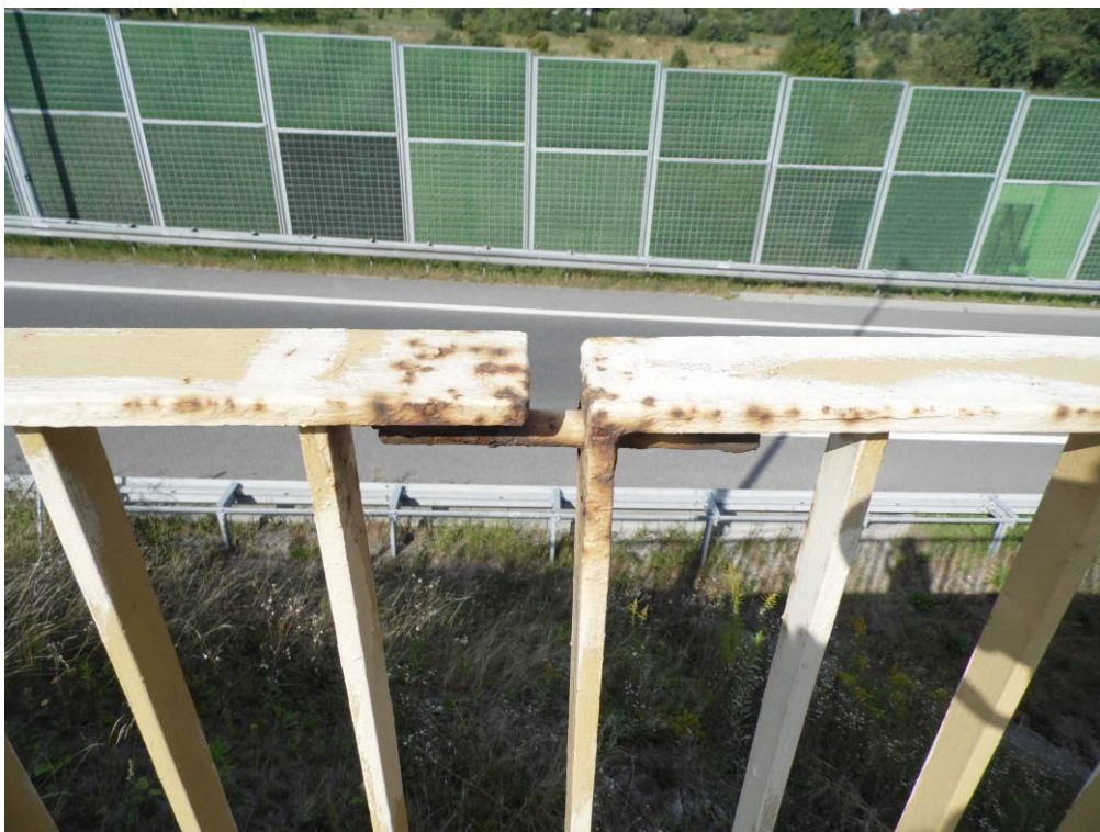
Fot. 23. Widok na balustradę od strony Tarnowa nad przyczółkiem od strony Krakowa. Ogniska korozji na powierzchni pochwyty balustrady w miejscu dylatacji.
