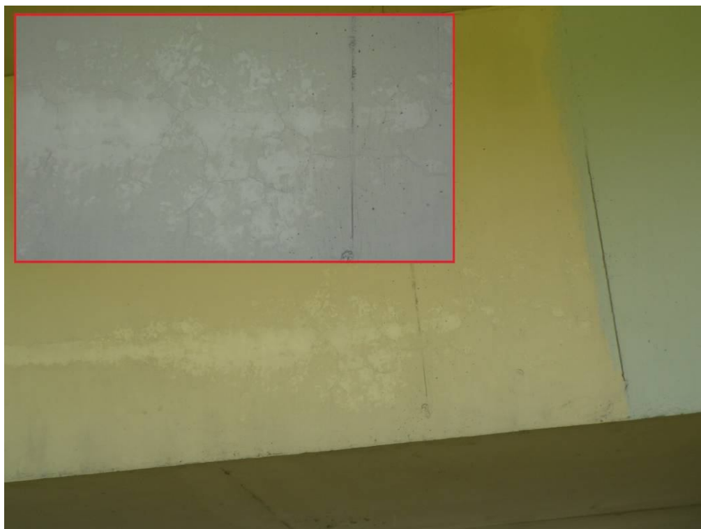
Fot. 36. Widok od strony Katowic na boczną powierzchnię dźwigara w przęśle nr 1 – złuszczenia powłoki malarskiej powstałe w wyniku wadliwego wykonania.
