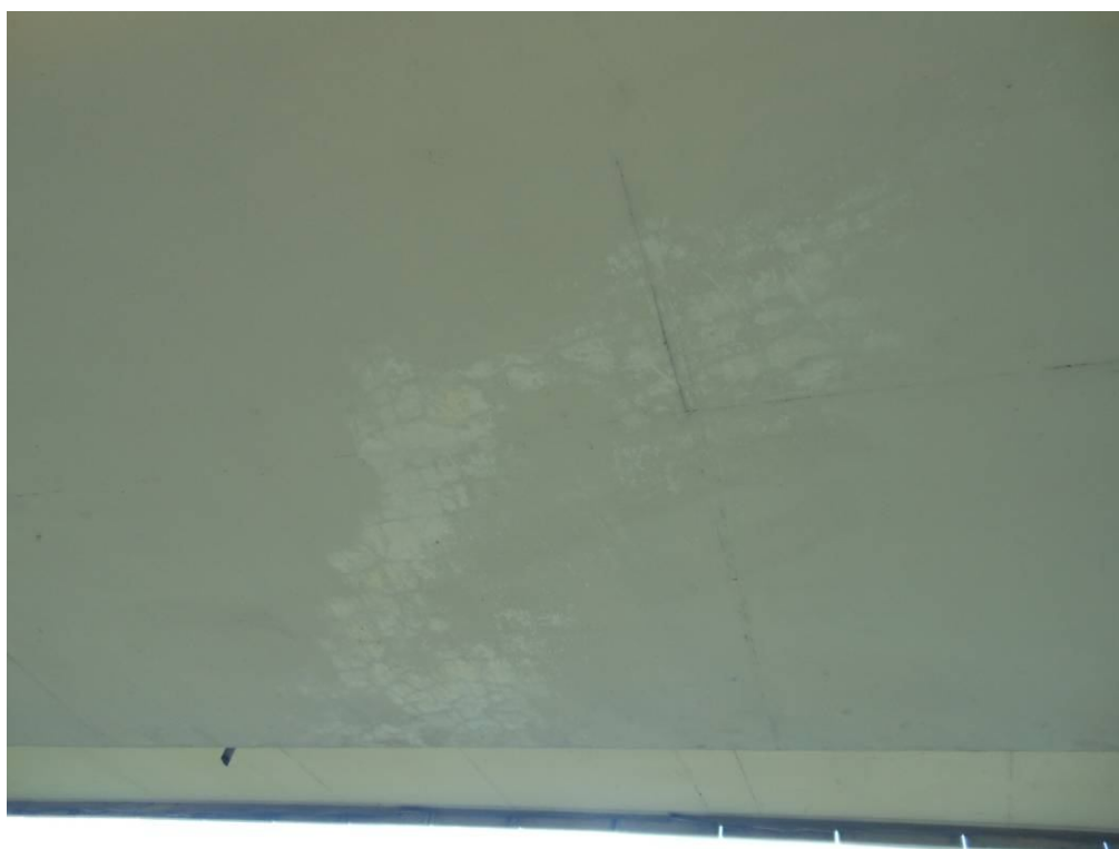
Fot. 35. Widok na dźwigar płytowy w przęśle nr 1 – zarysowania skurczowe.
