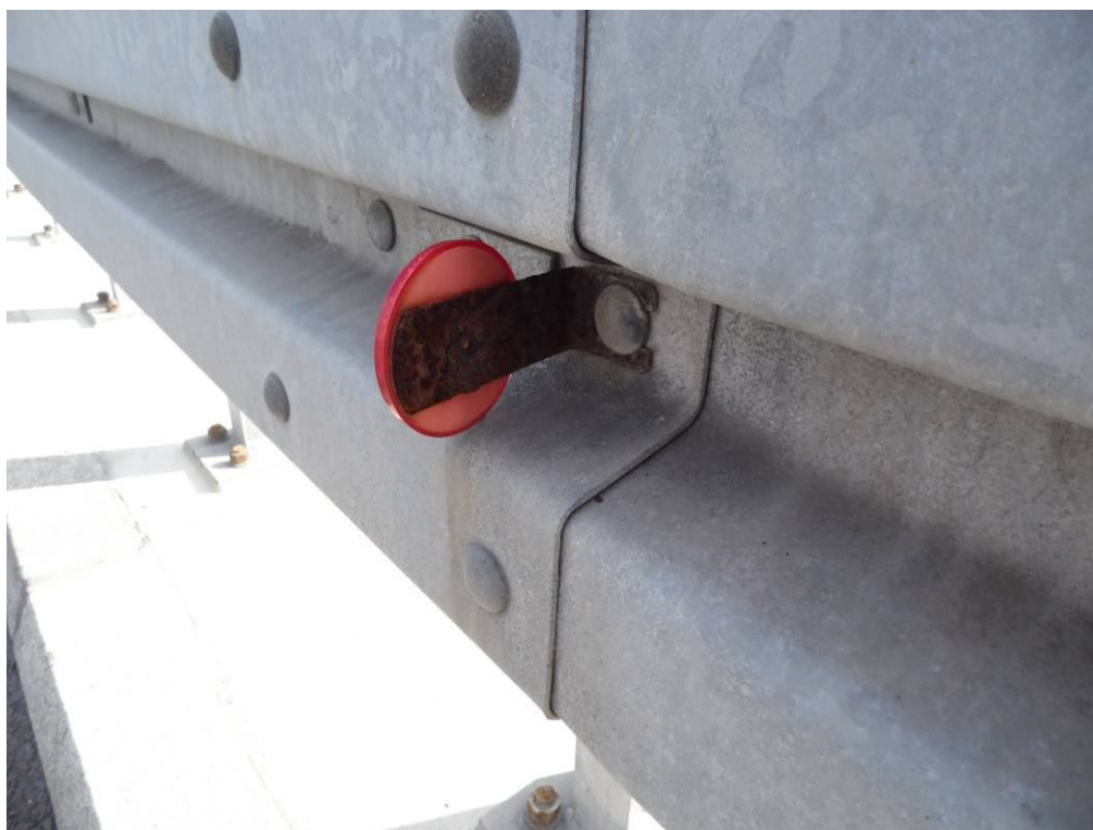
Fot. 18. Widok na prowadnicę bariery od strony Katowic. Korozja elementu mocującego światło odbłaskowe do prowadnicy.
