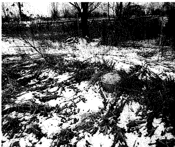
Fot. 3. W centralnej części widoczny kominek rewizyjny zbiornika bezodpływowego, w głębi wywiewka PCV, \varnothing 75
