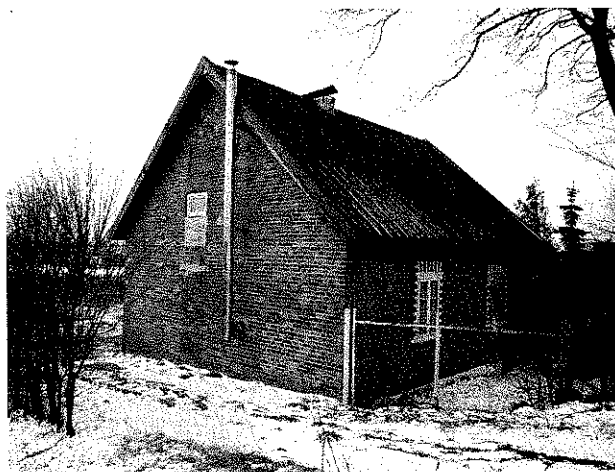
Fot. 19. Demontaż komina zewnętrznego z blachy stalowej nierdzewki Ø250, h=6,2m
