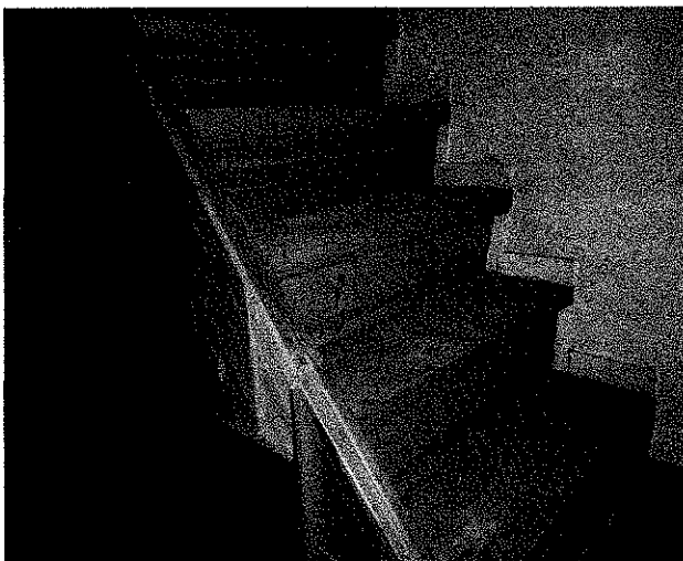
Fot. 6. Schody drewniane z bali sosnowych z parteru na poddasze
