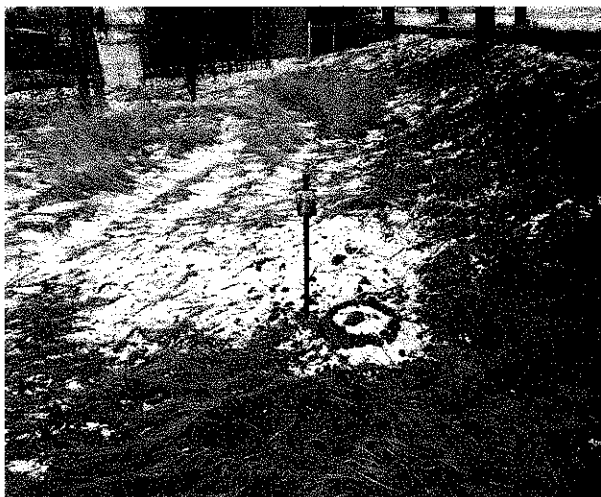
Fot. 2. Oznaczenie zasuwy wodociągowej na sieci W90
