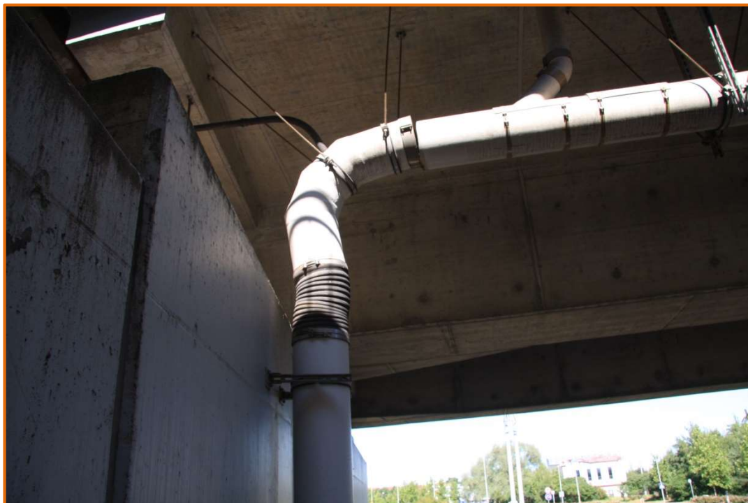
WA-20 – przyczółek od strony Kudowy – rozszczelniony kolektor
