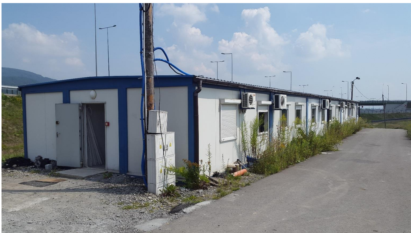
Widok budynku przed demontażem
