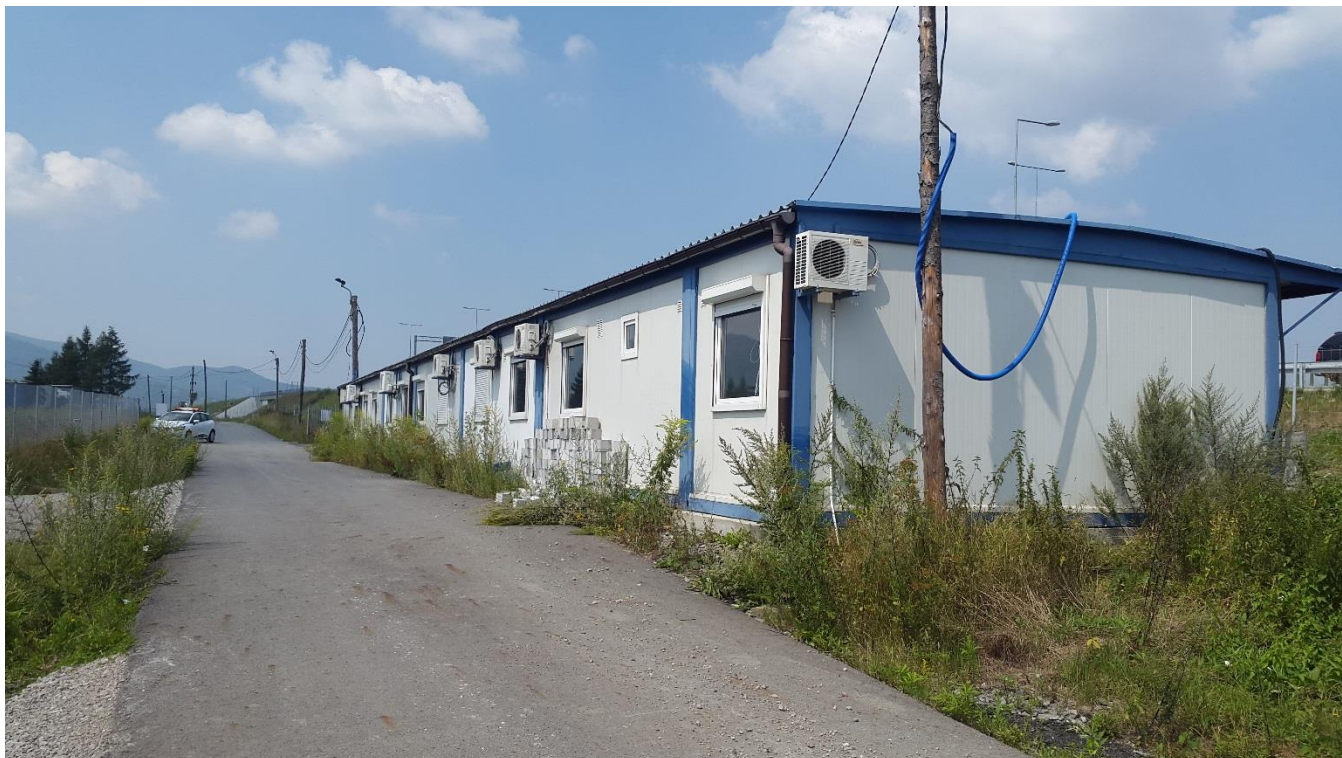
Widok budynku przed demontażem
