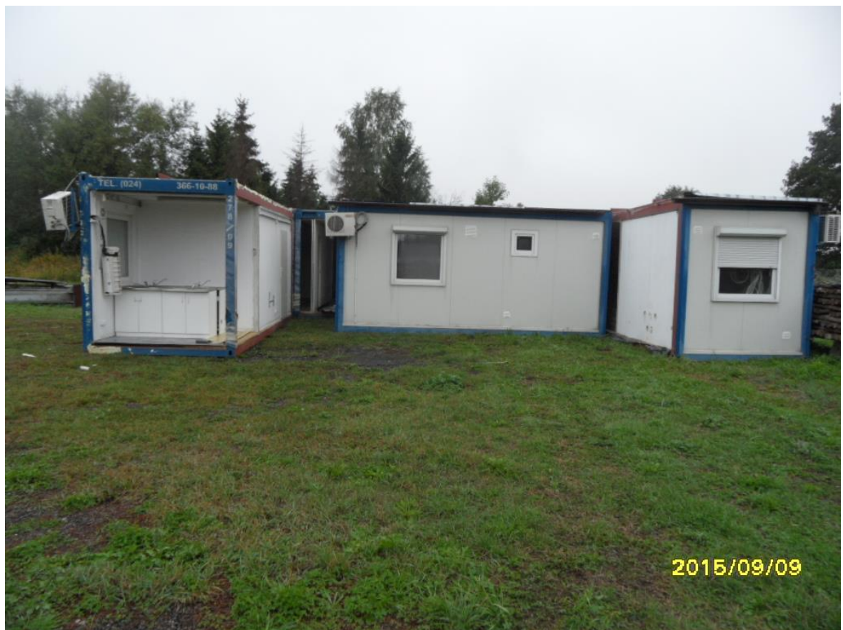
Widok stanu obecnego. Kontenery po demontażu
