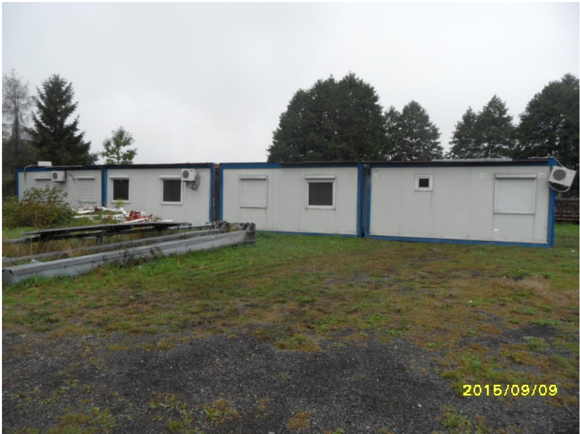
Widok stanu obecnego. Kontenery po demontażu
