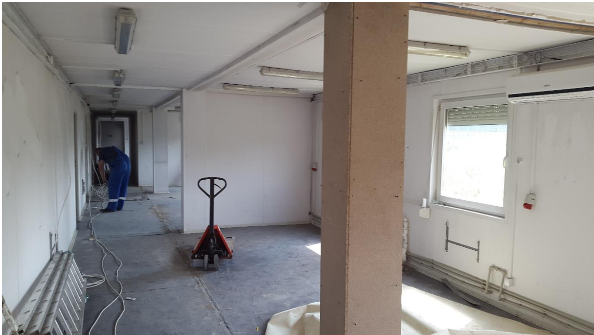
Widok wnętrza budynku przed demontażem
