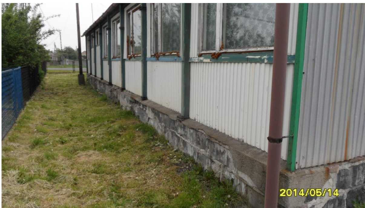
Widok części tylnej budynku (część wschodnia)
