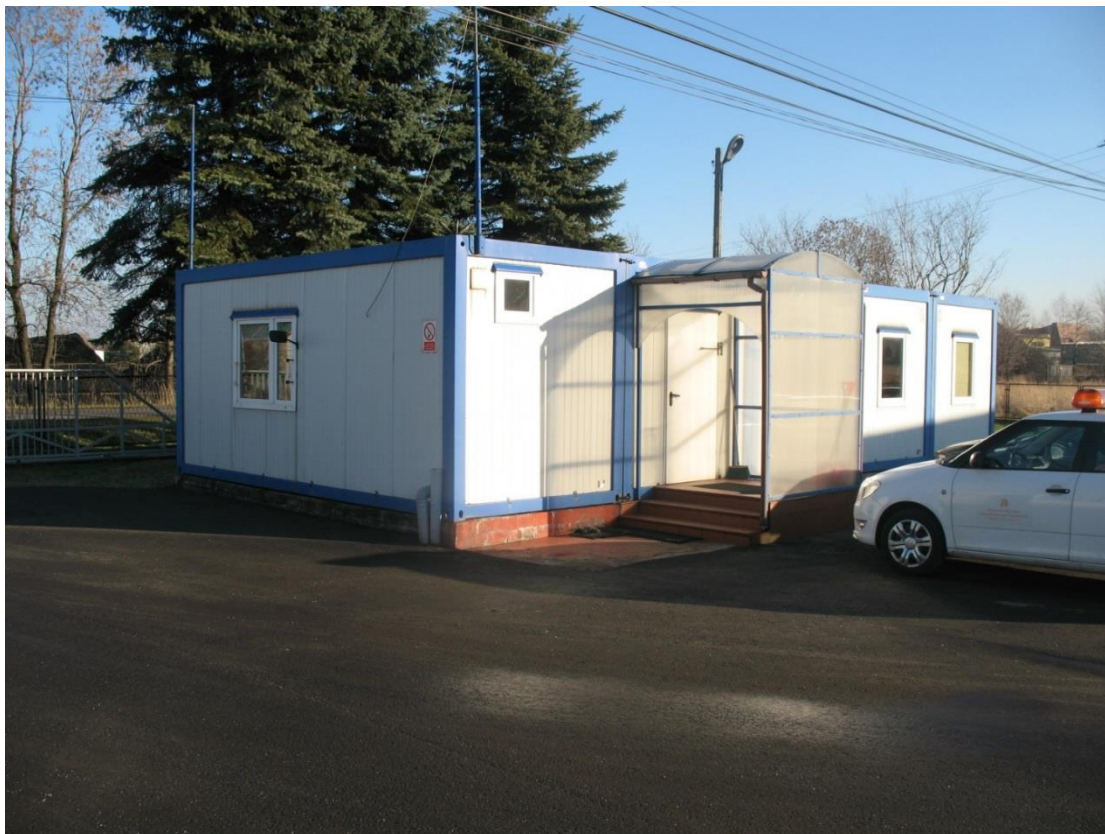
Widok budynku biurowego elewacja frontowa
