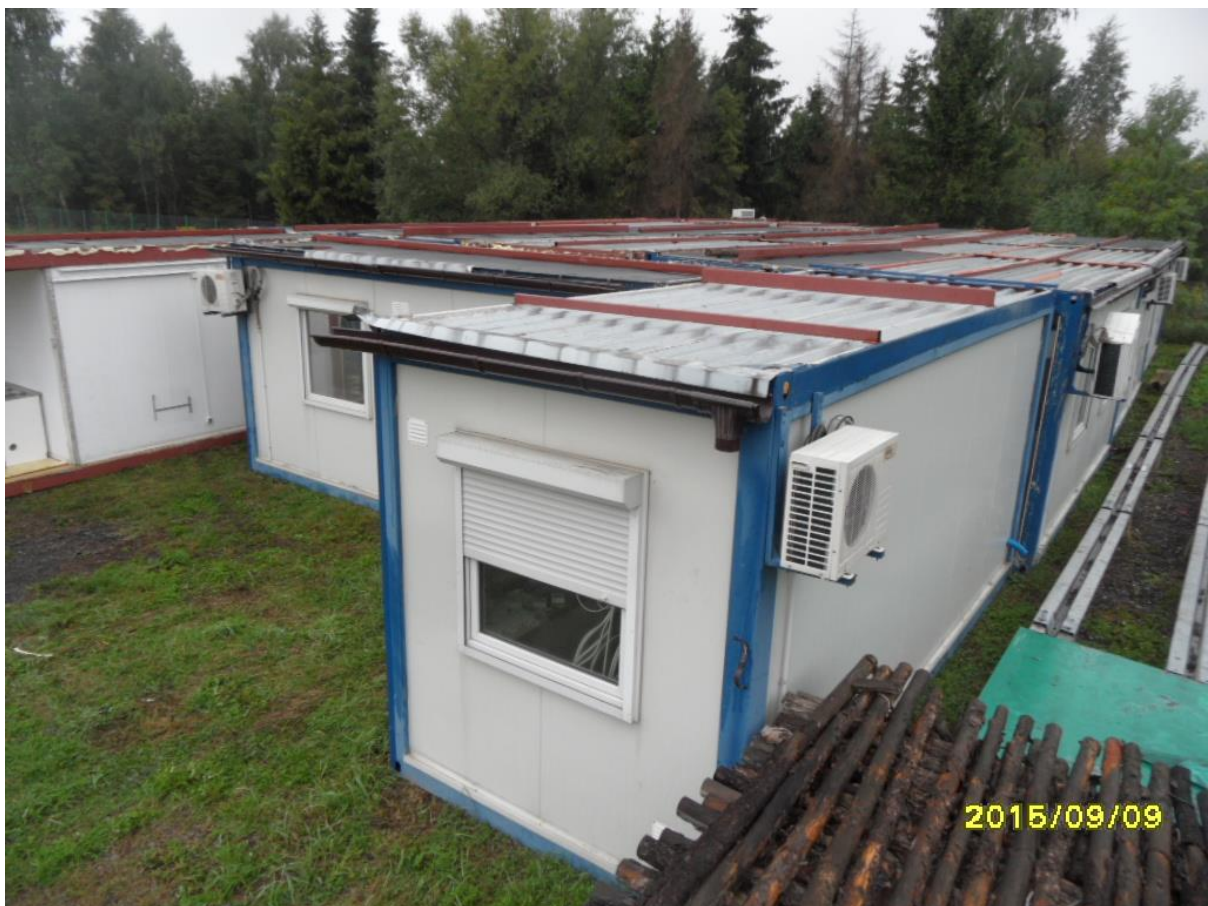
Widok stanu obecnego. Kontenery po demontażu
