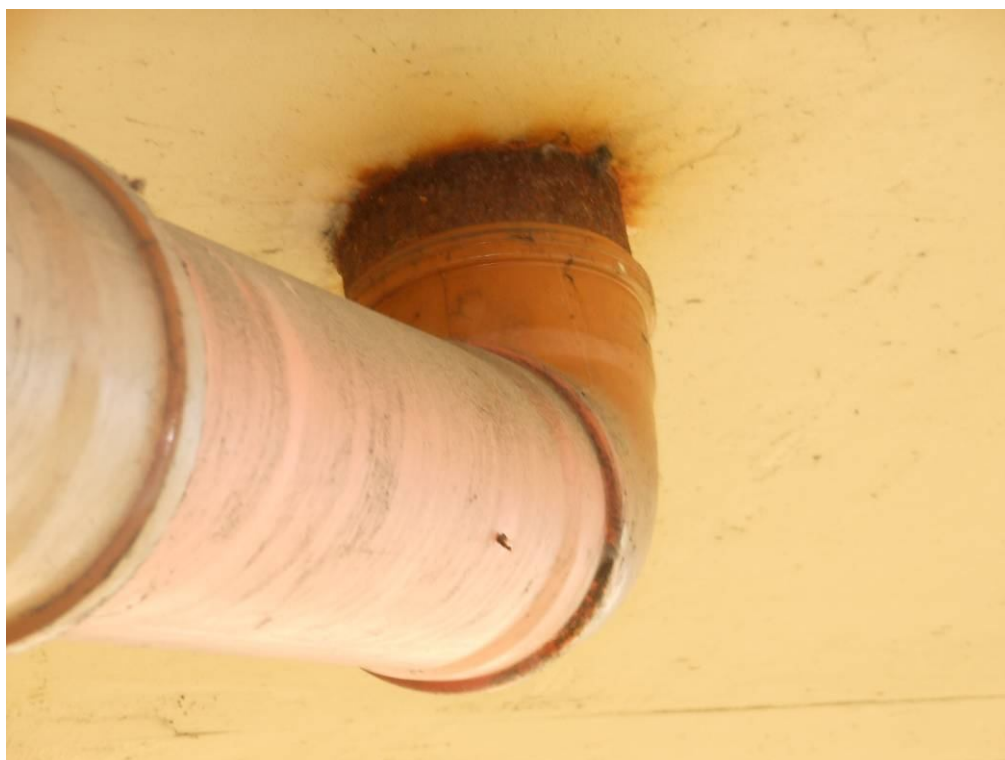
Fot. 34. Widok na rurę spustową wpustu przy podporze nr 2 od strony Tarnowa. Korozja rury spustowej.
