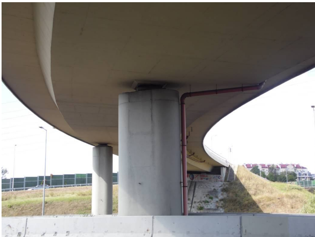
Fot. 67. Widok od strony Wieliczki na podporę nr 4. Nie stwierdzono uszkodzeń.
