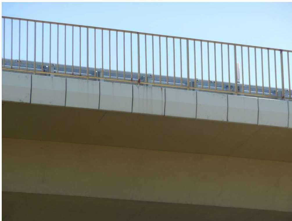
Fot. 24. Widok od strony Katowic na gzyms w przęśle nr 2. Zacieki na powierzchni desek gzymsowych. Punktowo występujące rdzawe plamy spowodowane korozją zbrojenia wskutek zbyt małej otuliny.
