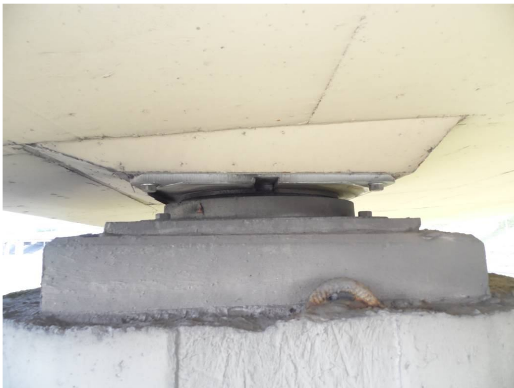
Fot. 69. Widok na cios łożyskowy oraz łożysko na podporze nr 5. Wystający korodujący pręt do montażu zbrojenia słupa.
