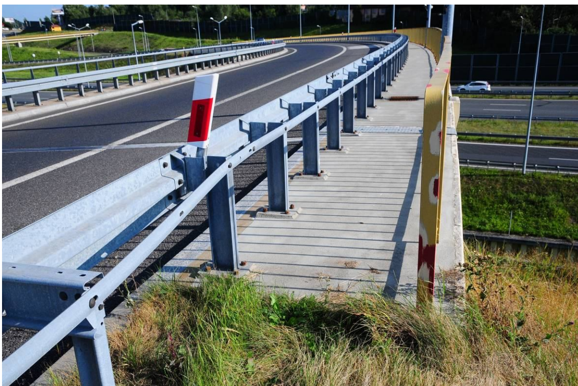
Fot. 25. Widok od strony Krakowa na rampę wejściową od strony Katowic. Widoczne ślady wadliwie wykonanych napraw zabezpieczenia antykorozyjnego balustrady. Brak chodnika i wegetacja roślinności na dojeździe do obiektu.
