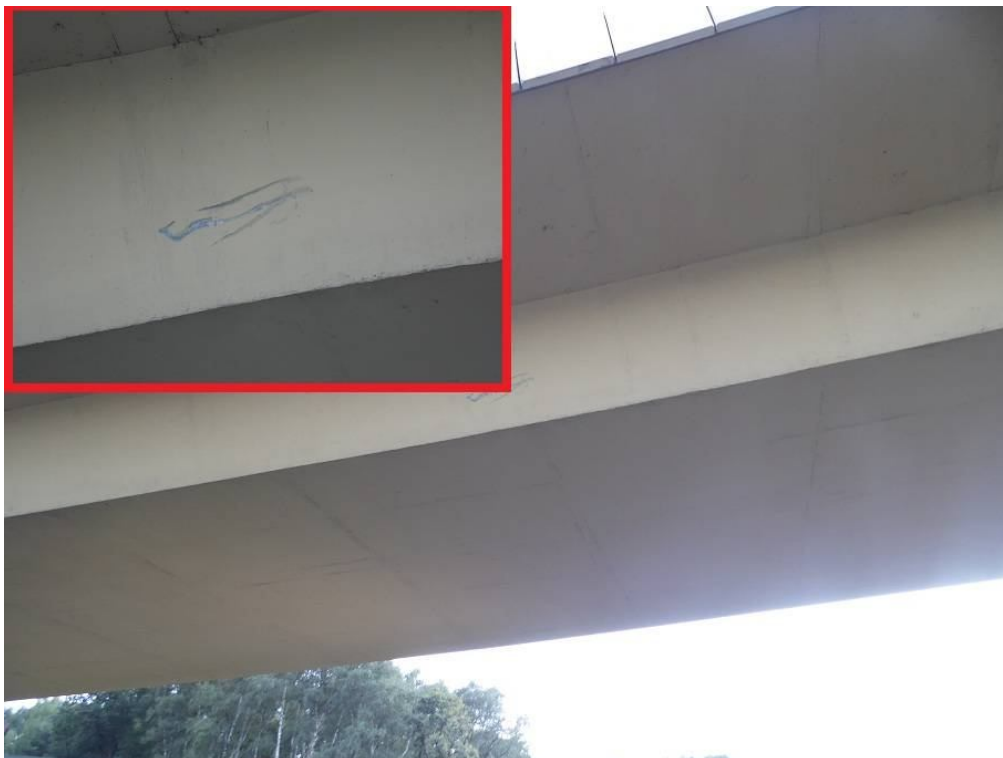
Fot. 48. Widok od strony Tarnowa na dźwigar w przęśle nr 4. Zadrapanie bocznej powierzchni dźwigara.
