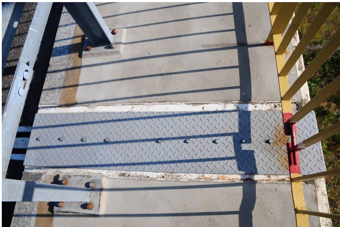
Fot. 39. Widok na urządzenie dylatacyjne od strony Katowic nad przyczółkiem od strony Krakowa. Zanieczyszczenia oraz ślady korozji powierzchniowej profili stalowych urządzenia.
