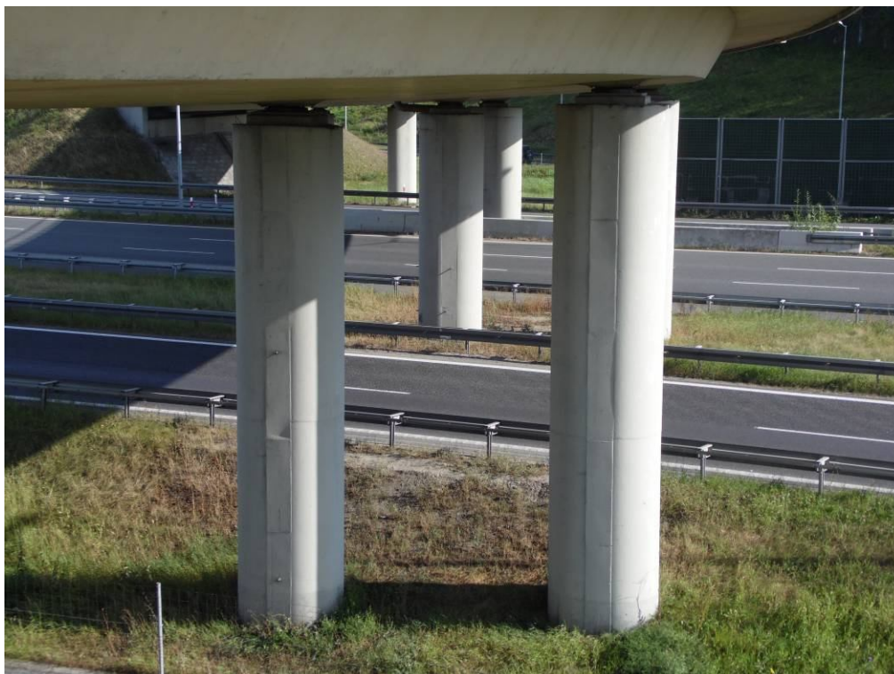
Fot. 62. Widok od strony Krakowa na podpórę nr 2. Nierówności powierzchni betonu powstałe na krawędziach szalunku.
