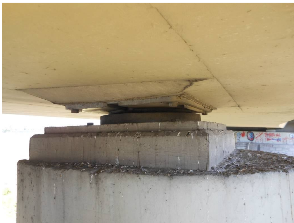
Fot. 70. Widok na łożysko od strony Katowic na podporze nr 2. Mimośrodowo osadzone łożysko na słupie.
