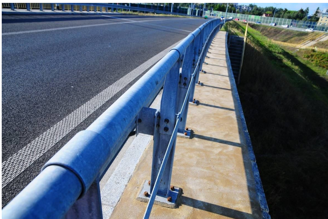
Fot. 31. Widok na barierę od strony Tarnowa na prześle nr 2 i 1. Pozostałości nalepek producenta na słupku bariery, ubytki kapturek ochronnych i korozja nakrętek i kotew słupków barier.
