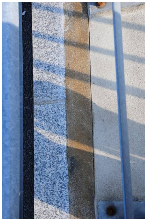
Fot. 15. Widok na krawężnik i kapę chodnikową od strony Katowic nad podporą nr 4. Niedokończona naprawa nawierzchni chodnika, brak wierzchniej warstwy i uszczelnienia styków przy krawężniku na całej długości wiaduktu.
