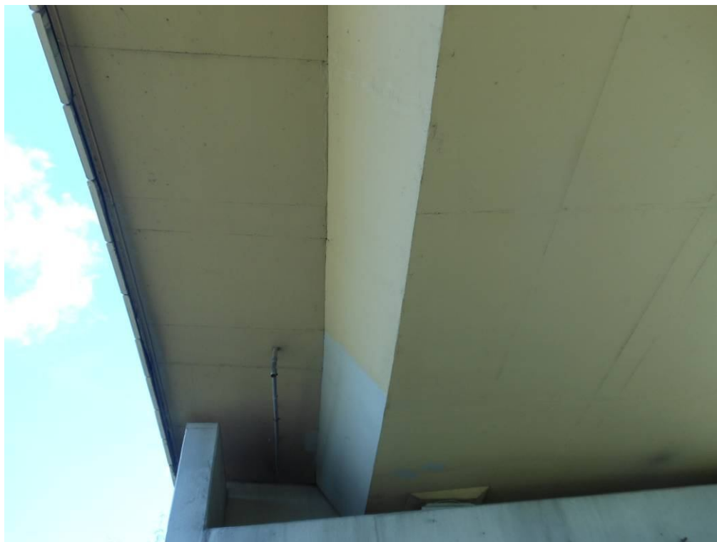
Fot. 46. Widok na dźwigar od strony Tarnowa przy przyczółku od strony Wieliczki. Widoczne ślady napraw bocznej powierzchni dźwigara, nieodpowiednio dobry kolor powłoki malarskiej.
