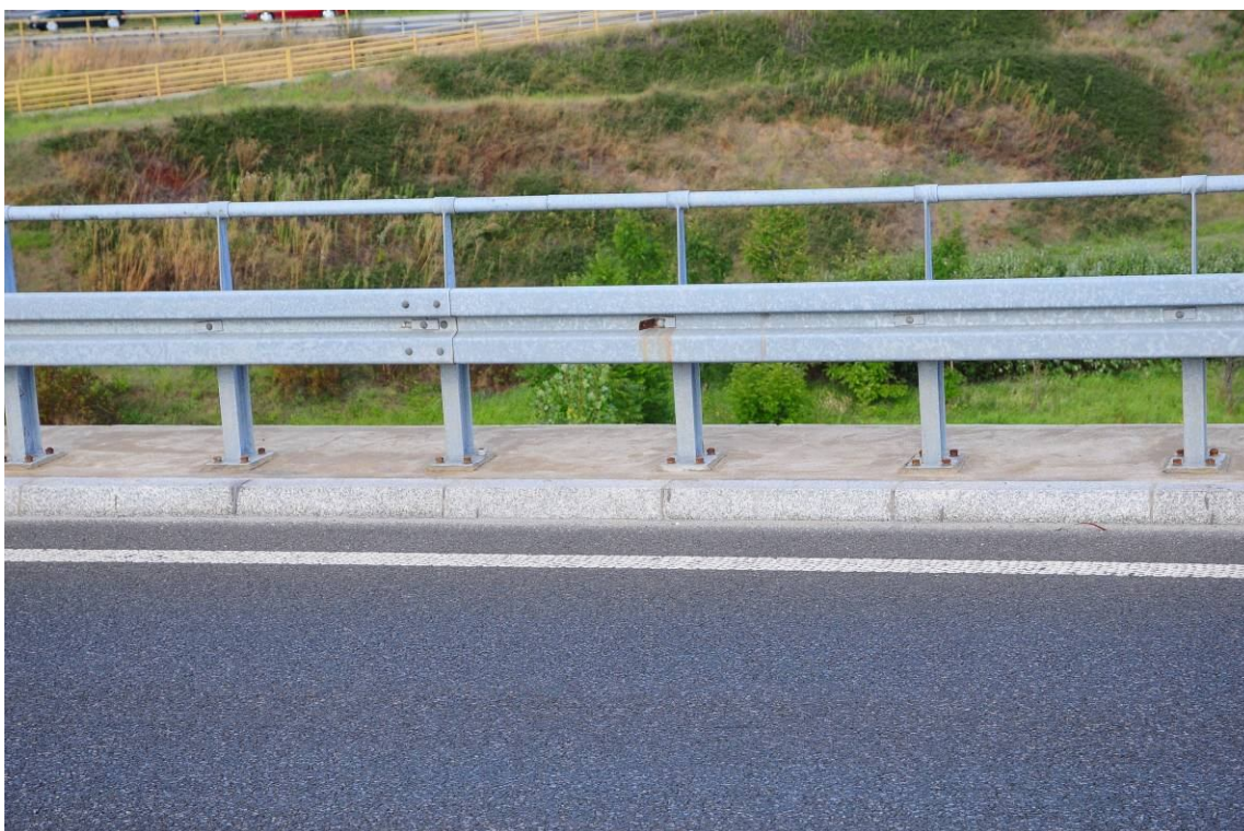
Fot. 27. Widok na barierę ochronną od strony Tarnowa w prześle nr 1. Brak światelka odblaskowego na prowadnicy oraz korozja elementu mocowania światelka.
