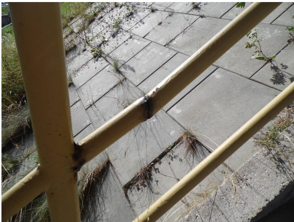
Fot. 79. Widok na balustradę schodów naskarpowych przy przyczółku od strony Krakowa. Brak ciągłości i korozja przeciągu.
