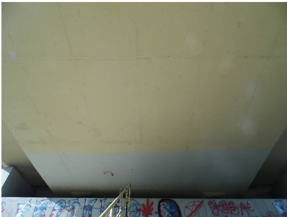
Fot. 47. Widok na dźwigar przy przyczółku od strony Krakowa. Widoczne ślady napraw dolnej powierzchni dźwigara, nieodpowiednio dobry kolor powłoki malarskiej, zanieczyszczenia w postaci graffiti.
