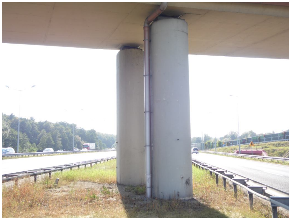
Fot. 66. Widok od strony Tarnowa na podporę nr 3. Zanieczyszczenia w dolnej części słupa filara.
