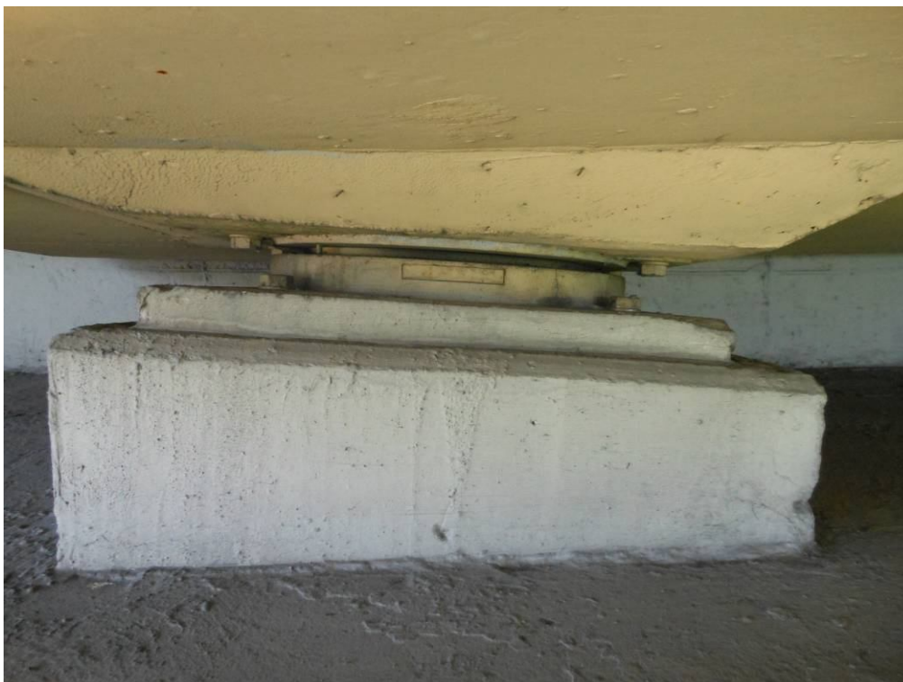
Fot. 73. Widok na łożysko przyczółka od strony Wieliczki. Zanieczyszczenie łożyska.
