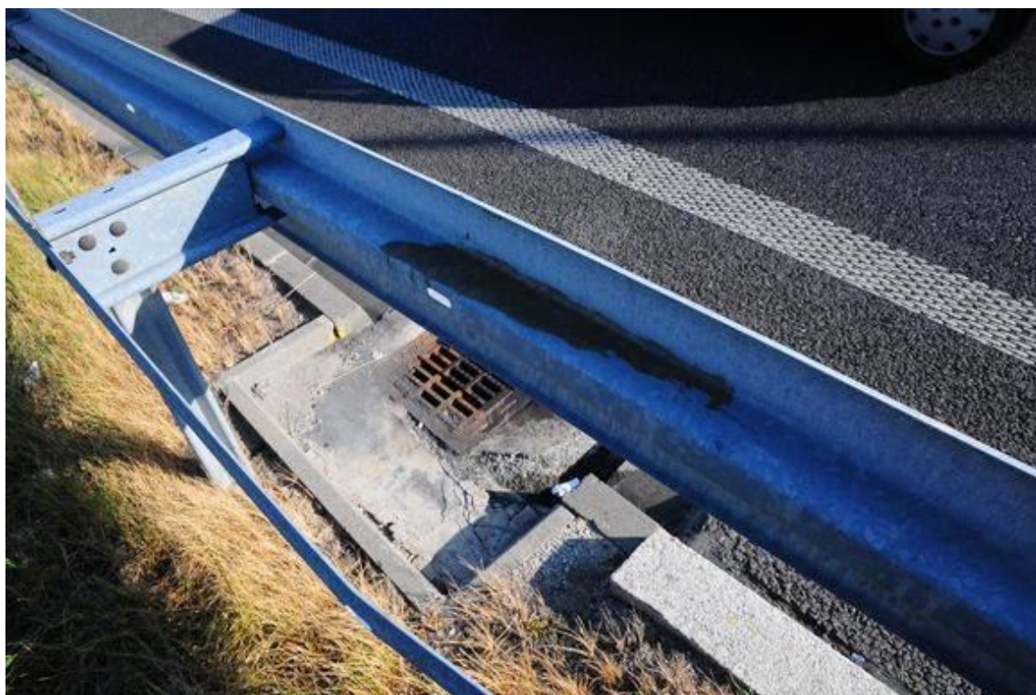
Fot. 30. Widok na barierę od strony Tarnowa na dojeździe od strony Wieliczki. Deformacja pasa profilowego oraz zanieczyszczenie prowadnicy.
