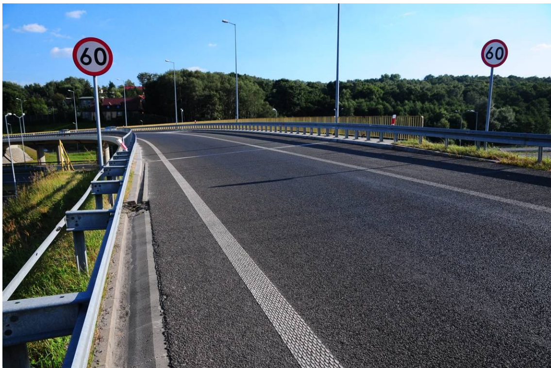
Fot. 75. Widok na dojazd od strony Krakowa. Drobne wykruszenia nawierzchni jezdni wzdłuż ścieku przy krawędzi jezdni.
