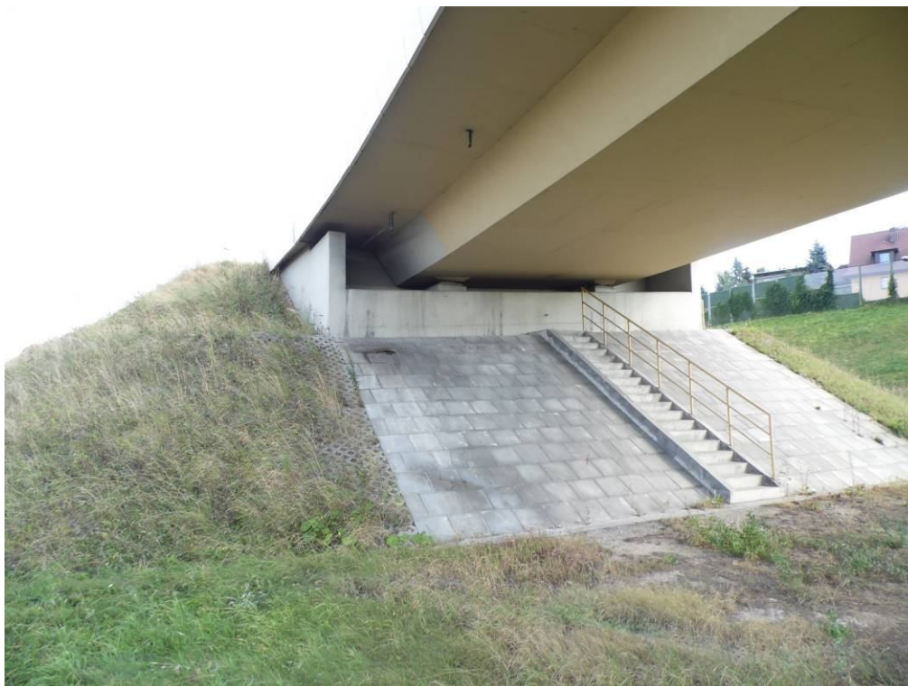
Fot. 57. Widok na przyczółek od strony Wieliczki. Zacieki na powierzchni przyczółka powstałe w wyniku przecieków wokół sączka, zacieki na umocnieniu skarpy spowodowane spływem wody z wylotu sączka.
