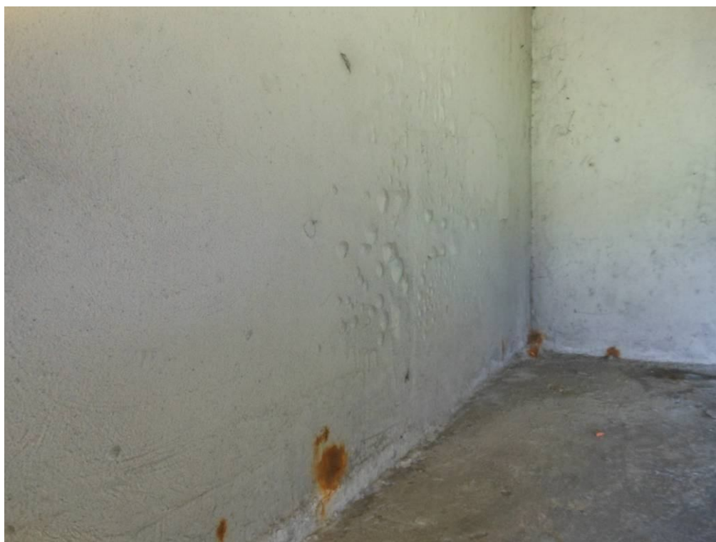
Fot. 60. Widok na ławę łożyskową i boczną ściankę przyczółka od strony Wieliczki. Pęcherze na powierzchni bocznej ścianki przyczółka, ślady korozji na powierzchni betonu powstałe w wyniku korozji stalowych zanieczyszczeń przy powierzchni betonu.
