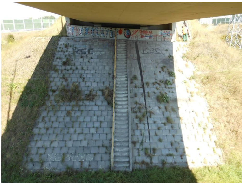
Fot. 76. Widok na umocnienie skarpy przyczółka oraz schody naskarpowe przy przyczółku od strony Krakowa. Zanieczyszczenia w postaci graffiti oraz bitumicznego zacieku, wegetacja roślinności pomiędzy elementami umocnienia, pęknięcia elementów betonowych umocnienia.
