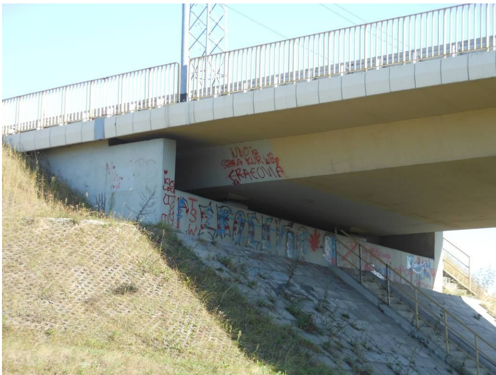
Fot. 52. Widok od strony Katowic na przyczółek od strony Krakowa. Zanieczyszczenia przyczółka i dźwigara w postaci graffiti.
