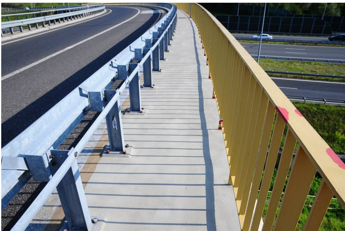
Fot. 26. Widok na barierę i balustradę od strony Katowic w prześle nr 1. Ubytki kapturek ochronnych i korozja nakrętek i kotew słupków barier. Widoczne ślady wadliwie wykonanych napraw zabezpieczenia antykorozyjnego balustrady.
