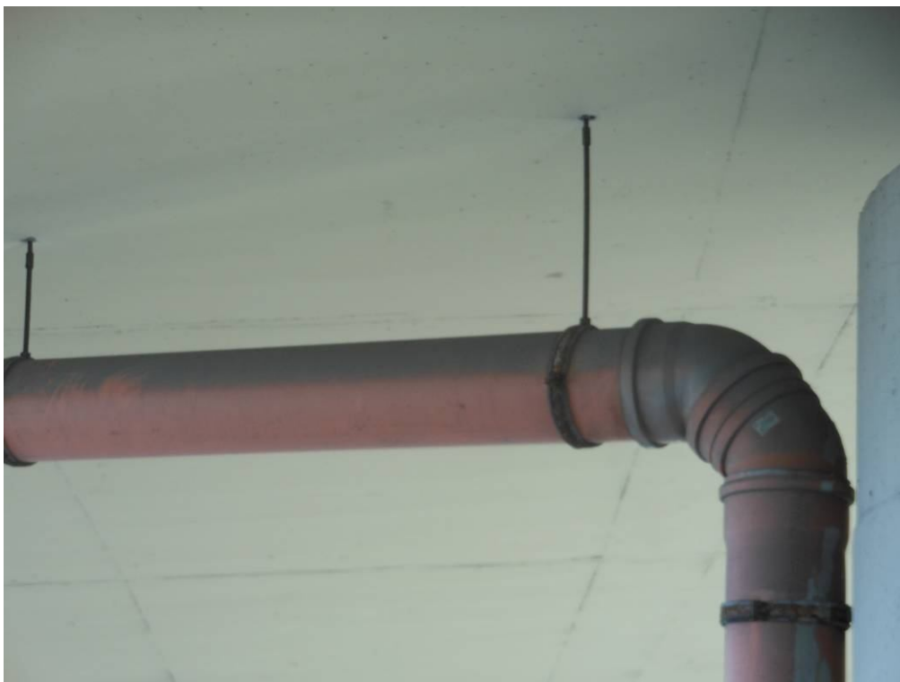
Fot. 35. Widok na podwieszenie kolektora od strony Tarnowa przy podporze nr 4. Korozja elementów podwieszeń spowodowana niedostatecznym zabezpieczeniem antykorozyjnym.
