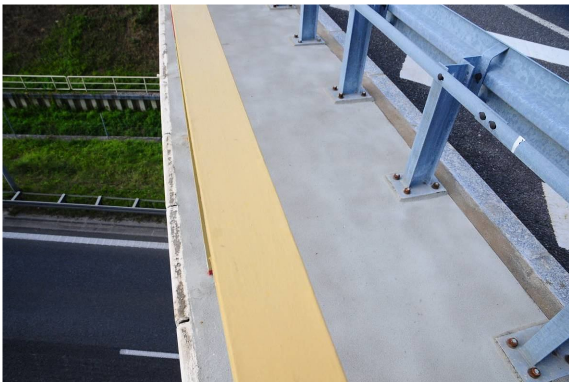
Fot. 12. Widok na kapę chodnikową od strony Katowic w prześle nr 2. Ubytki zabezpieczenia antykorozyjnego oraz ubytki betonu desek gzymsowych powstałe w wyniku użycia materiałów niskiej jakości.
