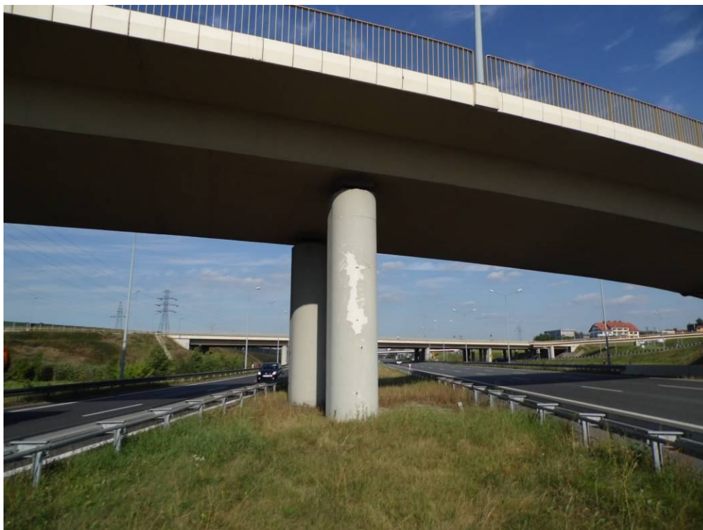
Fot. 65. Widok od strony Katowic na podporę nr 3. Ślady napraw powierzchniowych betonu i braku powłoki zabezpieczającej.
