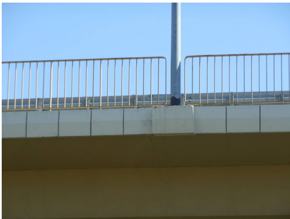
Fot. 23. Widok na gzyms od strony Katowic w przęśle nr 1 – widoczny dobudowany wspornik pod zakotwienie słupa oświetleniowego nie przykryty deskami gzymsowymi. Lokalne złuszczenia powłoki ochronnej oraz zarysowanie betonu desek gzymsowych.
