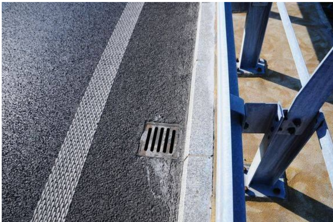
Fot. 33. Widok na wpust od strony Tanowa w prześle nr 4. Zanieczyszczenia powierzchni wpustu i przyległej nawierzchni.
