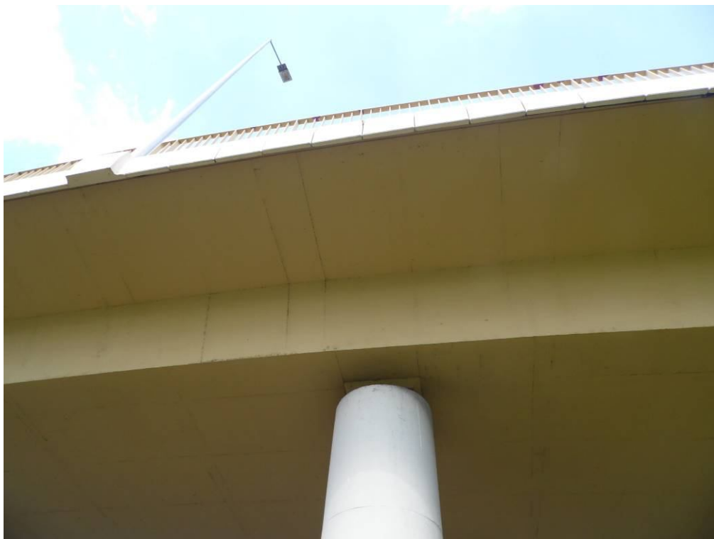
Fot. 49. Widok od strony Katowic na wspornik pochodnikowy nad podporą nr 5. Nierówności powierzchni betonu powstałe w miejscu krawędzi szalunku.
