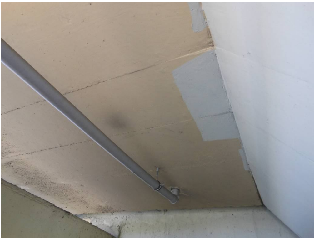
Fot. 51. Widok na wspornik podchodnikowy od strony Tarnowa nad przyczółkiem od strony Wieliczki. Ślady napraw powierzchni betonu, złuszczenia powłoki malarskiej nad ścianką boczną przyczółka.
