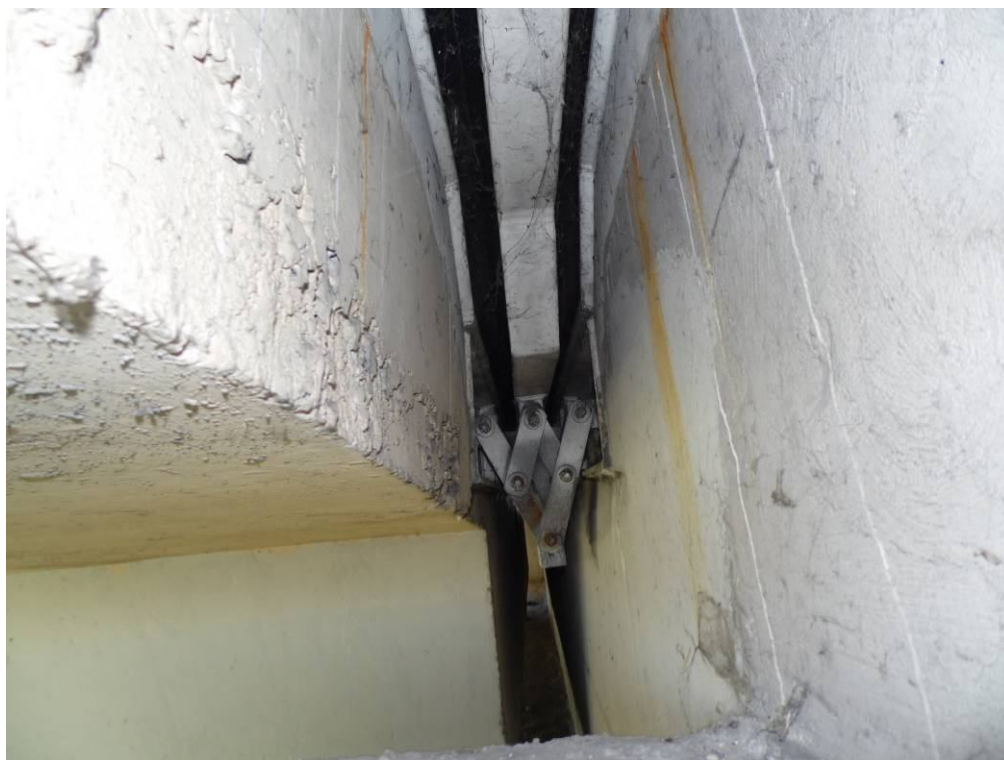
Fot. 42. Widok od dołu na urządzenie dylatacyjne nad przyczółkiem od strony Krakowa. Widoczne rdzawe i wapienne zacieki na powierzchni dźwigara i ścianki zapleczonej od poziomu dolnego betonowania wnętrza dylatacyjnej powstałe w wyniku nieszczelności na styku wnętrza dylatacyjnych i ścianki zapleczonej oraz dźwigara, raki betonu zakończenia dźwigara.
