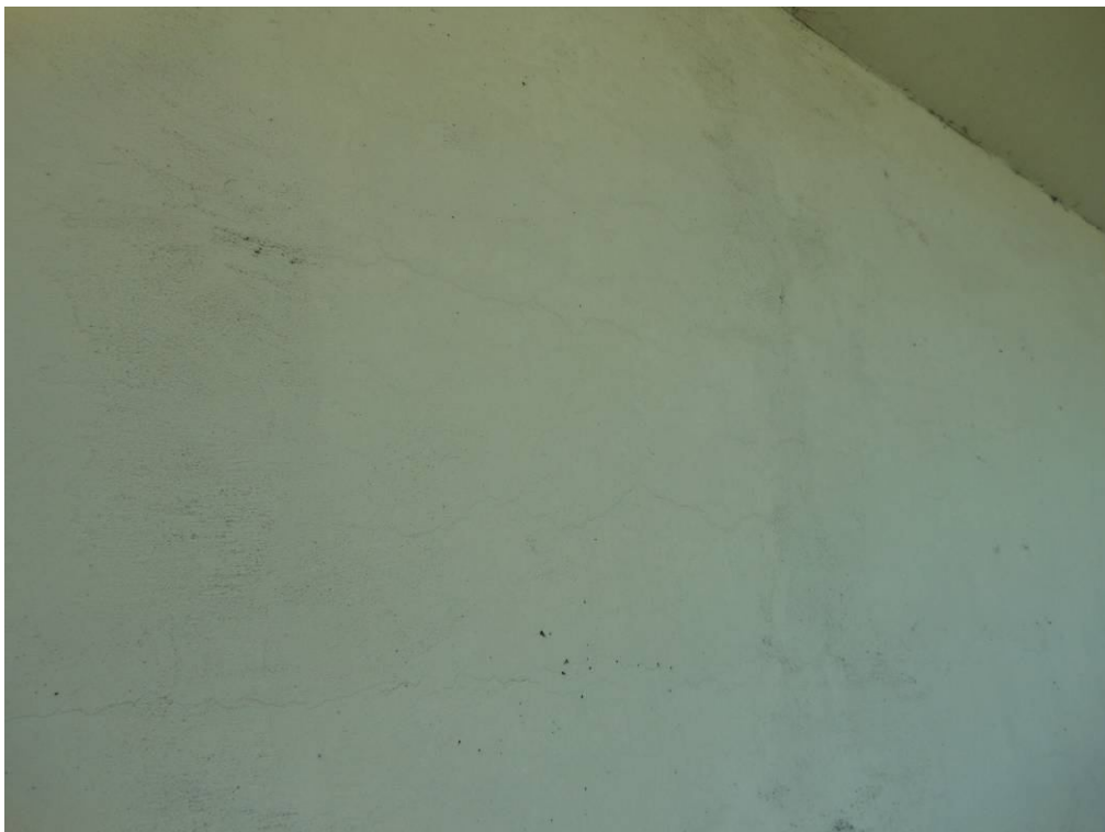
Fot. 44. Widok od strony Katowic na boczną powierzchnię dźwigara nad podporą nr 2. Poziome skurczowe zarysowania dźwigara.
