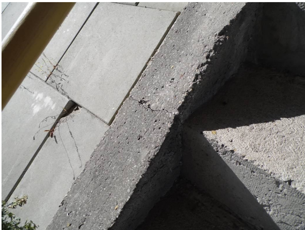
Fot. 81. Widok na umocnienia oraz schody naskarpowe przy przyczółku od strony Krakowa. Zarysowanie belki policzkowej schodów oraz wyłamane naroże płyty betonowej umocnienia.
