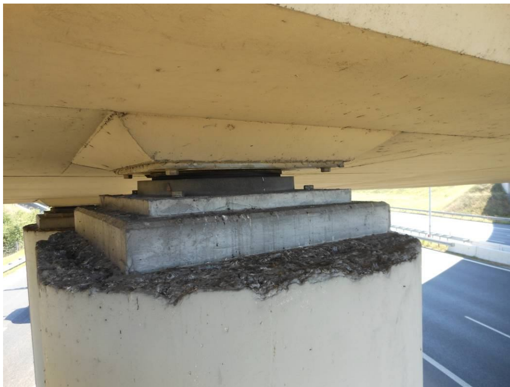
Fot. 64. Widok na głowicę słupa od strony Katowic podpory nr 3. Ubytki betonu powstałe w wyniku wadliwego wykonania, zanieczyszczenia głowicy ptasimi odchodami.
