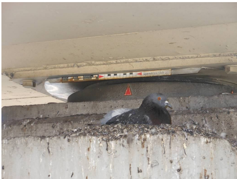
Fot. 63. Widok na głowicę słupa od strony Tarnowa podpory nr 3. Ubytki betonu powstałe w wyniku wadliwego wykonania, zanieczyszczenia głowicy ptasimi odchodami. Powierzchniowa korozja skali przesuwu łożyska.
