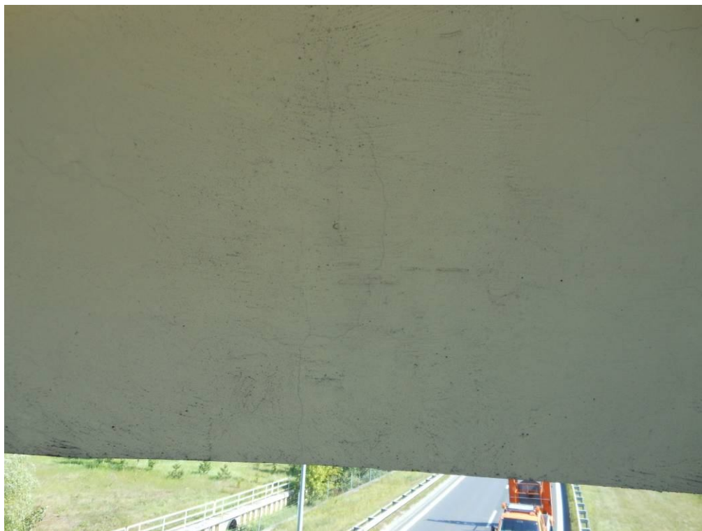
Fot. 45. Widok od strony Katowic na boczną powierzchnię dźwigara nad podporą nr 3. Pionowe skurczowe zarysowania dźwigara o rozwarości do 0,1 mm.
