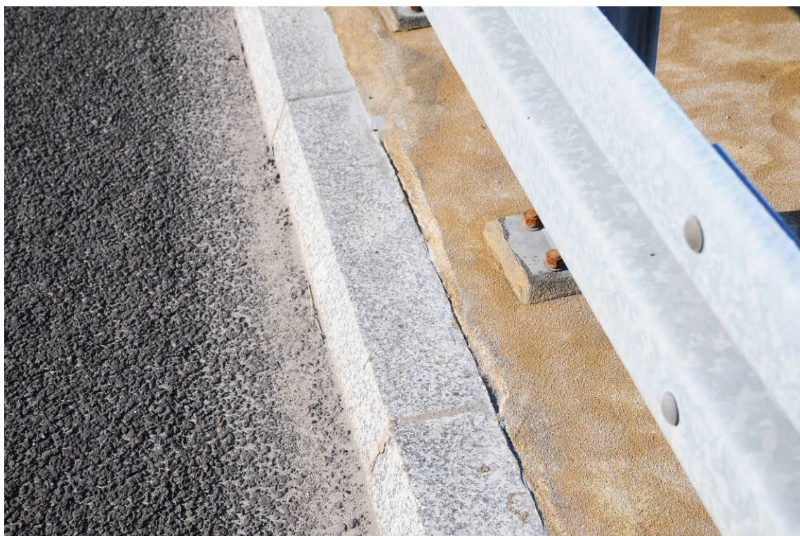
Fot. 20. Widok na krawężnik od strony Tarnowa w przęśle nr 2. Niedokończona naprawa nawierzchni chodnika, brak wierzchniej warstwy, ubytki betonu i uszczelnienia styków przy krawężniku. Zanieczyszczenie krawężnika.
