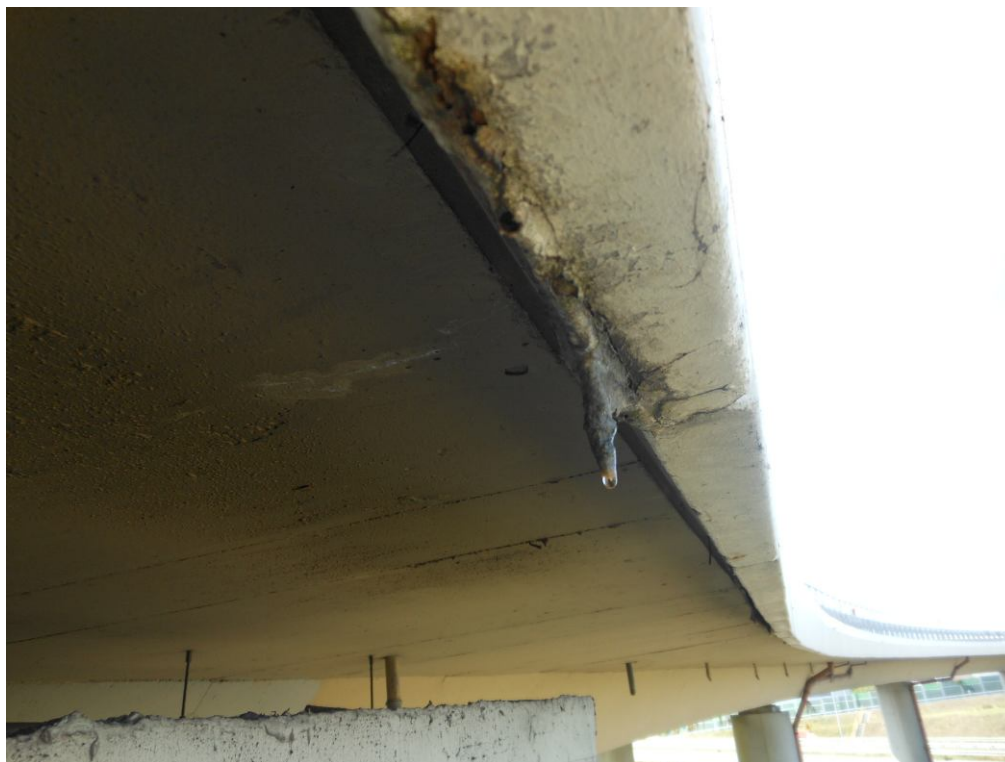
Fot. 22. Widok na deskę gzymsową od strony Tarnowa przy podporze nr 5. Stalaktyt powstały w wyniku przecieków na styku gzymsu i kapy chodnikowej. Wapienne wykwity w miejscu zarysowania poprzecznego wspornika pochodnikowego.
