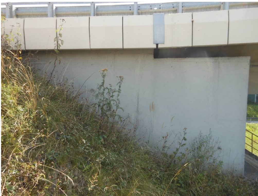
Fot. 61. Widok od strony Tanowa na skrzydełko przyczółka od strony Wieliczki. Zanieczyszczenie powierzchni skrzydełka.
