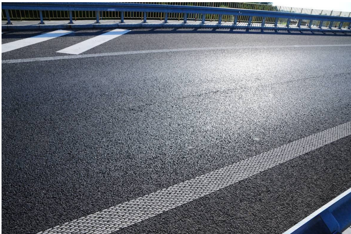
Fot. 5. Widok na nawierzchnię jezdni na wiadukcie w przęśle nr 5. Widoczne łączenie nawierzchni jezdni w szwie.
