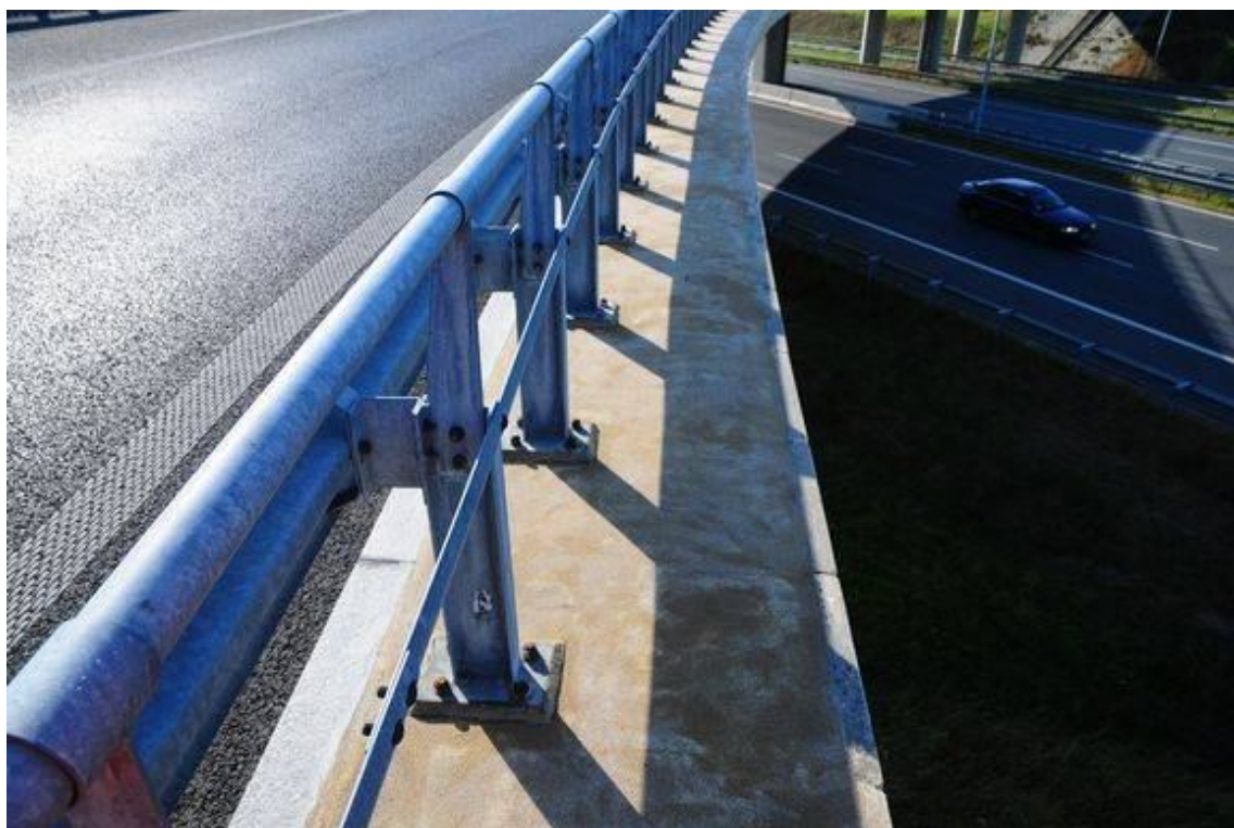
Fot. 18. Widok na kępę chodnikową od strony Tarnowa w przęśle nr 5. Niedokończone roboty związane z wymianą nawierzchni pobocza – brak wierzchniej warstwy.
