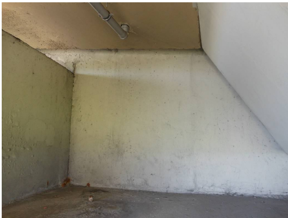
Fot. 58. Widok na ławę łożyskową i ściankę zapleczną przyczółka od strony Wieliczki. Pęcherze na powierzchni bocznej ścianki przyczółka, ślady korozji na powierzchni betonu powstałe w wyniku korozji prętów zbrojeniowych lub stalowych zanieczyszczeń przy powierzchni betonu, korodujący wystający pręt zbrojeniowy.
