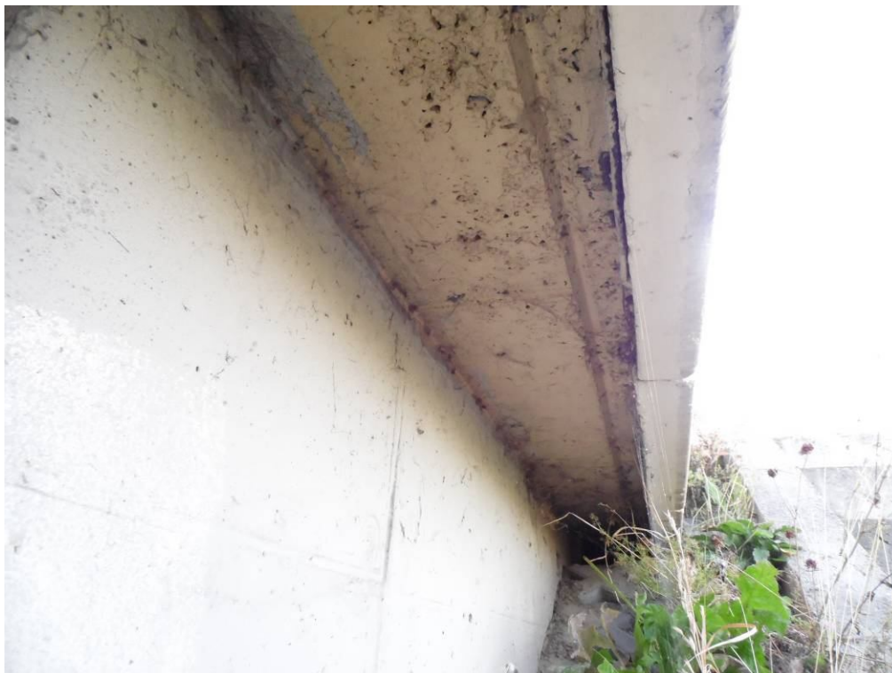
Fot. 54. Widok od strony Tarnowa na wspornik skrzydełka przyczółka od strony Krakowa. Raki na powierzchni betonu powstałe w wyniku niedostatecznego zagęszczenia mieszanki betonowej.
