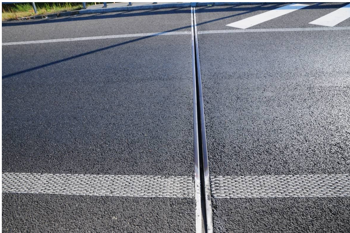
Fot. 40. Widok od strony Tarnowa na urządzenie dylatacyjne na jezdni nad przyczółkiem od strony Wieliczki. Niewielkie zanieczyszczenia wkładki neoprenowej przy krawężniku. Rozszczelnienie styku nawierzchni z dylatacją oraz niewielkie ubytki nawierzchni asfaltowej przy krawężniku.
