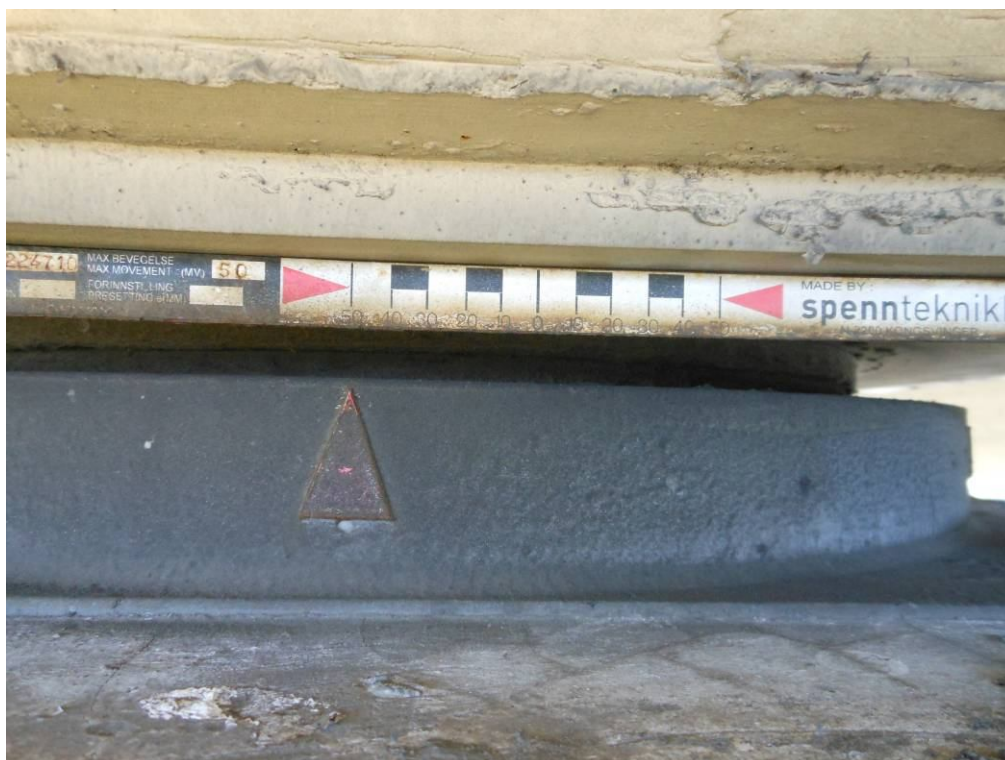
Fot. 71. Widok na łożysko podpory nr 2. Wychylenie łożyska do maksymalnej wartości 50 mm.
