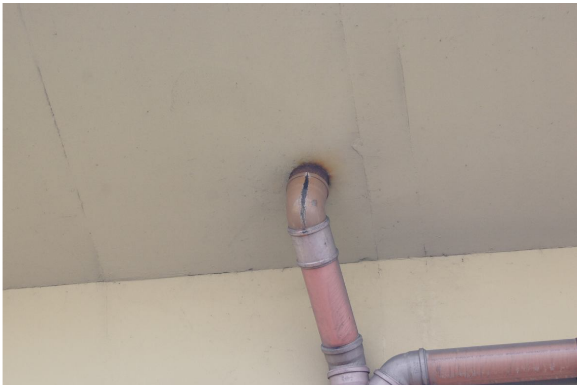
Fot. 38. Widok na rurę spustową wpustu od strony Tarnowa przy podporze nr 5. Korozja rury spustowej wpustu oraz pęknięty kielich kolektora powodujący przecieki.
