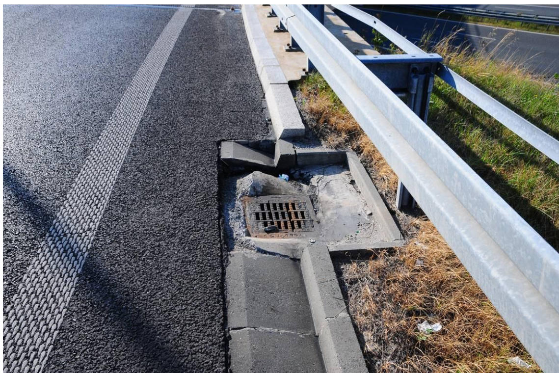
Fot. 32. Widok na wpust drogowy od strony Tarnowa na dojeździe od strony Wieliczki. Ubytki oraz spękania betonu wokół wpustu powstałe wskutek użycia materiałów niskiej jakości.
