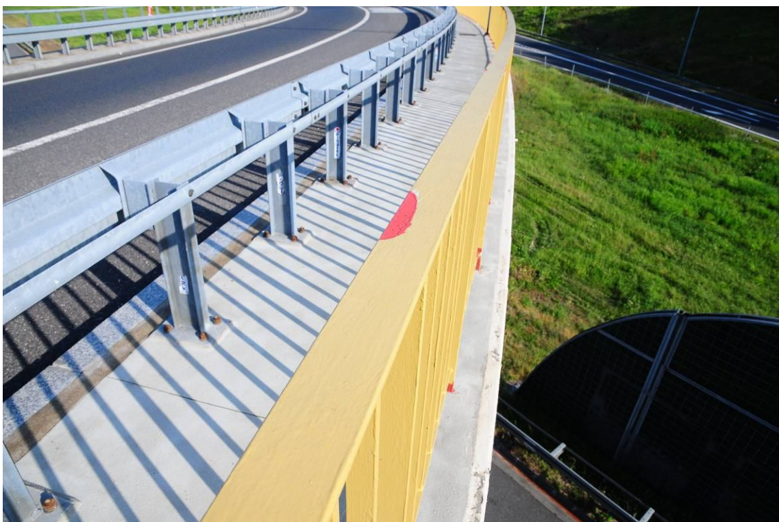
Fot. 28. Widok na barierę i balustradę od strony Katowic w prześle nr 4. Ubytki kapturek ochronnych i korozja nakrętek i kotew słupków barier. Widoczne ślady wadliwie wykonanych napraw zabezpieczenia antykorozyjnego balustrady bez wcześniejszego oczyszczenia ze złuszczonej się farby.
