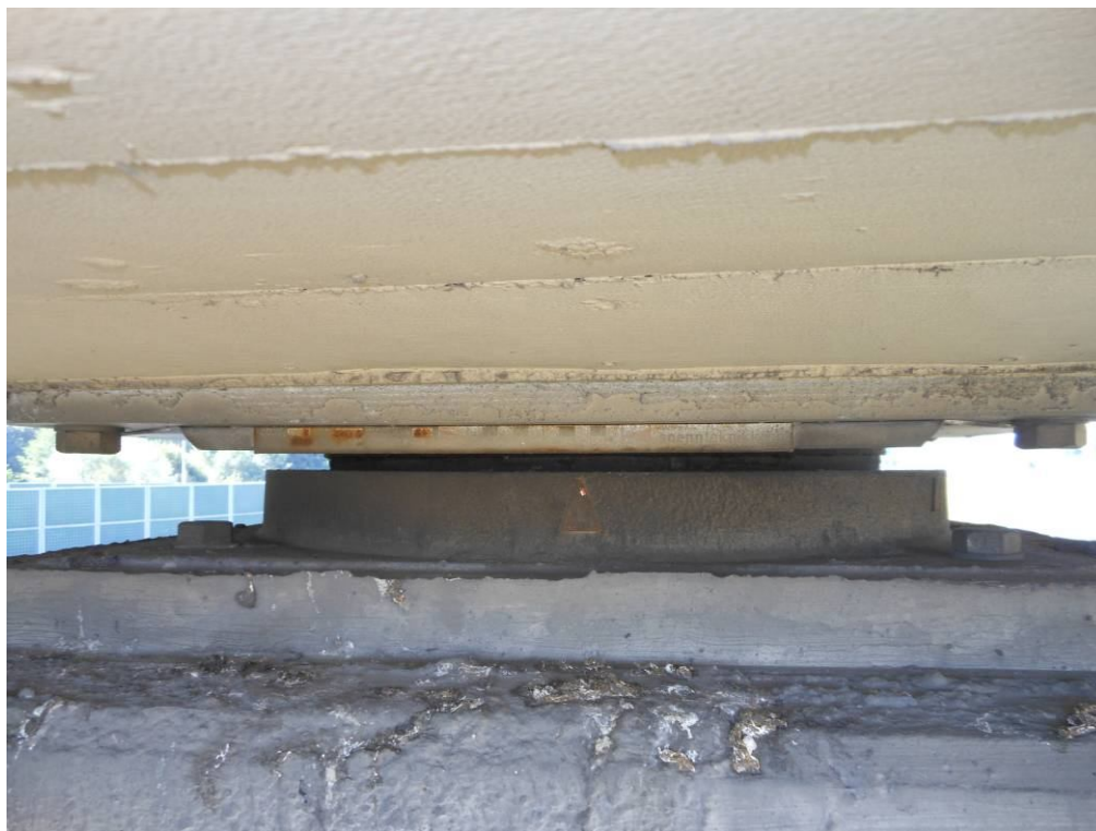
Fot. 72. Widok na łożysko podpory nr 3. Wychylenie łożyska o wartość 23 mm.
