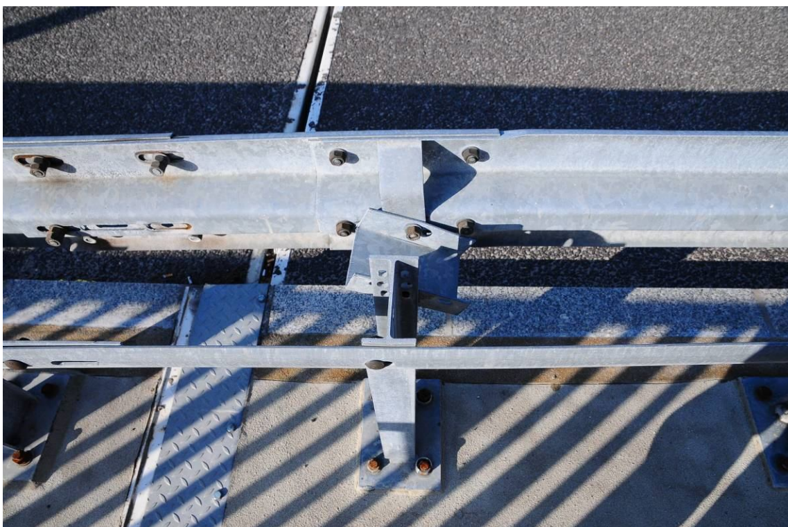
Fot. 29. Widok na barierę od strony Katowic nad dylatacją przyczółka od strony Wieliczki. Źle zamontowana przekładka łącząca prowadnicę i słupek.
