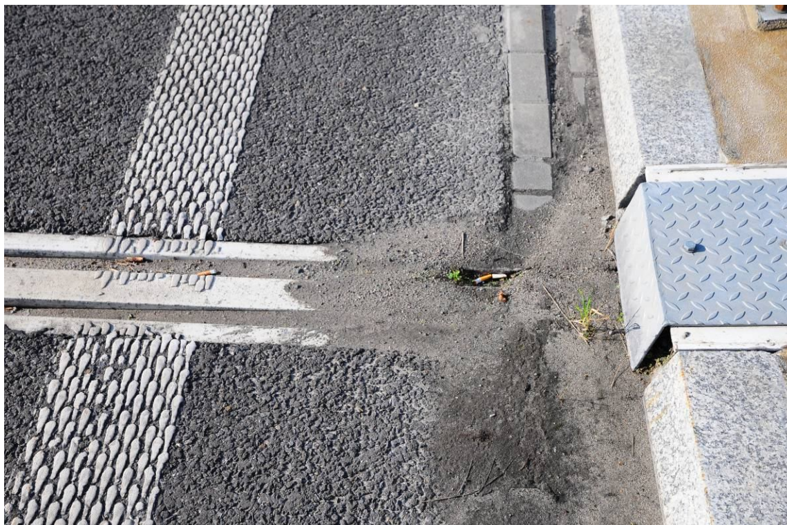
Fot. 41. Widok od strony Tarnowa na urządzenie dylatacyjne na jezdni nad przyczółkiem od strony Krakowa. Zanieczyszczenia wkładki neoprenowej przy krawężniku.
