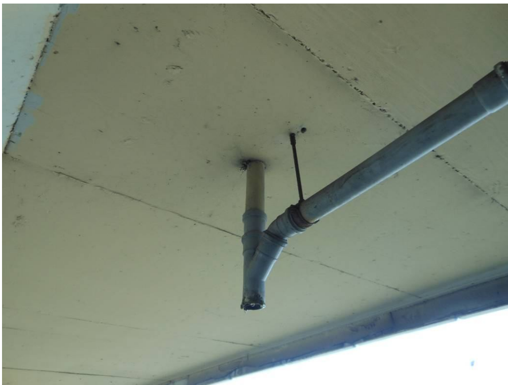
Fot. 36. Widok na wylot sączka od strony Tarnowa przy przyczółku od strony Wieliczki. Korozja elementów podwieszenia.
