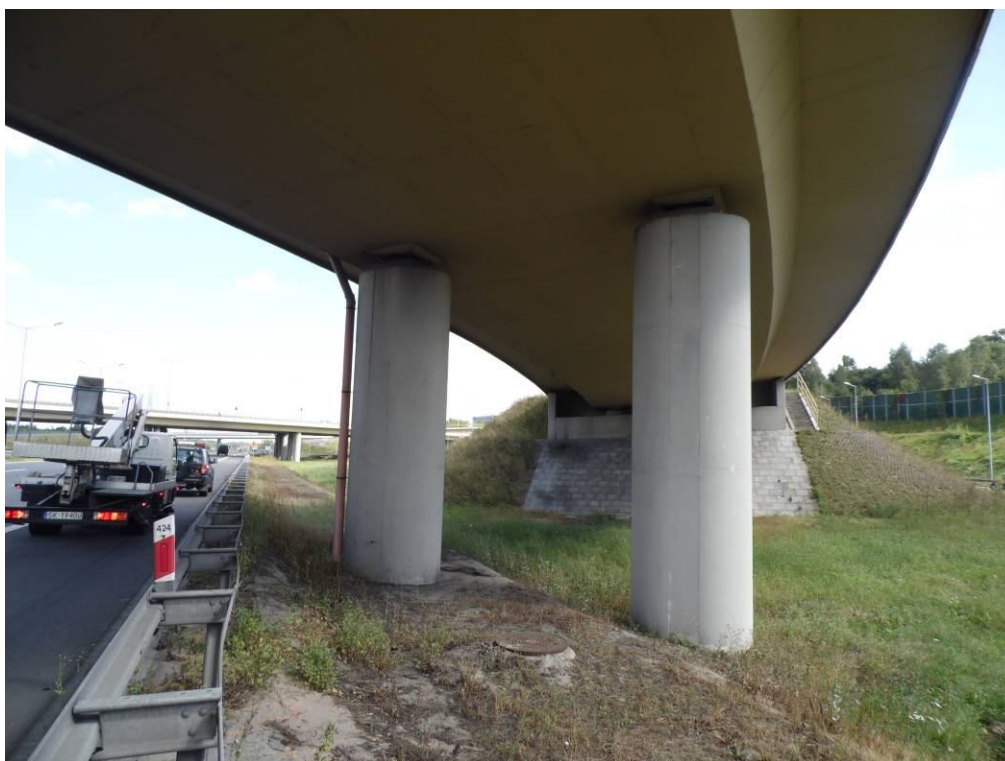
Fot. 68. Widok od strony Krakowa na podporę nr 5. Nie stwierdzono uszkodzeń.
