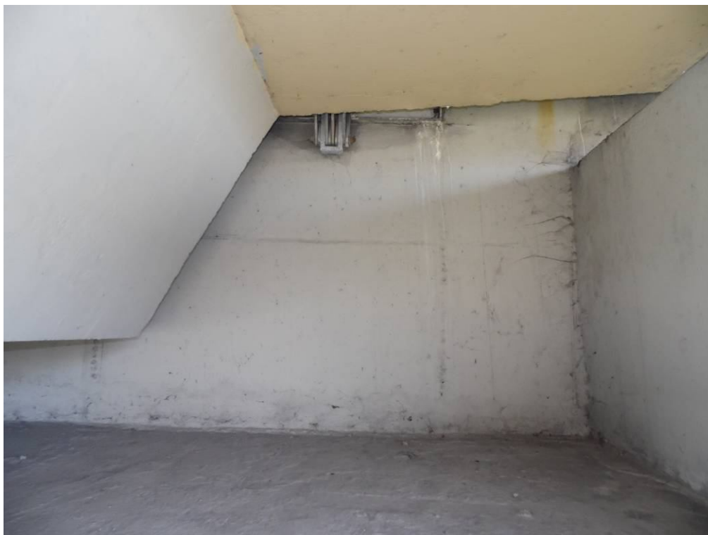
Fot. 55. Widok na ściankę zapleczną przyczółka od strony Krakowa. Wapienne i rdzawe zacieki powstałe w wyniku nieszczelności na styku urządzenia dylatacyjnego i ścianki zapleczej przyczółka.
