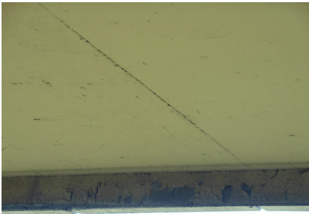
Fot. 21. Widok na wewnętrzną powierzchnię gzymsu od strony Tarnowa w strefie przy podporze nr 2. Ubytki i spękania powłoki malarskiej powstałe w wyniku wadliwego wykonania.
