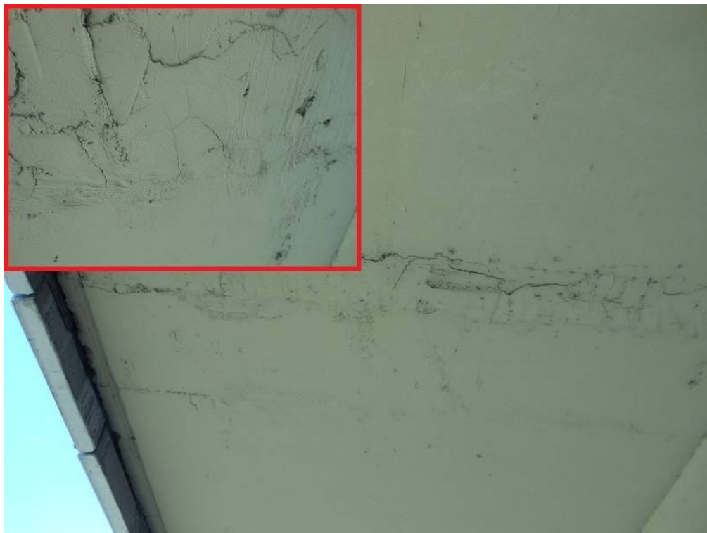
Fot. 50. Widok na wspornik podchodnikowy od strony Katowic nad podporą nr 3. Niestaranne wykonanie i zarysowanie naprawy powierzchniowej w miejscu przerwy technologicznej w betonowaniu konstrukcji nośnej.
