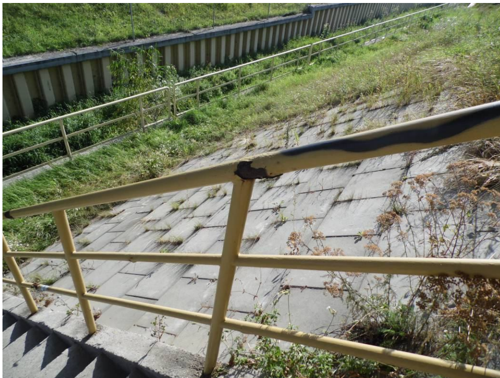
Fot. 80. Widok na balustradę schodów naskarpowych przy przyczółku od strony Krakowa. Korozja pochwytu oraz zanieczyszczenia w postaci graffiti balustrady.
