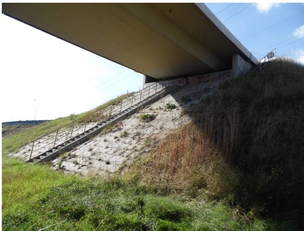
Fot. 78. Widok na umocnienie skarpy przyczółka oraz schody naskarpowe przy przyczółku od strony Krakowa. Wegetacja roślinności pomiędzy elementami umocnienia.
