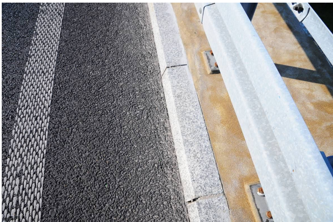
Fot. 19. Widok na krawężnik od strony Tarnowa w przęśle nr 4. Niedokończona naprawa nawierzchni chodnika, brak wierzchniej warstwy i uszczelnienia styków przy krawężniku, ubytki spoin pomiędzy krawężnikami powstałe w wyniku wadliwego wykonania.
