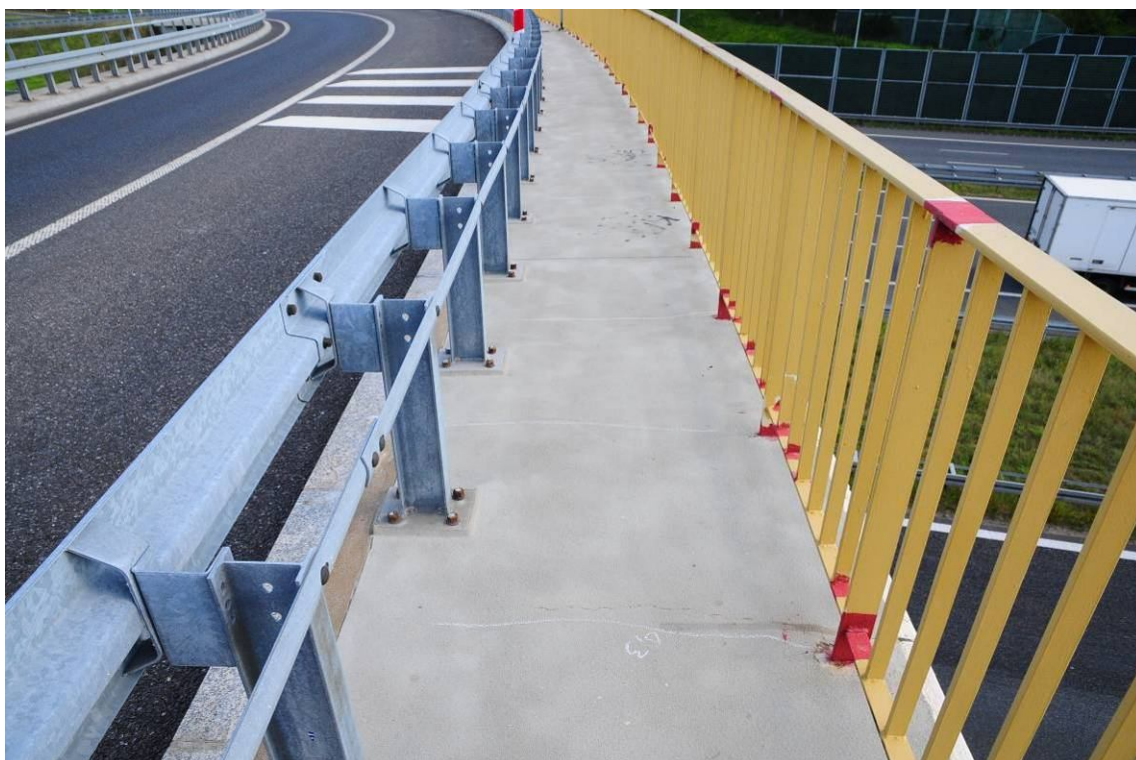
Fot. 11. Widok na kapę chodnikową od strony Katowic w prześle nr 2. Pęknięcia nawierzchni chodnika w miejscu zarysowań skurczowych kapy chodnikowej (rozwarłość do 0.3 mm). Niestarannie wykonane naprawy malarskie na balustradzie.
