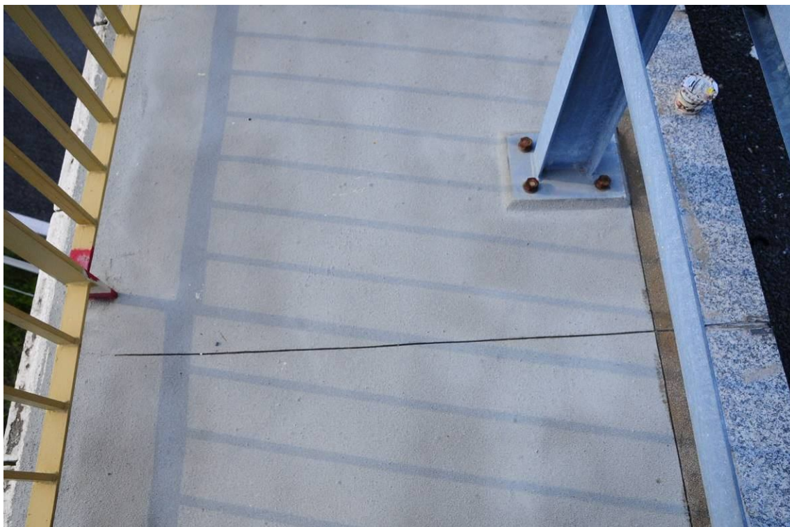
Fot. 13. Widok na kapek chodnikową od strony Katowic nad podporą nr 3. Brak wypełnienia nacięcia dylatacyjnego kapy chodnikowej.
