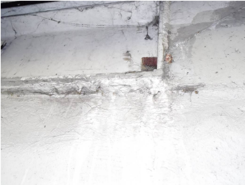
Fot. 43. Widok na dolną część profilu urządzenia dylatacyjnego nad przyczółkiem od strony Krakowa. Korozja śruby, wapienny wyciek na styku profilu urządzenia dylatacyjnego ze ścianką zapleczną.
