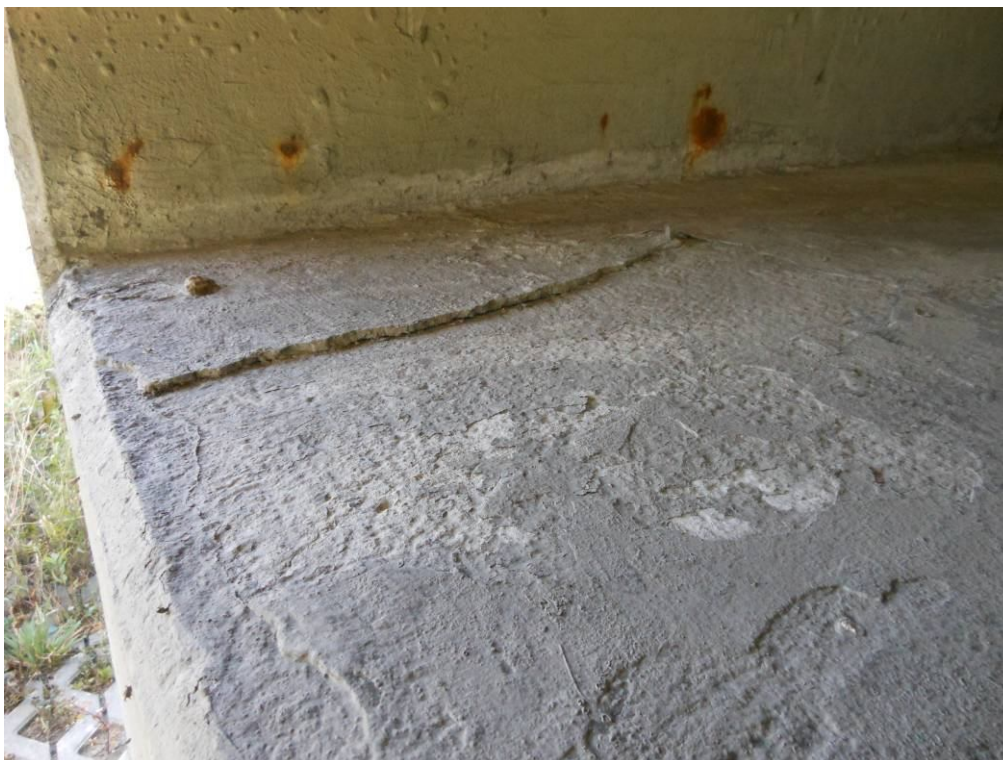
Fot. 59. Widok na ławę łożyskową przyczółka od strony Wieliczki. Pęcherze na powierzchni bocznej ścianki przyczółka, ubytki wyprawy oraz betonu ławy łożyskowej, ślady korozji na powierzchni betonu powstałe w wyniku korozji stalowych zanieczyszczeń przy powierzchni betonu. Wystający korodujący pręt zbrojeniowy.
