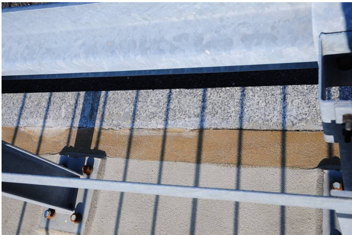
Fot. 7. Widok na krawężnik i kapę chodnikową od strony Katowic w przęśle nr 1. Niedokończona naprawa nawierzchni chodnika, brak wierzchniej warstwy i uszczelnienia styków przy krawężniku na całej długości wiaduktu.
