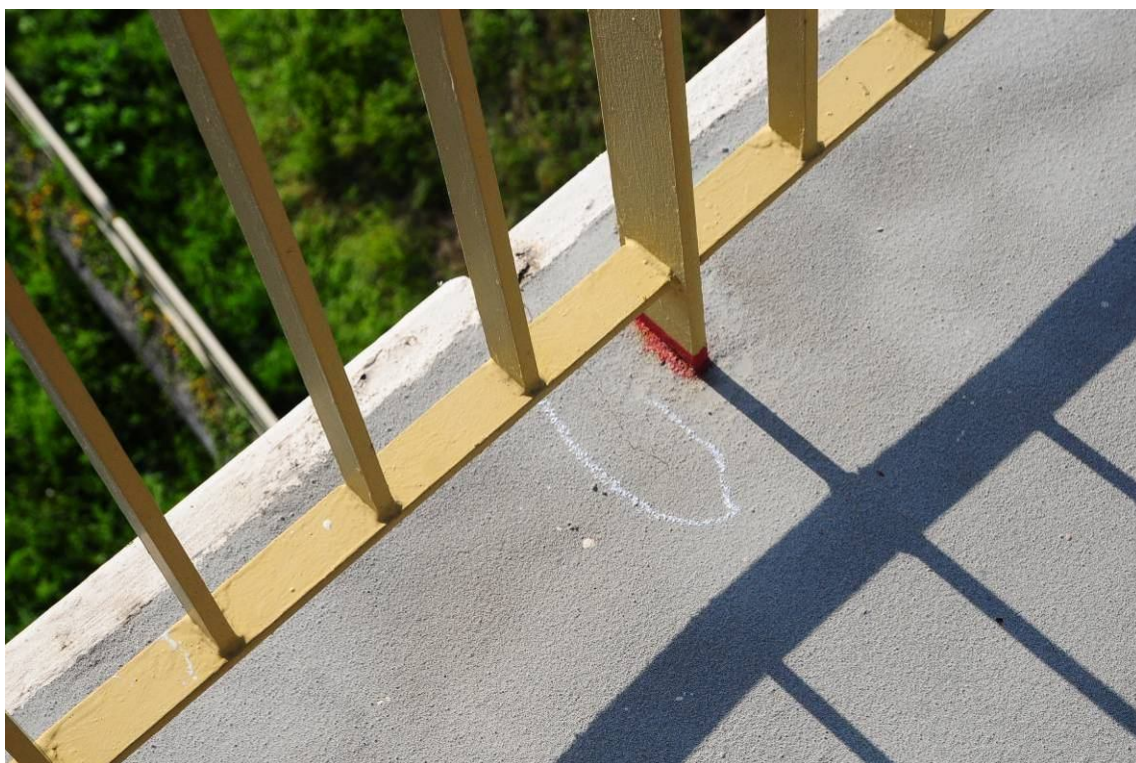
Fot. 8. Widok na kapę chodnikową od strony Katowic w przęśle nr 1. Pęknięcie nawierzchni chodnika w miejsc zarysowania skurczowego kapy chodnikowej.
