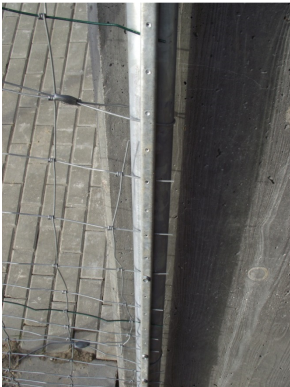
Fot. 3 – przykład szczelnego dowiązania wygradzenia do obiektu
