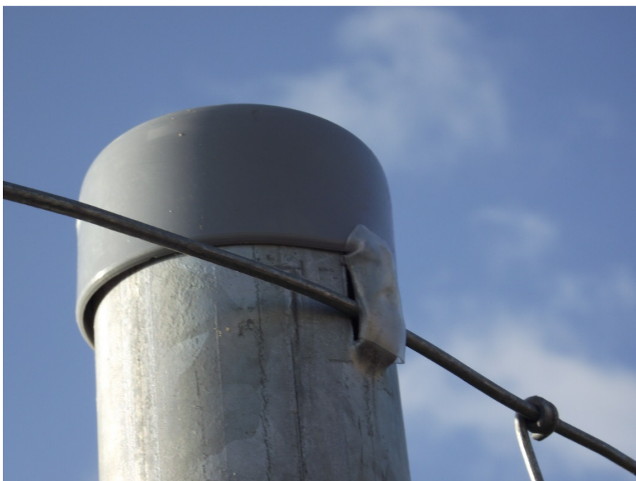
Fot. 2 – przykład rozwiązania zabezpieczenia końca słupka oraz miejsca styku drutu konstrukcji siatki ze słupkiem.
