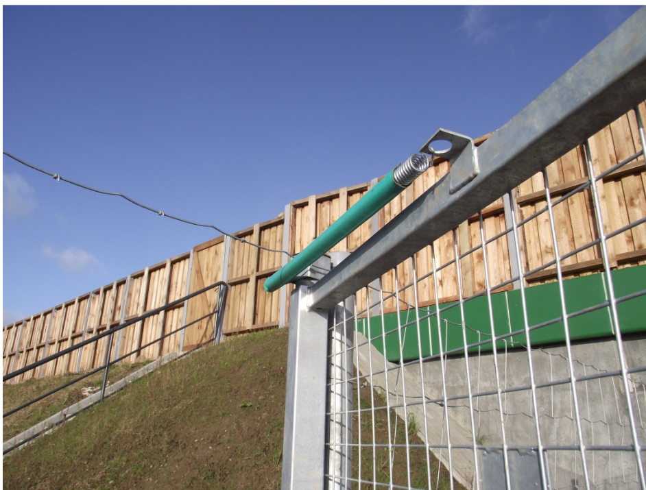
Fot. 1 – przykład rozwiązania samozamykacza furtki
