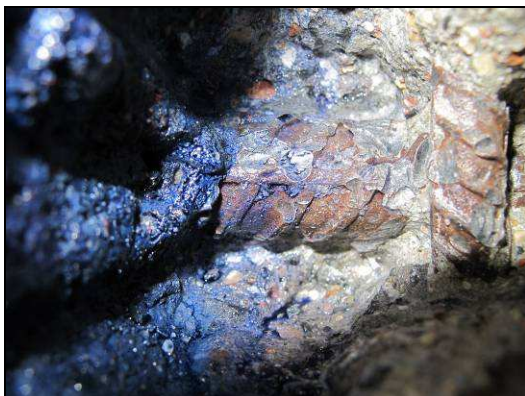
Fot. 4.5. Widok wykonanych odkrywek w a) w dźwigarze płytowym, b) w słupie podpory c) w poprzecznicy płyty
