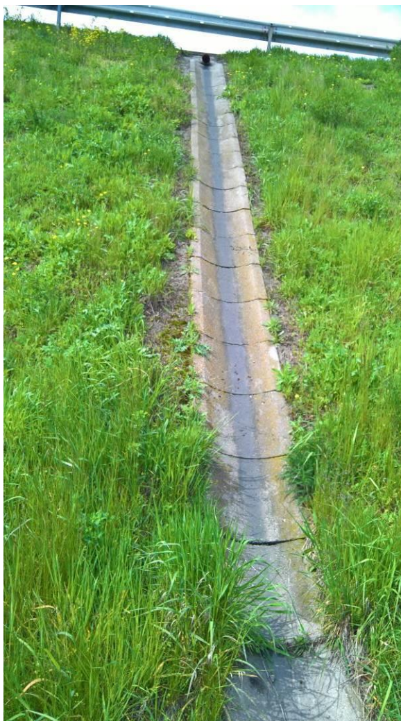
Fot. 10 Widok na ściek skarpowy
