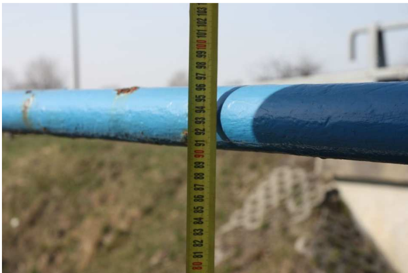
Wysokość balustrad nie spełniająca wymagań zawartych w Dz.U.2000r Nr 63 poz.735
