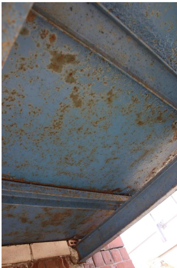
Widok od spodu kładki – widoczne ślady korozji stalowych profili i blachy pomostu
