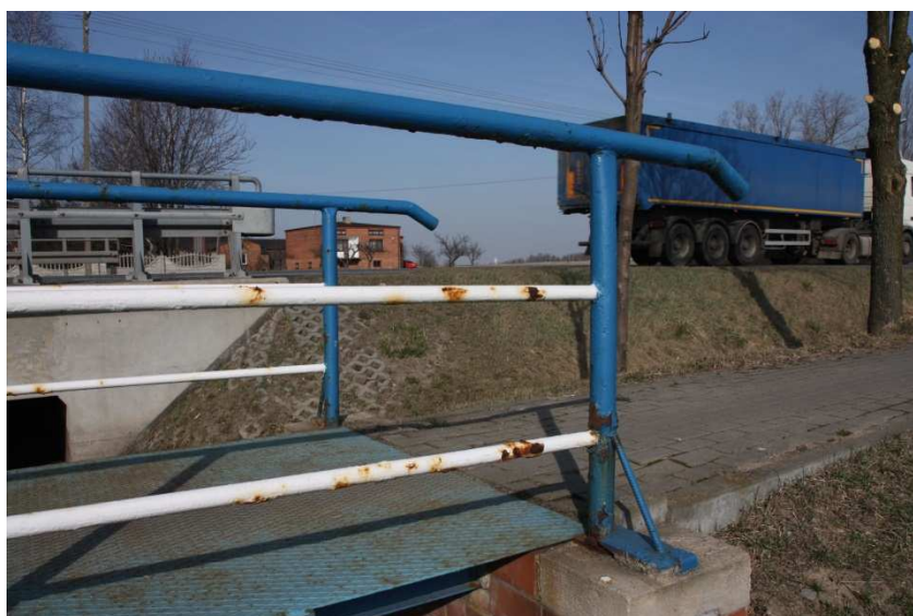
Korozja balustrad
