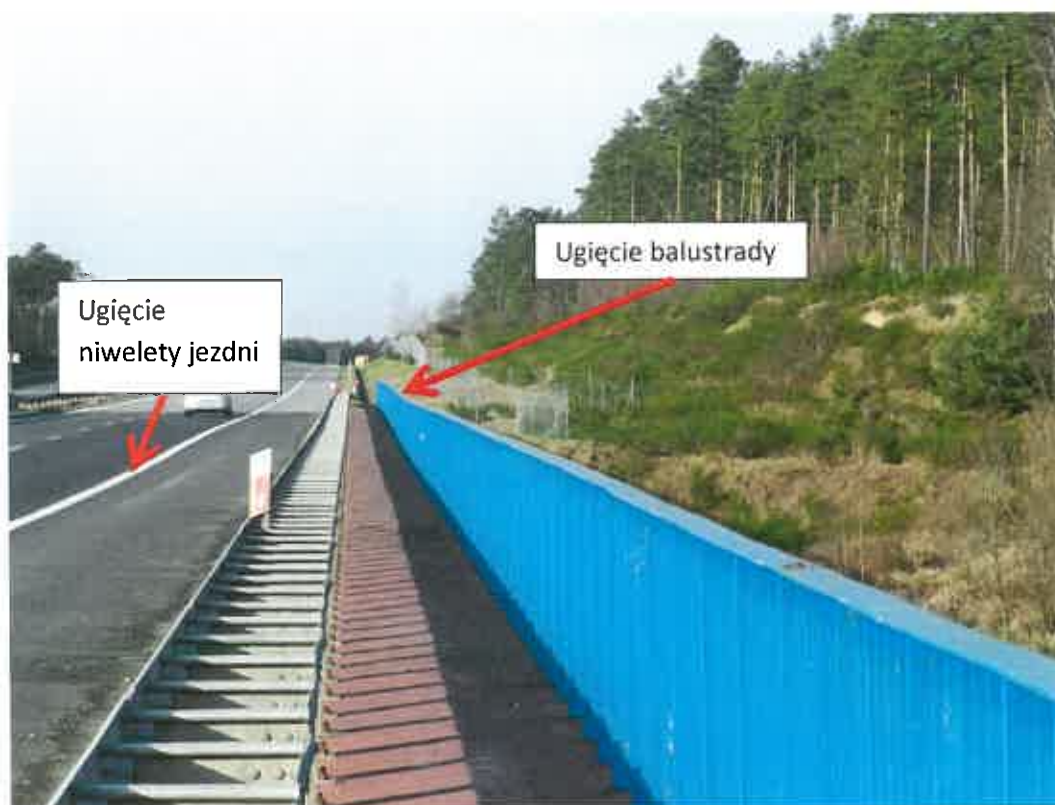
Fot. 3. Widok na pomost oraz raz balustradę w przęśle środkowym. Widoczne ugięcie przęsła (balustrady)
