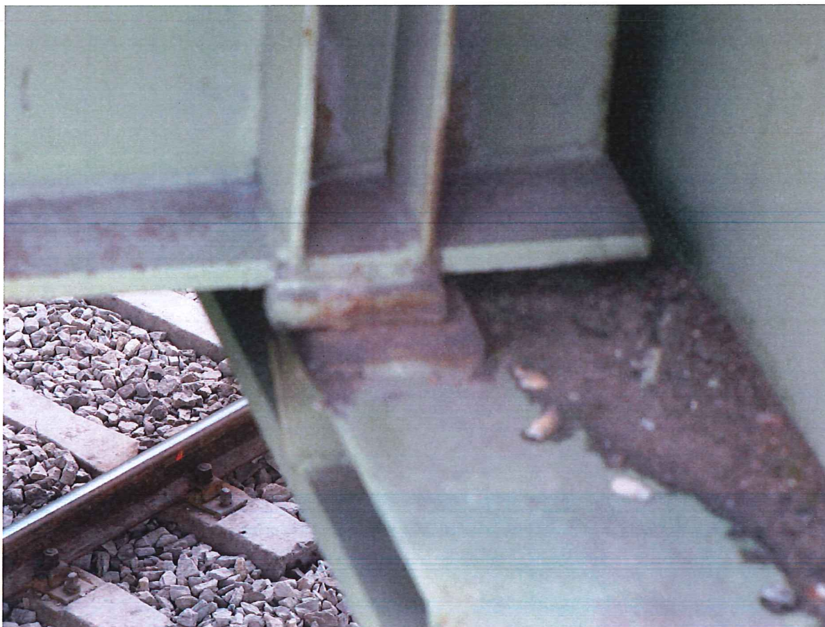
Fot. 1 – brak współosiowości dolnej i górnej płyty łożyskowej łożyska skrajnego na filarze
