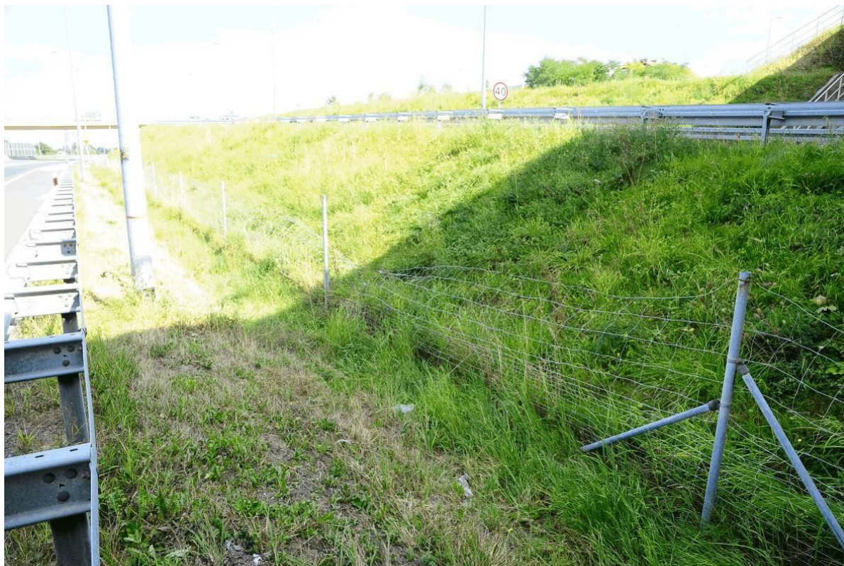
Fot. 77. Widok na przestrzeń podmostową pod przęsłem nr 5 – uszkodzenie siatki stalowej.
