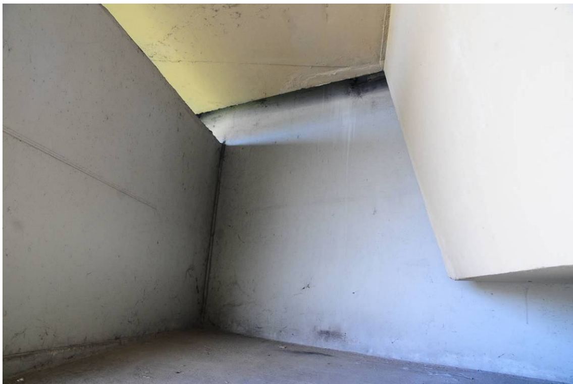
Fot. 62. Widok na ściankę zapleczną przyczółka od strony Wieliczki – zacieki wapienne na powierzchni ścianki zapleczej powstałe w wyniku nieszczelności styku urządzenia dylatacyjnego ze ścianką zapleczną przyczółka.
