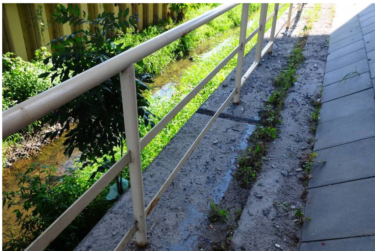
Fot. 82. Widok na przestrzeń podmostową pod przęsłem nr 1 – wegetacja roślinności w korycie potoku Malinówka oraz pomiędzy elementami betonowymi, złuszczenia zabezpieczeń antykorozyjnych oczezu ścianki szczelnej koryta potoku.
