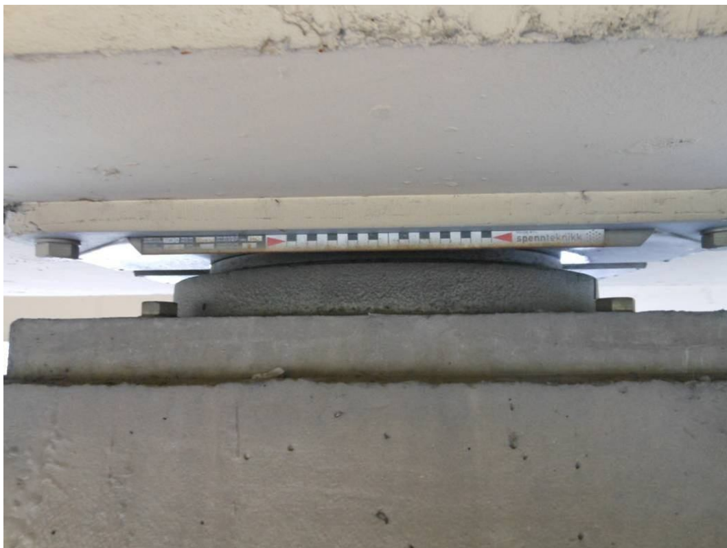
Fot. 73. Widok na łożysko dźwigara nr 2 na podporze nr 6 – korozja skali wychyleń łożyska.
