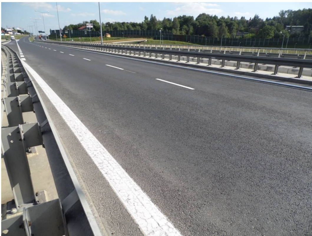
Fot. 5. Widok od strony Krakowa na jezdnię na wiadukcie w przęśle nr 1 – spękania powłoki malarskiej oznakowania poziomego, brak uszkodzeń nawierzchni jezdni.
