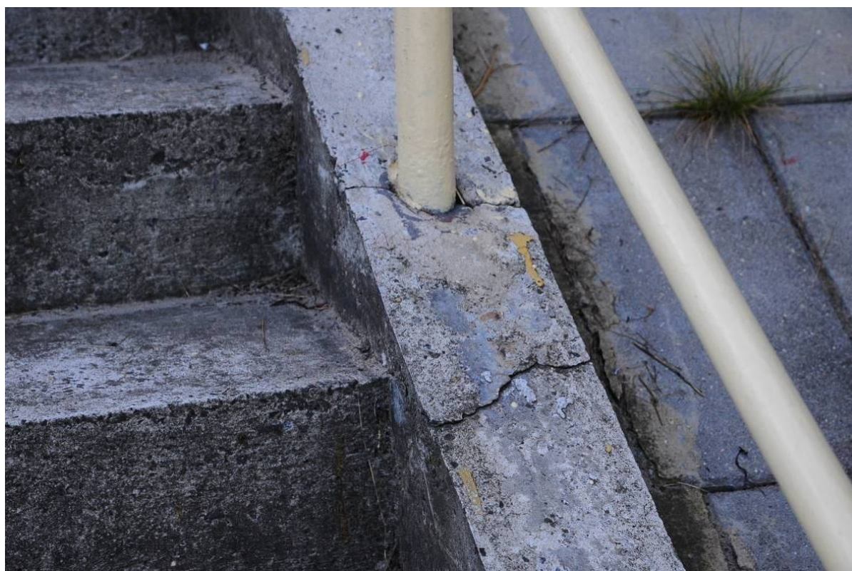
Fot. 78. Widok na belkę policykową schodów naskarpowych przy przyczółku od strony Wieliczki – pęknięcie belki policykowej powstałe w wyniku niedostatecznego zbrojenia.
