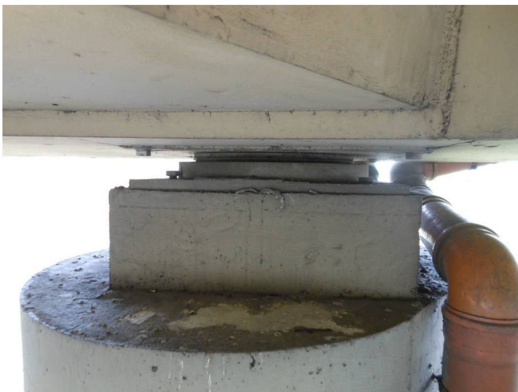
Fot. 68. Widok na cios łożyskowy na podporze nr 2 – zanieczyszczenia ciosu łożyskowego oraz łożyska.
