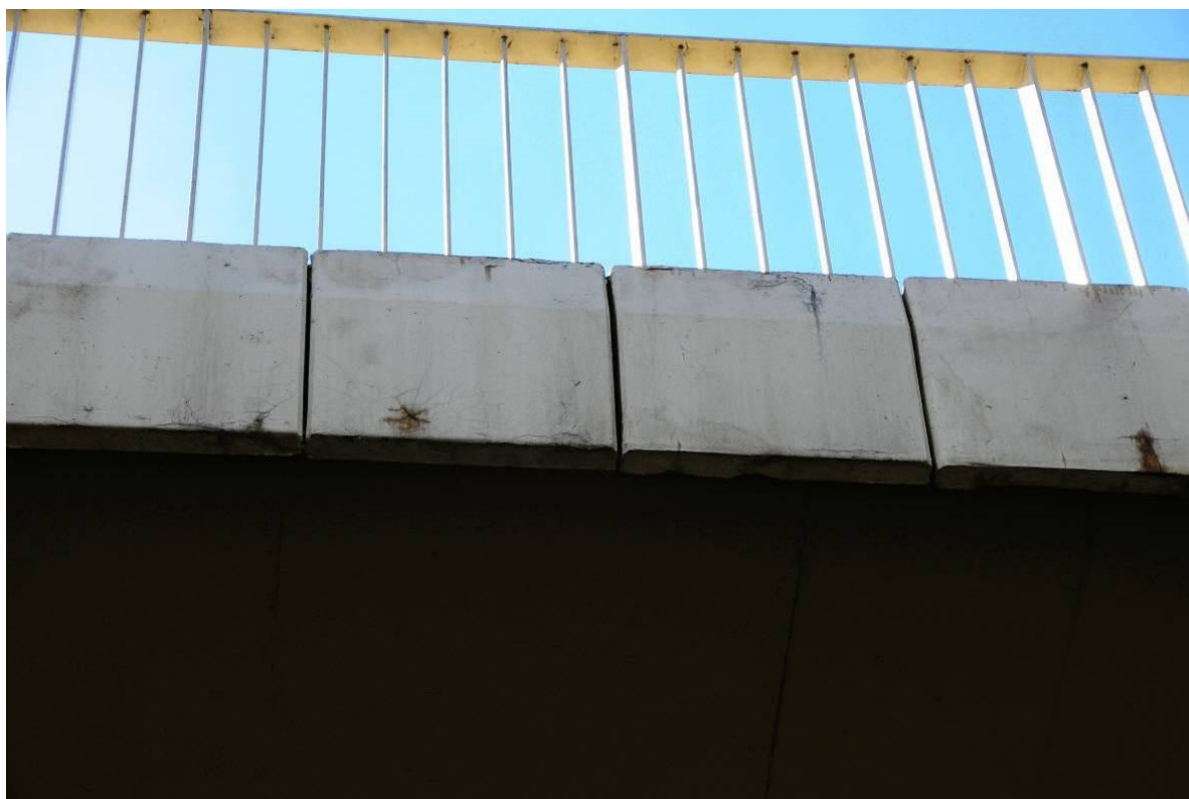
Fot. 20. Widok na gzyms od strony Tarnowa w przęśle nr 4 – spękania skurczowe betonu desek oraz rdzawe wycieki w miejscach zarysowań powstałe w wyniku korozji zbrojenia.
