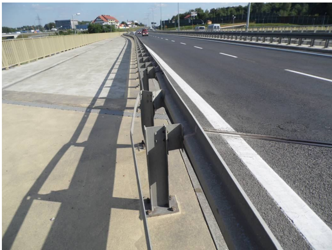
Fot. 22. Widok na barierę od strony Tarnowa nad przyczółkiem od strony Krakowa – brak śruby mocującej taśmę profilową do słupka, deformacja przekładki i słupka przy dylatacji powstałe w wyniku uderzenia pojazdu. Brak kapturek ochronnych oraz korozja nakrętek i kotew słupków.
