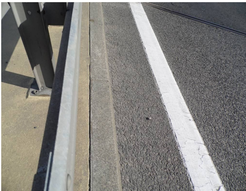
Fot. 9. Widok na krawężnik od strony Tarnowa nad przyczółkiem od strony Krakowa – ubytki wypełnienia szczeliny po nacięciu w betonie na styku krawężnika i kapy chodnikowej powstałe w wyniku wadliwego wykonania.
