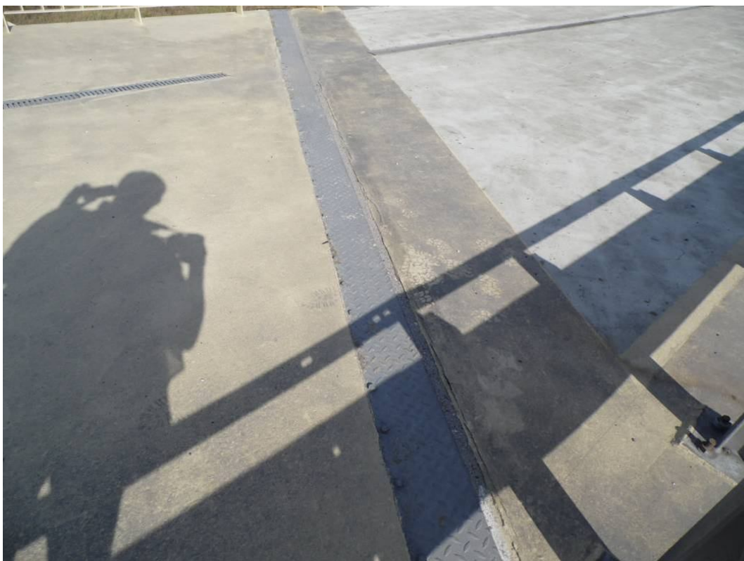
Fot. 40. Widok na urządzenie dylatacyjne na chodniku od strony Tarnowa nad przyczółkiem od strony Krakowa – ubytki zabezpieczenia antykorozyjnego blachy przykrywającej urządzenie, zarysowanie na styku profilu stalowego urządzenia i wyprawy cementowej naprawianej części kapy chodnikowej.
