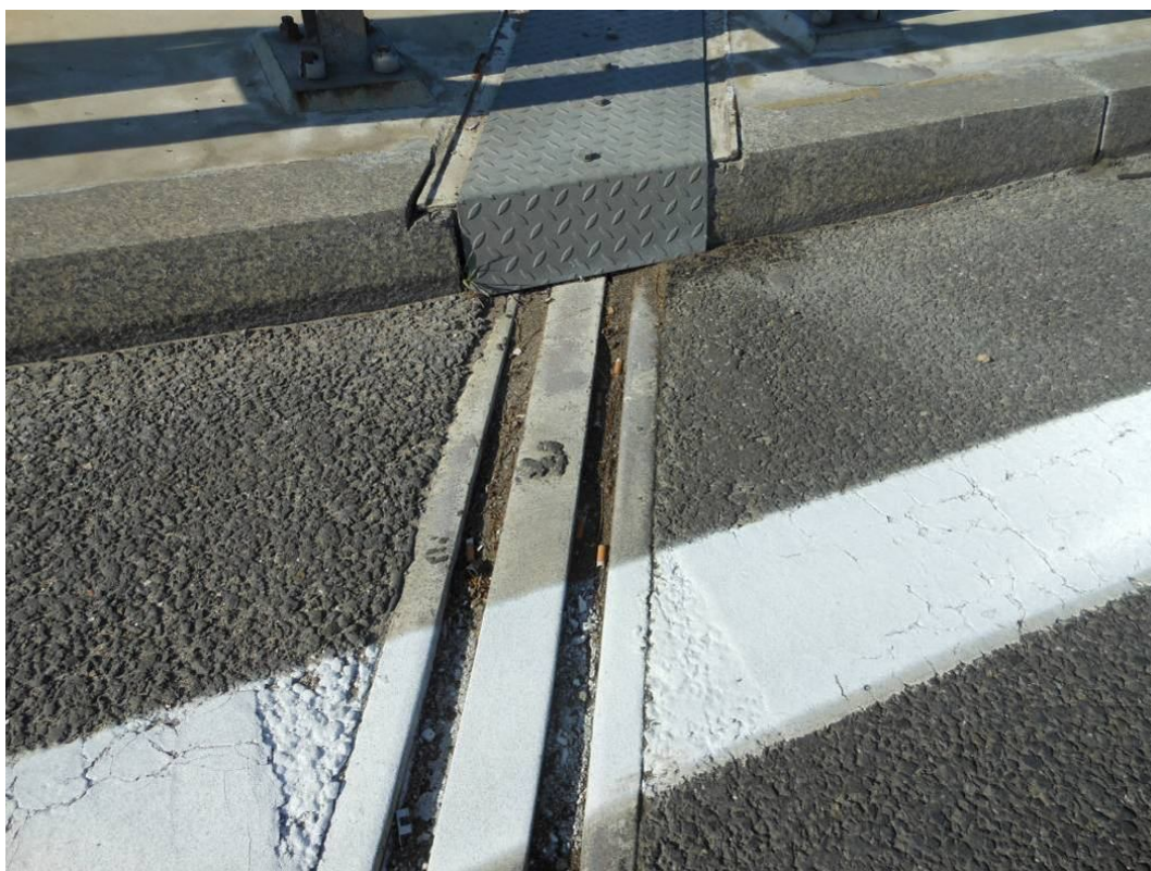
Fot. 42. Widok na urządzenie dylatacyjne nad przyczółkiem od strony Wieliczki – zanieczyszczenie wkładki urządzenia, rdzawe plamy powstałe w wyniku korozji profilu stalowego urządzenia na chodniku.
