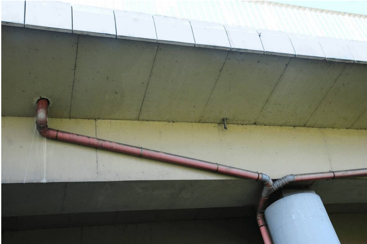
Fot. 49. Widok od strony Tarnowa na dźwigar nr 1 w przęśle nr 2 – zarysowania skurczowe oraz wapienne przecieki na bocznej powierzchni dźwigara powstałe w wyniku nieszczelnej izolacji pomostu wokół wpustu.
