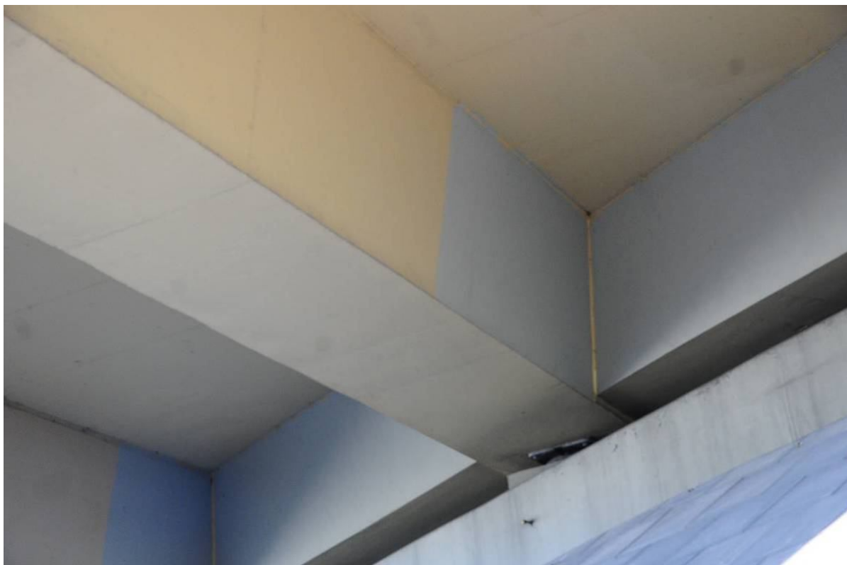
Fot. 52. Widok na oparcie dźwigara nr 2 na przyczółku od strony Wieliczki – widoczne ślady napraw powierzchniowych betonu przykryte żle dobraną kolorystycznie powłoką malarską.
