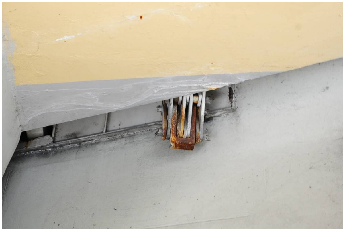
Fot. 44. Widok od spodu na urządzenie dylatacyjne nad przyczółkiem od strony Wieliczki – korozja urządzenia dylatacyjnego oraz wapienne zacieki na powierzchni wspornika podchodnikowego powstałe w wyniku nieszczelności urządzenia dylatacyjnego.
