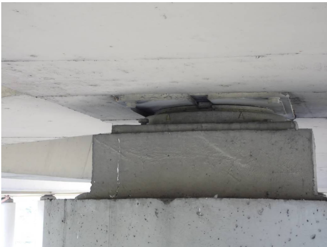
Fot. 74. Widok na łożysko dźwigara nr 2 na podporze nr 4 – niestarannie wykonana powłoka malarska ciosu, brak uszkodzeń łożyska.
