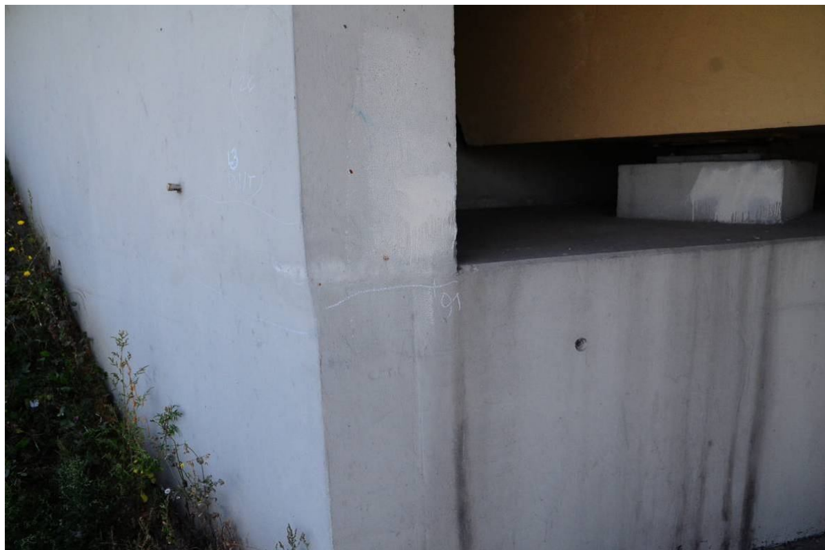
Fot. 61. Widok od strony Tarnowa na przyczółek od strony Wieliczki – brudne zacieki, zarysowanie skurczowe o rozwartości 0,1 mm, rdzawe plamy powstałe w wyniku korozji stalowych zanieczyszczeń betonu, niestarannie wykonane poprawki zabezpieczeń antykorozyjnych betonu.
