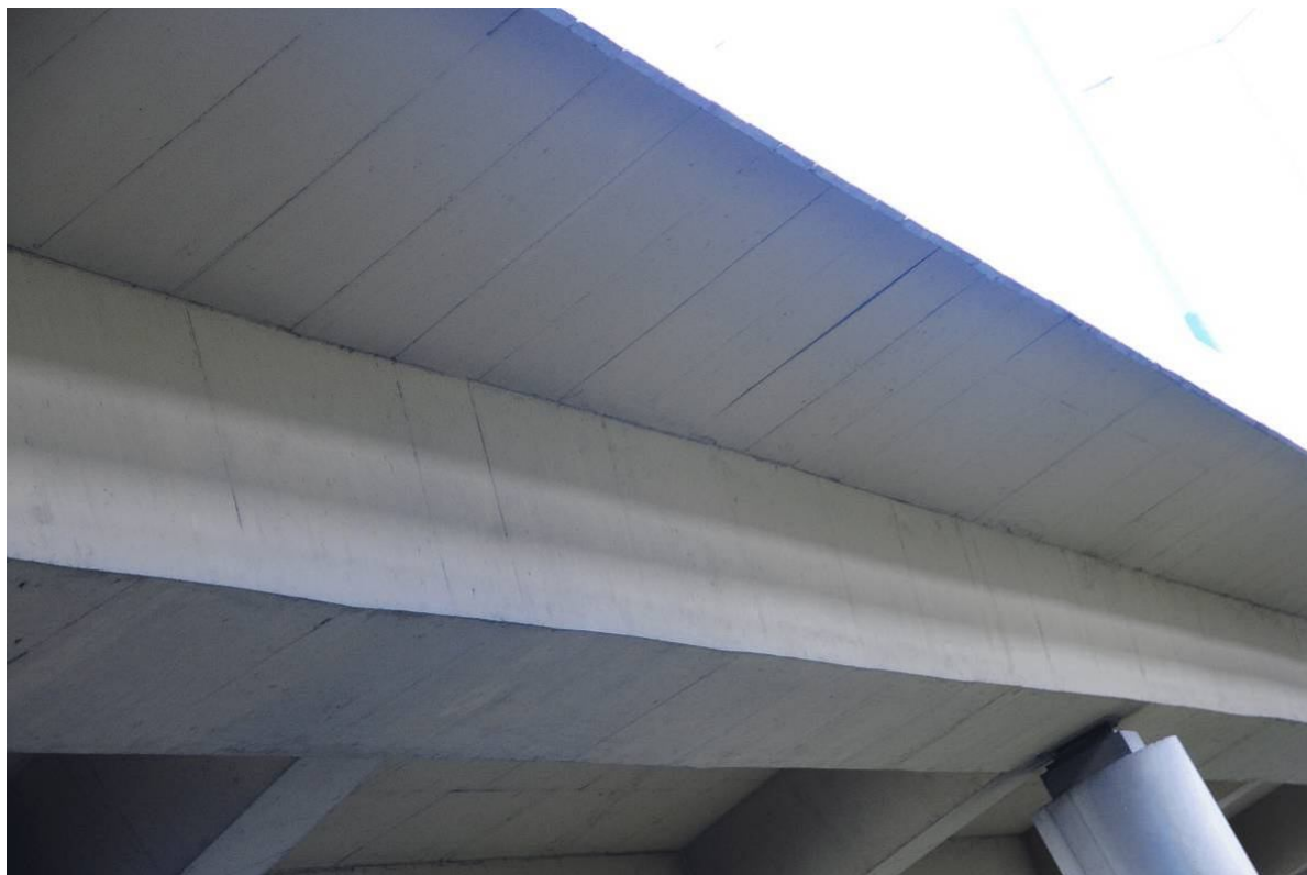
Fot. 57. Widok od strony Katowic na wspornik podchodnikowy w przęśle nr 3 – widoczne zanieczyszczenia w miejscach nierówności pozostałych po szalunkach.
