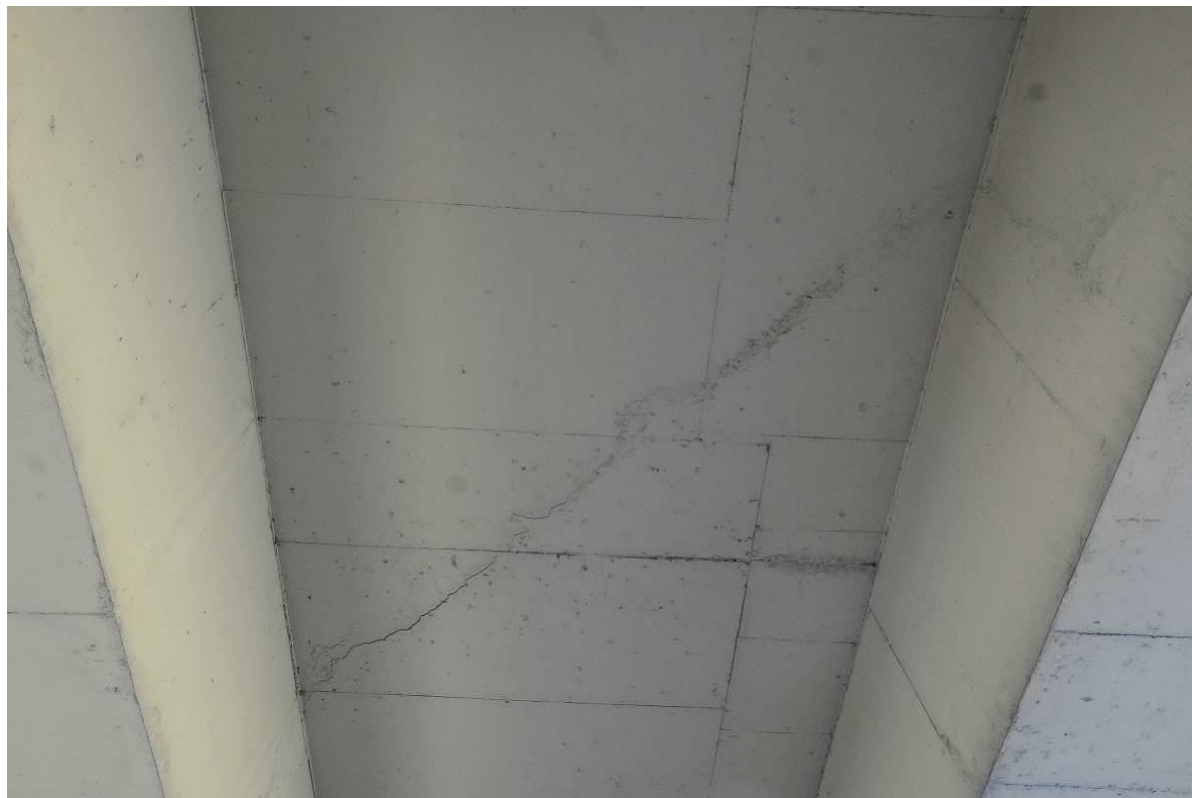
Fot. 56. Widok na płytę pomostu w przęśle nr 3 – widoczne ślady napraw powierzchniowych w miejscu przerwy technologicznej w betonowaniu.
