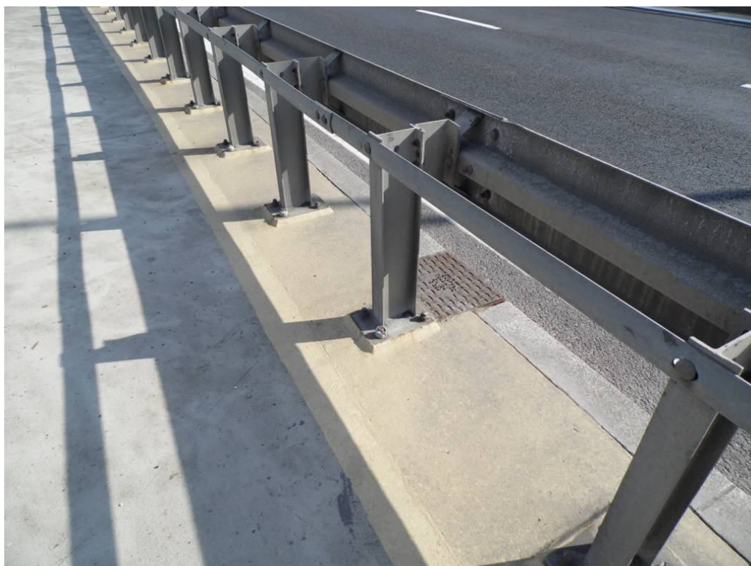
Fot. 10. Widok na pobocze od strony Tarnowa w przęśle nr 1 – widoczna naprawa nawierzchni pobocza na szerokości ok. 1 m na całej długości wiaduktu. Brak uszczelnienia styku nawierzchni pobocza z krawężnikiem wynikający z wadliwego wykonania robót.
