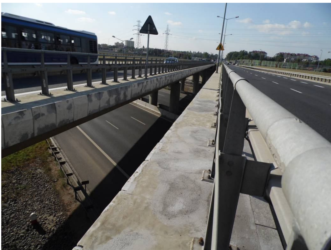
Fot. 12. Widok na kapę chodnikową od strony Katowic w prześle nr 4 – wypiaskowana powierzchnia kapy chodnikowej przygotowana do ułożenia nowej nawierzchni (podczas remontu prowadzony był remont kap), widoczne ślady napraw powierzchniowych.
