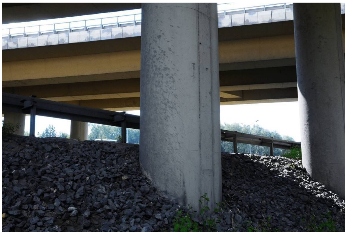
Fot. 65. Widok od strony Tarnowa na podporę nr 2 – zanieczyszczenia filara w postaci zachłapań zaprawą.
