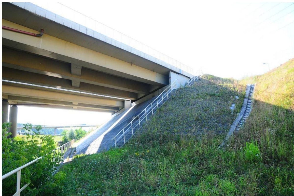
Fot. 81. Widok od strony Tarnowa na umocnienie stożka przyczółka od strony Krakowa – wegetacja roślinności.
