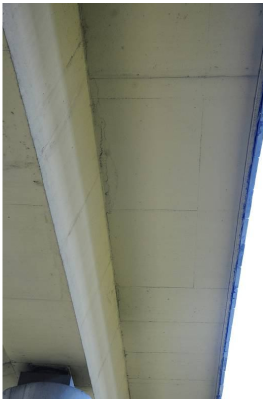
Fot. 58. Widok na wspornik podchodnikowy od strony Katowic w przęśle nr 4 – widoczne zarysowania skurczowe na styku dźwigara i wspornika pochodnikowego powstałe w wyniku wadliwego wykonania.
