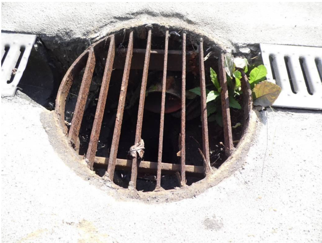
Fot. 32. Widok na studzienkę ściekową na chodniku od strony Tarnowa w przęśle nr 1 – korozja kratki, wegetacja roślinności.
