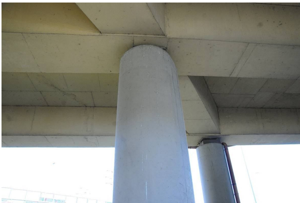
Fot. 66. Widok od strony Katowic na podporę nr 2 – zanieczyszczenia filara w postaci ptasich odchodów.
