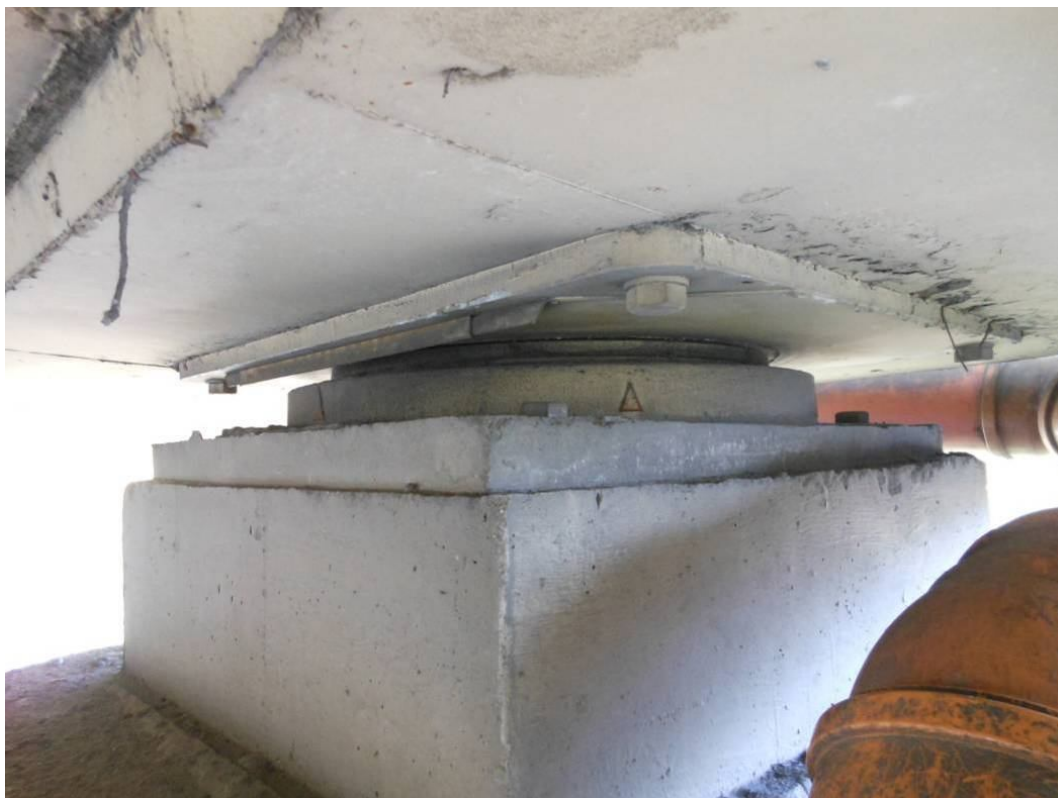
Fot. 54. Widok na oparcie dźwigara nr 1 na podporze nr 2 – wystające korodujące druty wiązałkowe z betonu dźwigara powstałe w wyniku wadliwego wykonania.
