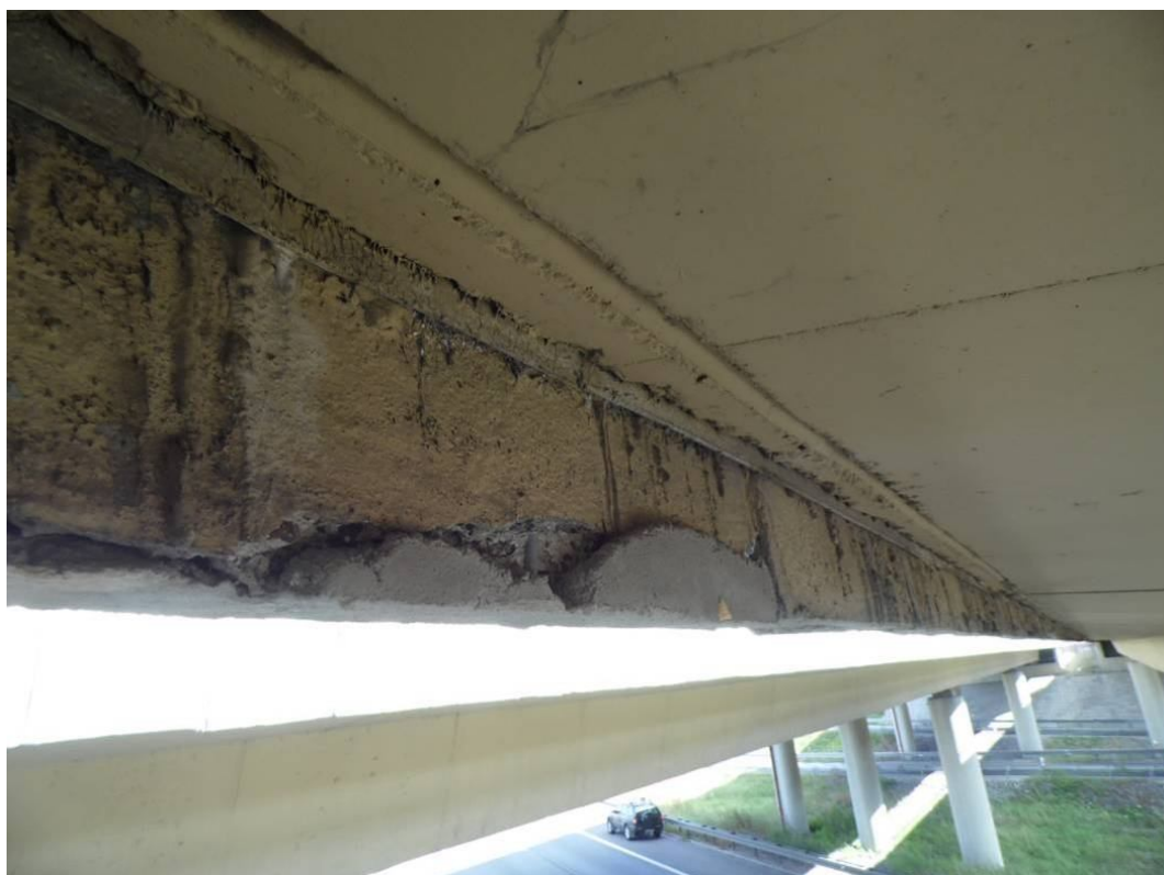
Fot. 17. Widok na gzyms od strony Katowic przy podporze nr 4 – widoczne nieprawidłowo wykonane uzupełnienia ubytków gzymsu.
