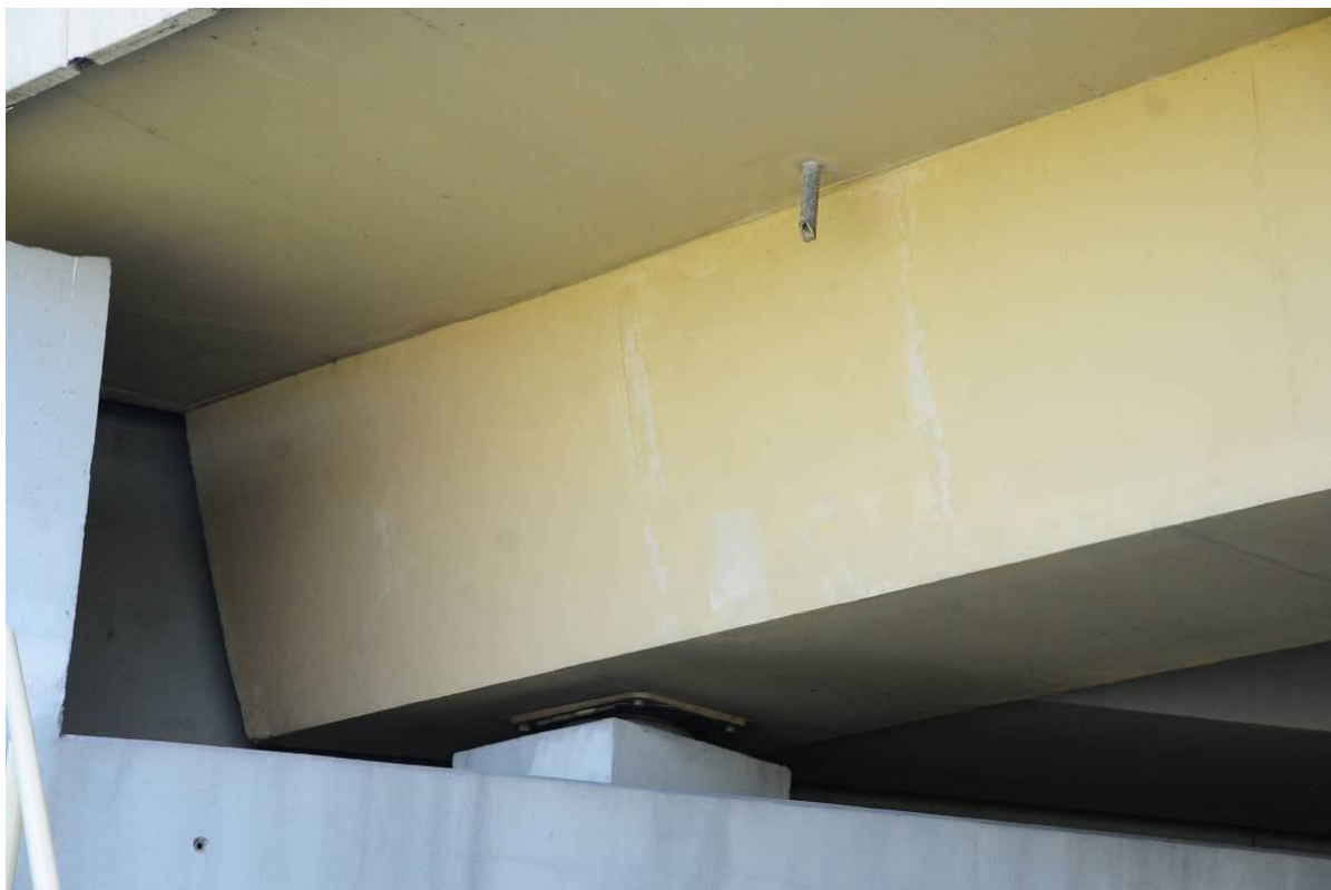
Fot. 51. Widok od strony Tarnowa na dźwigar nr 3 przy przyczółku od strony Wieliczki – wapienne zacieki na powierzchni dźwigara powstałe w wyniku przecieków na styku gzymsu i kapy chodnikowej.
