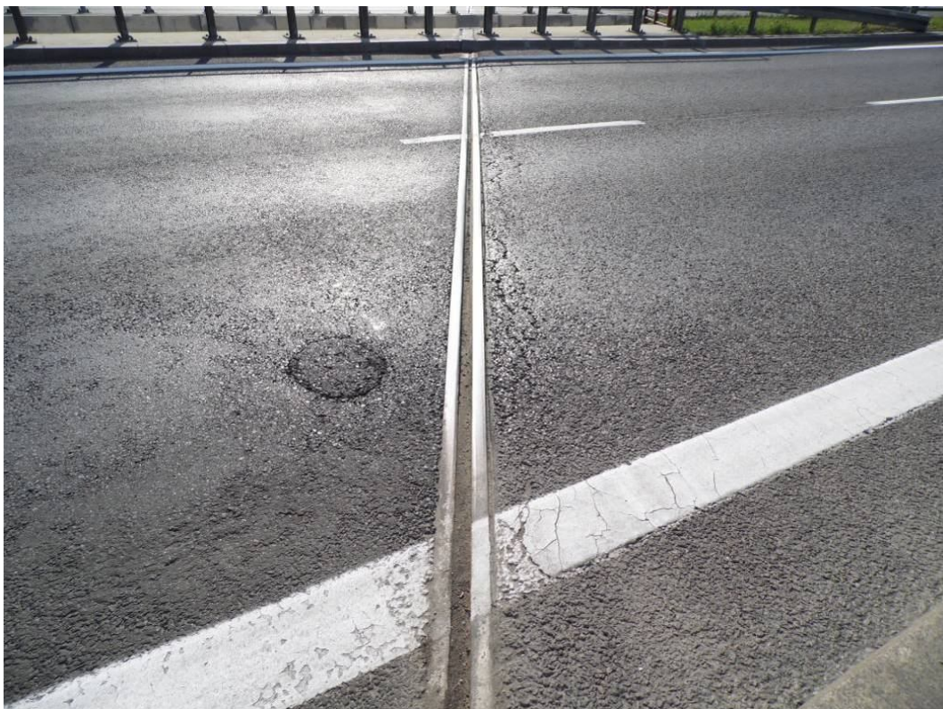
Fot. 39. Widok na urządzenie dylatacyjne na jezdni od strony Krakowa – zanieczyszczenie wkładki urządzenia dylatacyjnego, spękania nawierzchni jezdni od strony dojazdu.
