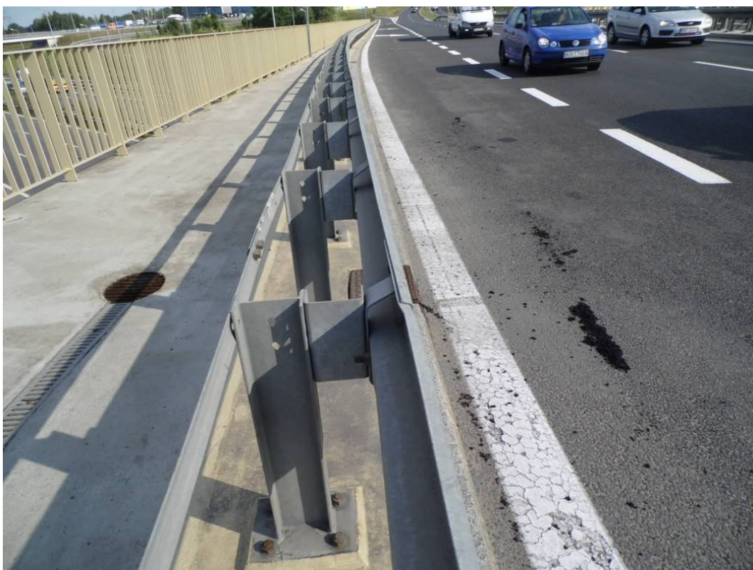
Fot. 6. Widok od strony Krakowa na jezdnię w przęśle nr 2 – spękania powłoki malarskiej oznakowania poziomego, zanieczyszczenia nawierzchni olejem powstałe prawdopodobnie podczas postoju pojazdu na pasie włączenia.
