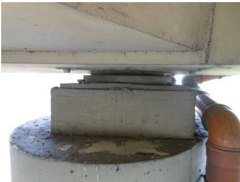
Fot. 69. Widok na cios i łożysko od strony Tarnowa na podporze nr 3 – mimośrodowo osadzony cios i łożysko na słupie, ubytki zabezpieczenia antykorozyjnego słupa.
