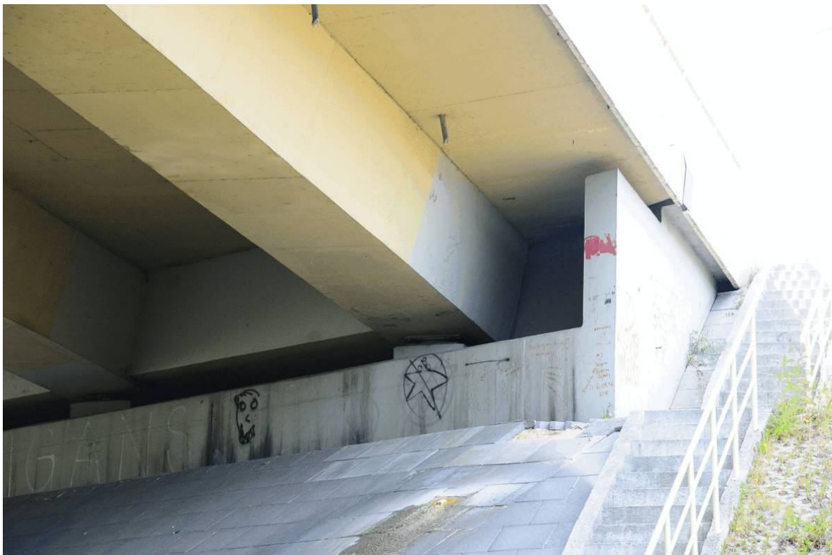
Fot. 50. Widok od strony Tarnowa na oparcie dźwigarów na przyczółku od strony Krakowa – widoczne ślady napraw powierzchniowych betonu przykryte źle dobraną kolorystycznie powłoką malarską.
