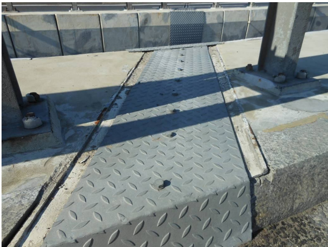
Fot. 43. Widok na urządzenie dylatacyjne kapy chodnikowej od strony Tarnowa nad przyczółkiem od strony Wieliczki – rdzawe plamy powstałe w wyniku korozji profilu stalowego urządzenia na chodniku, zanieczyszczenia urządzenia dylatacyjnego.
