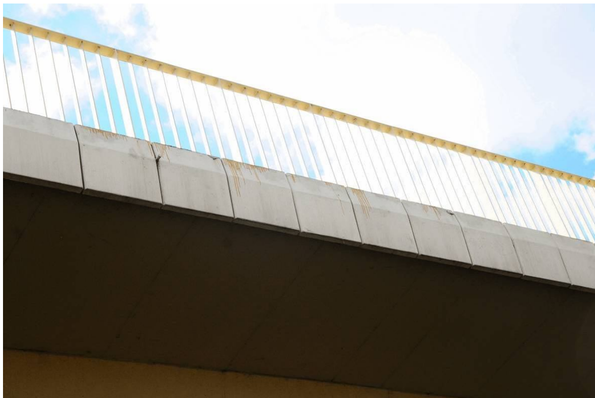
Fot. 19. Widok na gzyms od strony Tarnowa w przęśle nr 5 – zacieki na powierzchni desek gzymsowych powstałe po remoncie kap chodnikowych.
