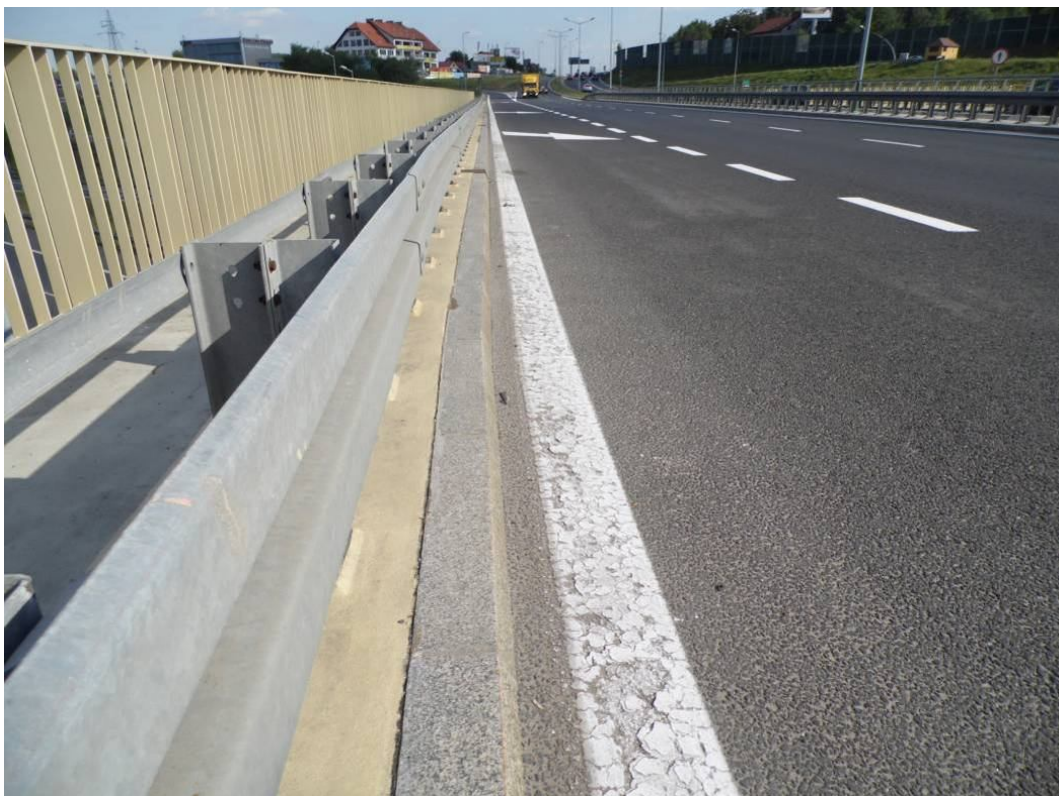
Fot. 11. Widok na krawężnik od strony Tarnowa w prześle nr 3 – ubytki wypełnienia szczeliny po nacięciu w betonie na styku krawężnika i kapy chodnikowej powstałe w wyniku wadliwego wykonania.
