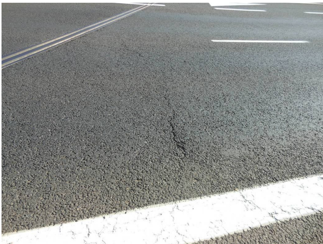
Fot. 75. Widok na nawierzchnię jezdni dojazdu od strony Wieliczki – pęknięcie nawierzchni jezdni.
