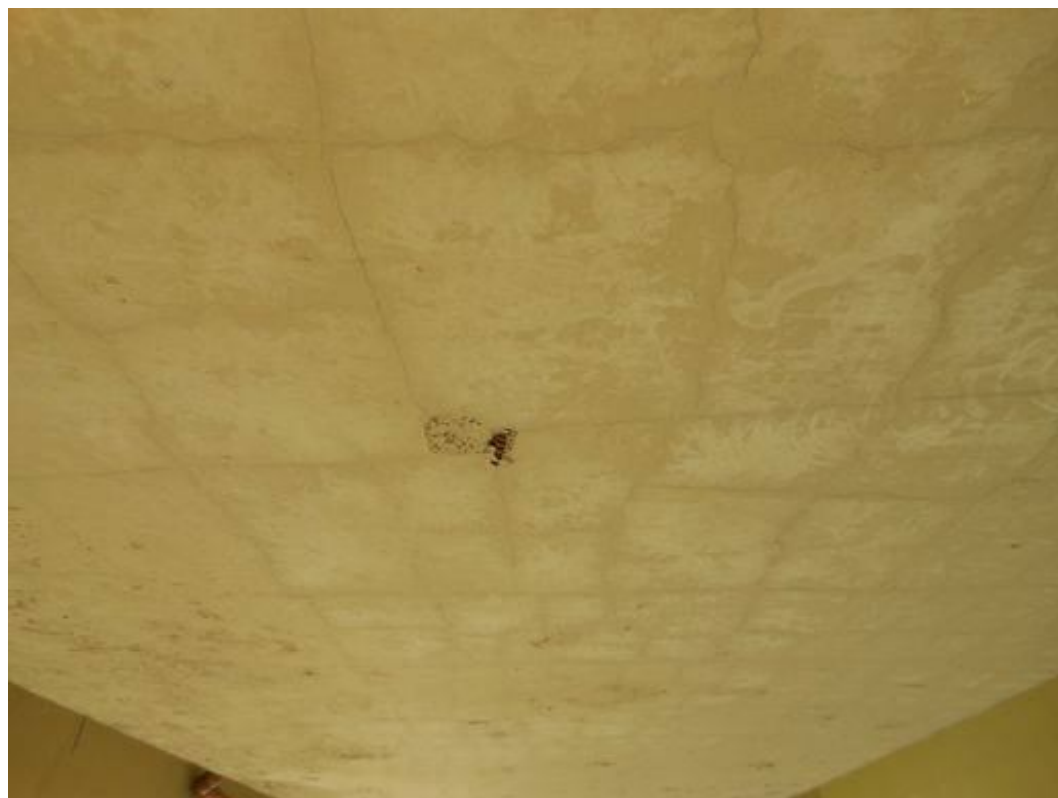
Fot. 46. Widok od spodu na dźwigar nr 2 w prześle nr 5 – siatka zarysowań skurczowych, ubytek betonu odsłaniający korodujące zbrojenie o zbyt małej otulinie.
