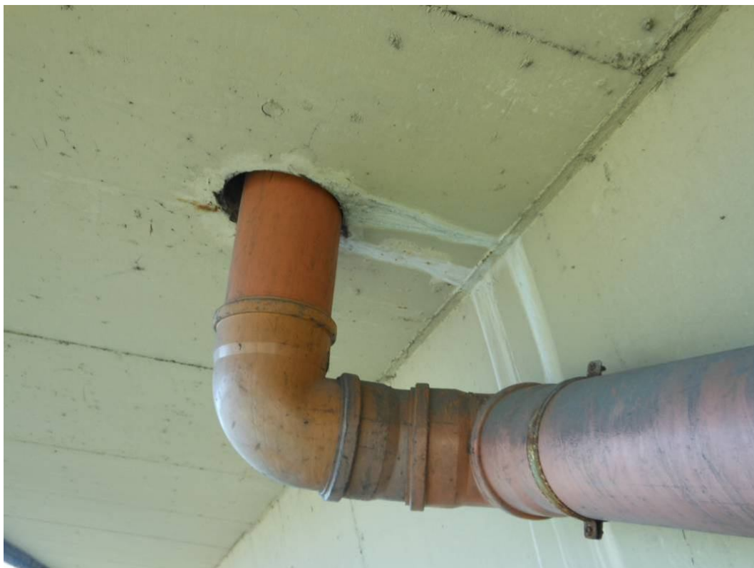
Fot. 29. Widok na rurę spustową i kolektor przy podporze nr 2 od strony Tarnowa – zanieczyszczenia kolektora oraz wapienne zacieki na powierzchni wspornika i dźwigara powstałe wskutek nieszczelności izolacji pomostu.
