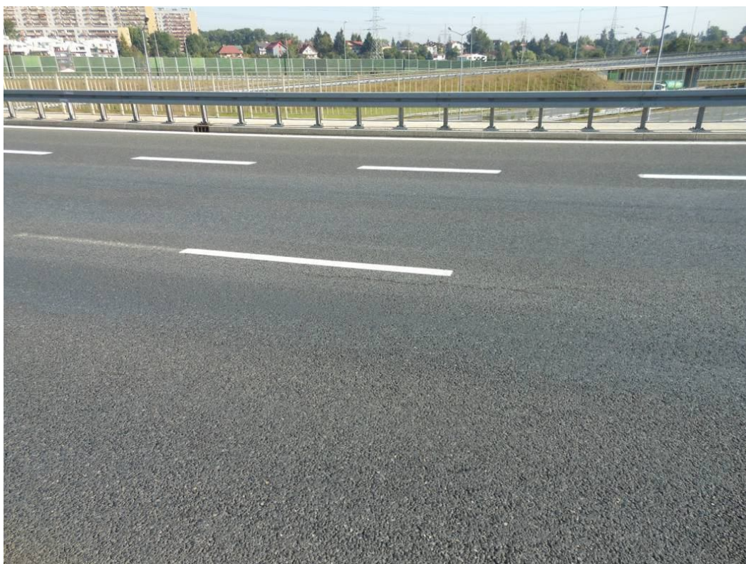
Fot. 8. Widok od strony Tarnowa na nawierzchnię jezdni w prześle nr 5 – widoczne zarysowanie w szwie.
