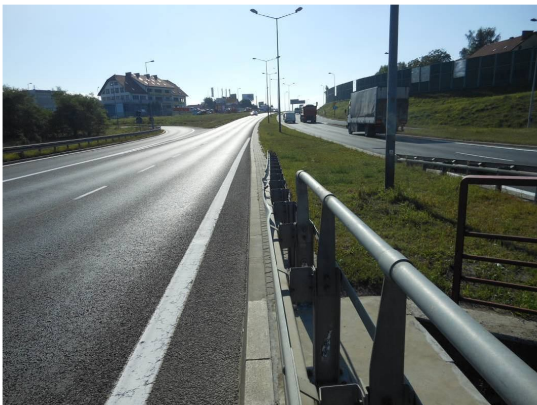
Fot. 25. Widok na barierę na dojeździe od strony Wieliczki – deformacja prowadnicy bariery powstała w wyniku uderzenia pojazdu.
