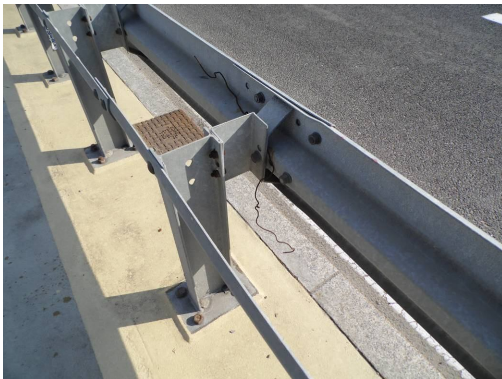
Fot. 24. Widok na barierę od strony Tarnowa w prześle nr 3 – pozostawiony drut pomiędzy prowadnicą, a przekładką bariery. Brak kapturków ochronnych oraz korozja nakrętek i kotew słupków.
