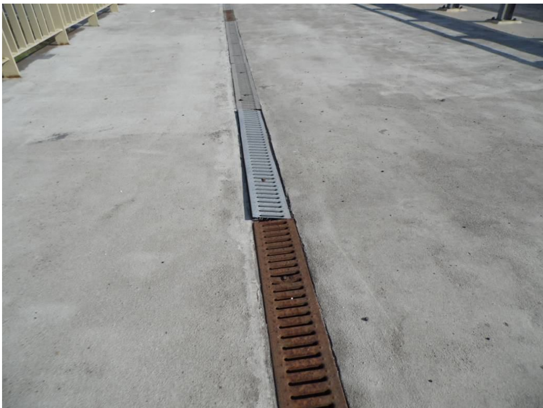
Fot. 33. Widok na odwodnienie liniowe kapy chodnikowej od strony Tarnowa w przejściu nr 1 – korozja kratki odwodnienia oraz wadliwie osadzona kratka.
