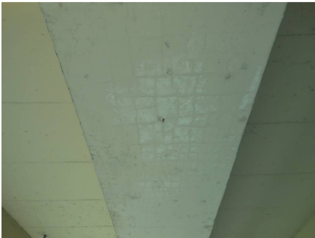
Fot. 45. Widok od spodu na dźwigar nr 2 w prześle nr 5 – siatka zarysowań skurczowych, ubytek betonu odsłaniający korodujące zbrojenie o zbyt małej otulinie.
