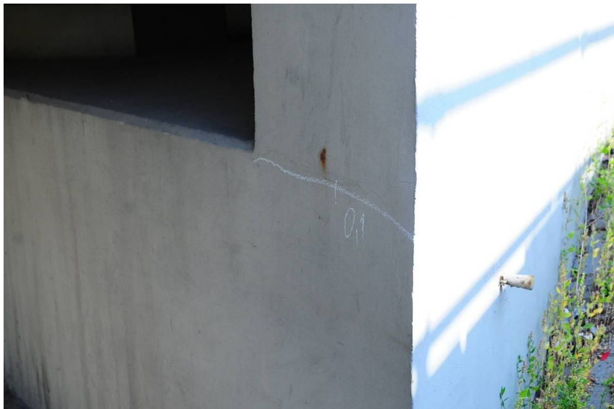
Fot. 64. Widok od strony Katowic na przyczółek od strony Wieliczki – brudne zacieki, zarysowanie skurczowe o rozwarości 0,1 mm, rdzawa plama powstała w wyniku korozji stalowych zanieczyszczeń betonu.
