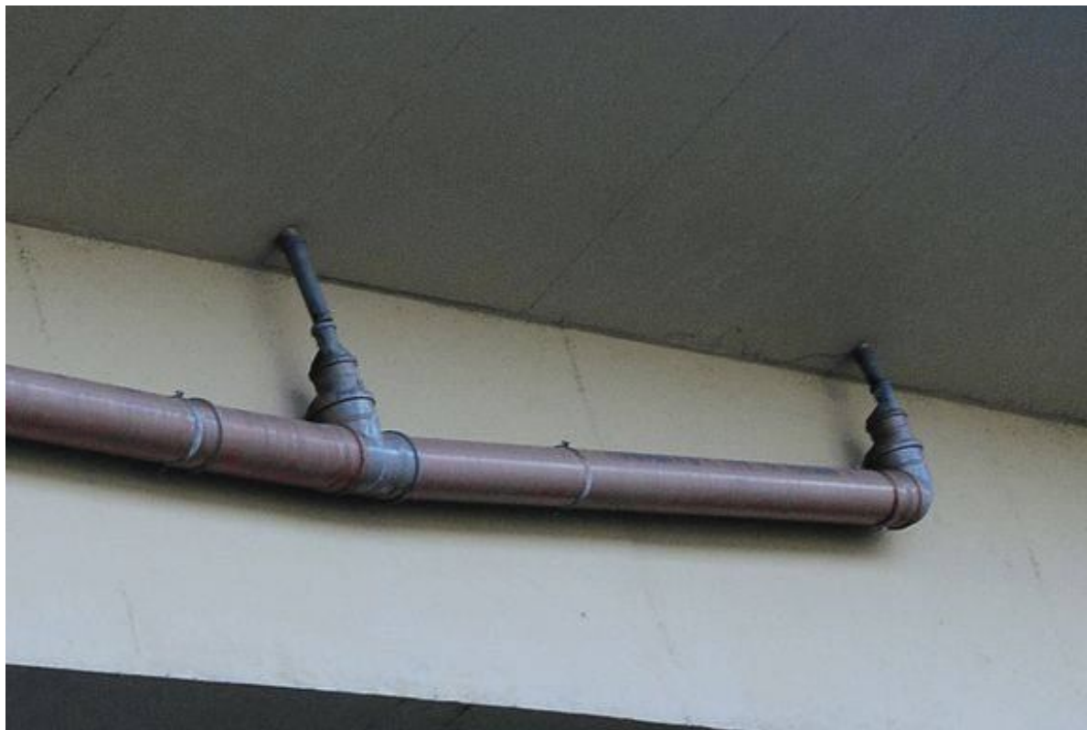
Fot. 38. Widok od strony Tarnowa na włączenie rurek wypływowych do kolektora w przęśle nr 5 – wysunięcie rurki wypływowej z kolektora wskutek wadliwego mocowania (załamanie kolektora).
