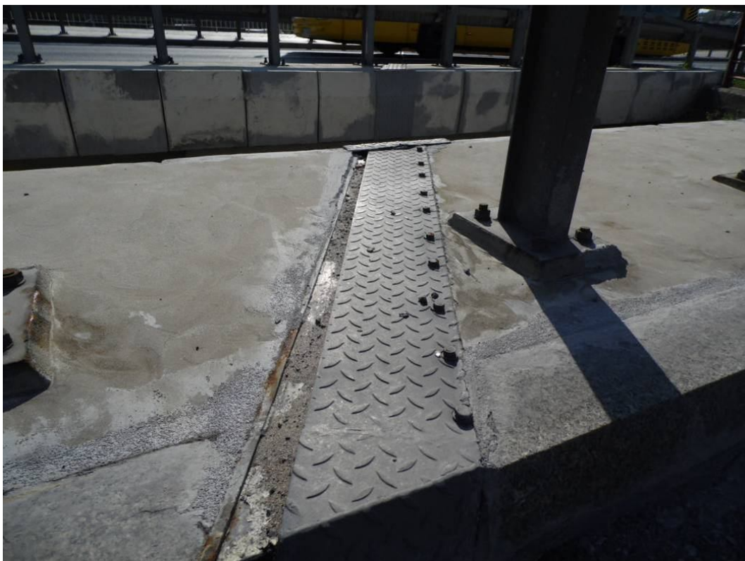
Fot. 41. Widok na urządzenie dylatacyjne na chodniku od strony Katowic nad przyczółkiem od strony Krakowa – rdzawe plamy powstałe w wyniku korozji profilu stalowego urządzenia.
