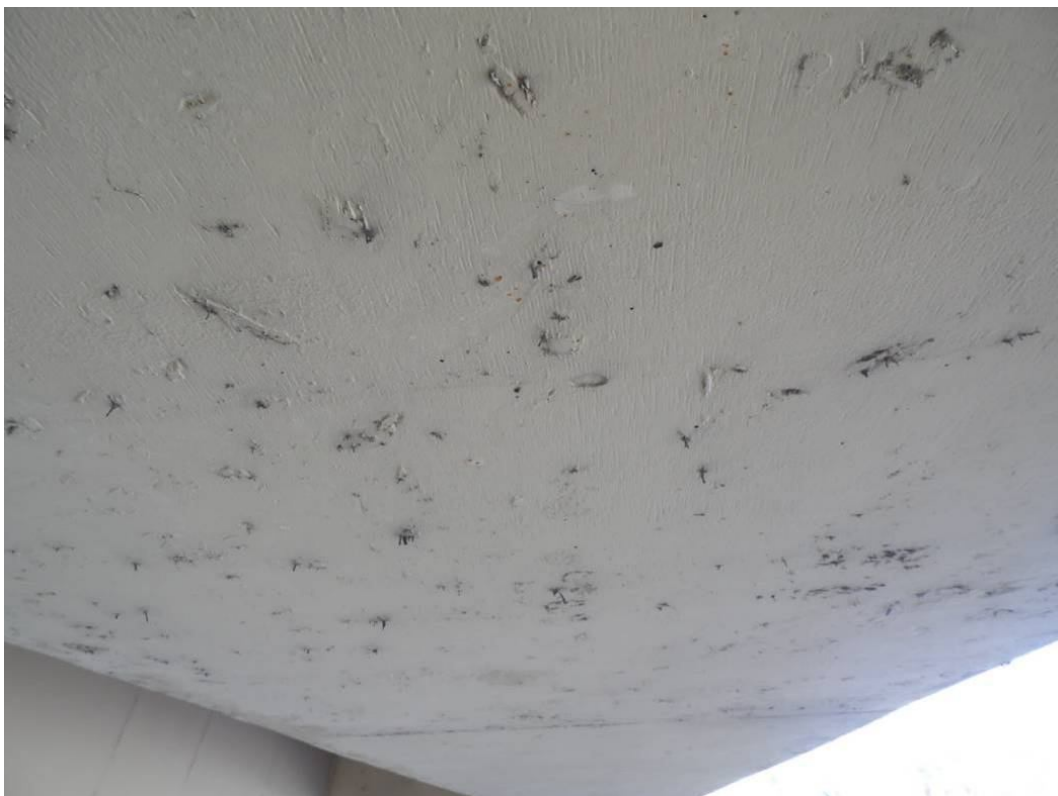
Fot. 47. Widok od spodu dźwigar nr 3 w przęśle nr 5 – liczne zanieczyszczenia w postaci resztki płyty szalunkowej na powierzchni betonu powstałe w wyniku nieoczystczenia szalunku przed betonowaniem.
