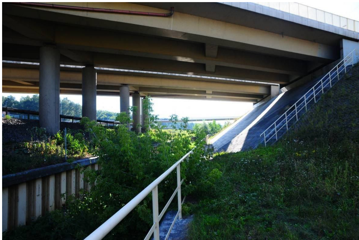
Fot. 83. Widok na przestrzeń podmostową pod przęsłem nr 1 – wegetacja roślinności w korycie potoku Malinówka.
