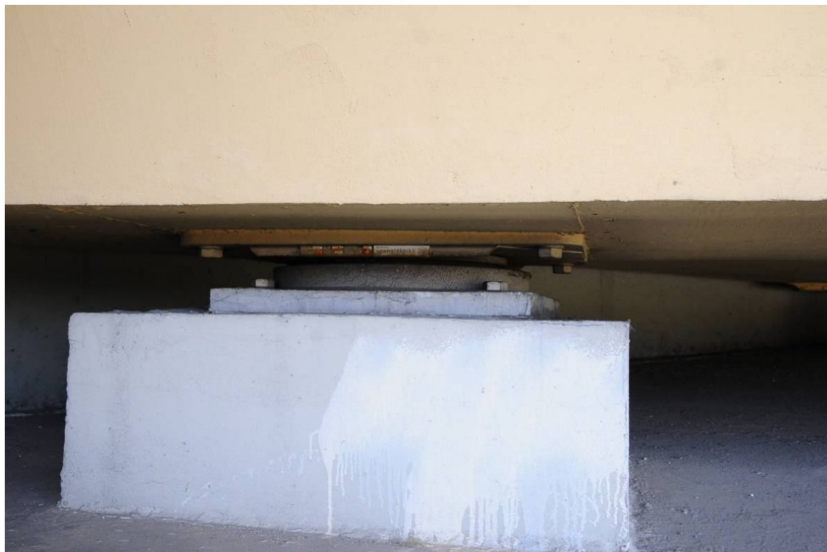
Fot. 71. Widok na łożysko dźwigara nr 1 na przyczółku od strony Wieliczki – niestarannie wykonane poprawki zabezpieczeń antykorozyjnych betonu.
