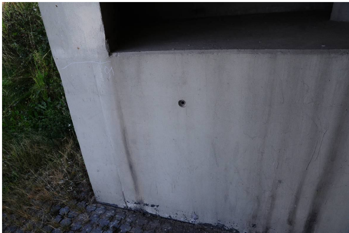
Fot. 63. Widok od strony Tarnowa na przyczółek od strony Wieliczki – brudne zacieki, złuszczenia oraz zacieki powłoki malarskiej powstałe w wyniku niechlujnego wykonania.
