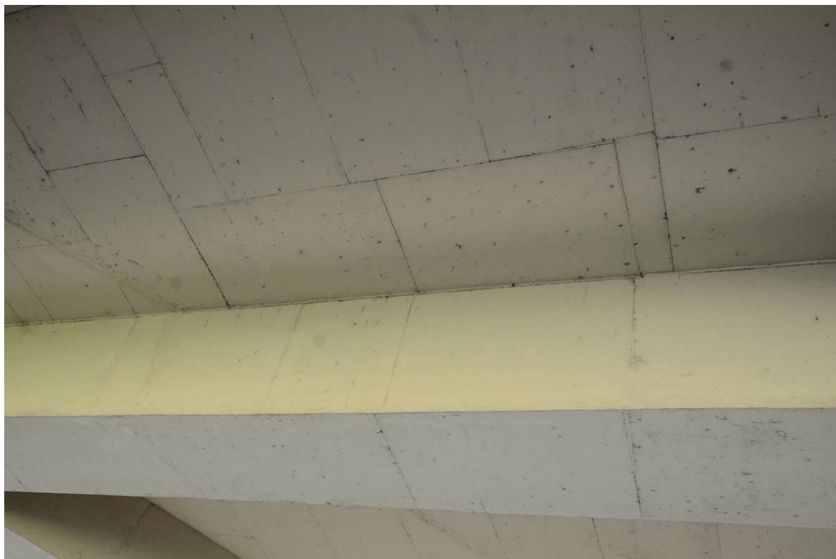
Fot. 55. Widok na płytę pomostu w przęśle nr 2 – liczne zanieczyszczenia wystającymi drutami wiązałkowym oraz brudem wzdłuż nierówności powstałych na krawędziach deskowań.
