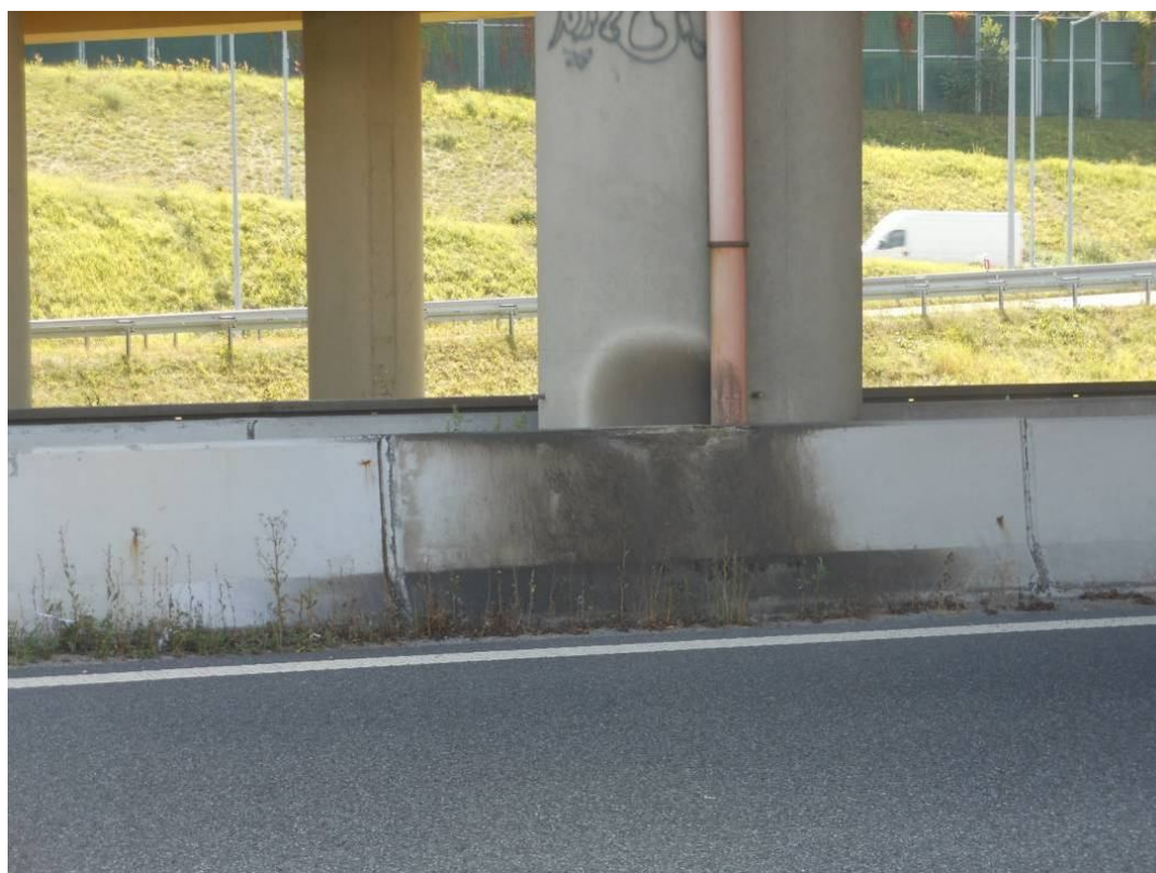
Fot. 84. Widok na barierę betonową przy podporze nr 4 – zanieczyszczenie filara oraz wapienne wykwyty na barierze betonowej autostrady powstałe wskutek ciekącej wody z sączka.
