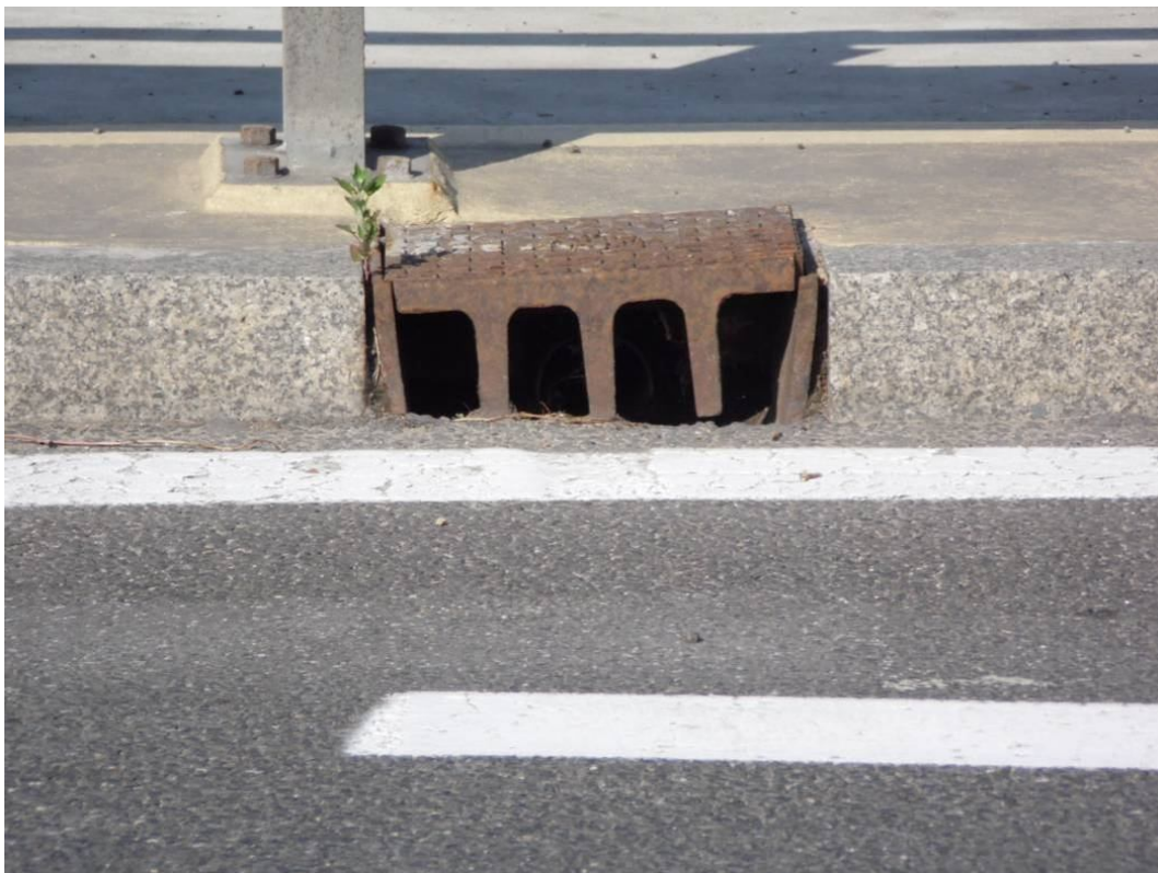
Fot. 36. Widok na wpust od strony Tarnowa w prześle nr 2 – nieprawidłowo osadzona korodująca pokrywa wpustu, porost roślinności pomiędzy wpustem, a krawężnikiem.
