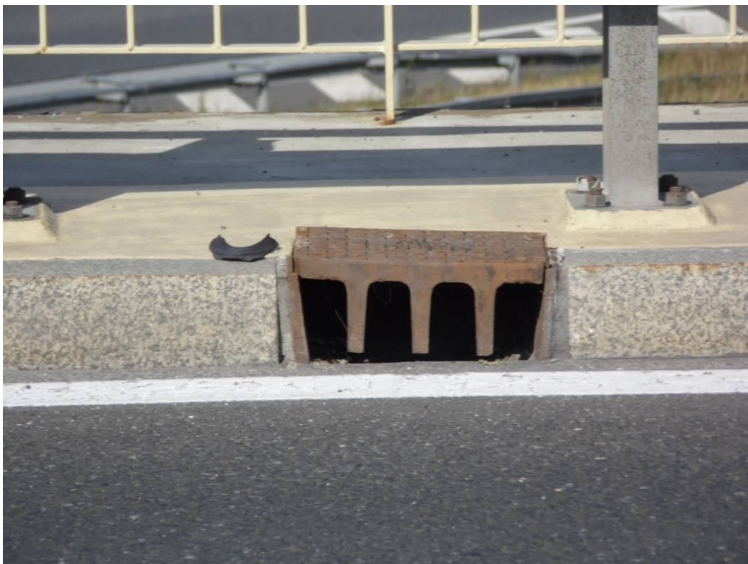
Fot. 35. Widok na wpust od strony Tarnowa w prześle nr 6 – nieprawidłowo osadzona korodująca pokrywa wpustu, zanieczyszczenia na kapie chodnikowej.
