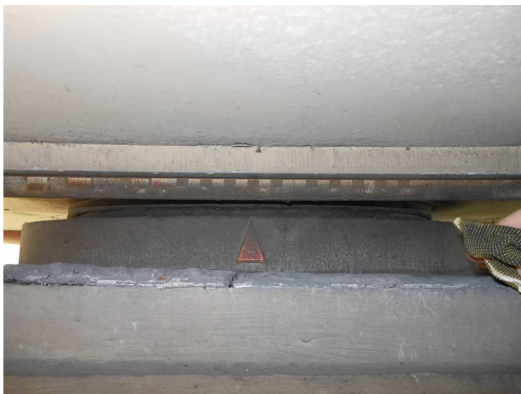
Fot. 72. Widok na łożysko dźwigara nr 1 na podporze nr 2 – zanieczyszczenie łożyska.
