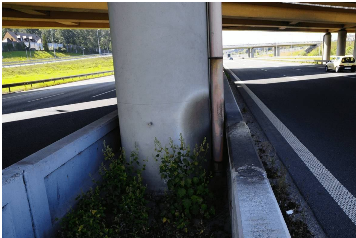
Fot. 37. Widok od strony Tarnowa na rurę spustową kolektora odwodnienia przy podporze nr 4 – korozja obejmy mocującej rurę spustową, zanieczyszczenie filara oraz wapienne wykwity na barierze betonowej autostrady powstałe wskutek ciekącej wody z sączka.
