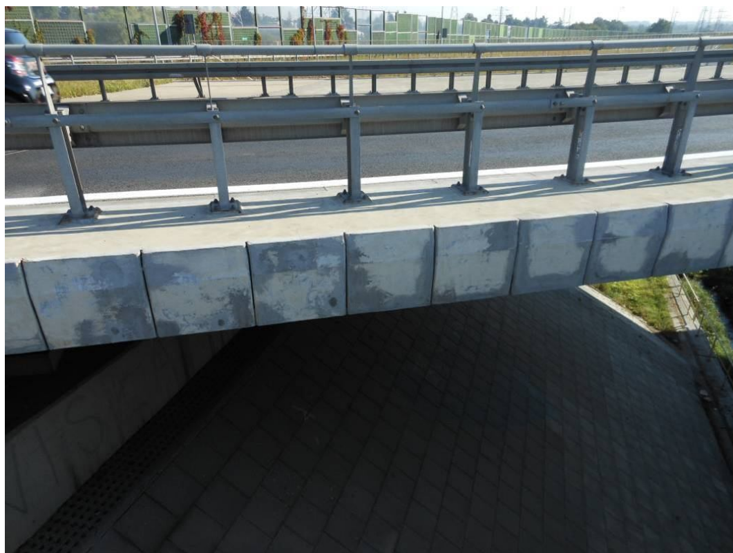
Fot. 18. Widok na gzyms od strony Katowic w przęśle nr 1 – wypięskowane deski gzymsowe, widoczne naprawy powierzchniowe betonu desek.
