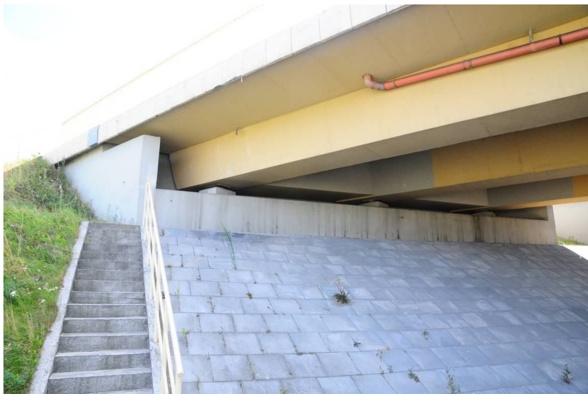
Fot. 60. Widok od strony Tarnowa na przyczółek od strony Wieliczki – brudne zacieki spowodowane przypuszczalnie nieszczelnością dylatacji.
