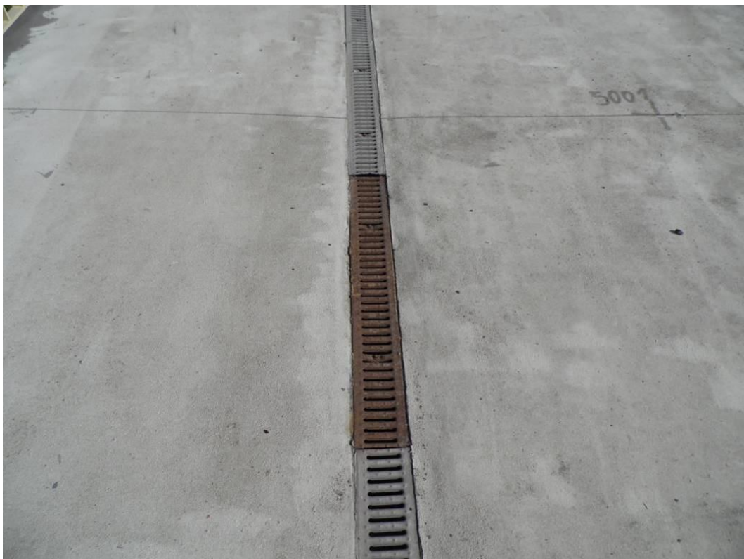
Fot. 31. Widok na odwodnienie liniowe kapy chodnikowej od strony Tarnowa w przęśle nr 1 – korozja kratki odwodnienia.
