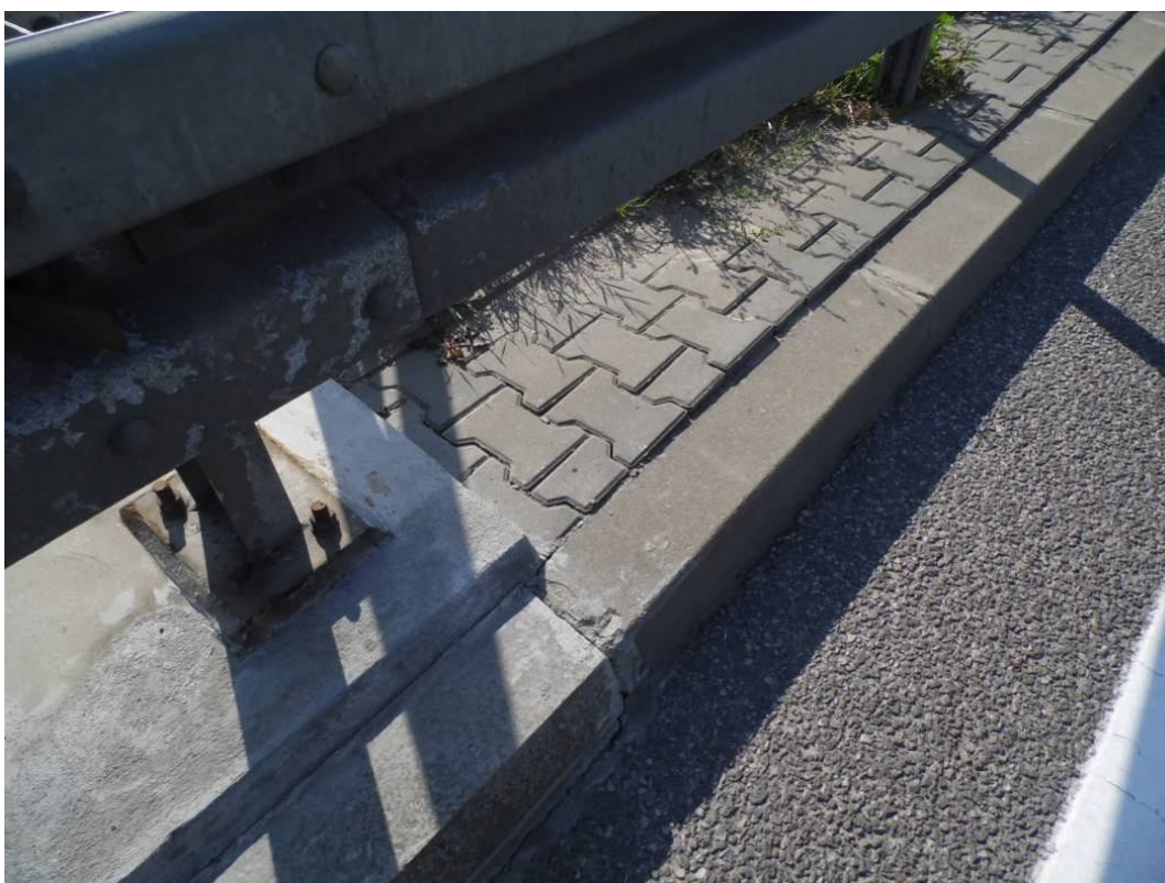
Fot. 76. Widok na chodnik od strony Katowic na dojeździe od strony Krakowa – ubytki betonu krawężniak betonowego, osiadanie krawężnika w wyniku osiadania nasypu.
