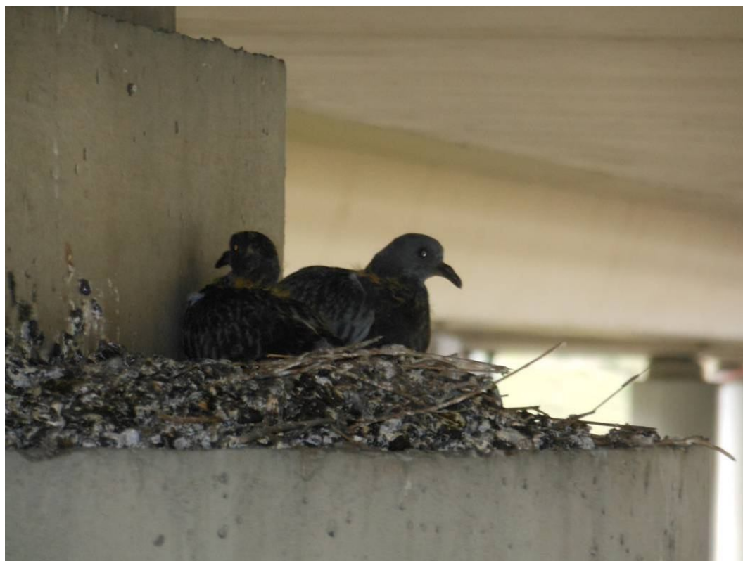
Fot. 70. Widok na słup środkowy podpory nr 6 – gromadzące się ptactwo, zanieczyszczenia w postaci gniazda oraz ptasich odchodów.
