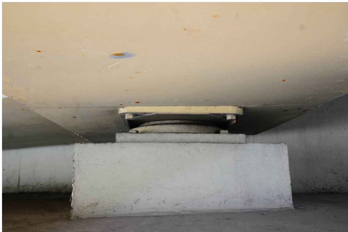
Fot. 53. Widok na dźwigar nr 3 przy przyczółku od strony Wieliczki – rdzawe plamy powstałe w wyniku korozji stalowych zanieczyszczeń w betonie.
