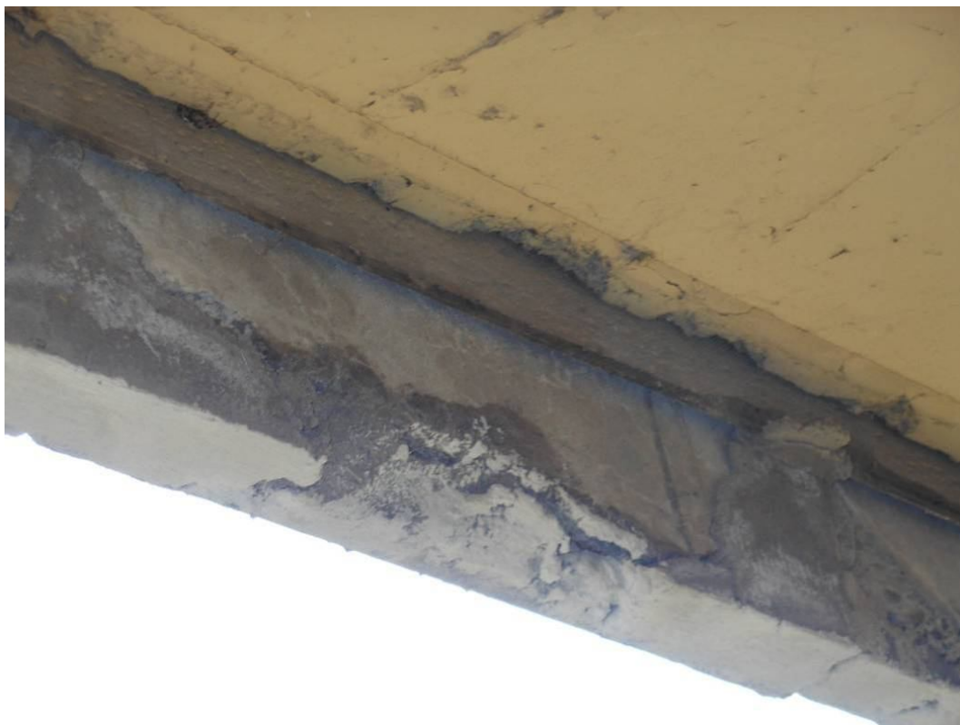
Fot. 15. Widok na gzyms od strony Katowic przy podporze nr 2 – widoczne nieprawidłowo wykonane uzupełnienia ubytków gzymsu.
