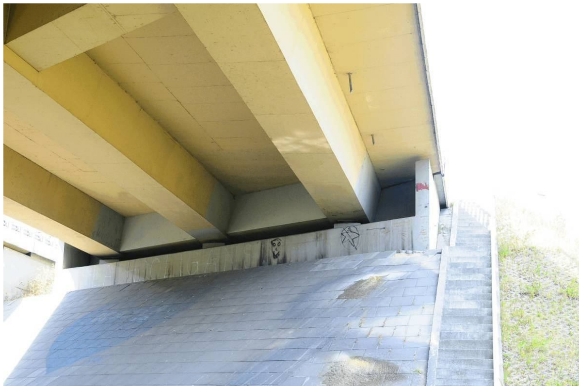
Fot. 59. Widok od strony Tarnowa na przyczółek od strony Krakowa – zanieczyszczenia w postaci graffiti oraz brudnych zacieków powstałych przypuszczalnie wskutek nieszczelności dylatacji.
