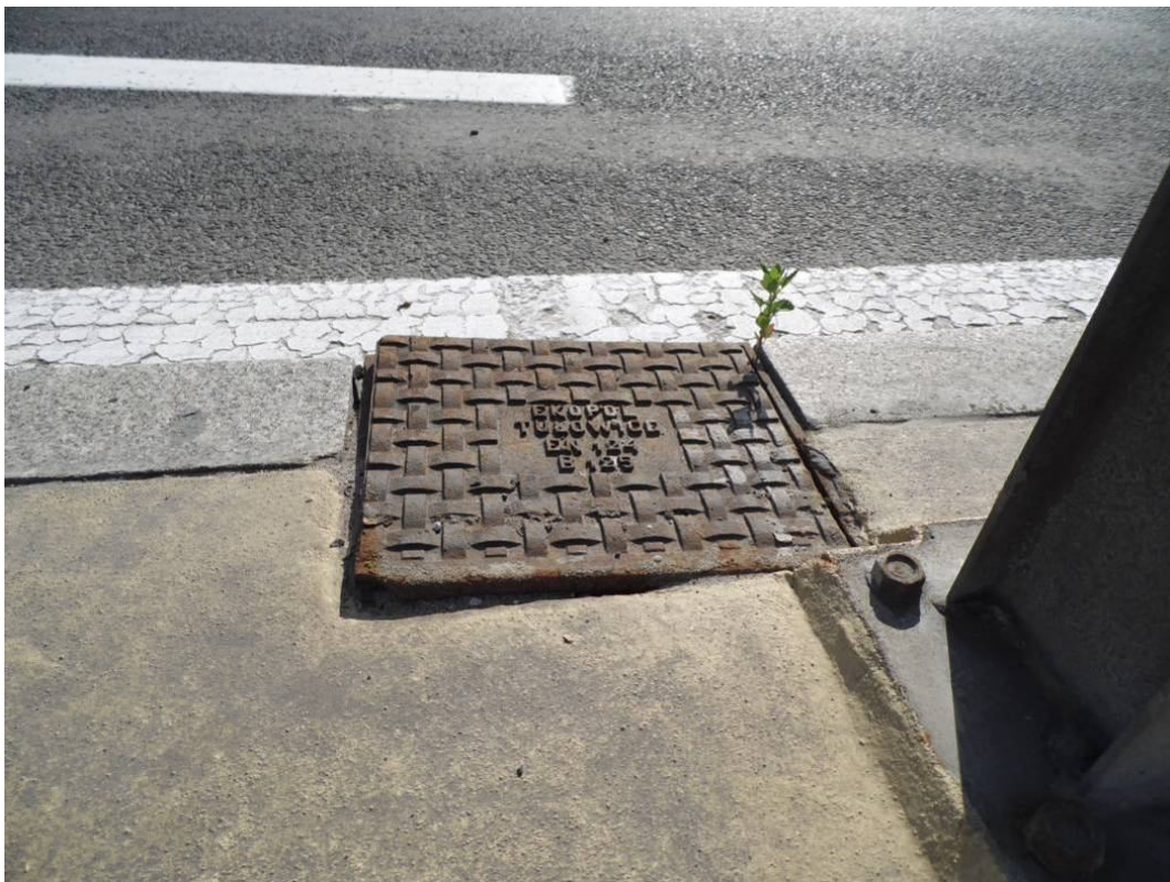
Fot. 34. Widok na wpust od strony Tarnowa w przejściu nr 2 – nieprawidłowo osadzona korodująca pokrywa wpustu, porost roślinności pomiędzy wpustem, a krawężnikiem.
