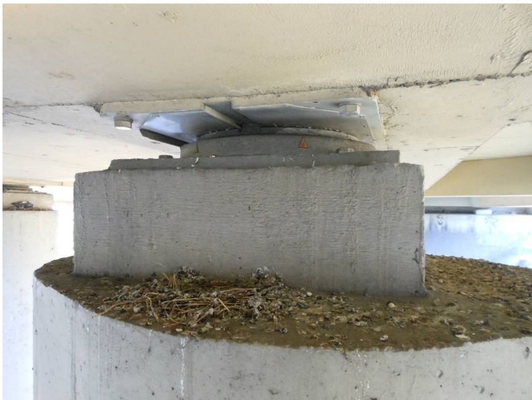
Fot. 67. Widok na cios i łożysko od strony Tarnowa na podporze nr 2 – mimośrodowo osadzony cios i łożysko na słupie, zanieczyszczenia w postaci gniazda i ptasich odchodów.
