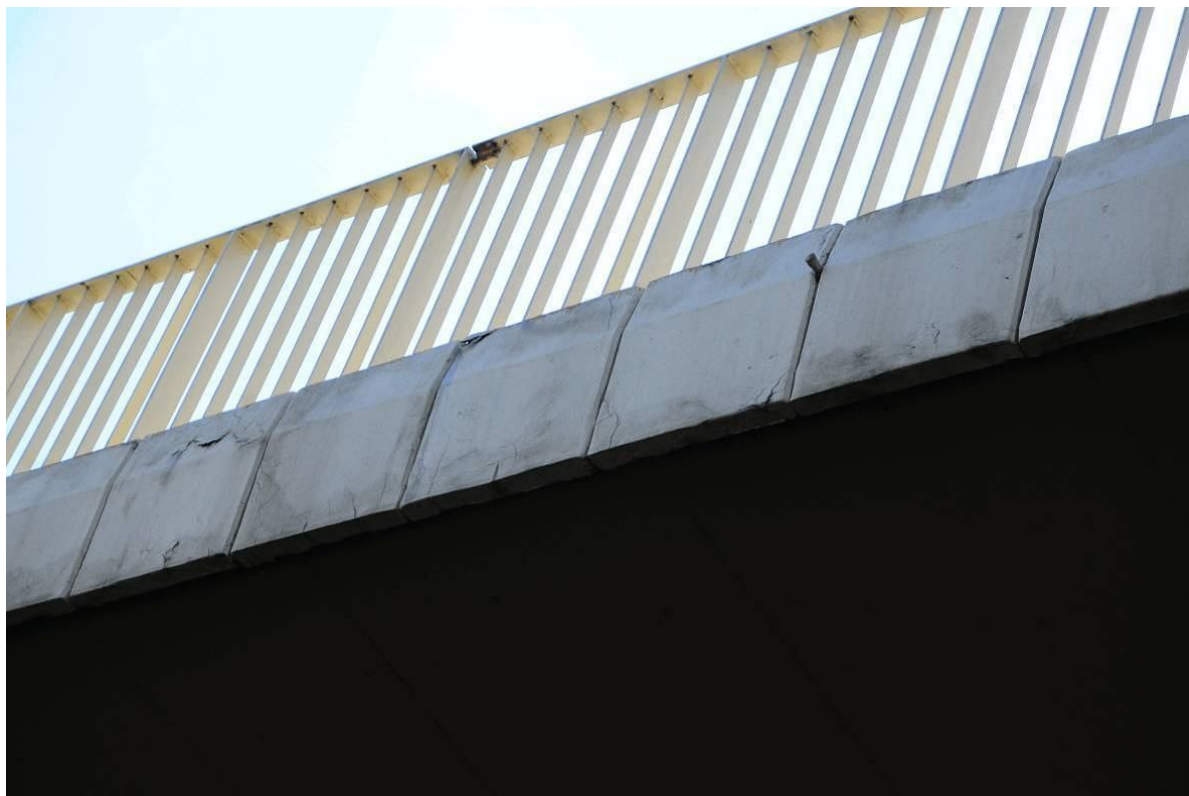
Fot. 21. Widok na gzyms od strony Tarnowa w przęśle nr 4 – spękania i ubytki betonu oraz wyprowadzeń cementowych desek powstałe w wyniku wadliwego wykonania.
