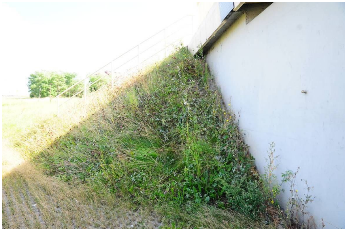
Fot. 79. Widok od strony Tarnowa na stożek przyczółka od strony Wieliczki – bujna wegetacja roślinności.
