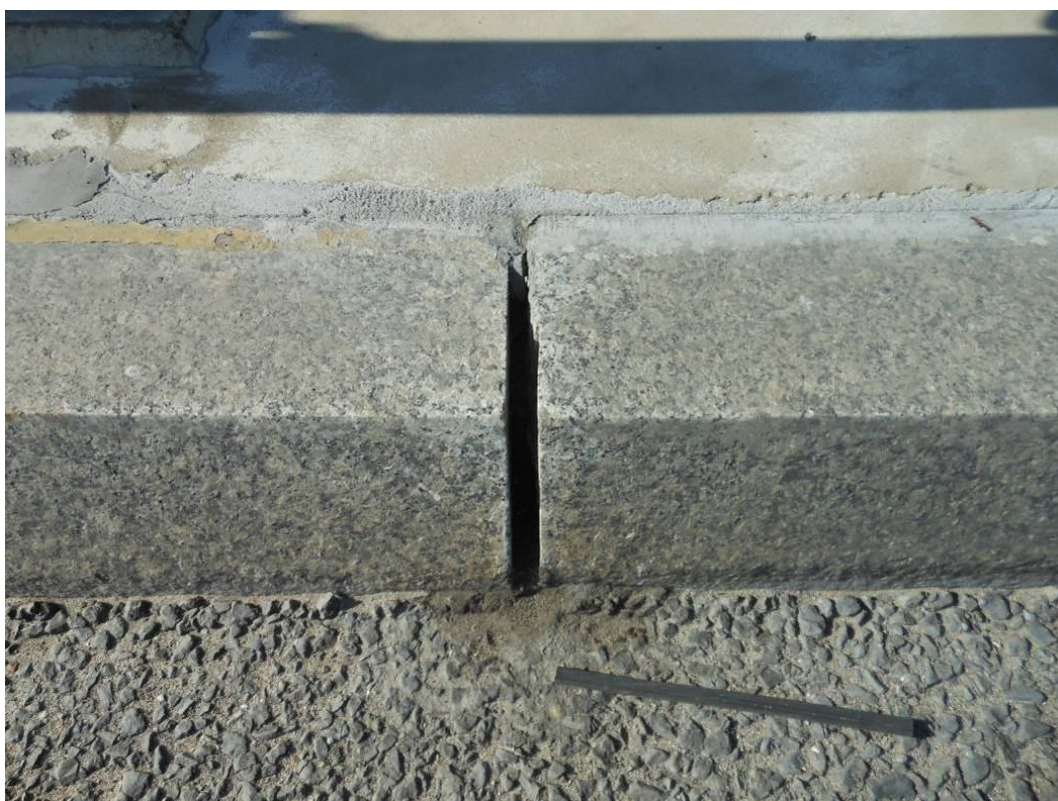
Fot. 14. Widok na pierwszy krawężnik od strony Katowic na przęśle nr 6 przy przyczółku od strony Wieliczki – brak wypełnienia szczeliny między krawężnikami, widoczne ślady napraw na styku kapy i krawężników.
