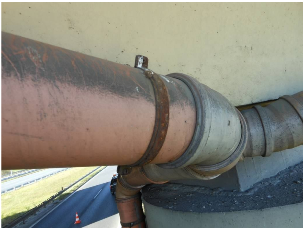
Fot. 27. Widok na kolektor odwodnienia przy podporze nr 2 – korozja obejmy powieszenia kolektora, zanieczyszczenia na powierzchni kolektora.
