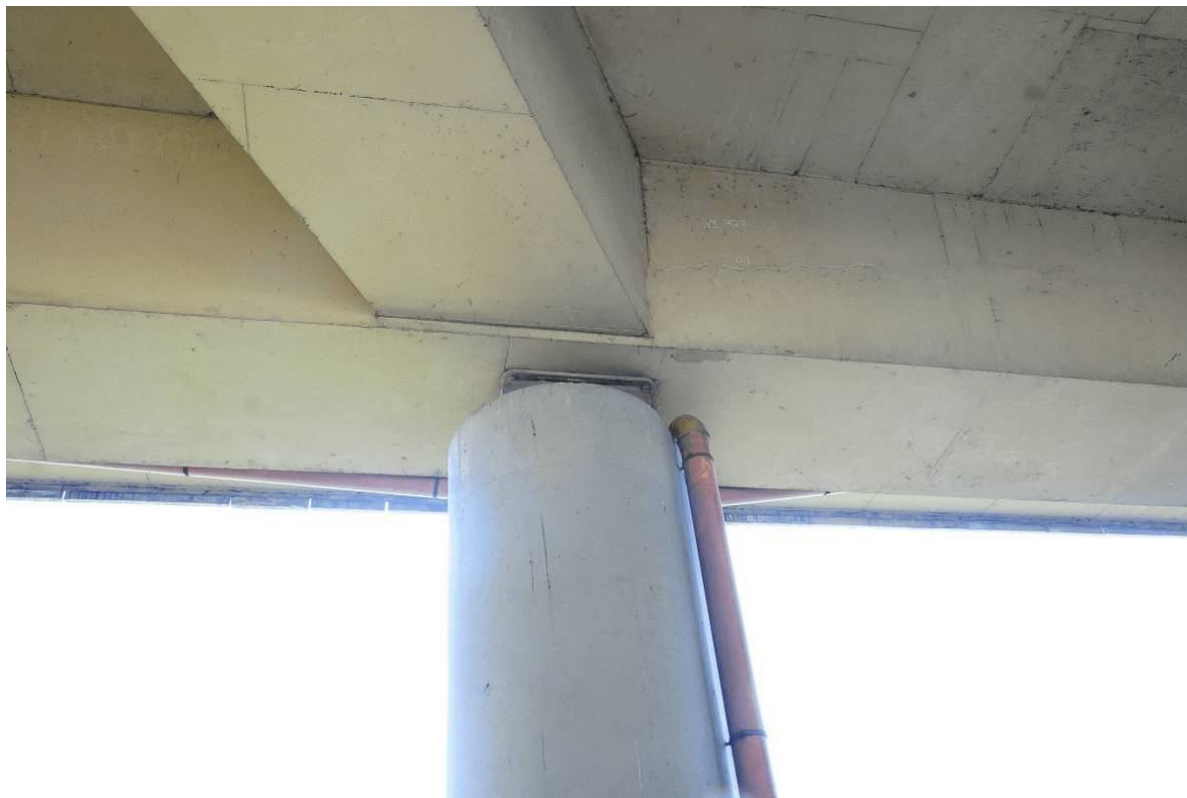
Fot. 48. Widok na dźwigar i poprzecznicę nad podporą nr 2 – zarysowanie poziome dźwigara o rozwarości 0,1 mm, zanieczyszczenia na powierzchni dźwigara.
