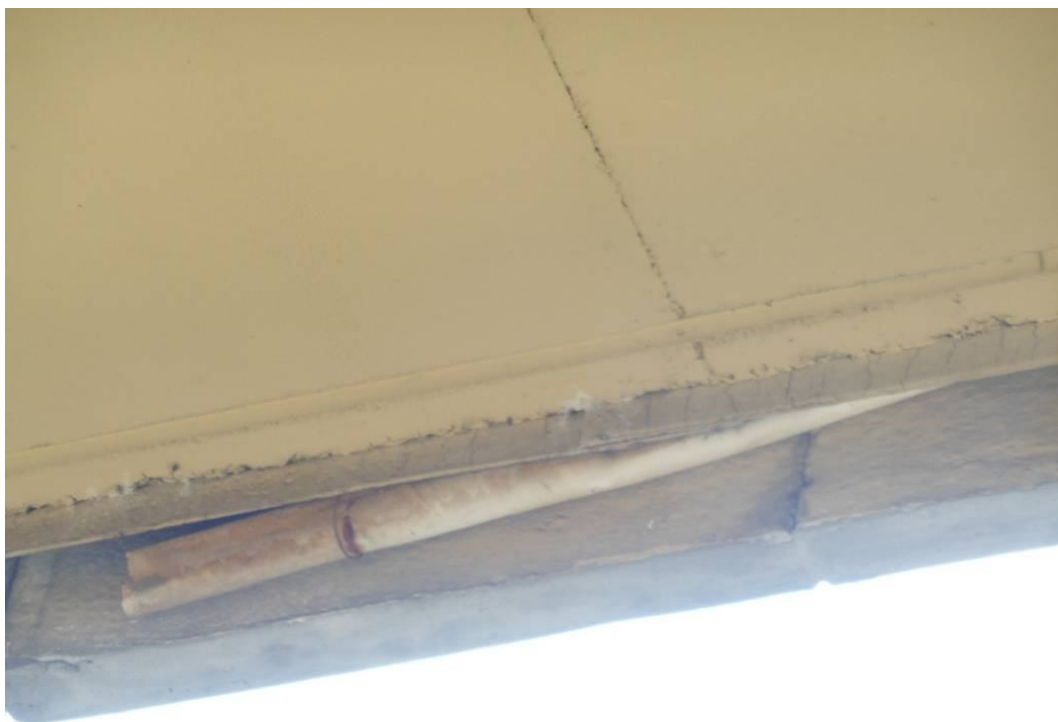
Fot. 15. Widok na gzyms od strony Katowic przy podporze nr 2 – widoczne nieprawidłowo wykonane uzupełnienia ubytków gzymsu.
