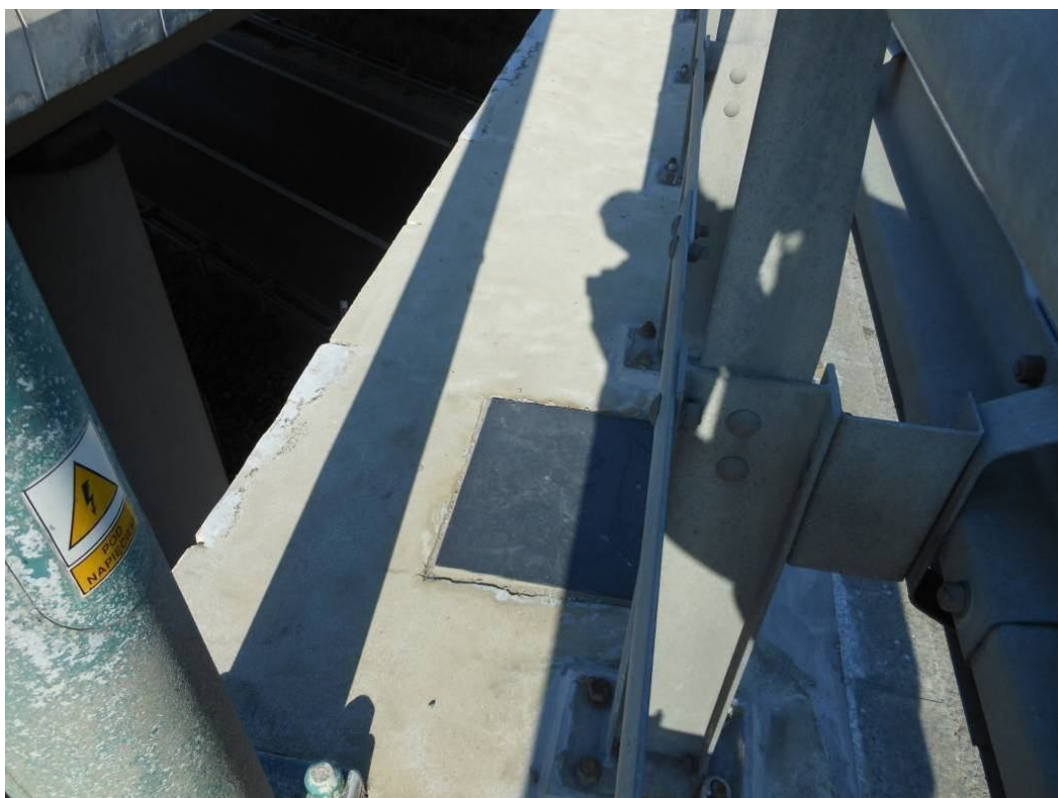
Fot. 13. Widok na kapę chodnikową od strony Katowic w przęśle nr 2 – wypiąskowana powierzchnia kapy chodnikowej przygotowana do ułożenia nowej nawierzchni. Zakryty sklejką właz do studzienki rewizyjnej.
