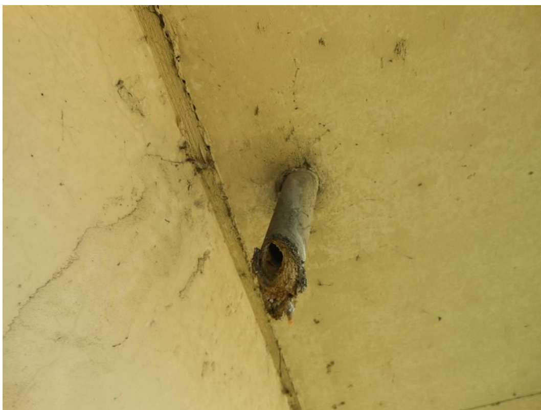
Fot. 28. Widok na rurkę wypływową sączka przy podporze nr 2 od strony Tarnowa – osady na rurce wypływowej sączka zawężające światło rurki.
