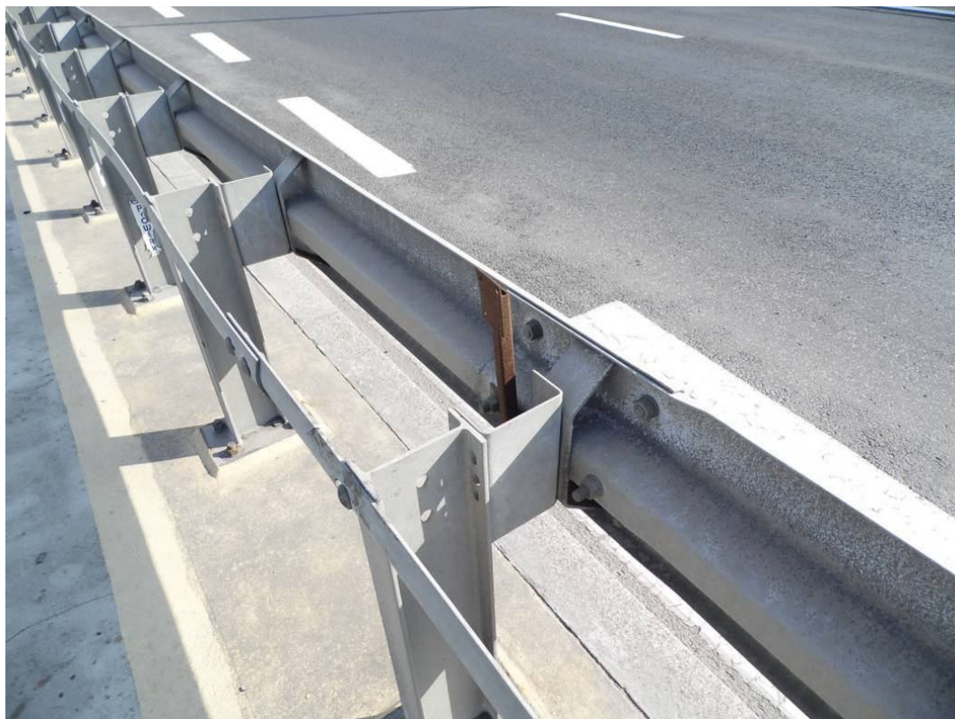
Fot. 23. Widok na barierę od strony Tarnowa w prześle nr 2 – brak górnej części i korozja dolnej części słupka hektometrowego, nalepki producenta na słupku bariery, utlenianie powłoki antykorozyjnej na prowadnicy. Brak kapturków ochronnych oraz korozja nakrętek i kotew słupków.
