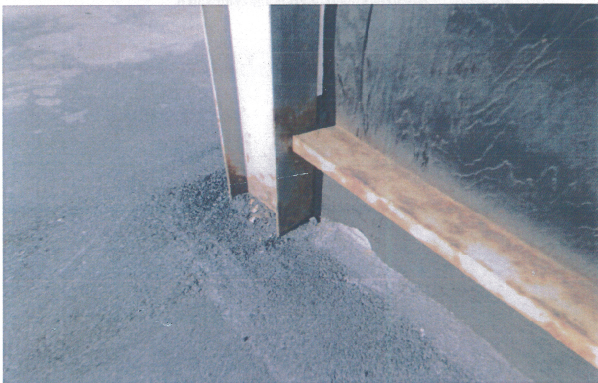
Korozja konstrukcji magazynu soli 9
