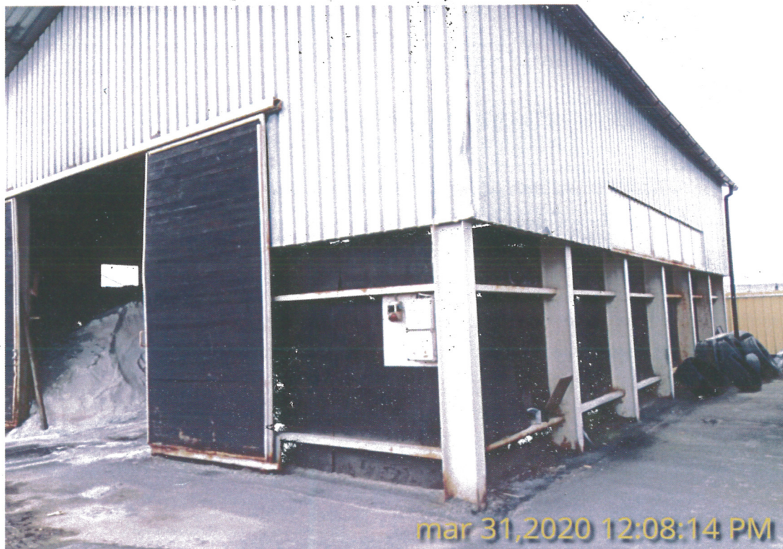
Korozja konstrukcji magazynu soli 6
