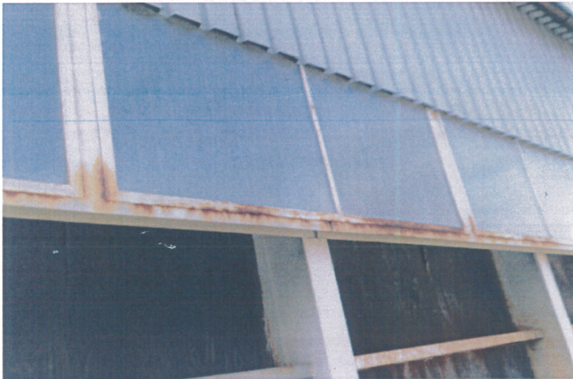
Korozja konstrukcji magazynu soli 8
