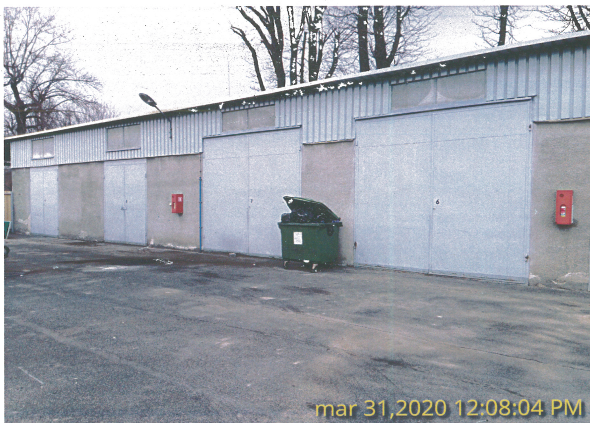
Ubytki tynku zewnętrznego 5
