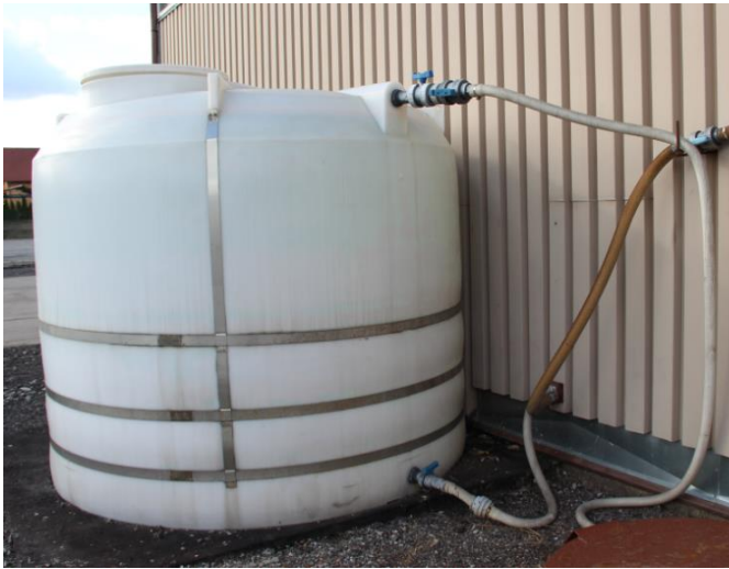
Fot. 1 i 2 Po lewej zbiornik do składowania roztworu chlorku sodu lub wapnia nazywanej powszechnie „solanką”, po prawej – magazyn materiałów do zapobiegania śliskości (chlerek wapnia składowany w workach typu „big bag” oraz dalej po prawej chlerek sodu składowany w stanie luźnym w przyzmach).
