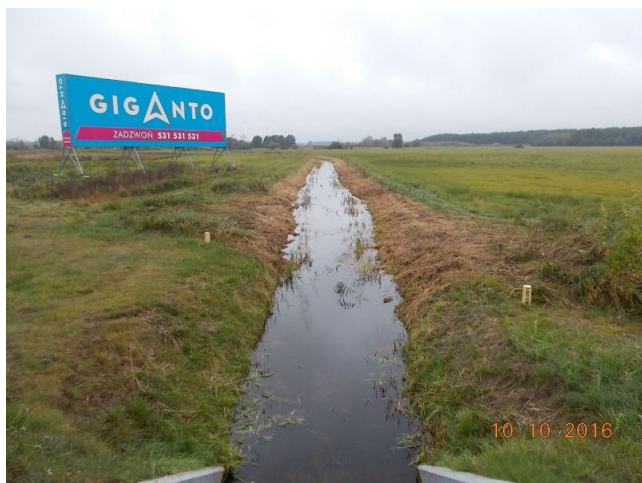
Stanowisko nr 49, ciek/rów w km 79+217 L
