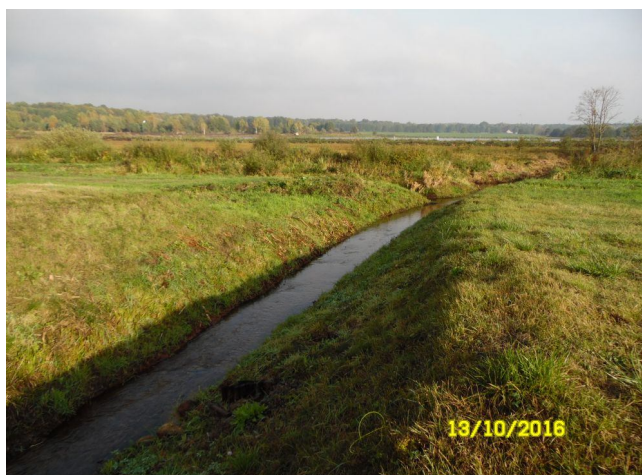
Stanowisko nr 39, system rowów i cieków w km 60+400 L
