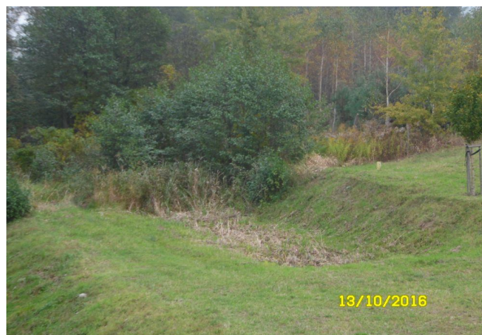
Stanowisko nr 46, rozlewisko w km 61+150 L, stanowisko wyschło
