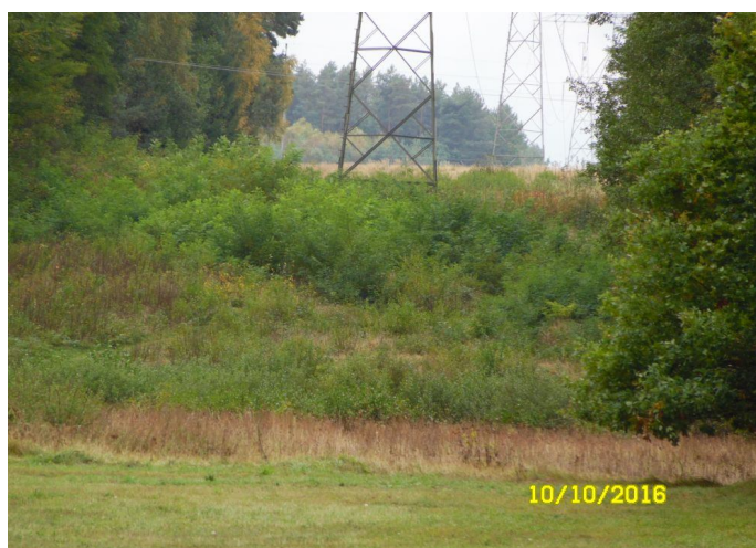
Stanowisko nr 36, bagno w km 56+150 P, znacznie obniżony poziom wody
