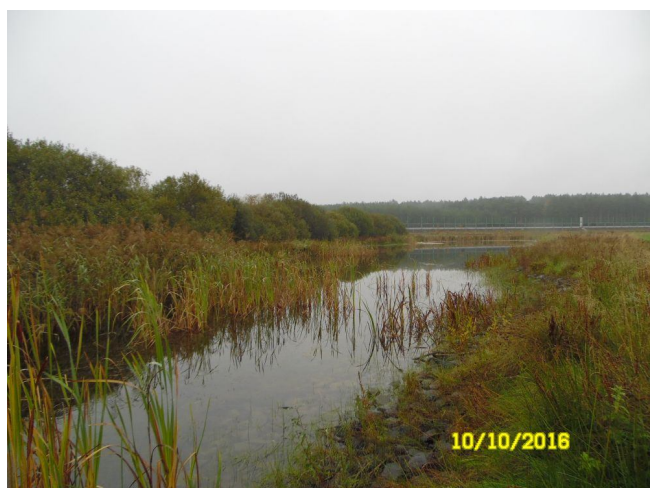
Zbiornik kompensacyjny w km 79+700 P
