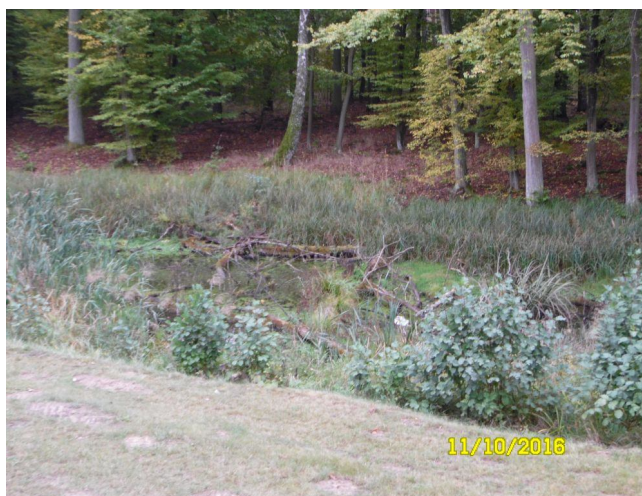
Stanowisko nr 59, staw w km 91+890 P, znacznie obniżony poziom wody
