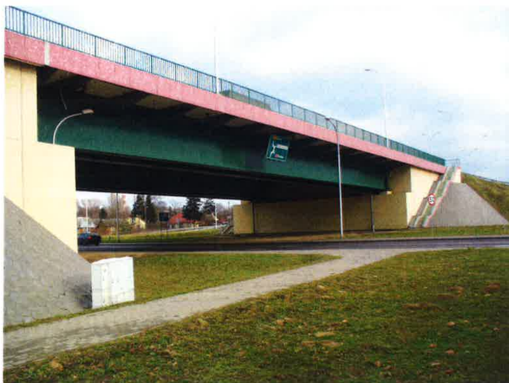
Obiekt nr 3 – wiadukt nad ulicą Dęblińską w km 9+944 drogi krajowej Nr 12s w m. Puławy
