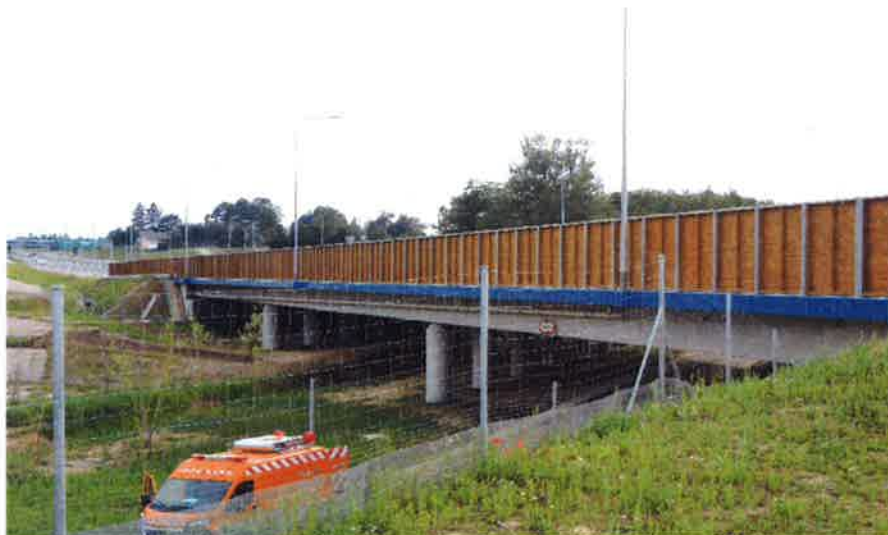
Obiekt nr 8 – most przez rzekę Łazęgę w km 2+257 drogi ekspresowej Nr S19d w m. Płuszwice Kolonia
