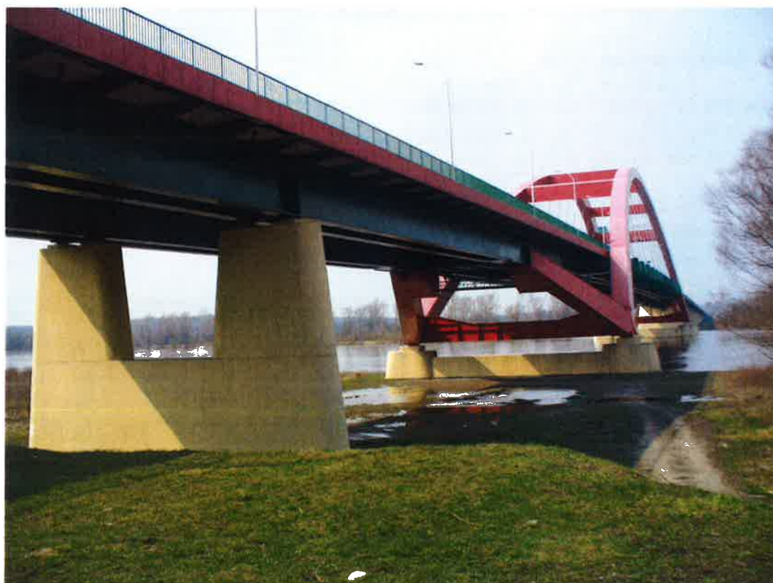
Obiekt nr 2 – most przez rzekę Wisłę w km 12+196 drogi ekspresowej Nr S12s w m. Puławy
