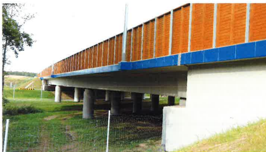
Obiekt nr 9 – most przez rzekę Łazęgę w km 2+257 drogi ekspresowej Nr S19d w m. Płuszwice Kolonia
