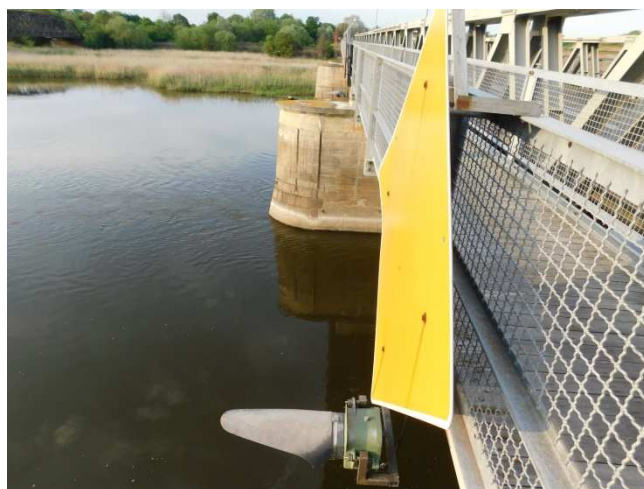
Fot. 2.26 Widok wodowskazu żeglugowego (przęsło 5)
