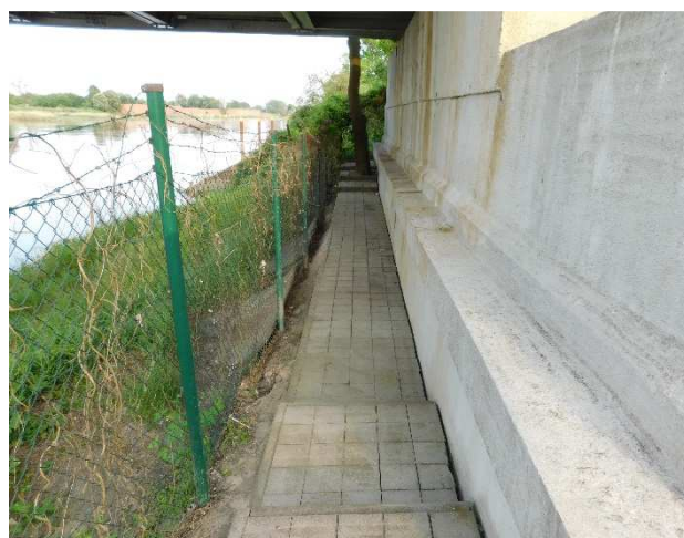
Fot 3.62 Widok na chodnik przed przyczółkiem. Stan chodnika jest dobry,
