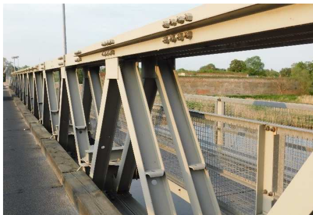
Fot 3.47 Widok ogólny na dźwigar kratowy od strony górnej wody.
