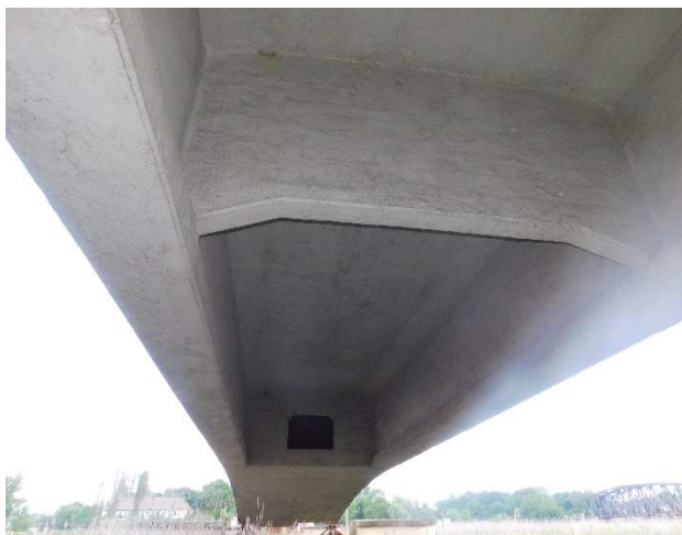
Fot 3.5 Prześle 1. Widok na poprzecznice i spód belek. Widoczny dobry stan konstrukcji.
