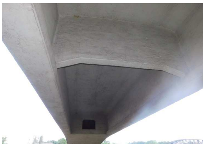
Fot. 2.5 Widok dwudźwigarowej części ustroju nośnego wraz z poprzecznica (przęsło 3)
