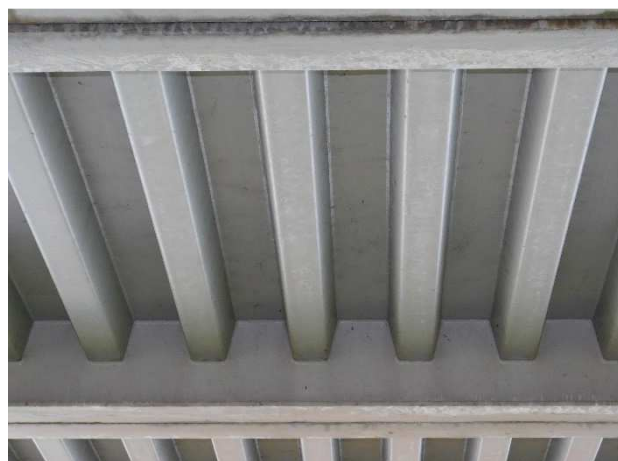
Fot 3.57 Zbliżenie na żeberka płyty ortotropowej. Stan żeberek i poprzecznic jest dobry.
