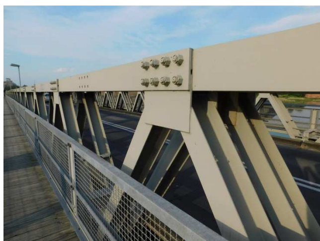
Fot. 2.18 Widok połączenia pasa górnego z krzyżulcami
