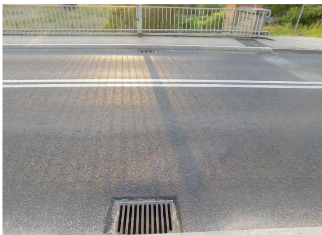
Fot. 2.11 Wpusty mostowe wzdłuż krawężników
