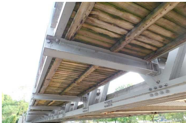
Fot 3.51 Widok z boku na pas dolny i wspornik podchodnikowy.
