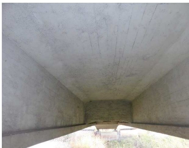
Fot 3.3 Przesło 1. Widok na płytę pomostu i boczną wewnętrzną powierzchnię dźwigarów. Widoczny dobry stan konstrukcji.
