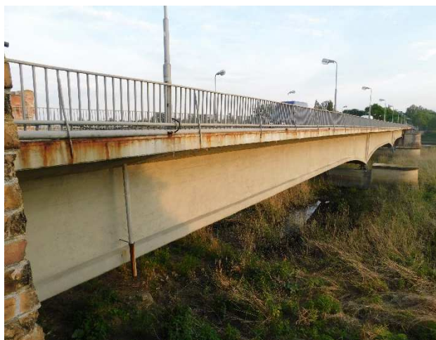
Fot 3.1 Widok ogólny dźwigarów żelbetowych od strony dolnej wody. Widoczny dobry stan powierzchni betonu.
