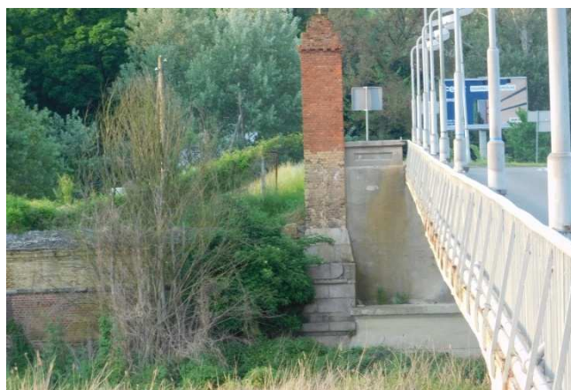
Fot. 2.10 Przyczółek z elementami zabytkowej fortyfikacji ze strony północnej (oś P1)
