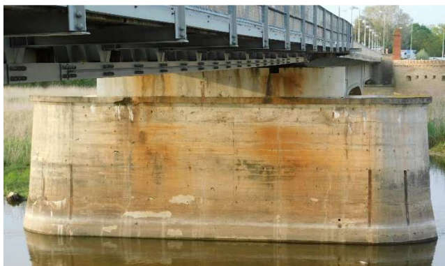
Fot 3.23 Widok filar P4 od strony Niemiec.
