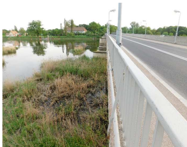
Fot 3.45 Widok na urządzenia obce pod chodnikiem od strony górnej wody.
