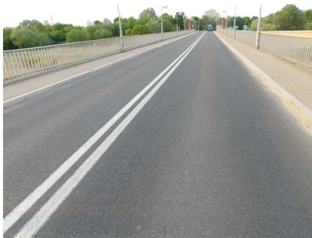
Fot. 2.12 Widok nawierzchni jezdni oraz chodnika (prześło 1 i 2)
