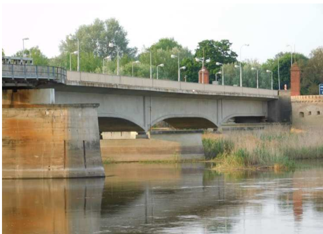
Fot. 2.1 Widok części żelbetowej obiektu
