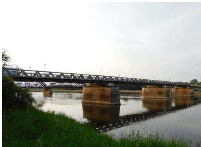
Fot. 2.2 Widok części stalowej obiektu
