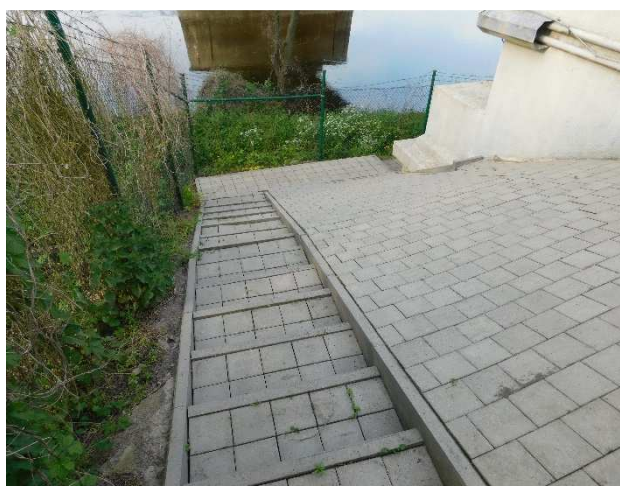
Fot 3.62 Umocniona skarpa i schody przy przyczółku P7. Stan elementów jest dobry.
