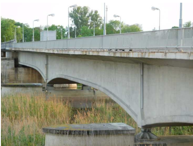
Fot. 2.3 Widok z boku na ustrój nośny części żelbetowej (przęsło 2 i 3)
