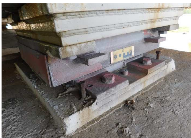
Fot 3.66 Widok na jedno z łożysk na filarze P5. Stan ogólnie dobry.
