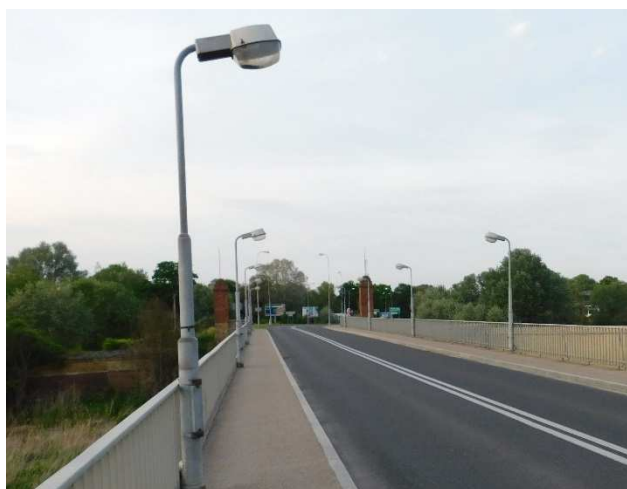
Fot. 2.14 Widok latarni oraz balustrady (prześło 2)
