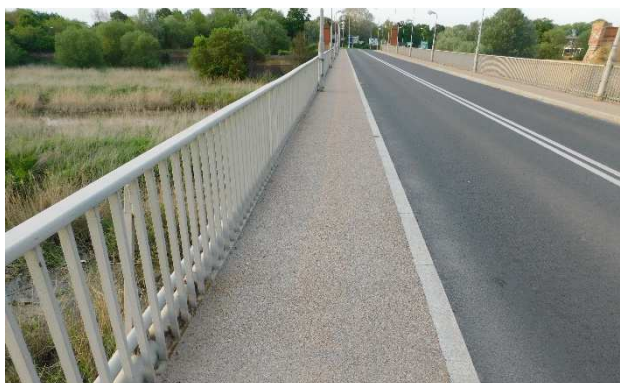
Fot 3.40 Nawierzchnia chodnika od strony dolnej wody. Stan dobry.
