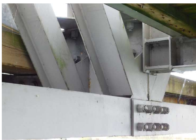
Fot. 2.17 Widok połączenia pasa dolnego z krzyżulcami
