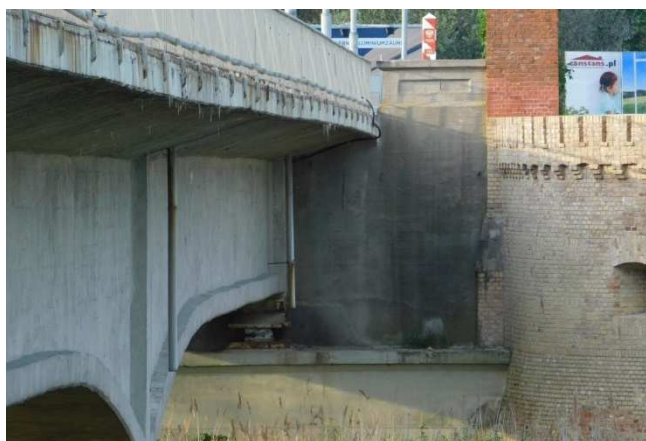
Fot. 2.9 Przyczółek z elementami zabytkowej fortyfikacji ze strony południowej (oś P1)
