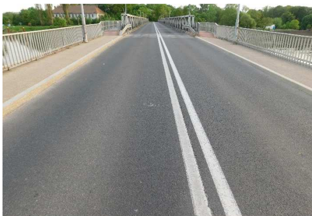
Fot 3.36 Nawierzchnia jezdni na obiekcie żelbetowym w rejonie konstrukcji stalowej. Stan dobry.
