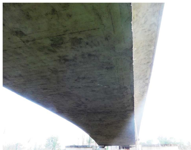
Fot 3.4 Przesło 2. Widok na spód dźwigara skrzynkowego. Widoczny dobry stan konstrukcji.
