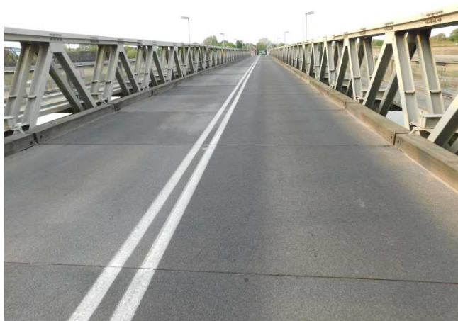
Fot. 2.23 Widok nawierzchni jezdni
