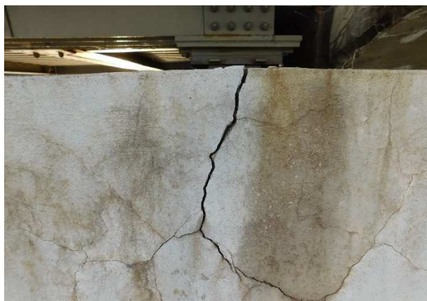
Fot 3.66 Znacznie spękany bok ciosu podłożyskowego na filarze P4.
