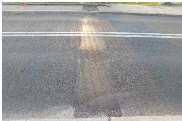
Fot 3.33 Bitumiczne przekrycie dylatacji na przyczółkiem P1 w widoku z góry.
