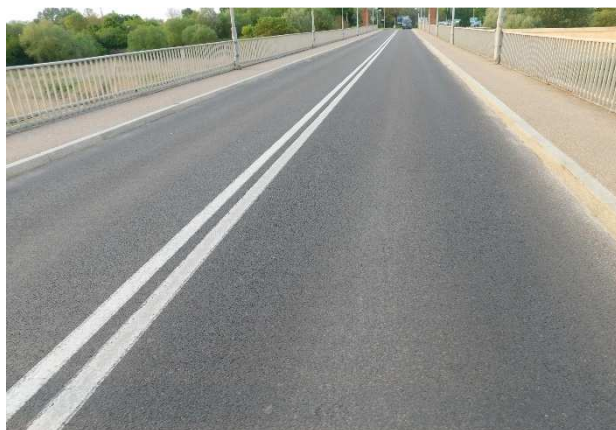
Fot 3.37 Nawierzchnia jezdni na obiekcie żelbetowym w środkowej części konstrukcji. Stan dobry.
