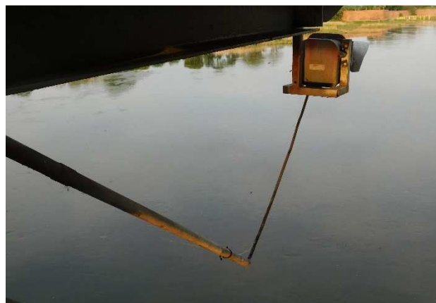
Fot 3.62 Uszkodzenie jw.
