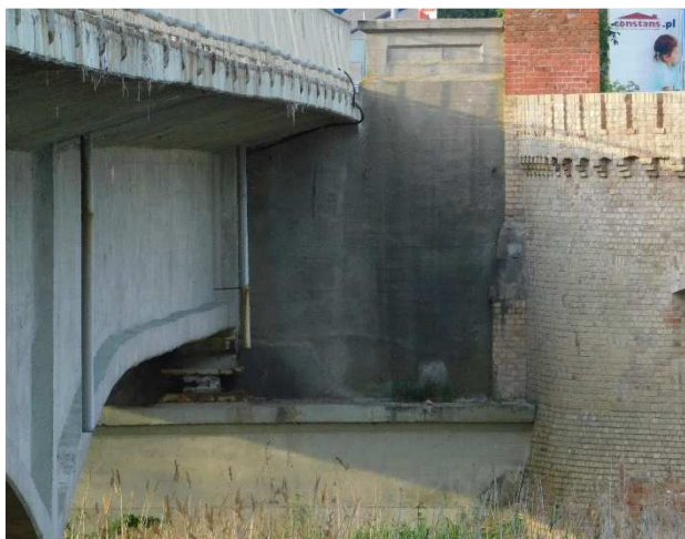
Fot 3.15 Boczna część przyczółka P1 od strony górnej wody. Widoczny dobry stan ścianki zapleczej i korpusu.
