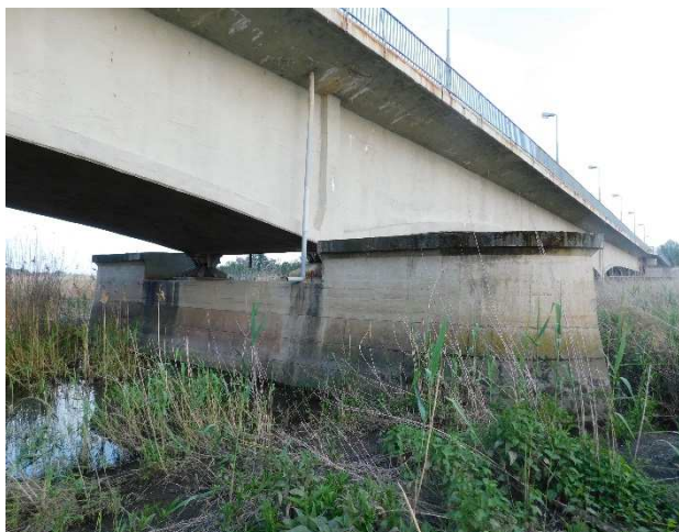
Fot 3.17 Widok na filar P2 od strony Polski. Widoczny dobry stan podpory.
