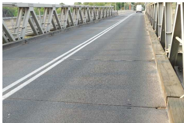
Fot 3.62 Widok nawierzchni jezdni w środkowej części obiektu. Stan nawierzchni jest dobry.
