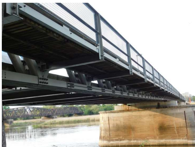
Fot. 2.15 Widok z boku konstrukcji nośnej części stalowej (przęsło 6)
