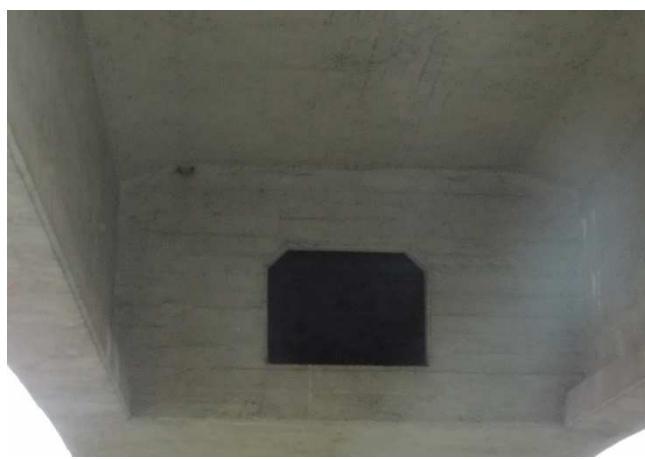
Fot. 2.6 Przepona przekroju skrzynkowego (przęsło 3)
