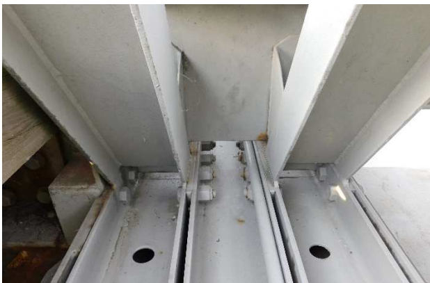
Fot 3.50 Widok od wewnątrz na węzeł dolny konstrukcji.
