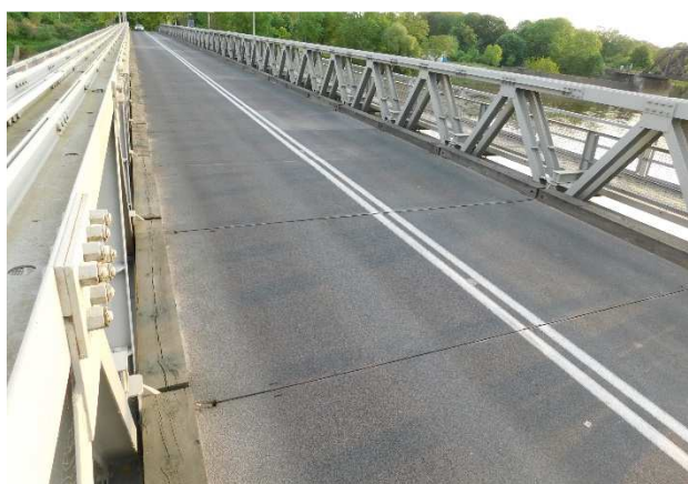
Fot 3.62 Widok nawierzchni jezdni w części obiektu od strony Polski. Stan nawierzchni jest dobry.
