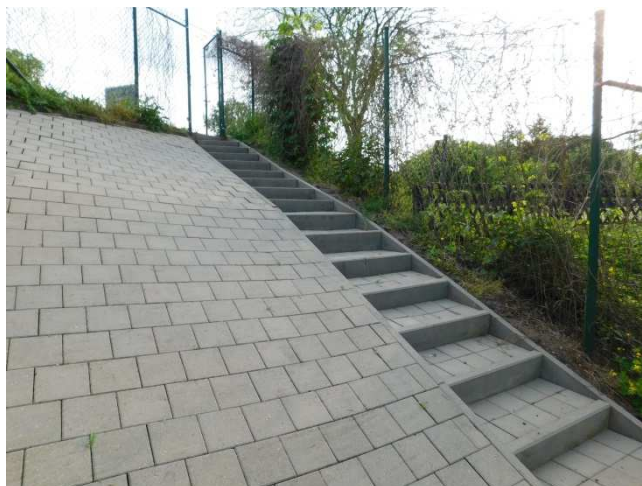
Fot. 2.20 Widok schodów skarpowych
