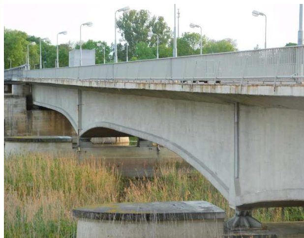
Fot 3.2 Widok ogólny dźwigarów żelbetowych od strony górnej wody. Widoczny dobry stan powierzchni betonu.
