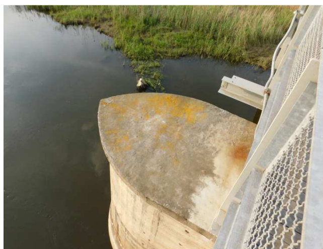
Fot. 2.22 Widok na krawędź podpory P6
