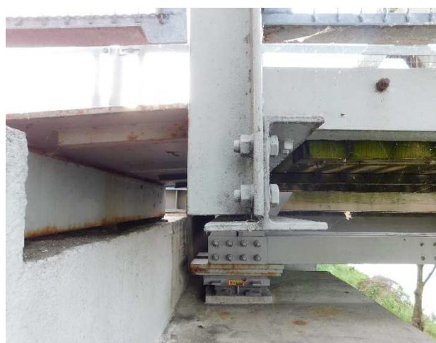
Fot 3.63 Widok na urządzenie dylatacyjne nad przyczółkiem P7 w widoku od dołu. Stan dobry.
