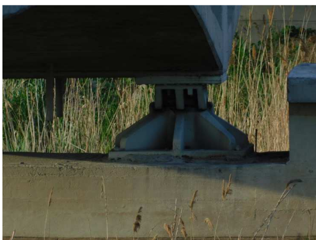
Fot. 2.13 Widok łożyska na filarze w osi P2
