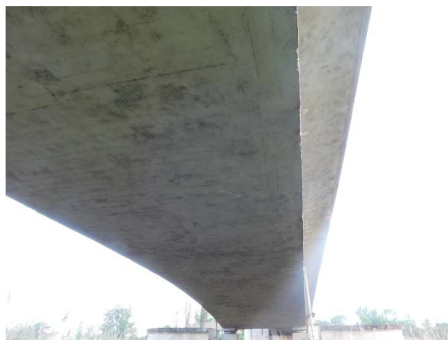
Fot. 2.4 Widok skrzynkowej części ustroju nośnego (przęsło 2)
