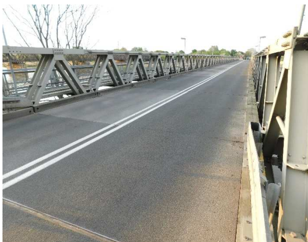
Fot 3.62 Widok nawierzchni jezdni na obiekcie od strony Niemiec. Stan nawierzchni jest dobry.
