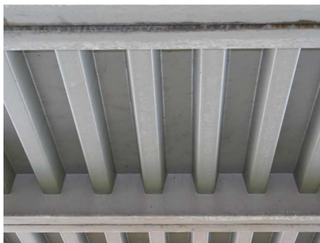
Fot. 2.16 Widok spodu płyty ortotropowej
