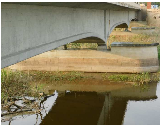
Fot 3.19 Widok części filara P3 od strony Niemiec i górnej wody. Widoczny dobry stan podpory.
