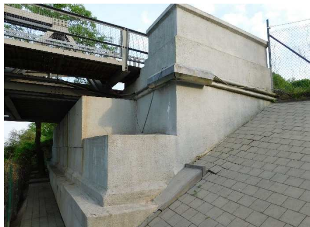
Fot 3.65 Widok na prawą stronę przyczółka P7 i prawe skrzydełko. Stan dobry.
