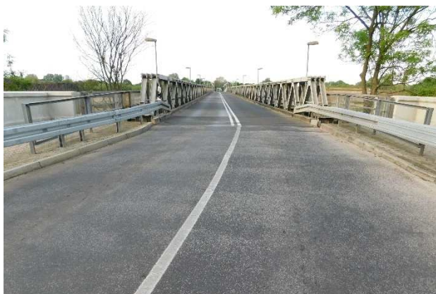
Fot 3.62 Widok nawierzchni jezdni na dojeździe od strony niemieckiej. Stan nawierzchni jest dobry.
