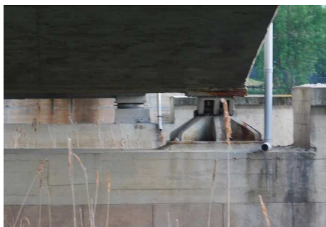
Fot. 2.8 Zagłębione nisze podłożyskowe (oś P2)
