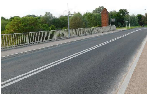
Fot 3.38 Nawierzchnia jezdni na obiekcie żelbetowym w części od strony Polski. Stan dobry.
