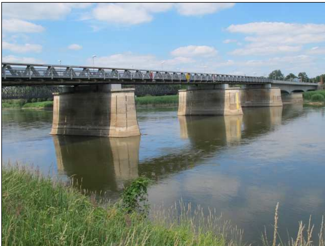
Rys. 4.1 Widok przęseł kratownicowych obiektu od strony górnej wody
