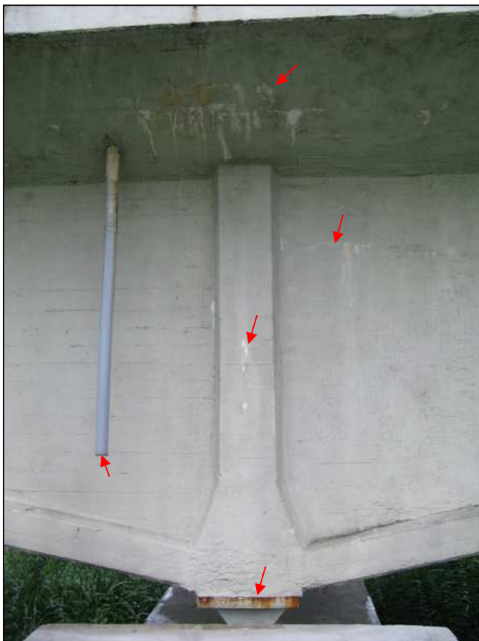
Rys.5.8. Brak kolanek zakańczających i brak końcowych odcinków rur spustowych powodują zaciekanie wody opadowej na niszę podłożyskową. Filar P2 – widok od strony Polski
