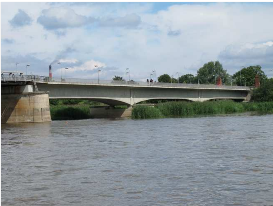
Rys. 4.2 Widok przęseł żelbetowych obiektu od strony górnej wody
