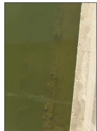
Rys. 6.13. Widoczna odsadzka filaru, pozostałości po ścianie drewnianej i zarys ścianki stalowej – fragment czoła filara, zdjęcie wykonane przy niskim stanie wody 28.06.2011
