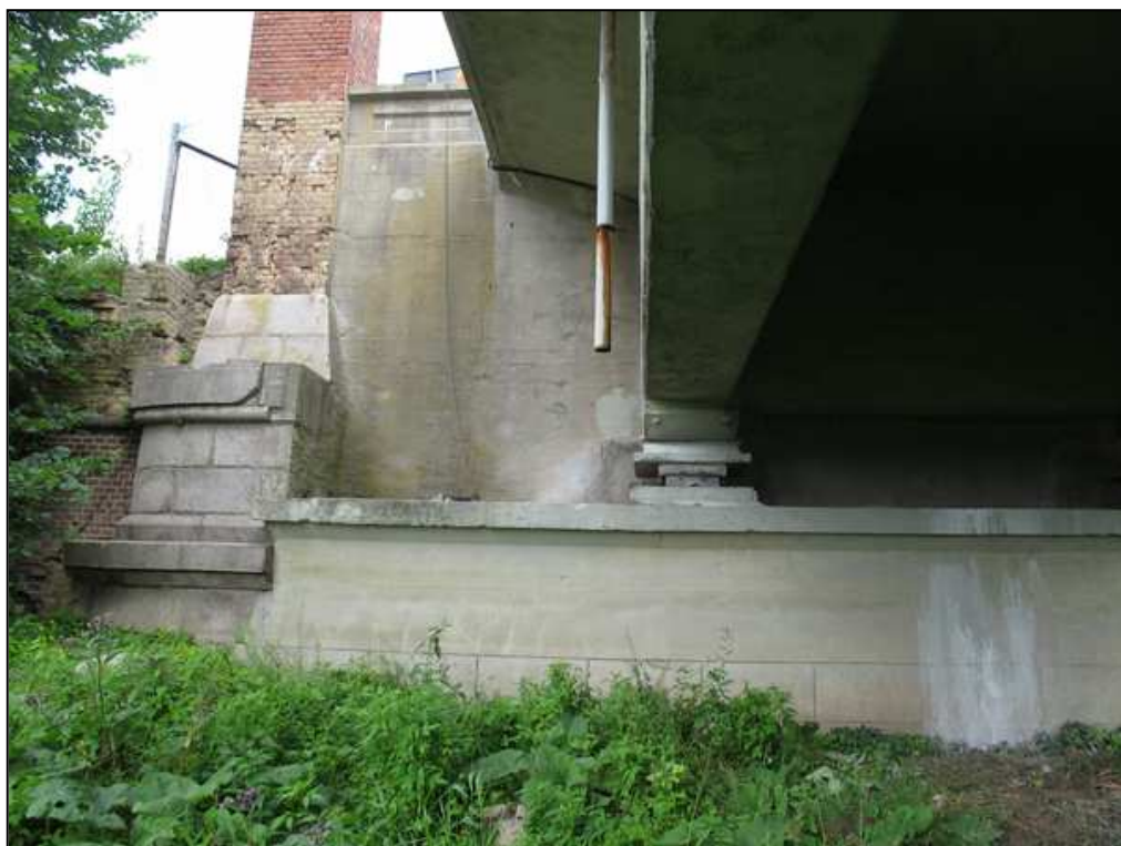
Rys. 6.3. Widok na przyczółek P1 od strony dolnej wody. Widoczne dwa rodzaje cegieł, z których wykonany jest pylon na obrzeżu przyczółka
