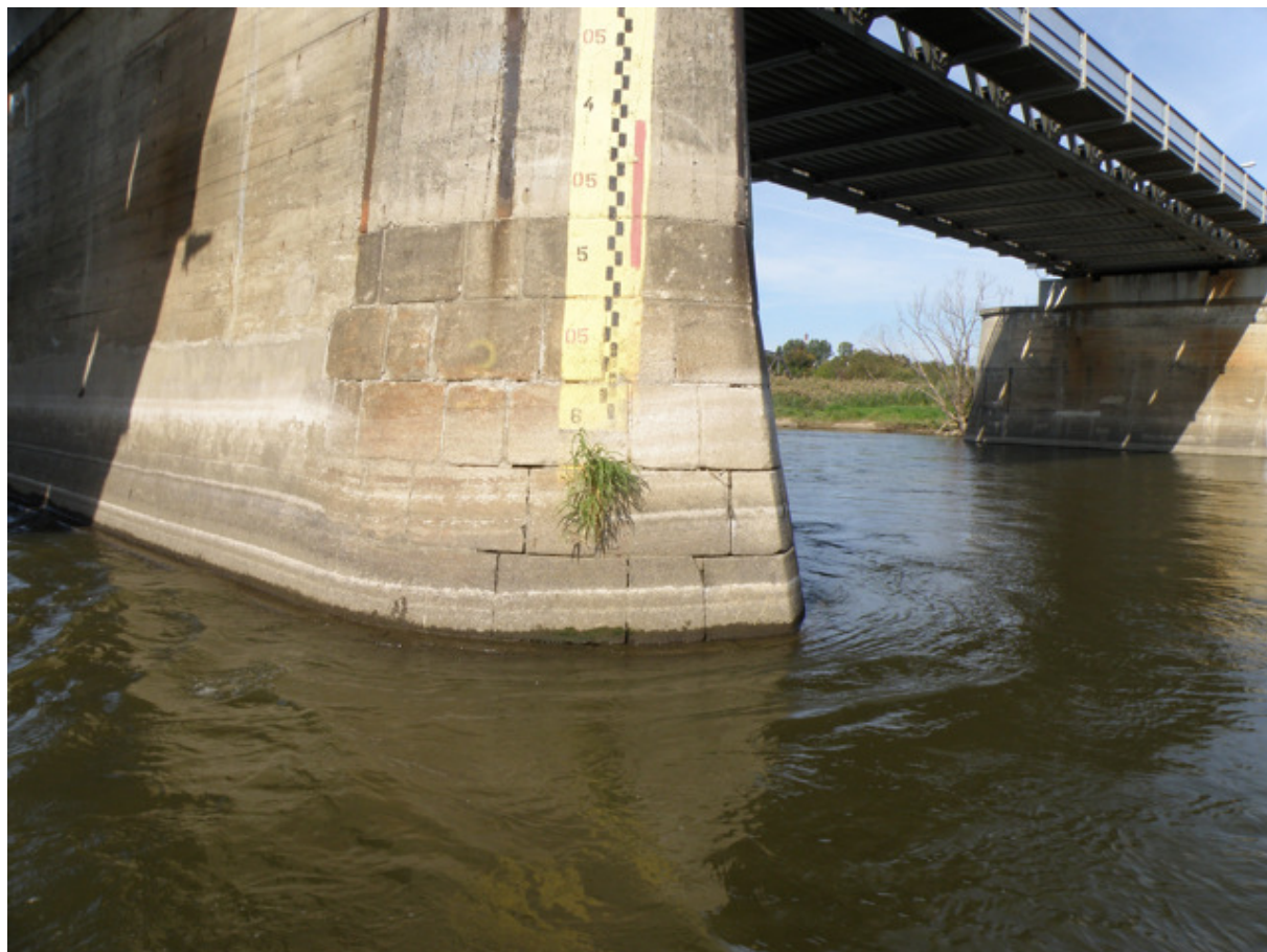
Rys. 10. Widok poziomu wody na wodowskazu filara P5 od strony czoła przy przeprowadzaniu pomiarów batymetrycznych w dniu 30.09.2011
