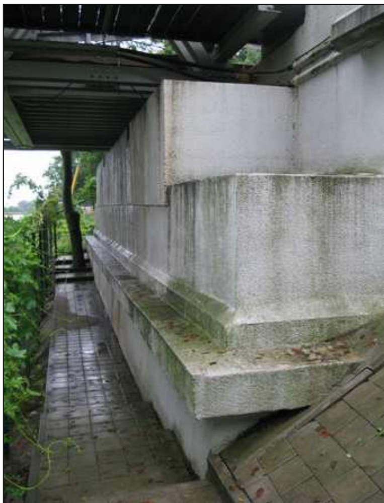
Rys. 6.25 Widok przyczółka P7 od strony dolnej wody
