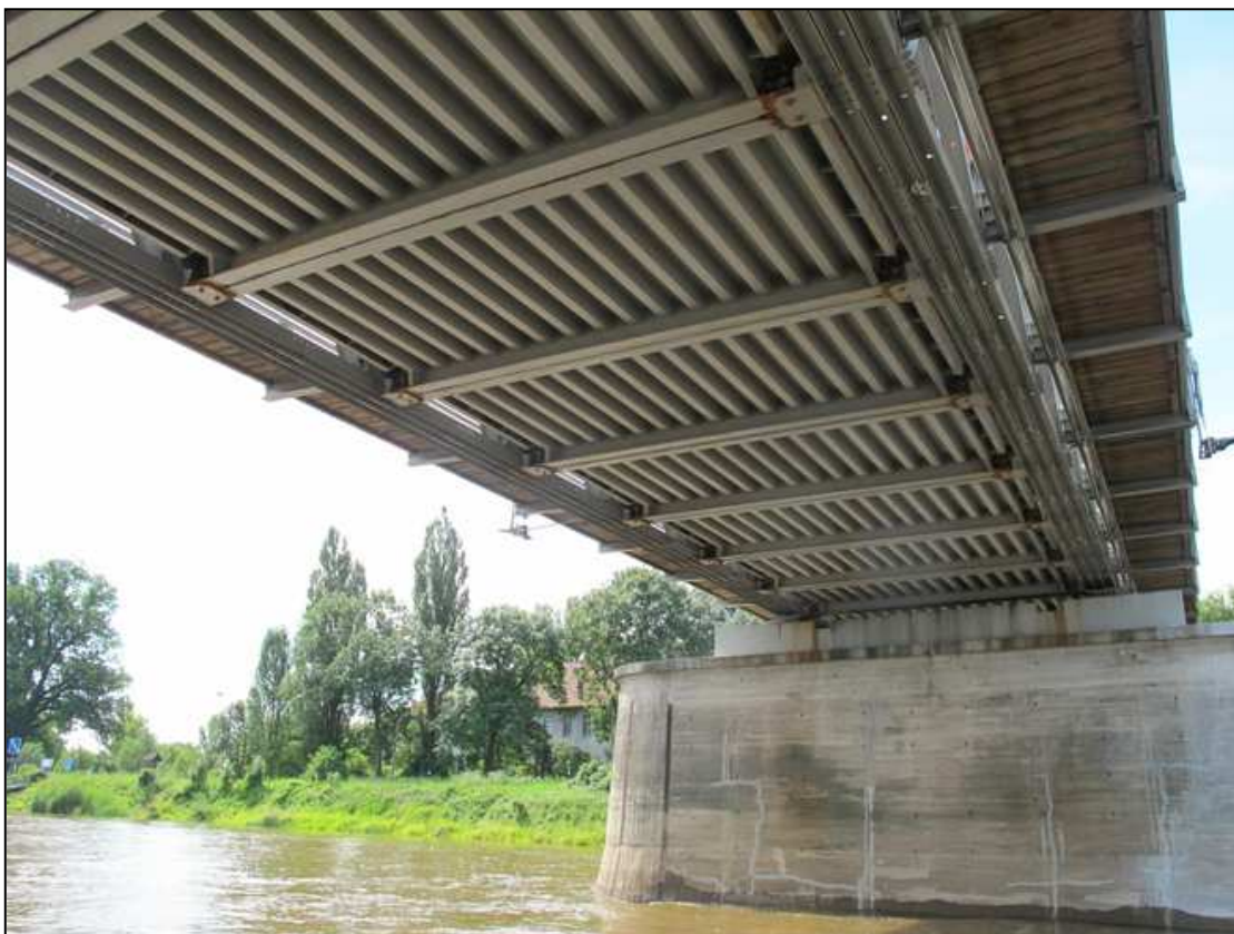
Rys. 4.6 Widok spodu konstrukcji stalowej
