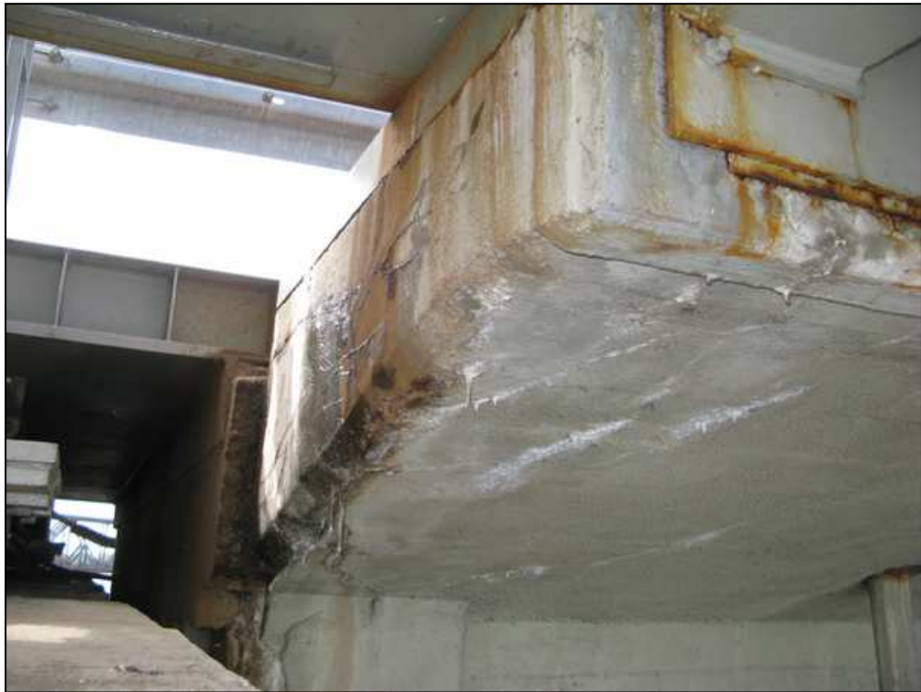
Rys. 5.20. Degradacja betonu w sąsiedztwie połączenia przęseł kratownicowych z żelbetowymi, powstała na skutek zaciekania wody przez nieosłoniętą szczelinę dylatacyjną. Widok od str. górnej wody
