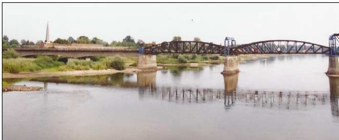
Rys. 4.10 Fotografia archiwalna obiektu z roku 1991 lub 1992. Widok od str. dolnej wody
