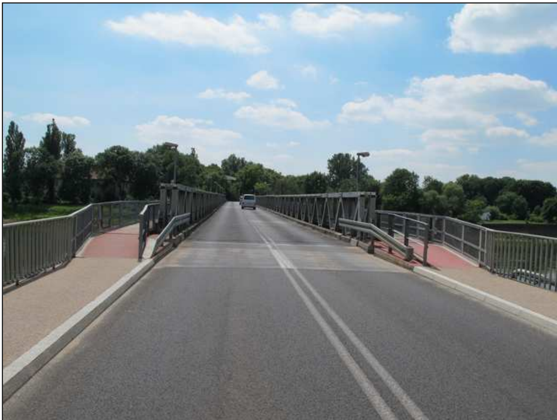
Rys. 4.5 Przejazd z mostu żelbetowego na most stalowy. Widok w kierunku Niemiec
