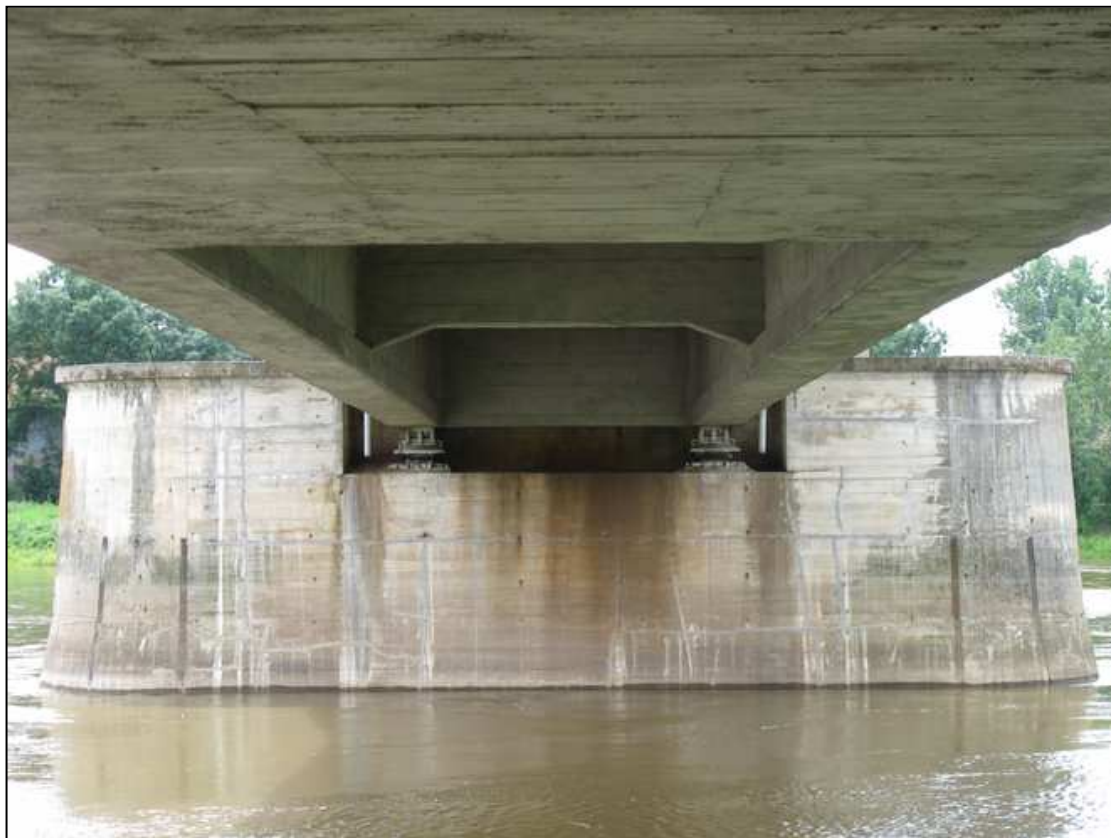
Rys. 4.7 Widok spodu konstrukcji żelbetowej
