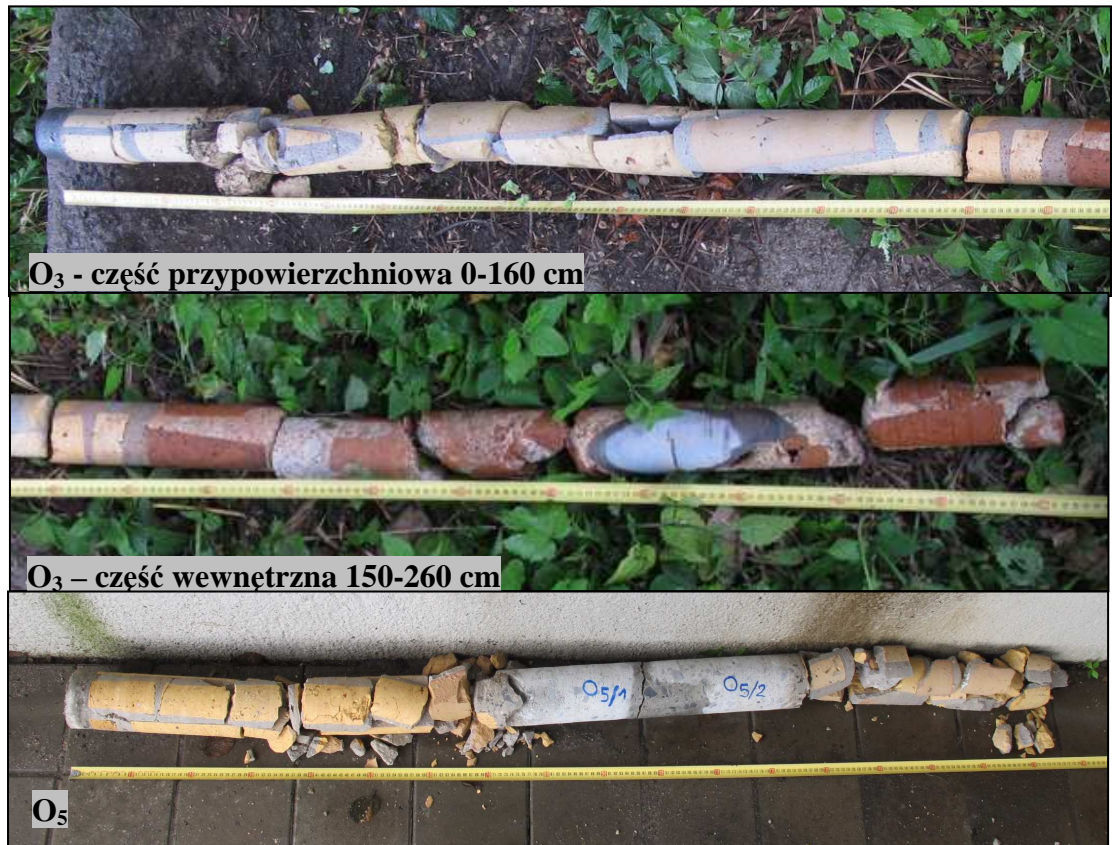
Rys. 8.2 Widok odwiertu O 3 pobranego z przyczółka P1 oraz odwiertu O 5 pobranego z korpusu przyczółka P7
