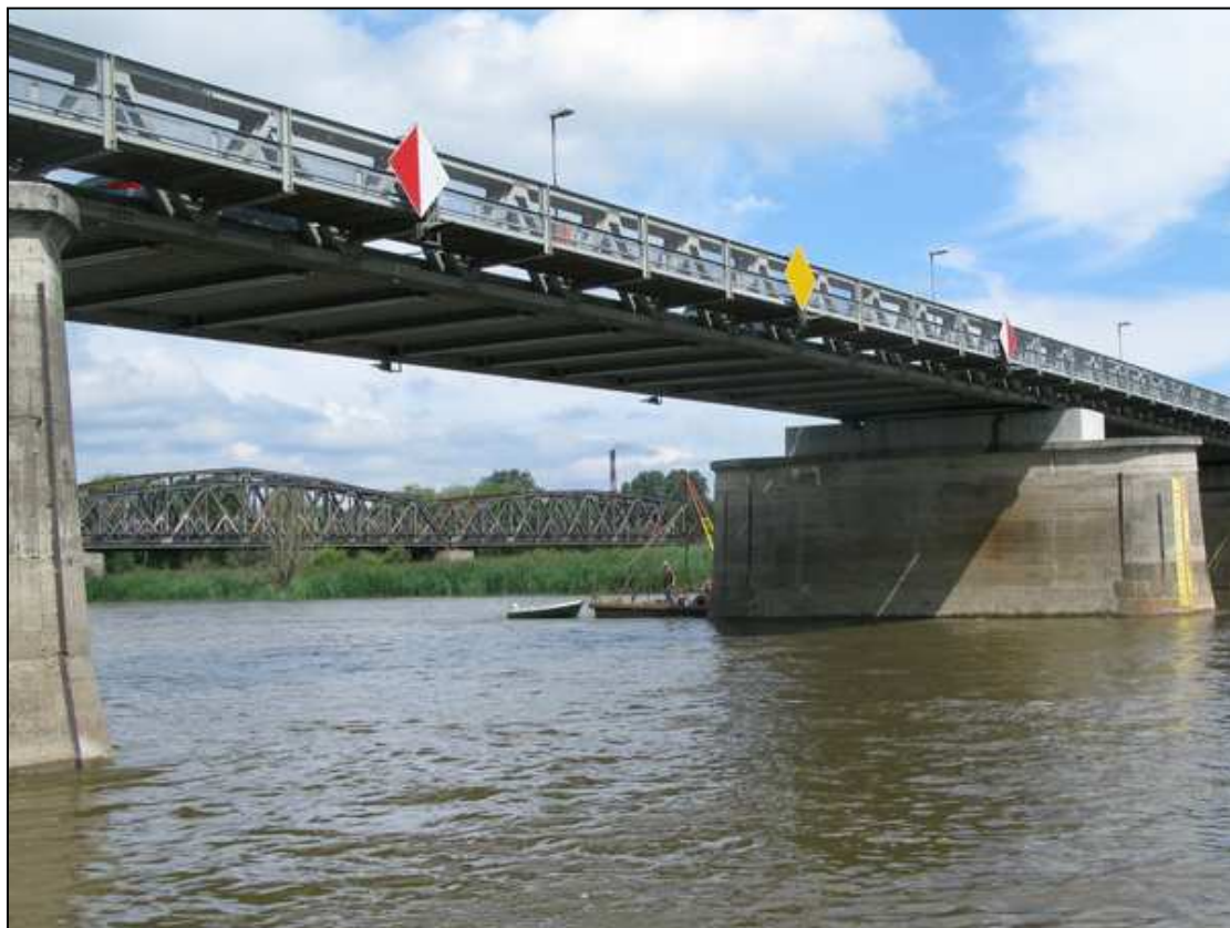
Rys. 4.8 Widok przęsła nad kanałem żeglownym od strony górnej wody. Widoczny wodowskaz żeglugowy na filarze P5 oraz znaki nawigacyjne
