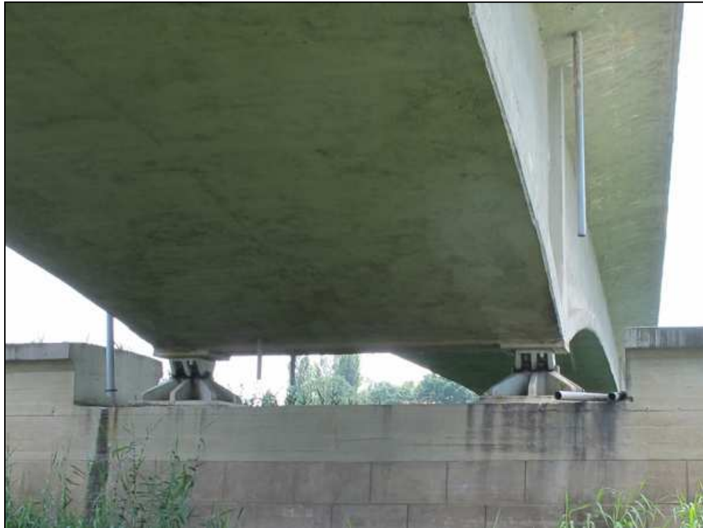
Rys.5.8. Brak kolanek zakańczających i brak końcowych odcinków rur spustowych powodują zaciekanie wody opadowej na niszę podłożyskową. Filar P2 – widok od strony Polski
