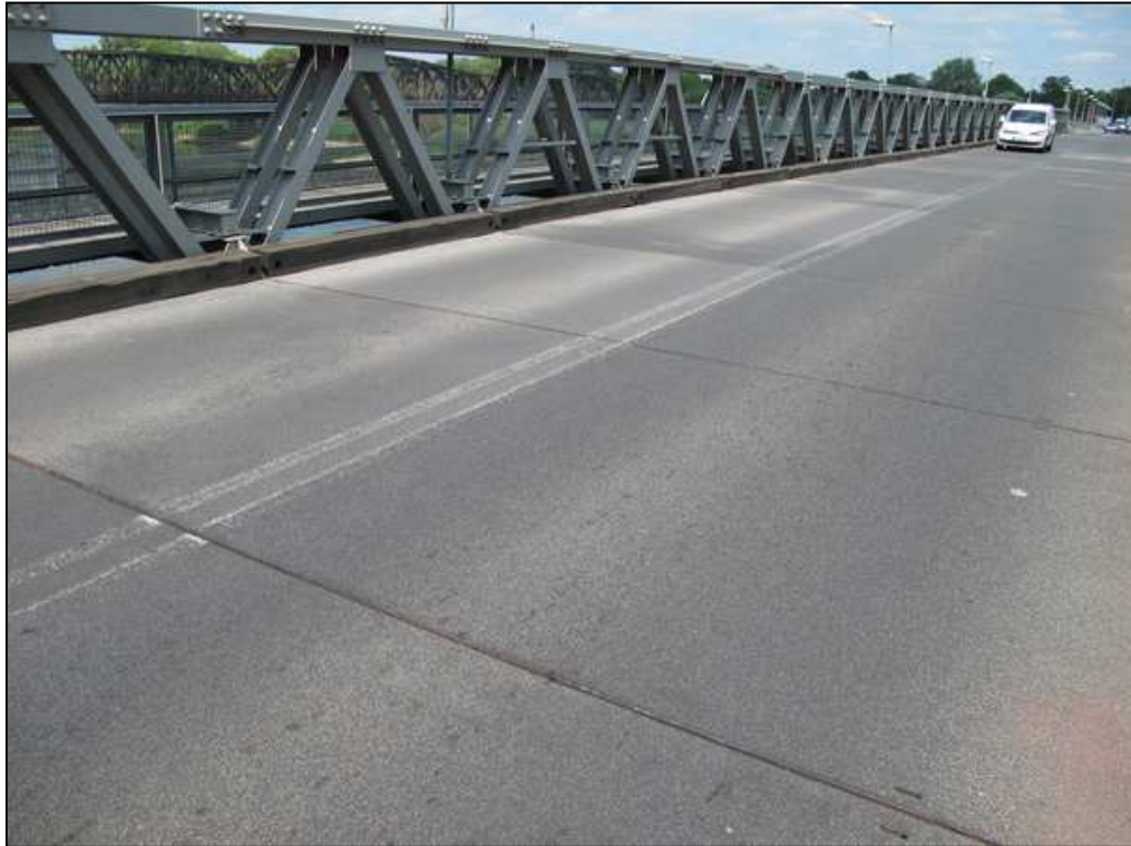
Rys. 5.14. Stan nawierzchni przęseł kratownicowych nie budzi zastrzeżeń. Widok w kierunku Polski
