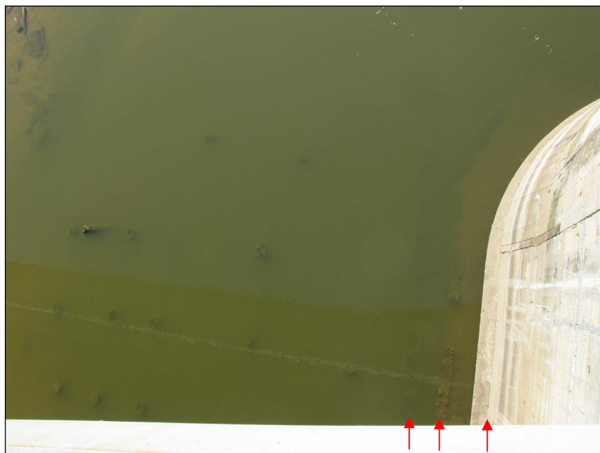
Rys. 6.13. Widoczna odsadzka filaru, pozostałości po ścianie drewnianej i zarys ścianki stalowej – fragment czoła filara, zdjęcie wykonane przy niskim stanie wody 28.06.2011
