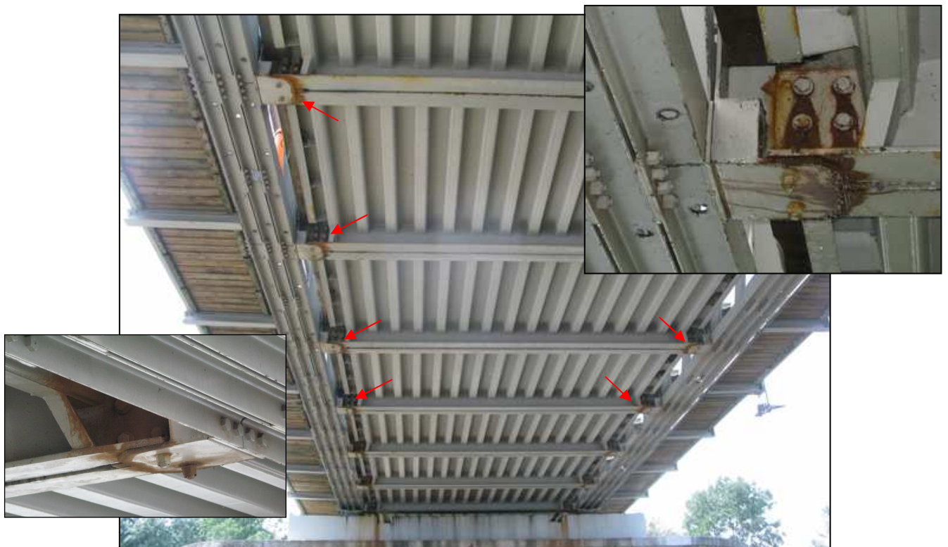
Rys. 5.20. Degradacja betonu w sąsiedztwie połączenia przęseł kratownicowych z żelbetowymi, powstała na skutek zaciekania wody przez nieosłoniętą szczelinę dylatacyjną. Widok od str. górnej wody
