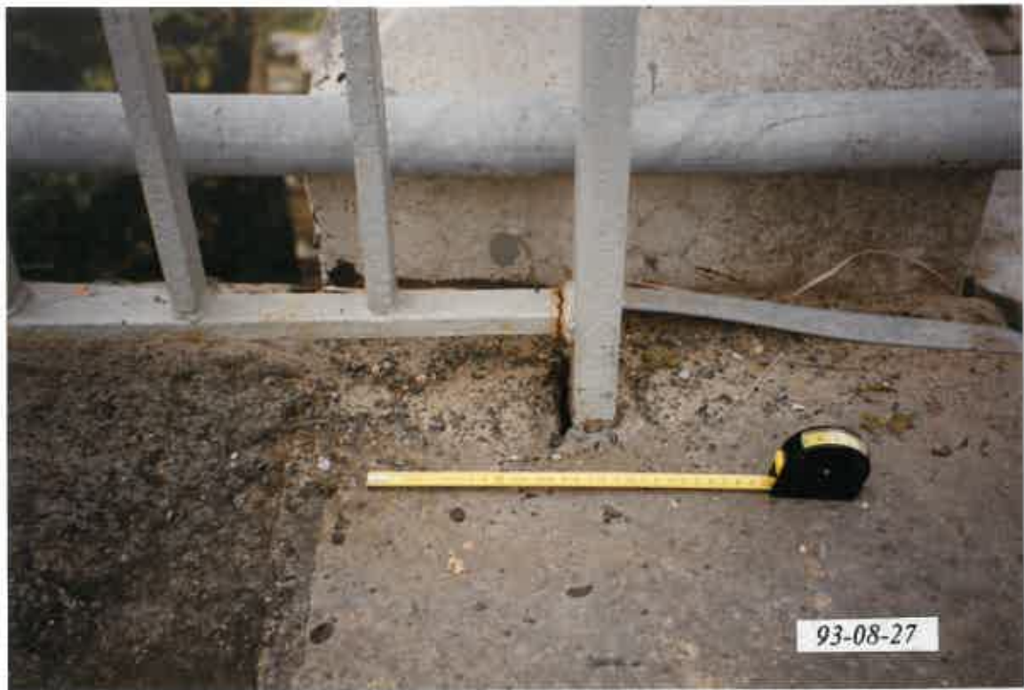
Rys. 4.9 Widok uszkodzenia zamocowania słupka poręczy przy przyczółku od strony wody dolnej
