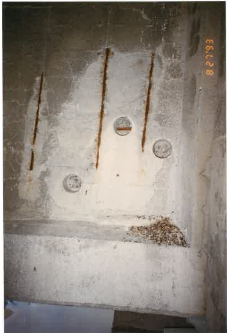
Rys. 4.9 Widok uszkodzenia zamocowania słupka poręczy przy przyczółku od strony wody dolnej
