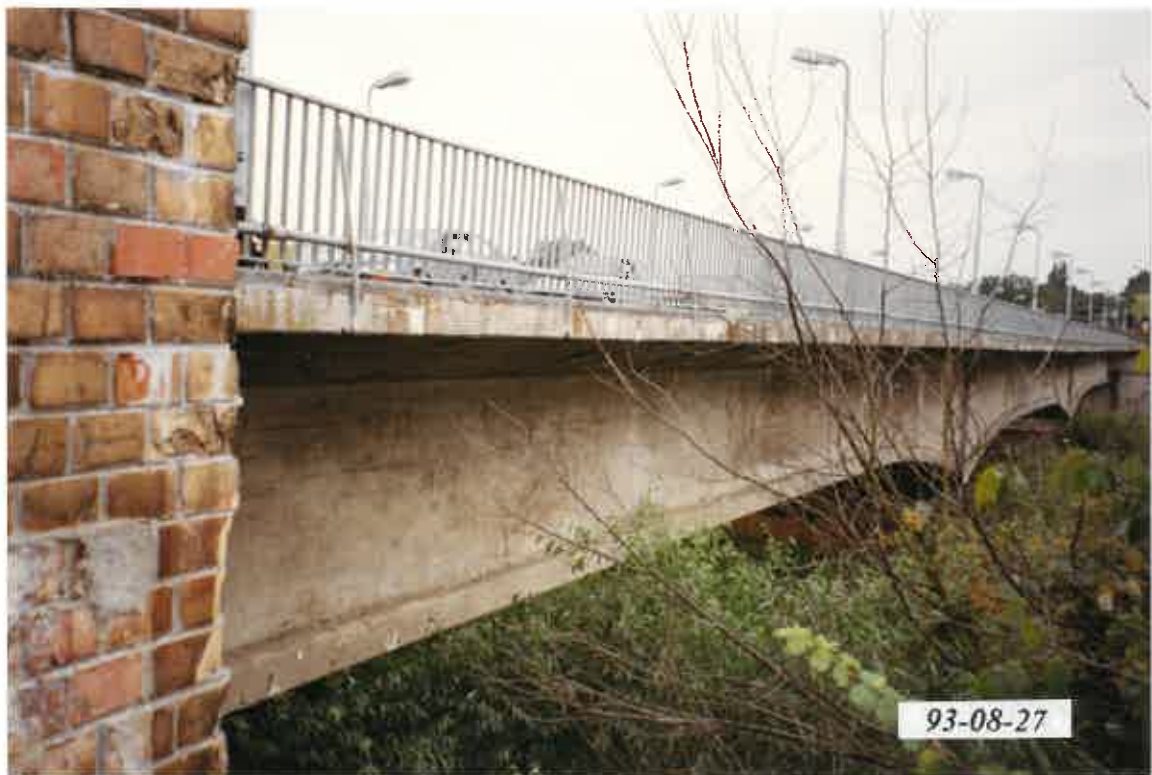
Rys. 3.2 Widok mostu z boku od strony wody dolnej
