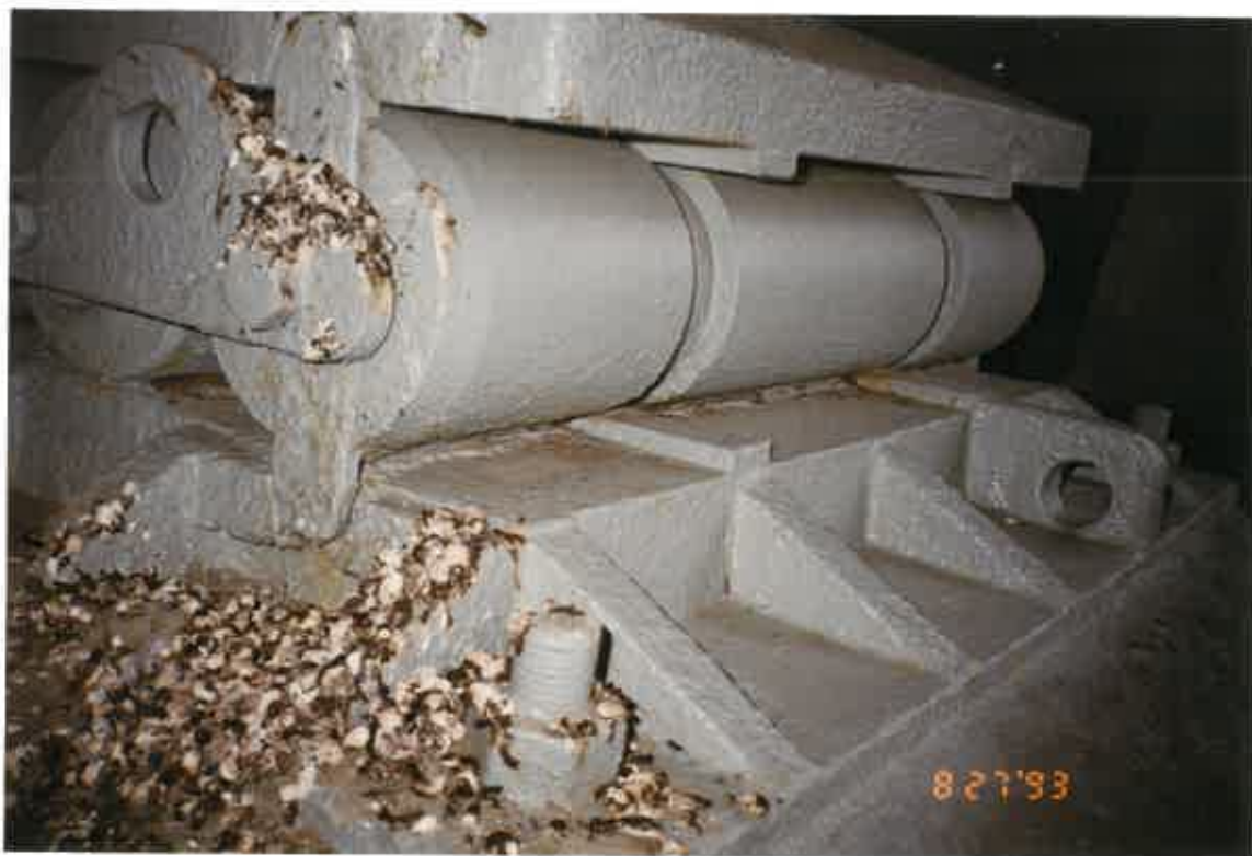
Rys. 4.5 Widok łożyska wałkowego na filarze nr 3
