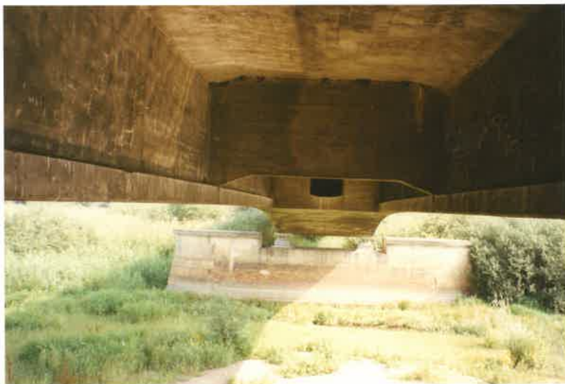
Rys. 3.3 Widok konstrukcji mostu od spodu
