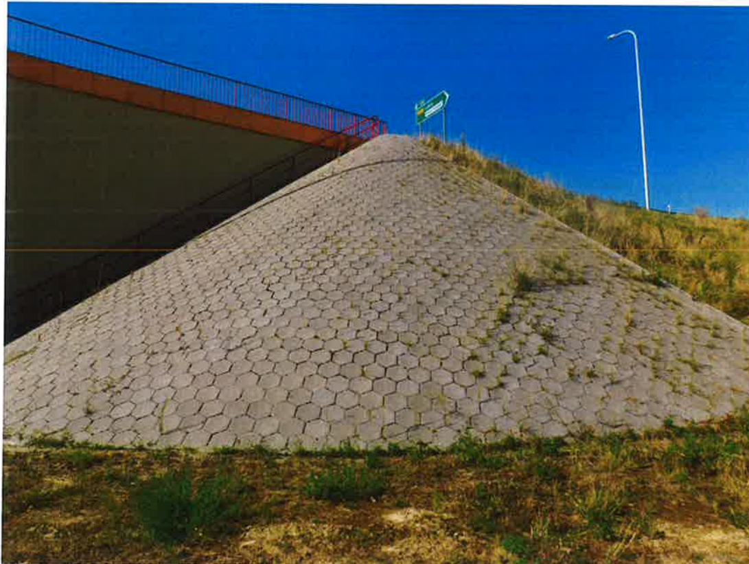
Fot. 14. Wegetacja roślinności na umocnieniu stożka nasypu.
