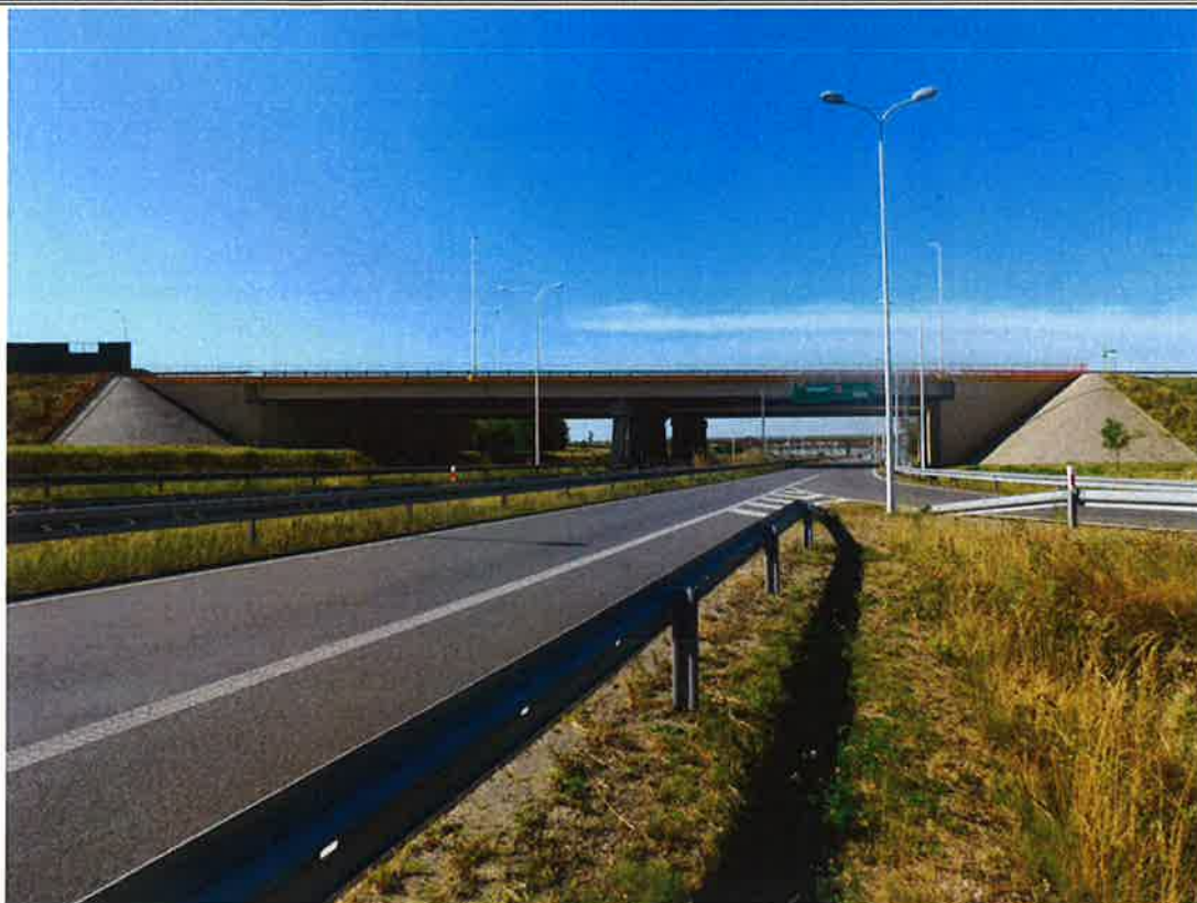
Fot. 1. Widok obiektu od strony północnej.
