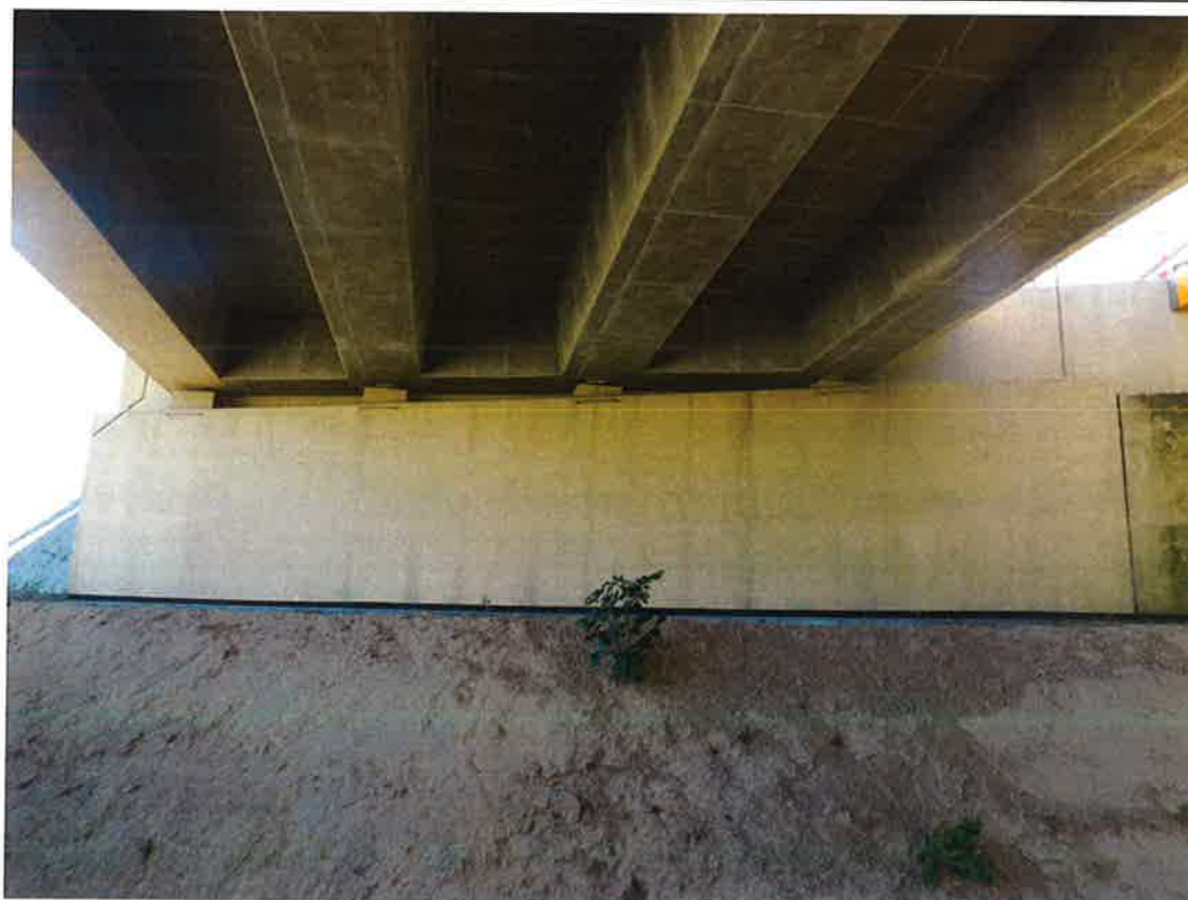
Fot. 10. Widok na przyczółek (podpora nr 3).
