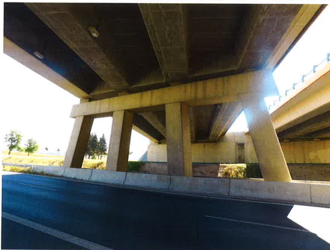
Fot. 9. Widok na filar (podpora nr 2).
