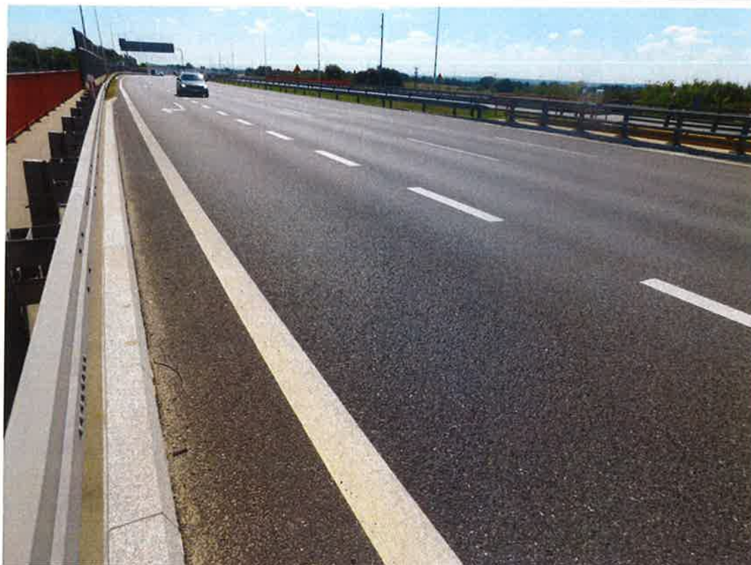
Fot. 3. Widok dojazdu od strony m. Łęczna.
