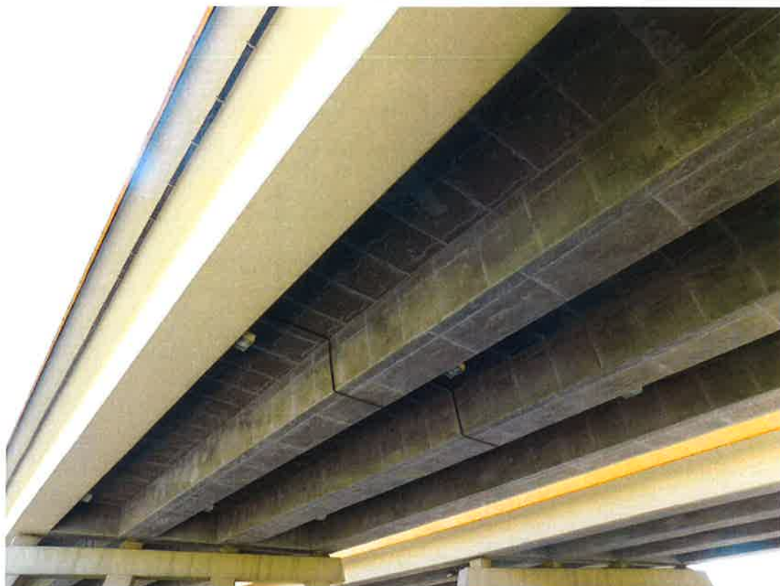
Fot. 5. Widok od spodu na konstrukcję przęsła (przęsło nr 1).
