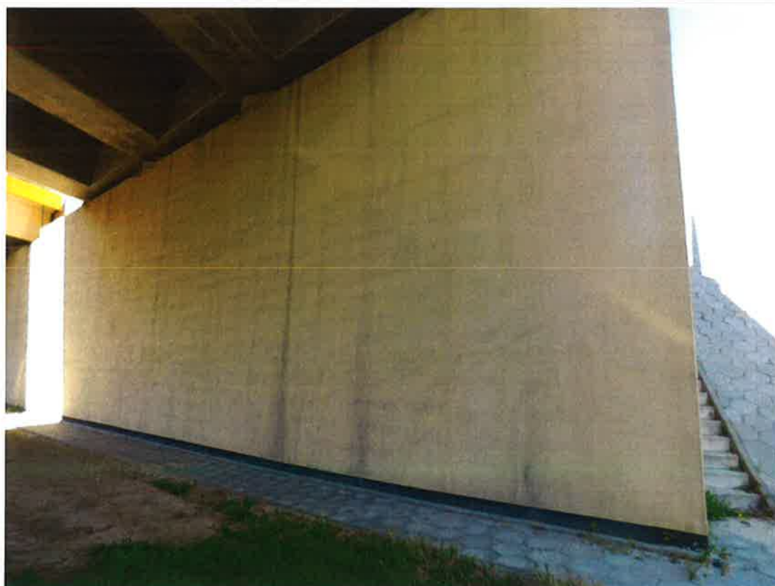
Fot. 8. Widok na przyczółek (podpora nr 1).
