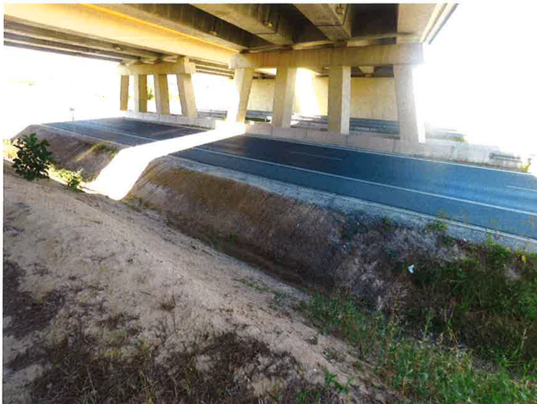
Fot. 7. Widok na przestrzeń podmostową.
