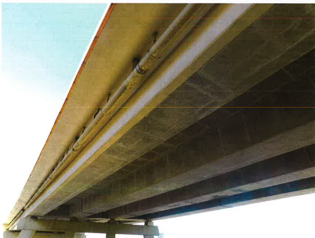
Fot. 6. Widok od spodu na konstrukcję przęsła (przęsło nr 2).
