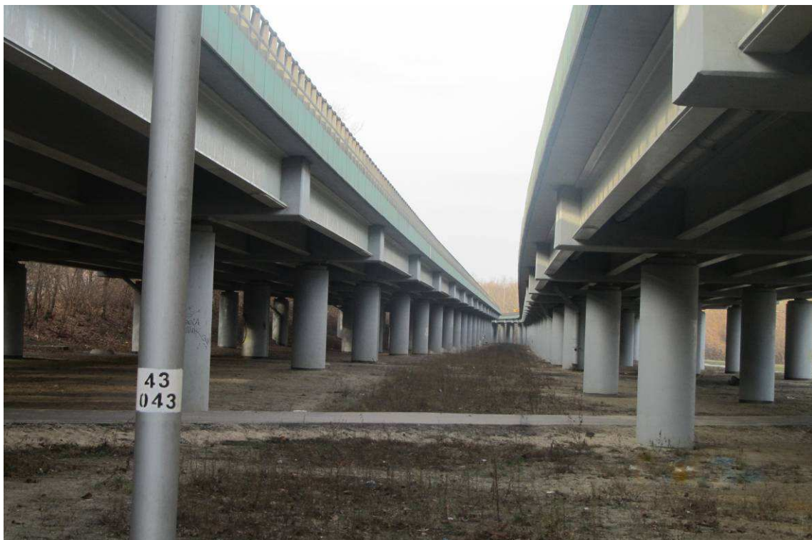
Fotografia 6 Estakada w ciągu Wisłostrady
