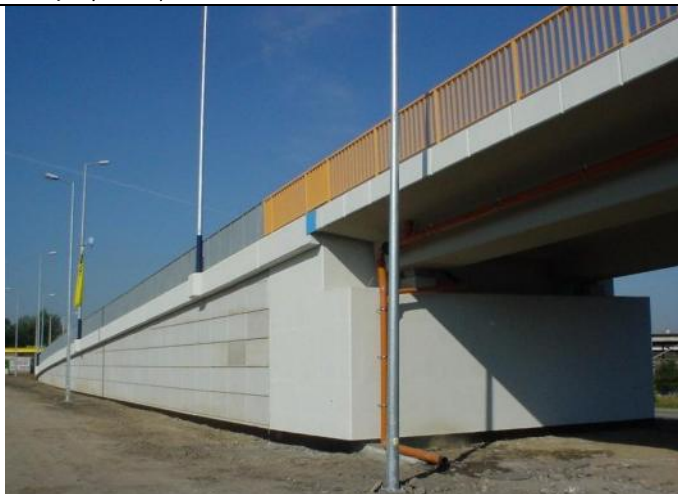
Rys. 4.15. Konstrukcja oporowa T-wall przylega do ściany bocznej przyczółka. Konstrukcja T-wall stanowi osobny drogowy obiekt inżynierski
