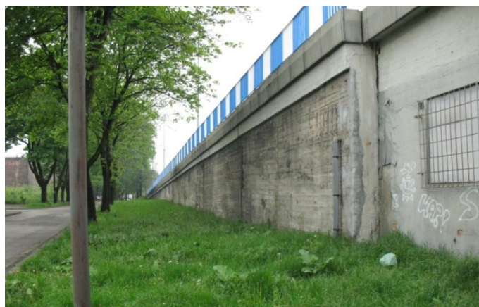
Rys. 4.11. Żelbetowa konstrukcja oporowa nie jest ścianą boczną przyczółka (przylega do ściany bocznej). W ewidencji będzie to osobny drogowy obiekt inżynierski
