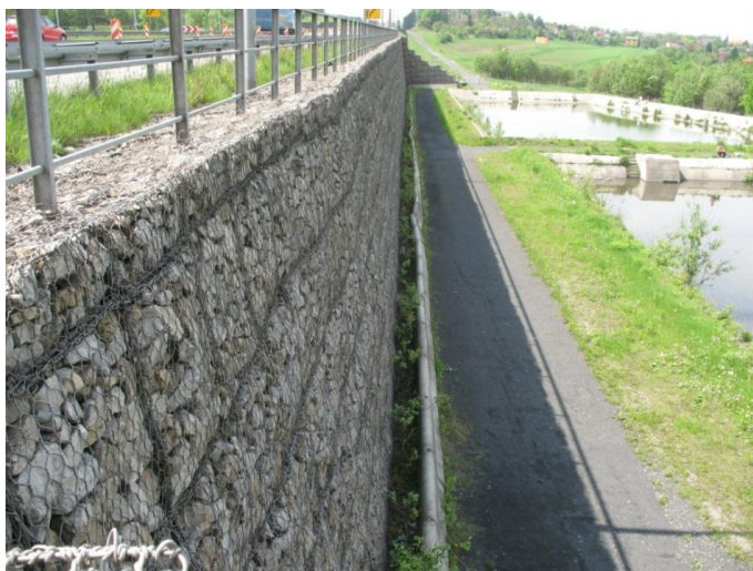
Rys. 4.28. Konstrukcja oporowa z koszy siatkowych
