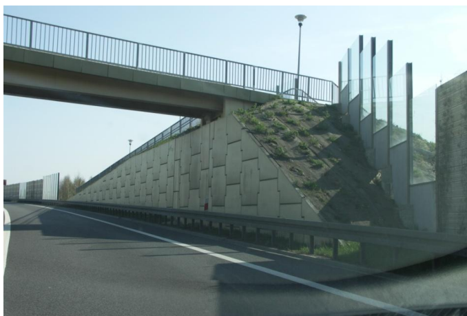
Rys. 5.1. Konstrukcja oporowa utrzymująca nasyp i pochylnię kładki dla pieszych
