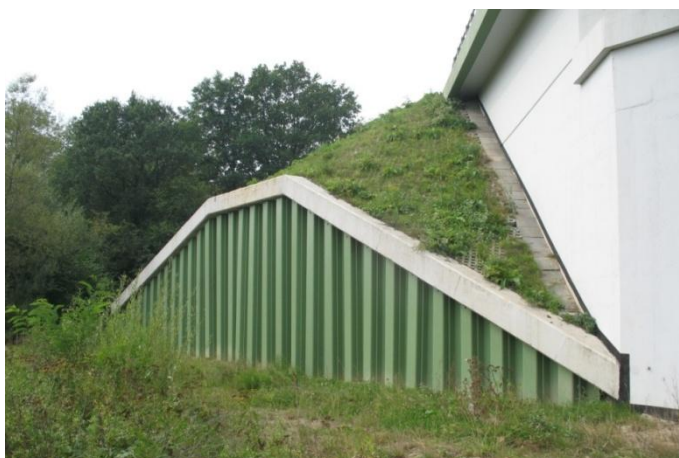
Rys. 4.19. Konstrukcja oporowa z grodzic stalowych – osobny drogowy obiekt inżynierski
