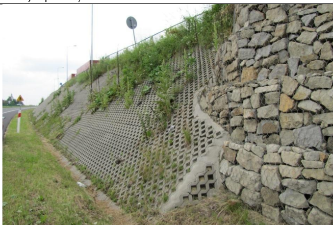
Rys. 4.27. Po prawej stronie fotografii konstrukcja oporowa z koszy siatkowych. Po lewej i po środku fotografii widoczne jest zabezpieczenie skarpy płytami ażurowymi (1:1 - nie jest to konstrukcja oporowa)
