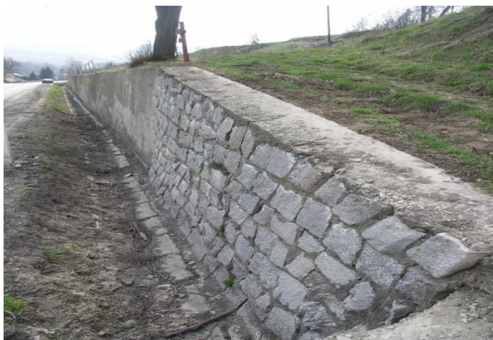
Rys. 4.6. Przykład konstrukcji oporowej złożonej z dwóch części: żelbetowej i kamiennej. W ewidencji będzie to jeden drogowy obiekt inżynierski (jeden NE, itd.)
