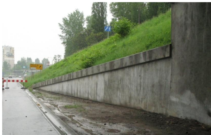
Rys. 4.12. Konstrukcja oporowa przylega do ściany bocznej przyczółka. W ewidencji konstrukcja będzie figurować jako osobny drogowy obiekt inżynierski
