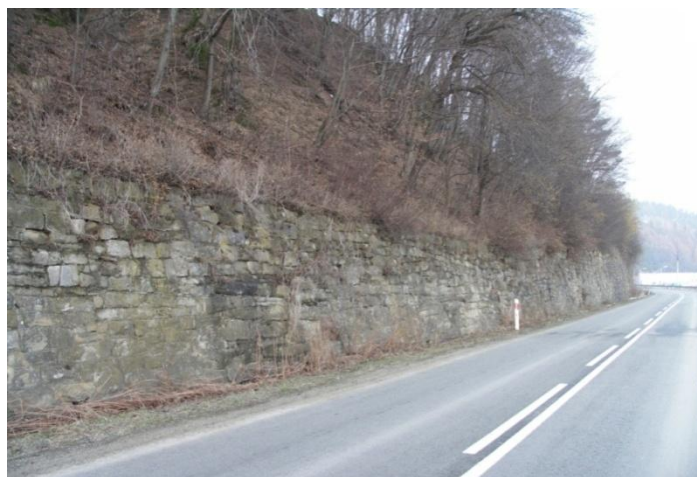
Rys. 4.1. Kamienna konstrukcja oporowa utrzymująca stok porośnięty drzewami – wysokość widocznej części - 3 m
