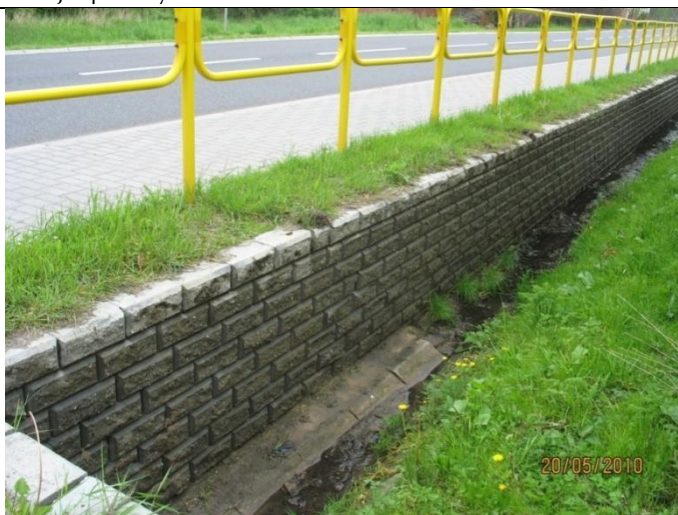
Rys. 4.2. Konstrukcja kamienna utrzymująca nasyp drogi/chodnika (wys. 1m długość 30m) – nie jest to osobny drogowy obiekt inżynierski, jest to element umocnienia nasypu drogi
