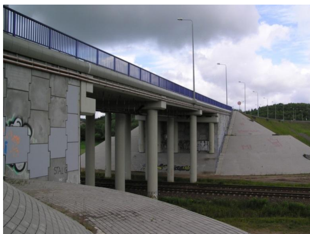
Rys. 4.16. Przyczółki dwudzielne (wg par. 105 ust. 3, Rozp. o warunkach technicznych) – część tylna przenosi oddziaływania naziomu. Konstrukcja oporowa jest częścią przyczółka - nie powinna figurować jako osobny drogowy obiekt inżynierski.
