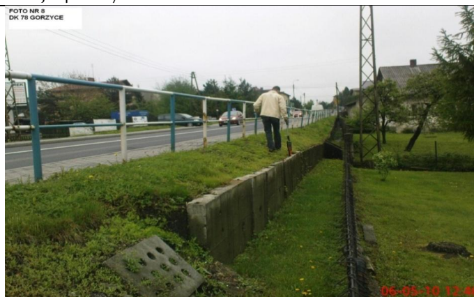
Rys. 4.5. Zabezpieczenie nasypu drogi konstrukcją oporową z prefabrykatów. Długość 30 m, wysokość 1.2 m. Obiekt nie będzie figurował jako osobny drogowy obiekt inżynierski.
