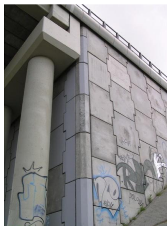
Rys. 4.16. Przyczółki dwudzielne (wg par. 105 ust. 3, Rozp. o warunkach technicznych) – część tylna przenosi oddziaływania naziomu. Konstrukcja oporowa jest częścią przyczółka - nie powinna figurować jako osobny drogowy obiekt inżynierski.
