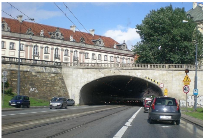
Rys. 4.20. Kamienne konstrukcje oporowe po lewej i po prawej stronie tunelu stanowią w ewidencji osobne drogowe obiekty inżynierskie, ponieważ ich długość jest większa od 15 m.
