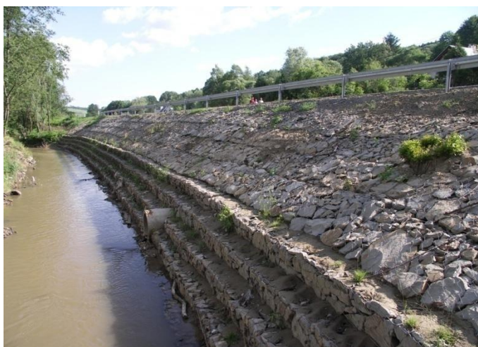
Rys. 4.23. Konstrukcja z gabionów wzmacniająca skarpe nasypu (1:1)
