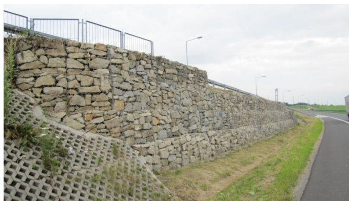
Rys. 4.26. Konstrukcja oporowa z koszy siatkowych
