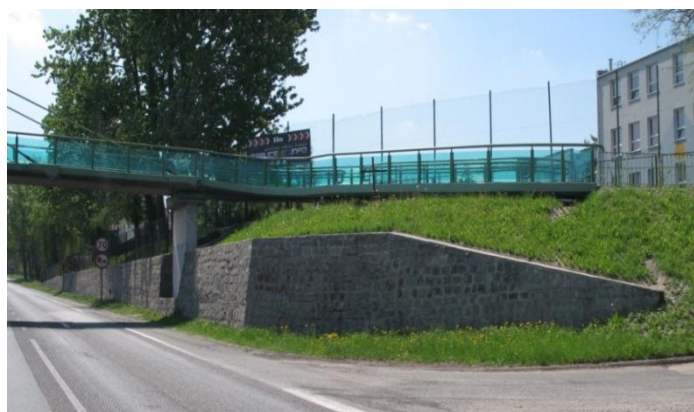
Rys. 4.7. Kamienna konstrukcja oporowa złożona z dwóch części. W ewidencji będzie to jeden drogowy obiekt inżynierski (jeden NE, itd.)
