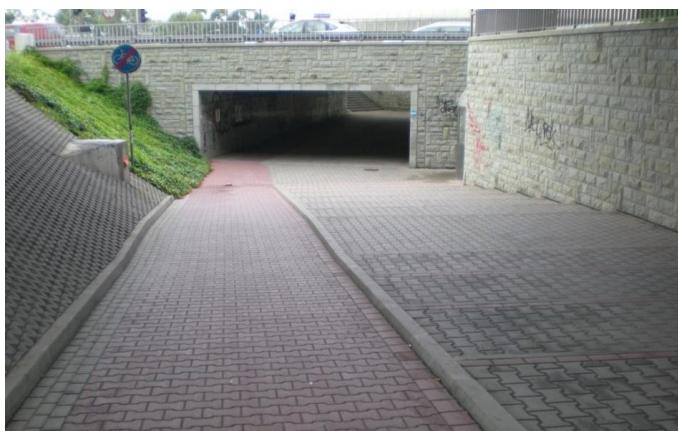
Rys. 4.21. Konstrukcja na pierwszym planie to ściana czołowa przejścia podziemnego i powinna być opisana w ewidencji przejścia podziemnego. Po prawej stronie jest żelbetowa konstrukcja oporowa z okładziną kamienną – nie przylega bezpośrednio do ściany czołowej przejścia podziemnego – stanowi osobny obiekt inżynierski
