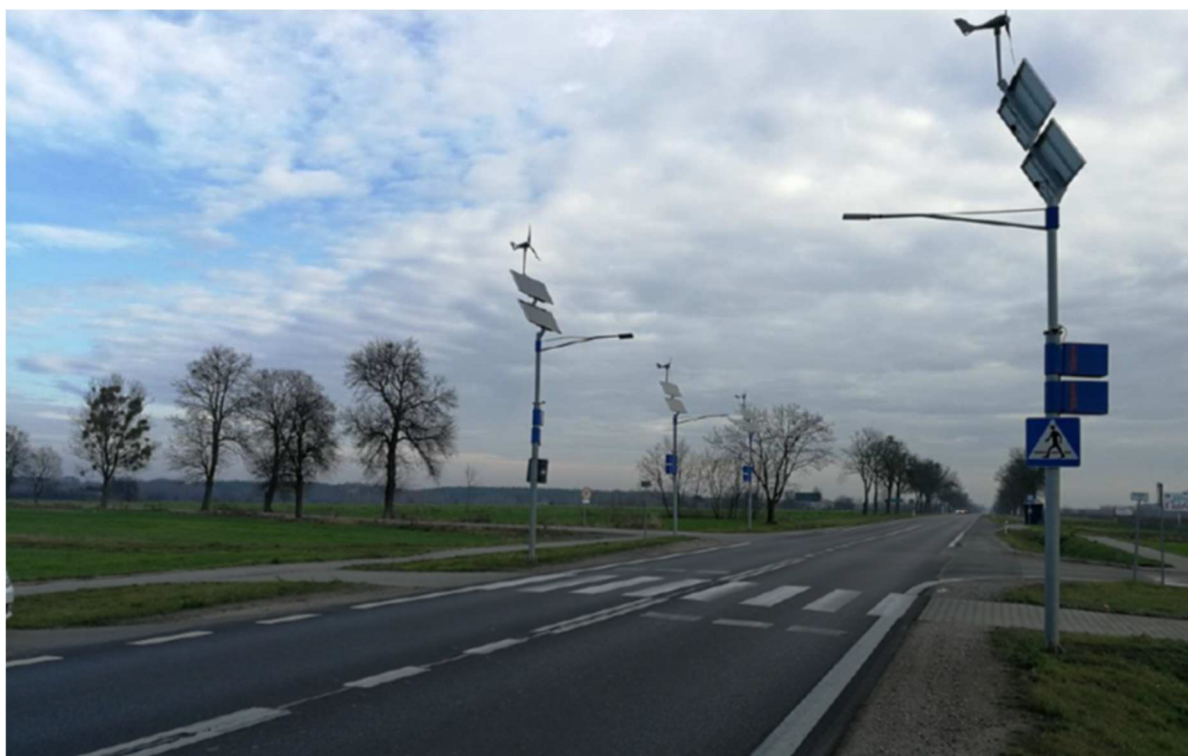
Zdjęcie 8 Przejście dla pieszych zlokalizowane na długim odcinku prostym. Długi odcinek prosty stwarza możliwość rozwijania dużych prędkości, a także wyprzedzanie.
