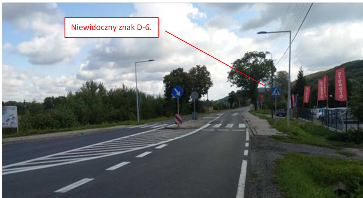
Zdjęcie 7 Źle widoczne oznakowanie pionowe.
