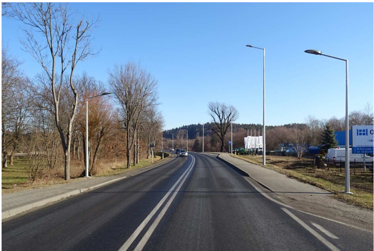
Zdjęcie 5 Sugerowane miejsce bezpiecznego przekroczenia jezdni zlokalizowane pomiędzy przystankami komunikacji zbiorowej, w sąsiedztwie skrzyżowania.
