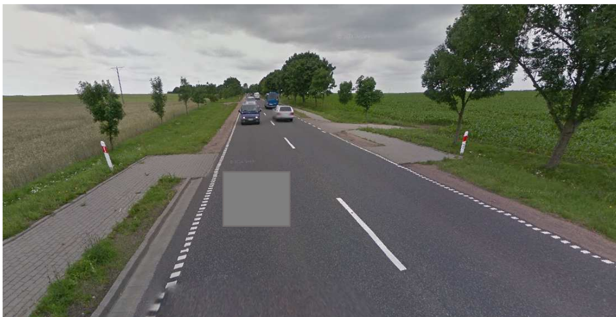
Zdjęcie 6 Sugerowane miejsce bezpiecznego przekroczenia jezdni jednoprzestrzennej o przekroju bez utwardzonego pobocza.
