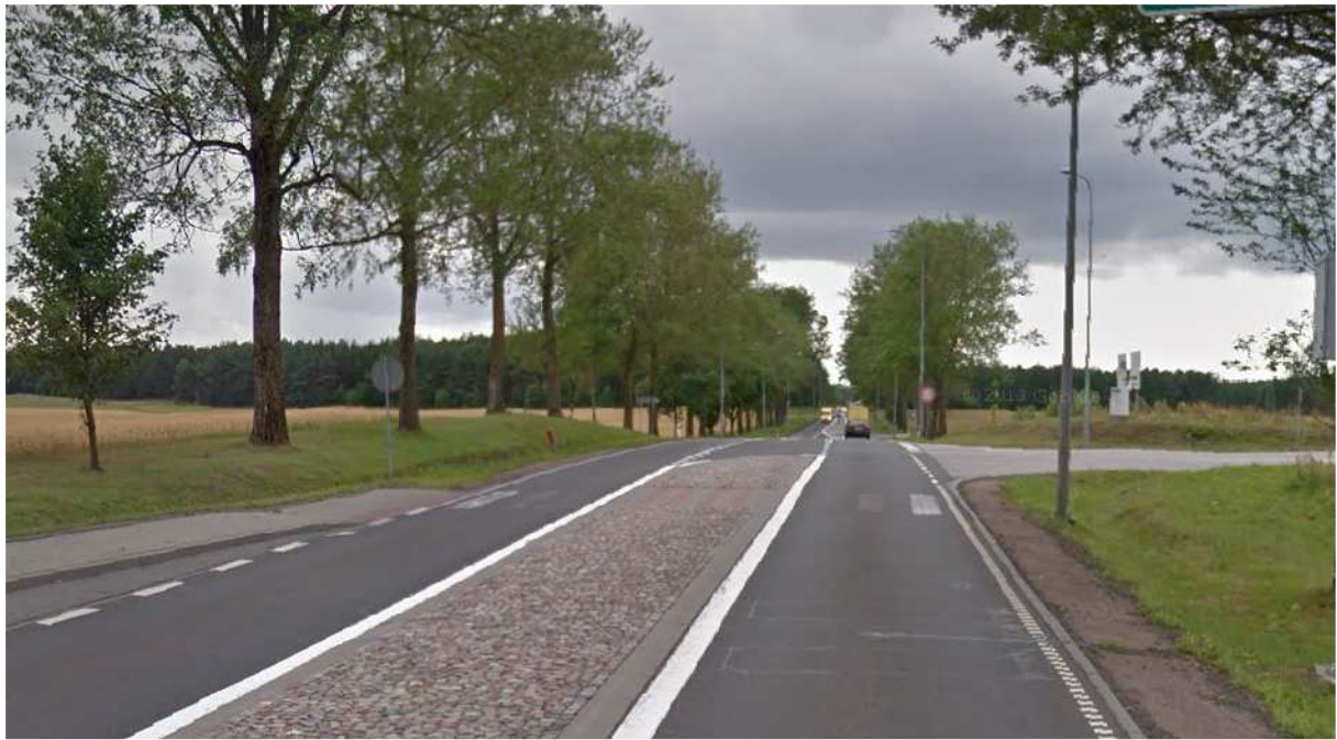
Rysunek 4 Sugerowane miejsce bezpiecznego przekroczenia jezdni z wyspą dzielącą w osi jezdni.
