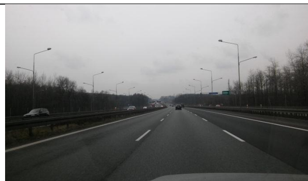
Rys 15 Autostrada A4 w rejonie zjazdu na Prologis.
