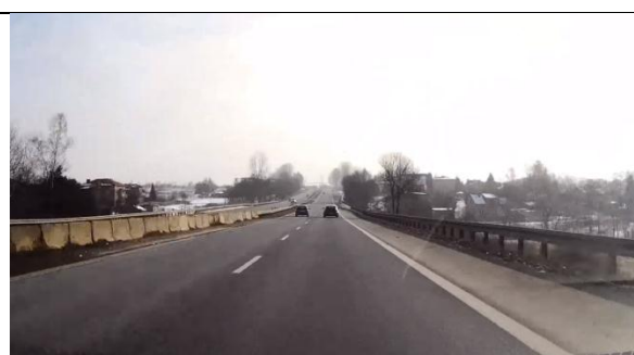
Rys 77 Droga krajowa nr 94 w miejscowości Sławków.
