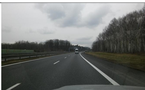
Rys 93 Autostrada A4 w rejonie w rejonie km 295+400.
