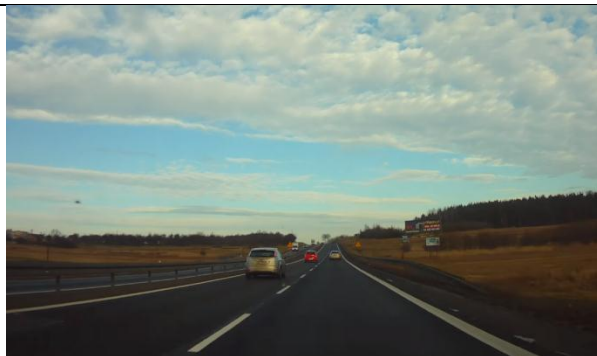
Rys 108 Droga krajowa nr 1 w rejonie km 505+600.
