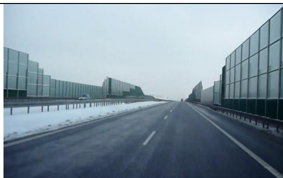
Rys 69 Autostrada A1d w rejonie km 3+500.
