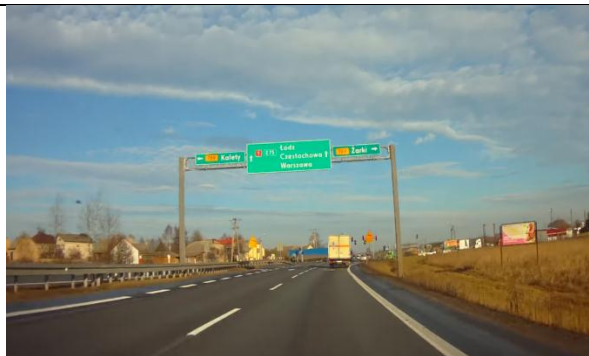
Rys 107 Droga krajowa nr 1 w rejonie miejscowości Koziegłowy.
