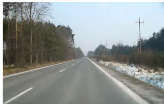
Rys 102 Droga krajowa nr 46 w rejonie km 168+900.
