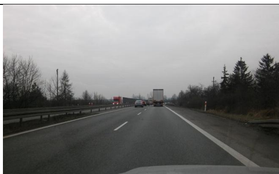
Rys 56 Droga ekspresowa S1 w rejonie wiaduktu z ul. Hubala w km 540+400.
