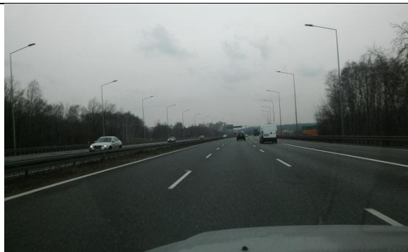
Rys 62 Autostrada A4 w rejonie węzła Zabrze Południe.
