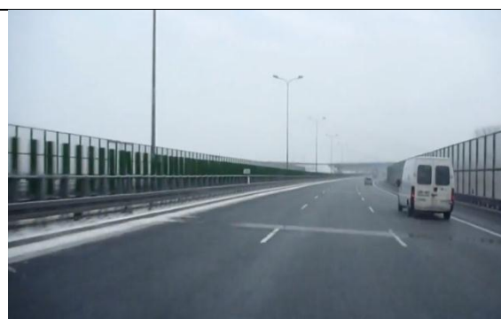
Rys 94 Autostrada A1a w rejonie węzła Knurów.
