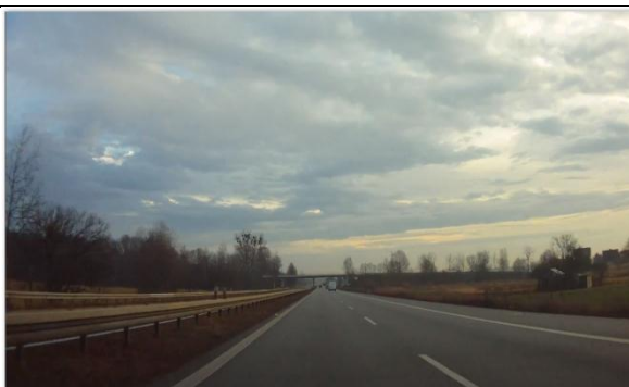
Rys 58 Droga ekspresowa S1 w rejonie km 563+800.
