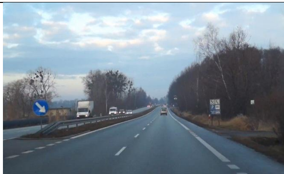
Rys 111 Droga krajowa nr 1 w rejonie miejscowości Pawłowice.
