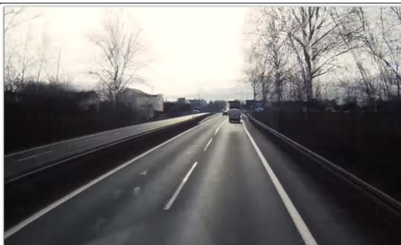
Rys 110 Droga krajowa nr 1 w rejonie miejscowości Goczałkowice-Zdrój.
