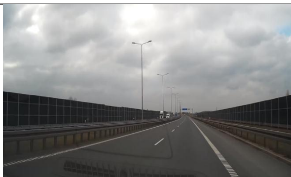
Rys 119 Droga ekspresowa S1b w rejonie węzła Pyrzowice.
