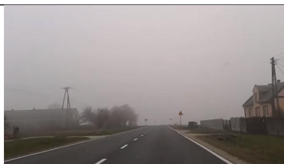
Rys 74 Droga krajowa nr 78 w miejscowości Mierzęcice.
