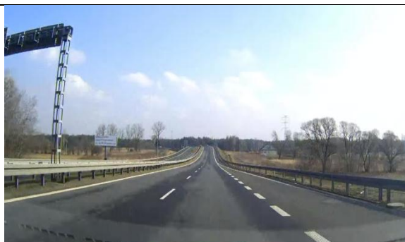
Rys 71 Droga krajowa nr 78b w rejonie km 2+800.
