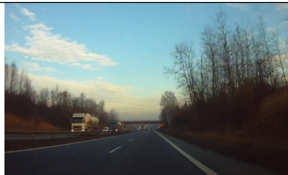
Rys 23 Droga ekspresowa S1 w rejonie wiaduktu z ul. Łaski w Dąbrowie Górniczej.
