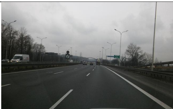
Rys 34 Autostrada A4 w rejonie węzła Katowice Mikołowska.
