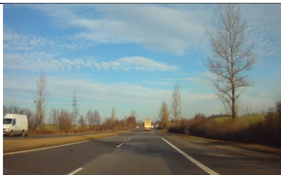
Rys 17 Droga krajowa nr 1 w rejonie północnej granicy miasta na prawach powiatu Częstochowa.
