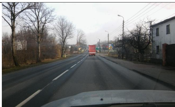
Rys 117 Droga krajowa nr 78 w miejscowości Tarnowskie Góry.
