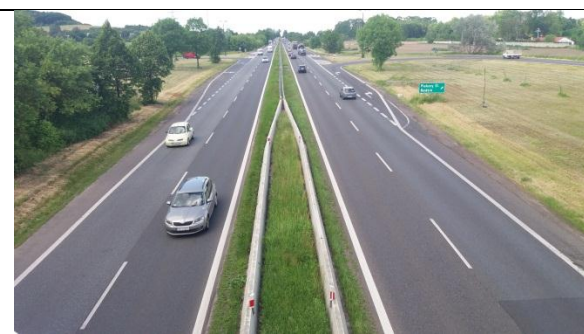
Rys 75 Droga krajowa nr 86 w rejonie wiaduktu z ul. Wolności w Będzinie.
