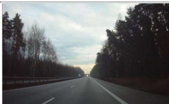
Rys 37 Droga ekspresowa S1 w rejonie km 561+200.
