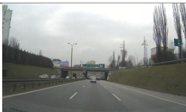
Rys 53 Droga ekspresowa S86 w rejonie wiaduktu z ul. Roweckiego w Sosnowcu.
