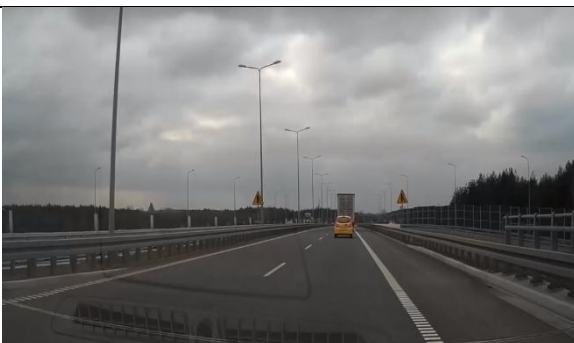
Rys 70 Droga ekspresowa S1b w rejonie węzła Pyrzowice – Lotnisko.
