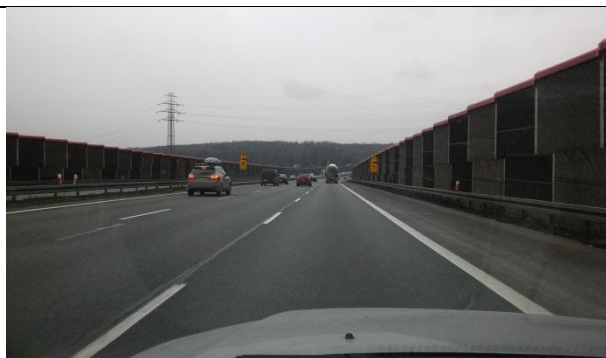
Rys 46 Autostrada A4 w rejonie km 329+300.
