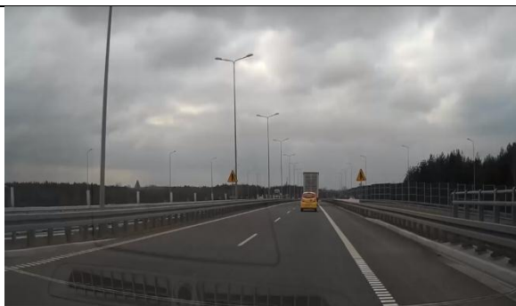
Rys 72 Droga ekspresowa S1b w rejonie węzła Pyrzowice – Lotnisko.
