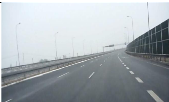
Rys 116 Autostrada A1c w rejonie węzła Zabrze Zachód.
