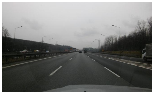
Rys 14 Autostrada A4 w rejonie węzła Chorzów.
