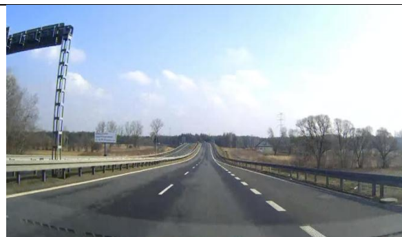
Rys 73 Droga krajowa nr 78b w rejonie km 2+800.
