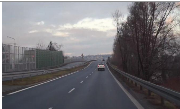
Rys 90 Droga krajowa nr 1 w rejonie km 486+000.
