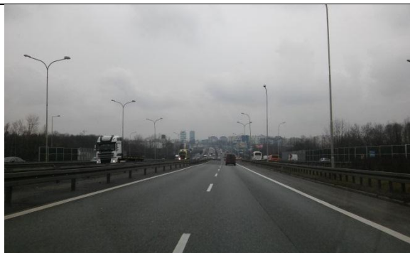
Rys 35 Autostrada A4 w rejonie węzła Katowice Murckowska.
