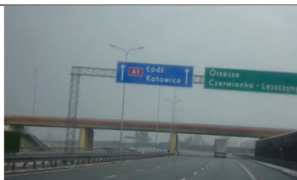
Rys 113 Autostrada A1a w rejonie węzła Dębiesko.
