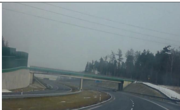
Rys 48 Autostrada A1a w rejonie przejazdu pod ul. Włociańską w km 25+500.
