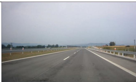
Rys 127 Droga ekspresowa S1f (dawna S69) w rejonie węzła Żywiec Soła.
