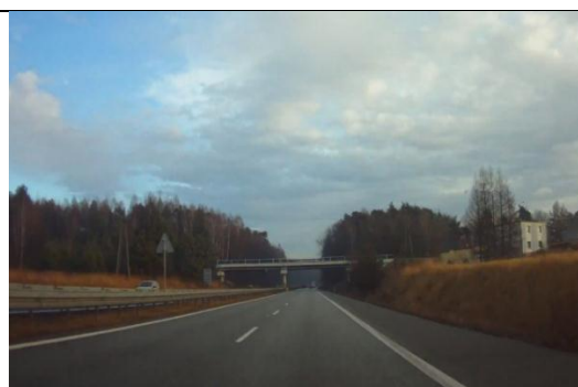
Rys 84 Droga ekspresowa S1 w rejonie wiaduktu z ul. Ratusz w km 557+900.
