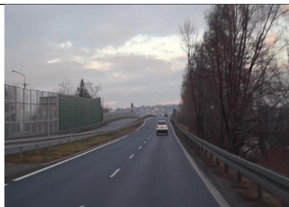
Rys 87 Droga krajowa nr 81 w miejscowości Skoczów.
