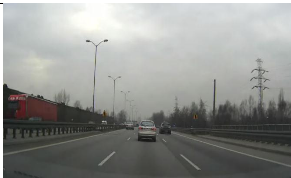
Rys 36 Droga ekspresowa S86 w rejonie węzła z ul. Hallera w Katowicach.
