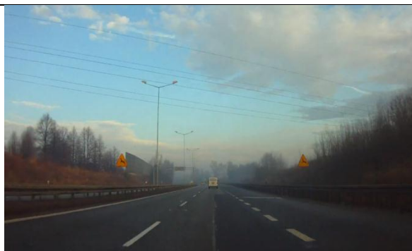
Rys 40 Droga ekspresowa S1 w rejonie węzła Mysłowice Brzezinka.
