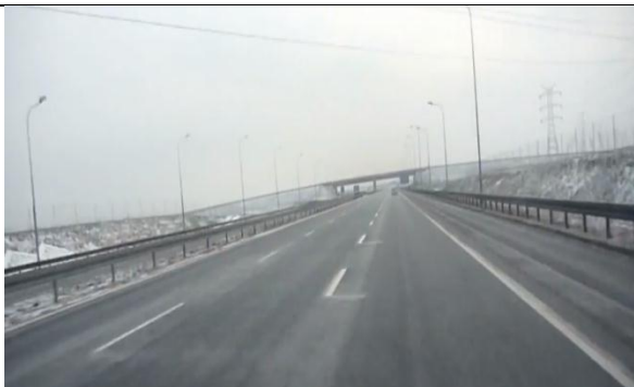
Rys 61 Autostrada A1c w rejonie węzła Zabrze Północ.
