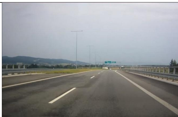
Rys 79 Droga ekspresowa S1f (dawna S69) w rejonie węzła Buczkowice.
