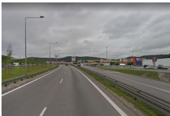
Fot. 43 Ciąg drogi S6 w Gdyni, zabudowa miejska
