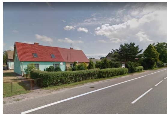
Fot. 28 Zabudowa jednorodzinna przy DK21, gm. Ustka
