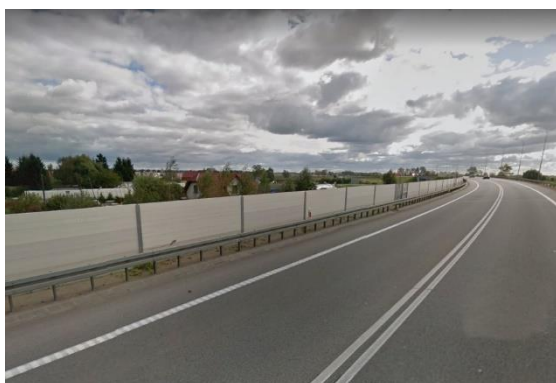
Fot. 23 Ciąg drogi DK7 na terenach podmiejskich Nowego Dworu Gdańskiego
