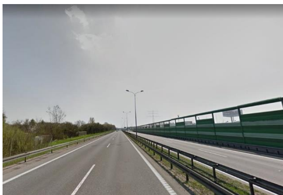
Fot. 41 Ciąg drogi S6 w Gdańsku
