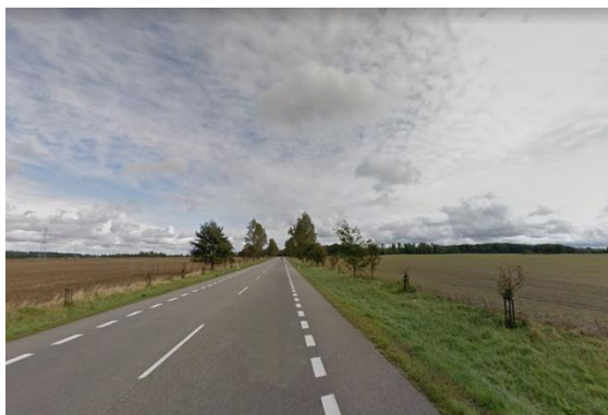
Fot. 25 Ciąg drogi DK6, gm. Damnica
