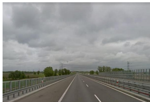
Fot. 42 Ciąg drogi S7 w Gdańsku
