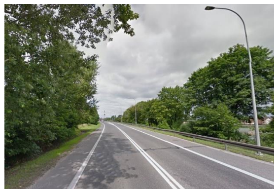
Fot. 34 Ciąg drogi DK91, tereny podmiejskie m. Tczew
