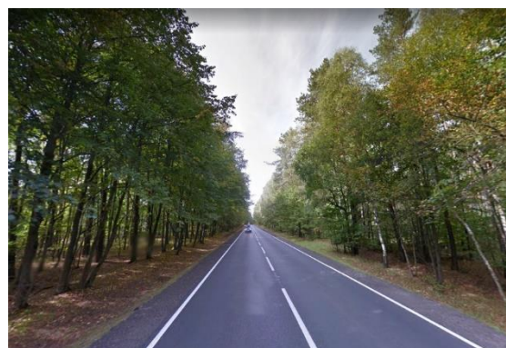
Fot. 14 Przebieg drogi DK20 gm. Kościerzyna
