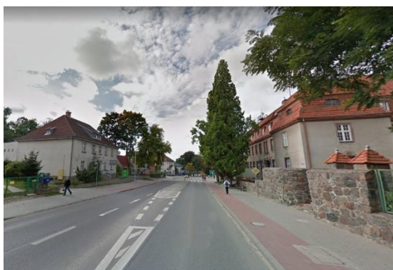
Fot. 1 Zabudowa miejska przy DK20, m. Bytów
