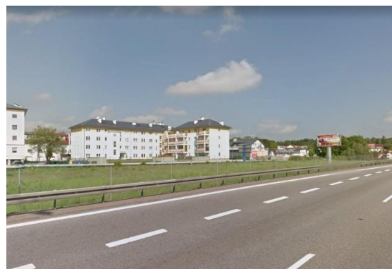
Fot. 44 Ciąg drogi S6 w Gdyni, zabudowa miejska
