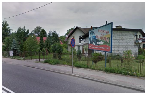
Fot. 39 Przebieg DK94 w m. Przeworsk
