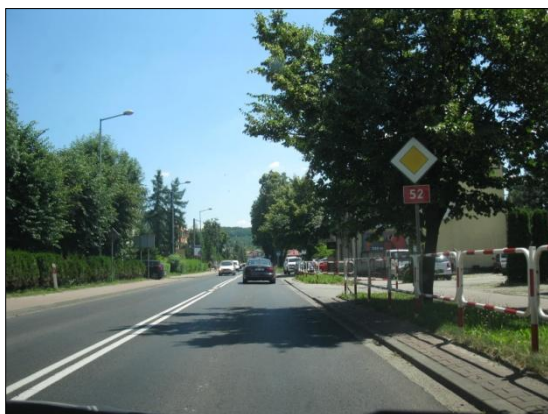
Fot. 2.37 Przykładowy widok na przekrój drogowy DK52 w powiecie wadowickim (Andrychów)
