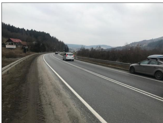
Fot. 2.21 Przykładowy widok na przekrój drogowy DK75 w powiecie nowosądeckim (Wielogłowy)
