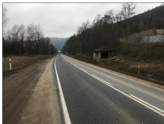
Fot. 2.22 Przykładowy widok na przekrój drogowy DK75 w powiecie nowosądeckim (Kurów)
