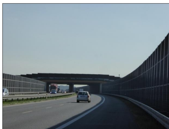
Fot. 2.4 Przykładowy widok na przekrój autostradowy A4 w powiecie brzeskim (okolice Szczepanowa)
