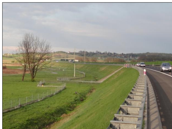
Fot. 2.31 Przykładowy widok na przekrój autostradowy A4 w Tarnowie (odcinek Tarnów Zachód – Tarnów Północ)
