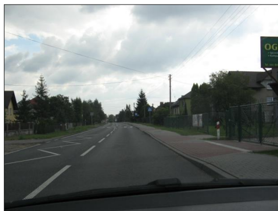
Fot. 2.28 Przykładowy widok na przekrój drogowy DK44 w powiecie oświęcimskim (Przeciszów)
