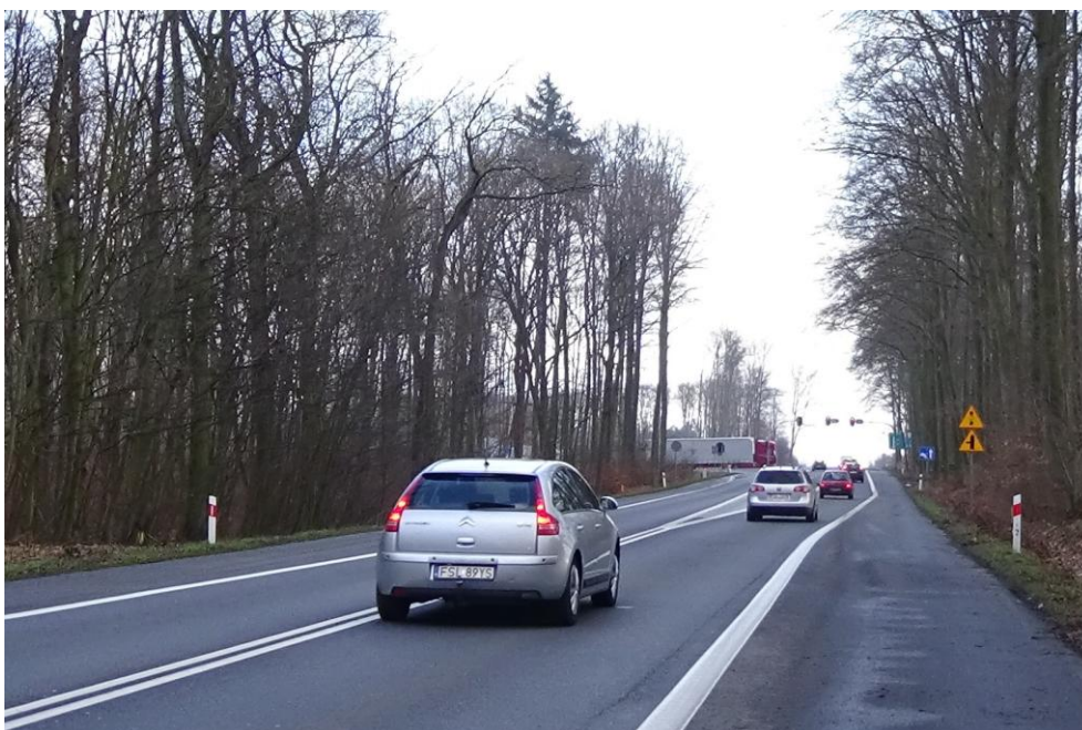
Fot. 6-54 Widok na drogę krajową DK 29 na odcinek 31509. W oddali widoczny węzeł drogowy z drogą krajową nr 2.
