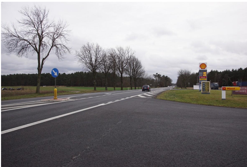
Fot. 6-31 Widok w kierunku południowym na odcinek 31406 drogi krajowej nr 3 (km 321+000). Droga zostanie docelowo odciążona po oddaniu do użytkowania będącego w realizacji odcinka drogi ekspresowej S3
