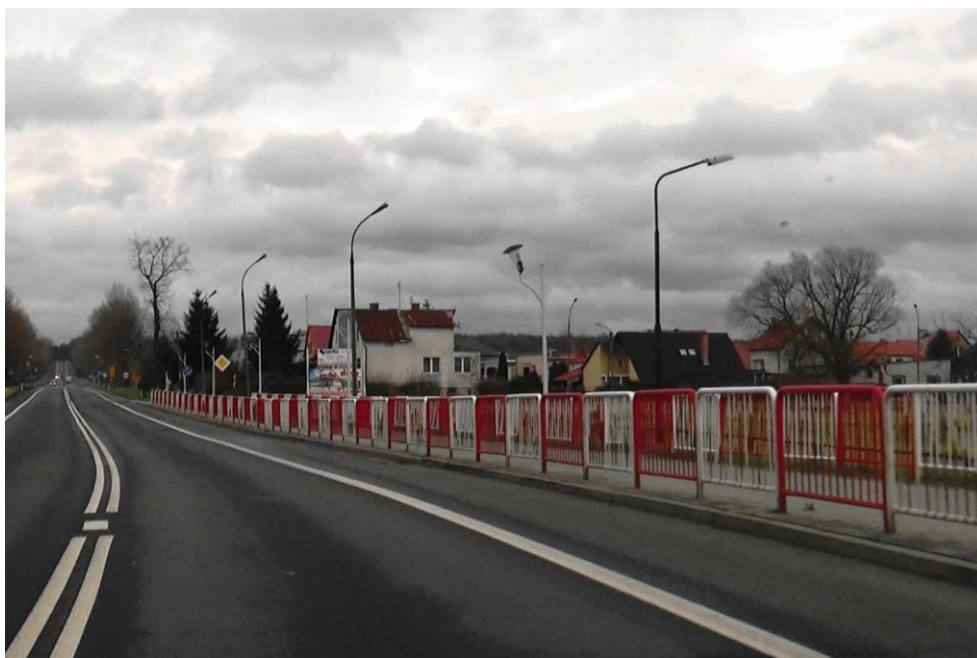
Fot. 6-32 Widok w kierunku południowym na odcinek 31406 drogi krajowej nr 3, przejazd przez m. Nowe Miasteczko (km 324+500). Droga zostanie docelowo odciążona po oddaniu do użytkowania będącego w realizacji odcinka drogi ekspresowej S3
