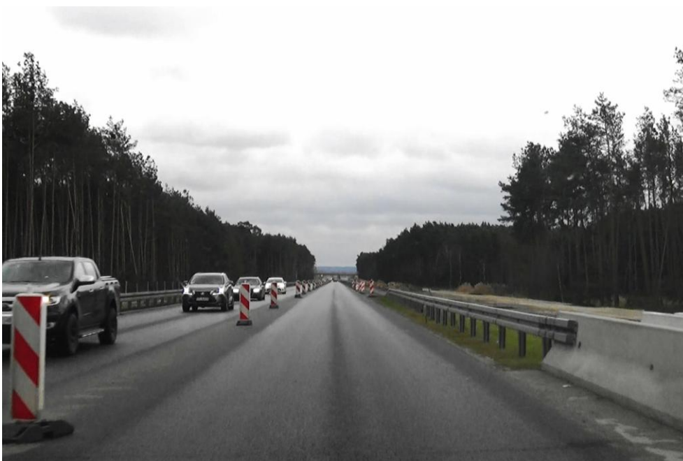
Fot. 6-30 Widok w kierunku południowym na odcinek 31405 drogi ekspresowej S3 (km 318+200). Droga w przebudowie.
