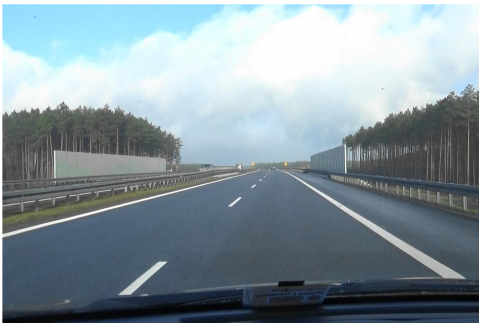
Fot. 6-16 Widok na ekrany akustyczne w ciągu odcinka 31116 drogi ekspresowej S3 (km 137+700)
