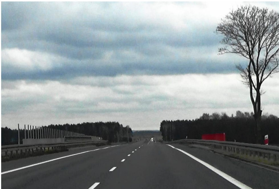
Fot. 6-27 Widok w kierunku południowym na początkowy fragment odcinka 31404 drogi ekspresowej S3 (km 300+500). Odcinek drogowy w przebudowie. Po lewej stronie w realizacji nowy ekran akustyczny.
