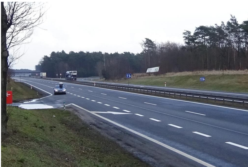
Fot. 6-47 Widok w kierunku wschodnim na odcinek 31501 drogi DK 2 (km 1+800)
