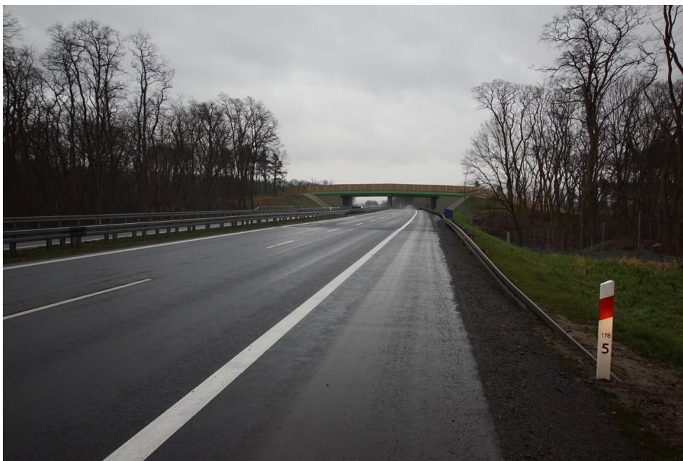
Fot. 6-23 Widok na przejście dla zwierząt w ciągu drogi ekspresowej S3 w km 178+600
