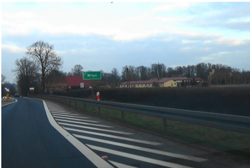
Fot. 6-60 Droga krajowa DK 92. Wjazd do miejscowości Wityn od strony zachodniej.
