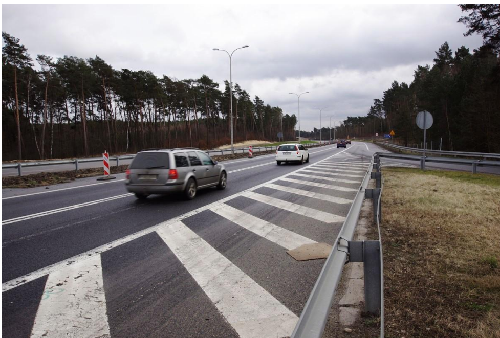
Fot. 6-26 Widok w kierunku południowym na początkowy fragment odcinka 31403 drogi ekspresowej S3 po południowej stronie m. Zielona Góra (km 293+600). Odcinek drogowy w przebudowie.
