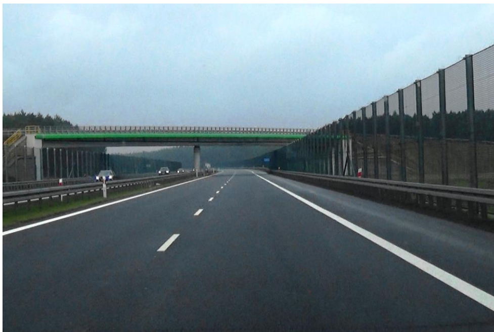
Fot. 6-11 Widok na wiadukt nad drogą ekspresową S3 na odcinku 31114 (km 113+500). W otoczeniu odcinka, brak terenów eksponowanych bezpośrednio na hałas drogowy.
