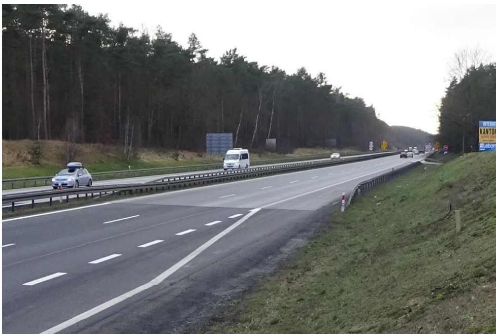
Fot. 6-48 Widok w kierunku zachodnim na odcinek 31501 drogi DK 2 (km 1+800)
