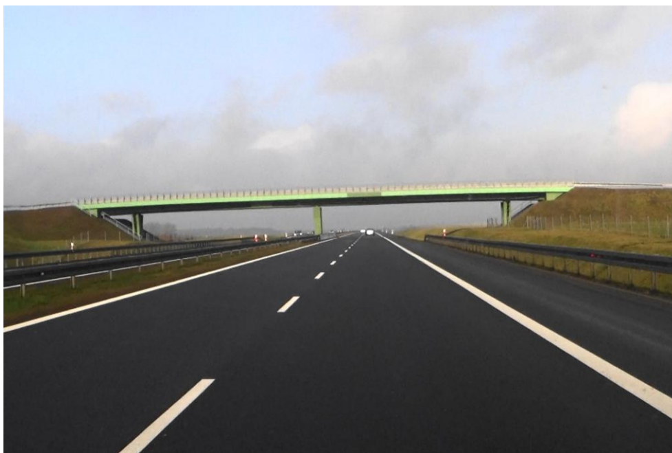
Fot. 6-15 Widok na most znajdujący się w km 141+700 odcinka 31116 drogi ekspresowej S3.
