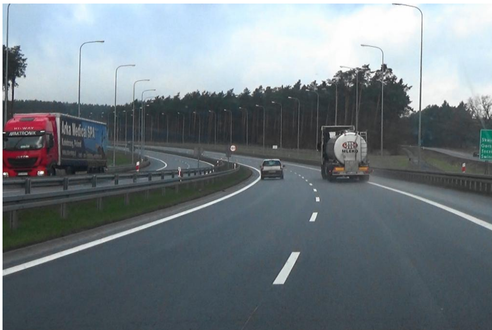
Fot. 6-13 Widok na początek odcinka 31115 drogi ekspresowej S3 za węzłem drogowym w m. Międzyrzecz (km 130+500)
