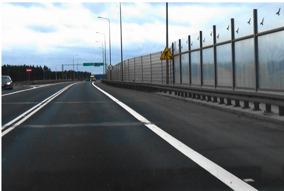
Fot. 6-28 Widok w kierunku południowym na odcinek 31404 drogi ekspresowej S3 (km 308+100). Po prawej ekran akustyczny chroniący zabudowę mieszkaniową Lubiszowa. Odcinek drogowy w przebudowie.
