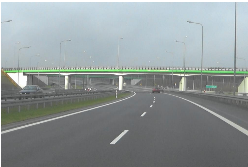
Fot. 6-14 Widok na koniec odcinka nr 31115 drogi ekspresowej S3 (km 117+700)
