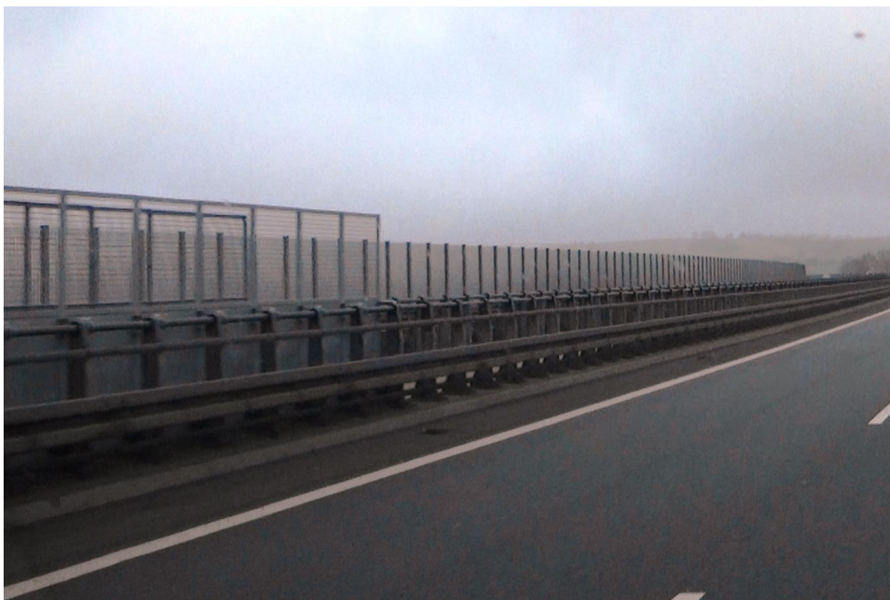
Fot. 6-43 Widok na ekrany akustyczne na odcinku 31417 (S3) na chroniące przed hałasem zabudowę mieszkaniową m. Świebodzin.
