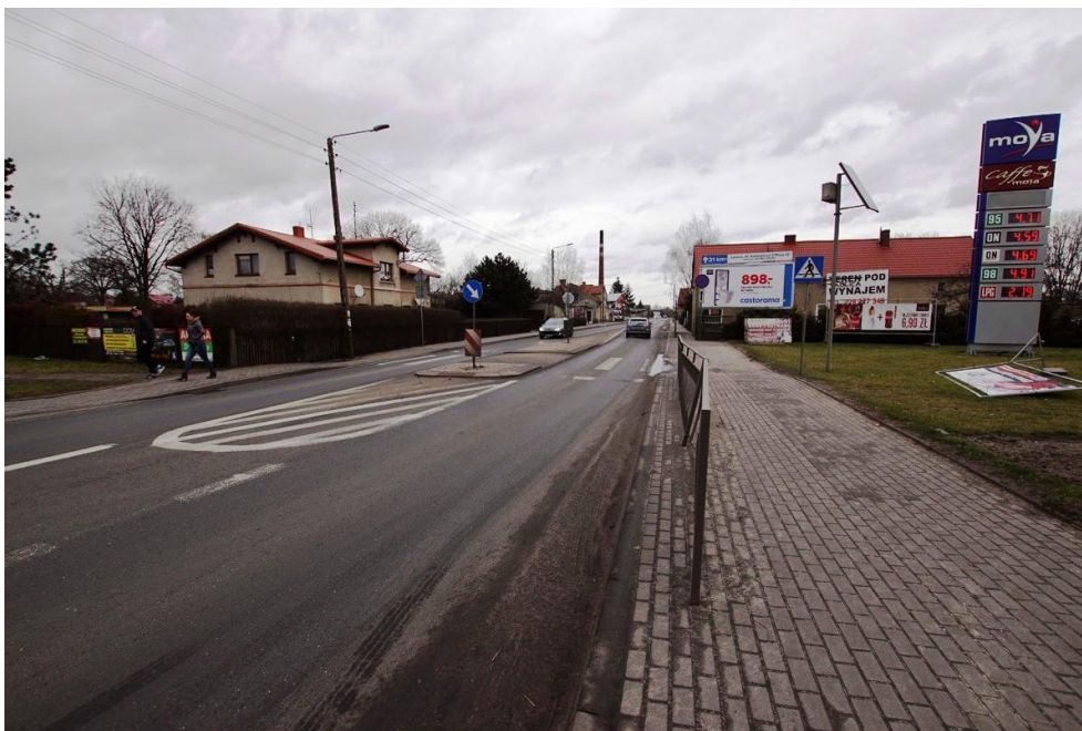
Fot. 6-2 Widok na początkowy odcinek drogi krajowej nr 12 w m. Wschowa (Przejście 1, km 147+600)
