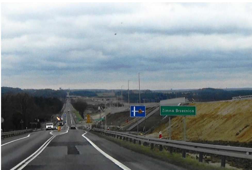
Fot. 6-34 Widok w kierunku południowym na odcinek 31407 w miejscowości Zimna Brzeznica. Droga zostanie docelowo odciążona po oddaniu do użytkowania będącego w realizacji (widocznego po prawej stronie) odcinka drogi ekspresowej S3.
