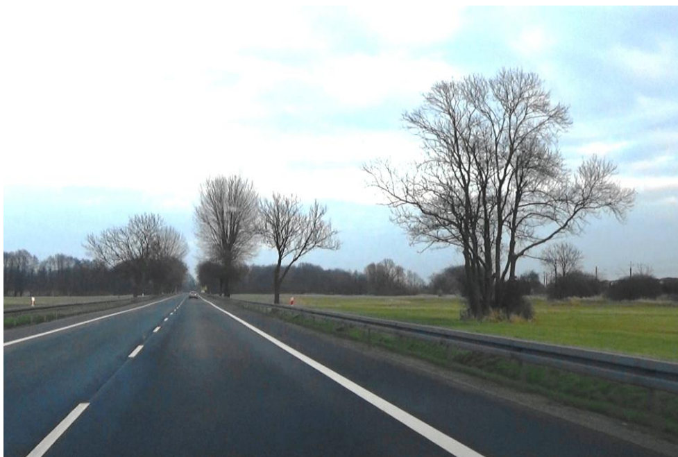
Fot. 6-59 Droga krajowa DK 92 na początkowym odcinku obwodnicy Świebodzina.
