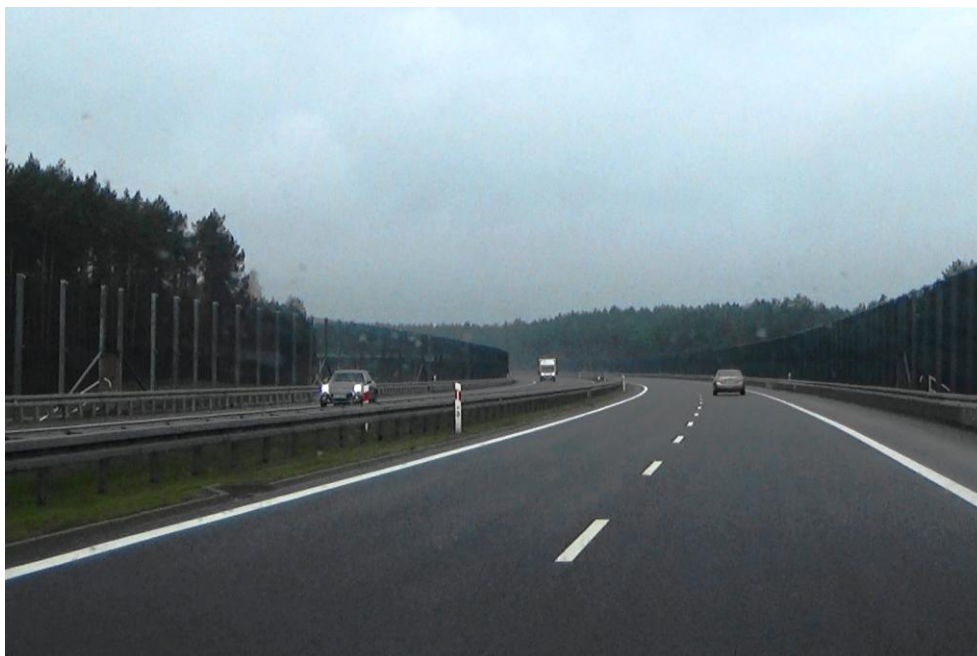
Fot. 6-12 Widok na drogę ekspresową S3 na odcinku 31114 (km 113+000). W otoczeniu odcinka, brak terenów eksponowanych bezpośrednio na hałas drogowy. W otoczeniu znajdują się głównie lasy oraz tereny z niską roślinnością.
