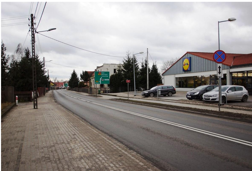
Fot. 6-3 Widok na początkowy odcinek drogi krajowej nr 12 w m. Wschowa (Przejście 2, km 148+300)
