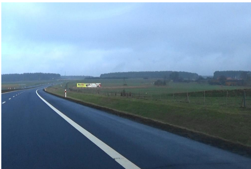
Fot. 6-42 Droga S3 na odcinku 31416 przebiega głównie z dala od terenów wymagających ochrony przed hałasem. Zdjęcie wykonane w km 148+300.
