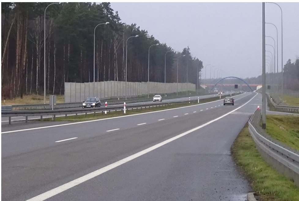
Fot. 6-7 Widok na ekran akustyczny znajdujący się w km 76+600, w ciągu drogi ekspresowej S3, na odcinku nr 31112
