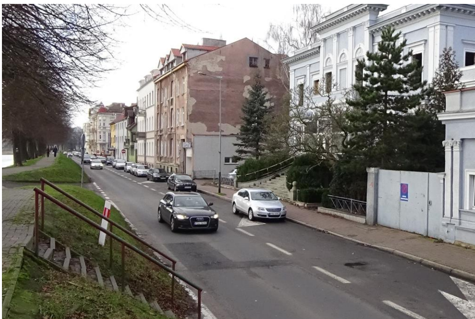
Fot. 6-51 Widok na drogę krajową nr 29 na terenie miasta Słubice. Na tym odcinku droga posiada dwie jezdnie oddzielone zabudową mieszkaniową. Na zdjęciu jezdnie prowadząca ruch na kierunku wschodnim.
