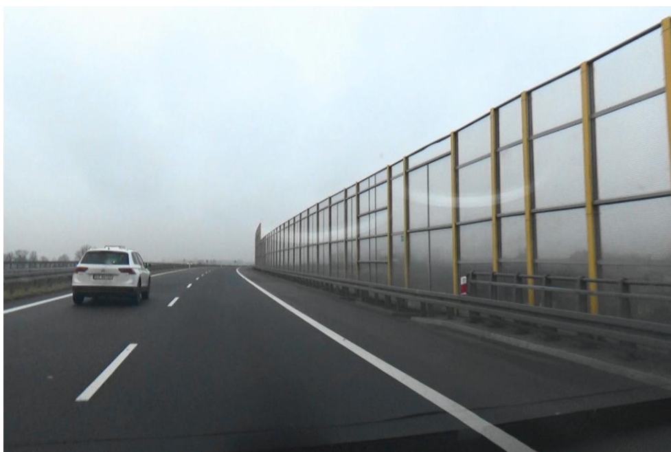
Fot. 6-10 Widok w stronę północną na trasę ekspresową S3 na wysokości miejscowości Deszczno. Ekran akustyczny ogranicza emisję hałasu komunikacyjnego w stronę zabudowy mieszkaniowej deszczna.
