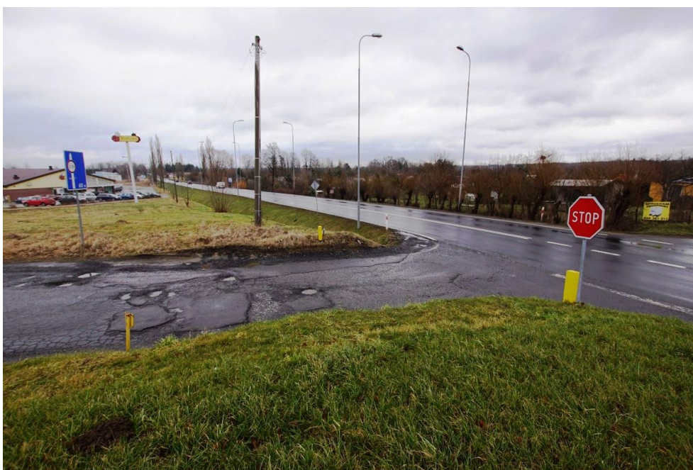
Fot. 6-40 Widok na końcowy, południowy fragment odcinka 31413 (DK 27) w Nowogrodzie Bobrzańskim (km 41+421). W otoczeniu tego fragmentu odcinka drogowego, występują znaczne ilości terenów przewidzianych pod funkcje użytkowe chronione przed hałasem.
