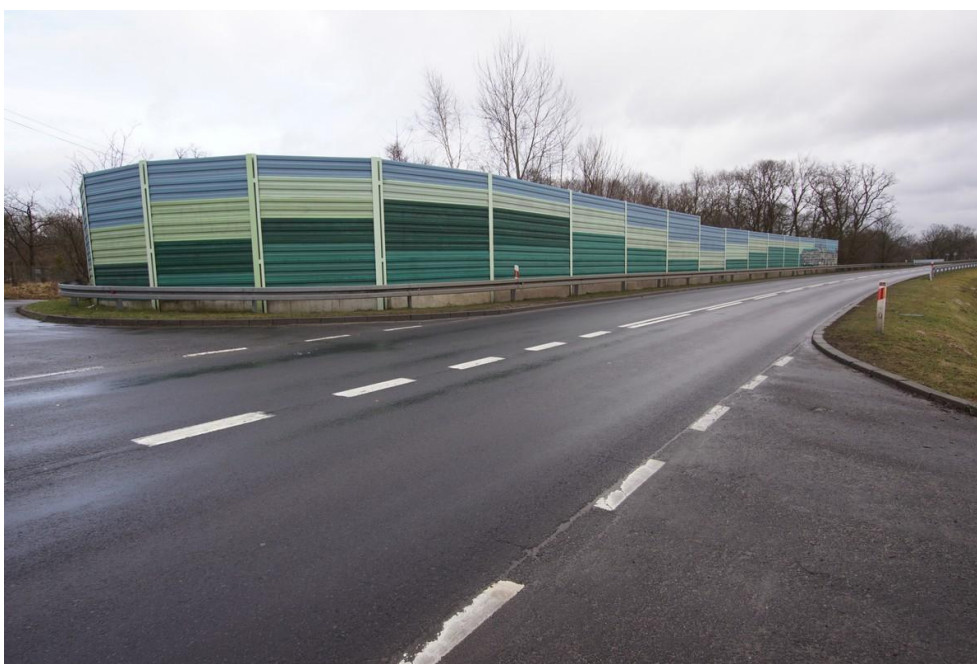
Fot. 6-66 Widok na ekran akustyczny w środkowej części odcinka nr 31720 obwodnicy miasta Żagania, chroniący przed hałasem komunikacyjnym zabudowę mieszkaniową jednorodzinną (km 0+900).
