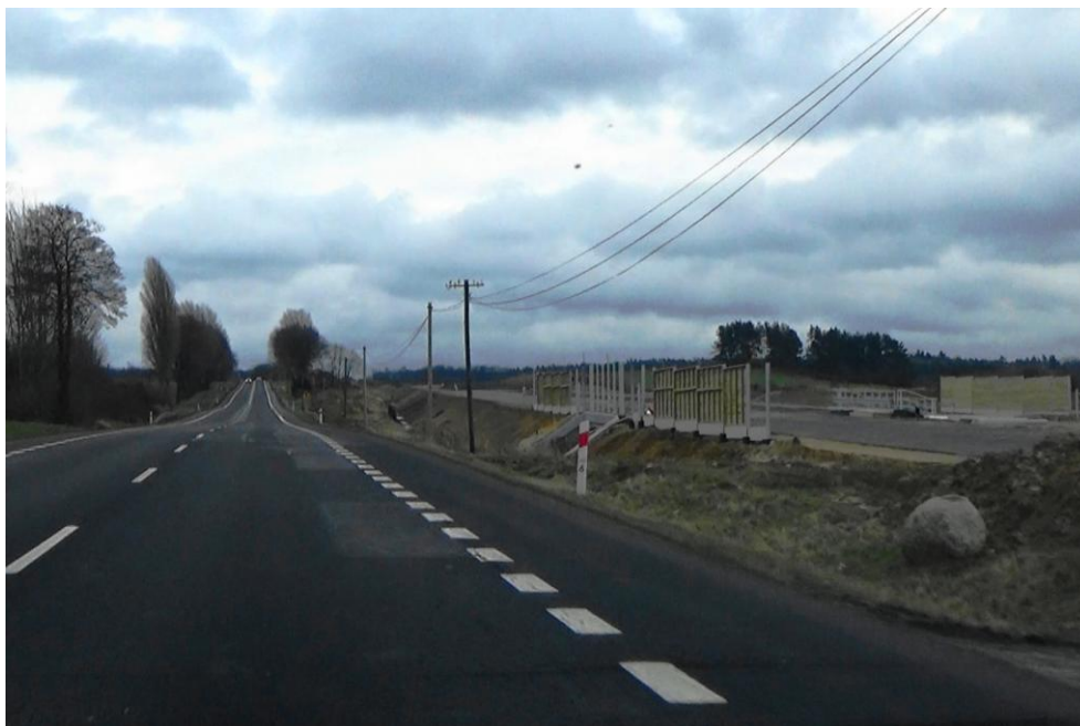
Fot. 6-33 Widok w kierunku południowym na odcinek 31407 drogi krajowej nr 3. Droga zostanie docelowo odciążona po oddaniu do użytkowania będącego w realizacji (widocznego po prawej stronie) odcinka drogi ekspresowej S3.
