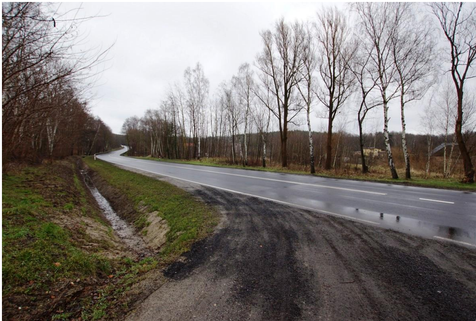
Fot. 6-37 Widok na środkowy fragment odcinka 31411 drogi krajowej nr 27 w (km 56+700). W otoczeniu tego fragmentu odcinka występuje las, brak zabudowy wymagającej ochrony przed hałasem.
