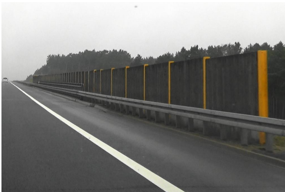
Fot. 6-9 Widok w stronę północną, na ekran akustyczny w kilometrze 109+000. Odcinek 31113 drogi ekspresowej S3.
