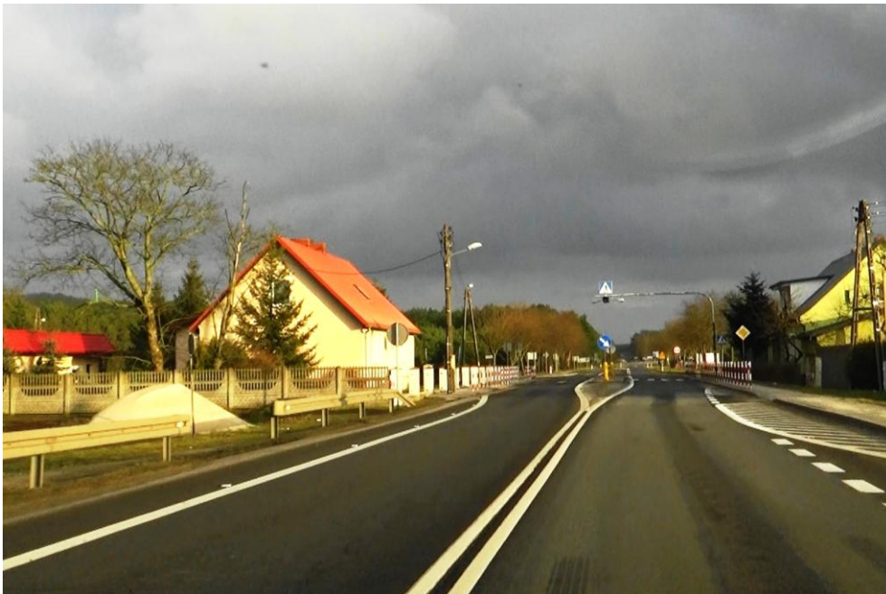
Fot. 6-61 Droga krajowa DK 92 na odcinku miejscowości Pożrzadło (31611). Widok w kierunku wschodnim na zabudowę mieszkaniową znajdującą się w otoczeniu drogi.
