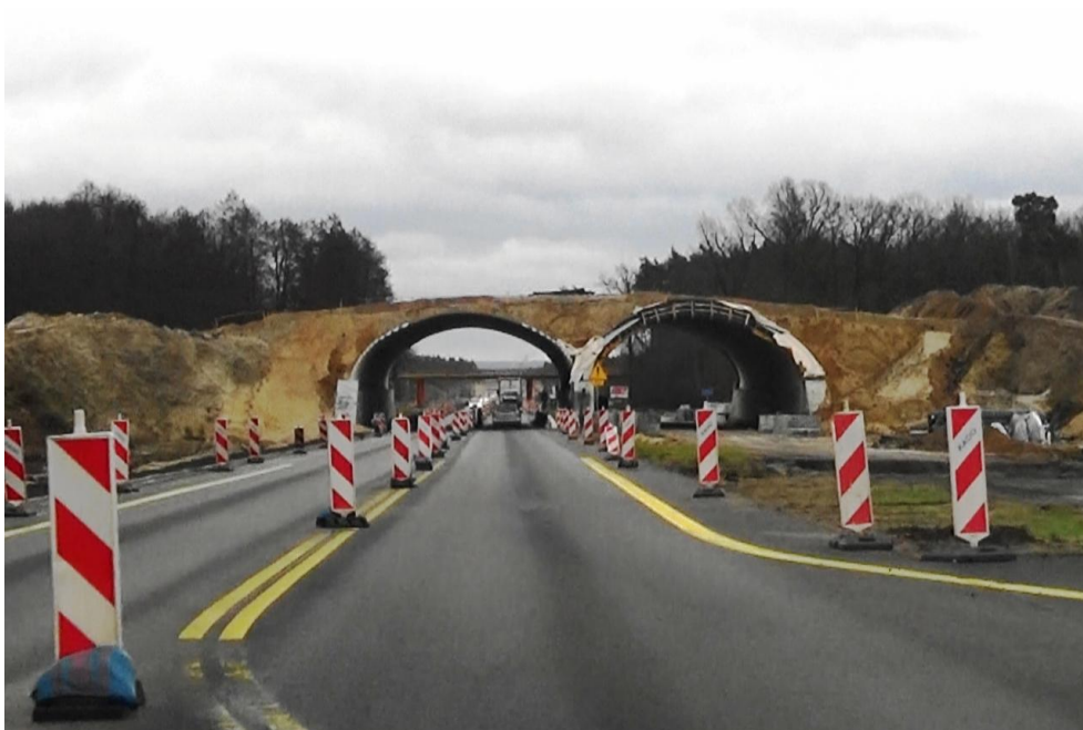
Fot. 6-29 Widok w kierunku południowym na odcinek 31405 drogi ekspresowej S3 (km 316+500). Przejście dla zwierząt w realizacji. Odcinek drogowy w przebudowie.
