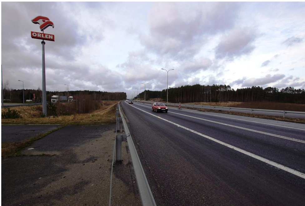
Fot. 6-25 Widok w kierunku północnym na początkowy fragment odcinka 31403 drogi ekspresowej S3 po południowej stronie m. Zielona Góra (km 293+600). Odcinek drogowy w przebudowie.
