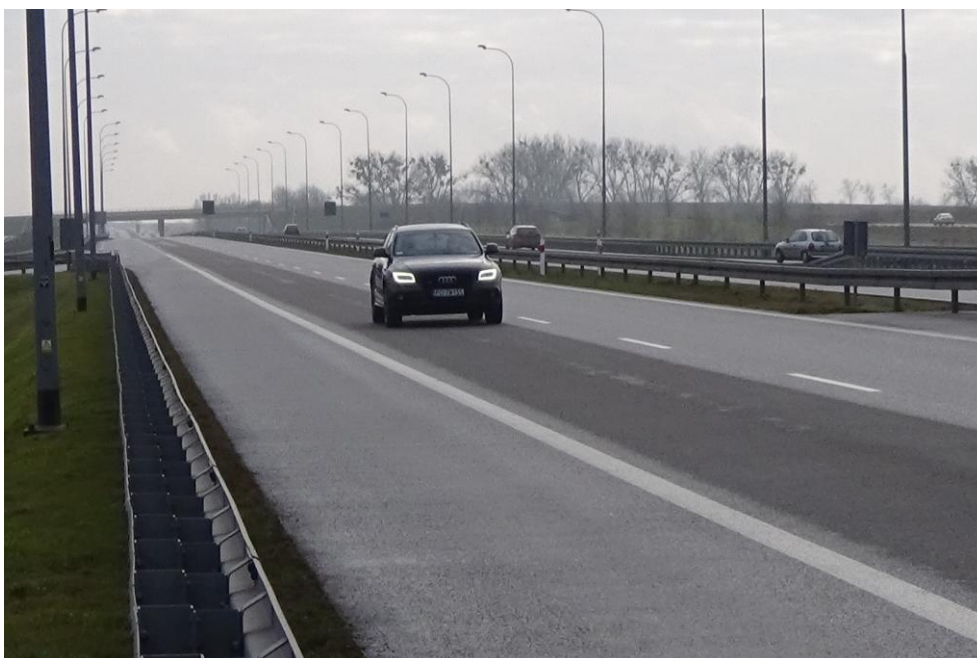
Fot. 6-8 Droga ekspresowa S3 na odcinku 31112 w kilometrze 76+000. Widok w stronę południową.
