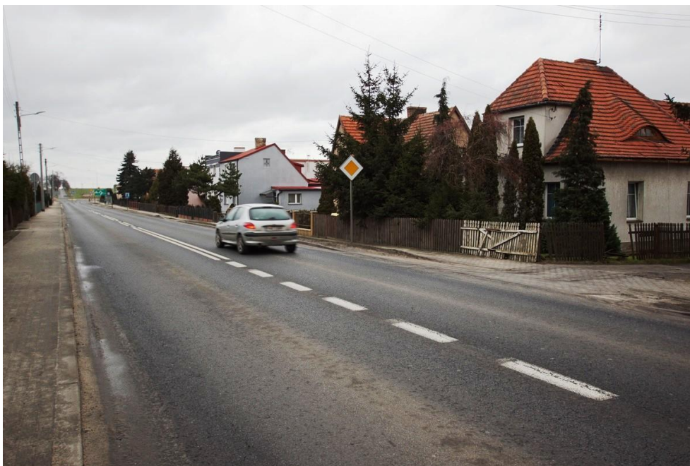
Fot. 6-4 Widok na końcowy odcinek drogi krajowej nr 12 w m. Wschowa (Przejście 2, km 148+900)
