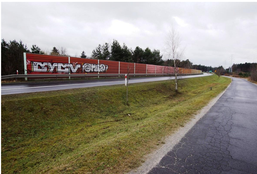
Fot. 6-65 Widok na ekran akustyczny na początku odcinka nr 31720 obwodnicy miasta Żagania, chroniący przed hałasem komunikacyjnym zabudowę mieszkaniową jednorodzinną (km 0+300).
