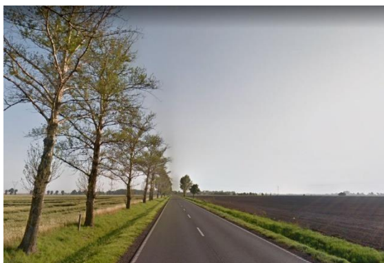
Fot. 19 Ciąg DK15, obwodnica Inowrocławia, gm. Strzelno
