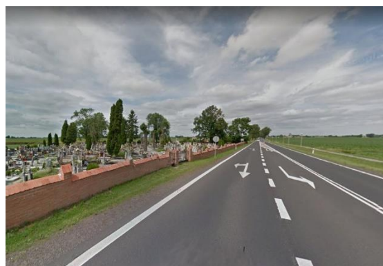
Fot. 12 Ciąg drogi DK 15 w gm. Kowalewo Pomorskie
