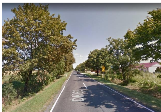
Fot. 24 DK62 na obrzeżach m. Radziejów
