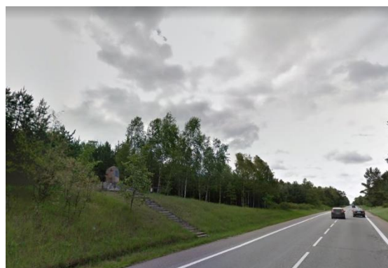
Fot. 38 DK91, ciąg drogi w gm. Włocławek
