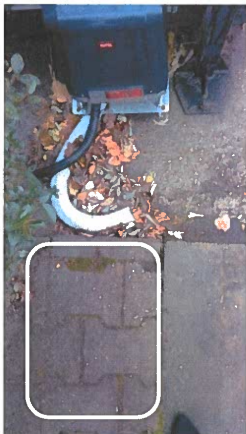
Zdjęcie nr 2. Miejsce montażu fundamentu podstawy.
