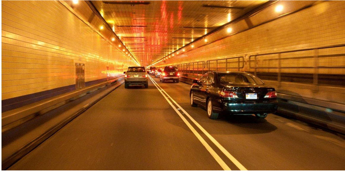
USA – tunel pod rz. Hudson, naw. asfaltowa
