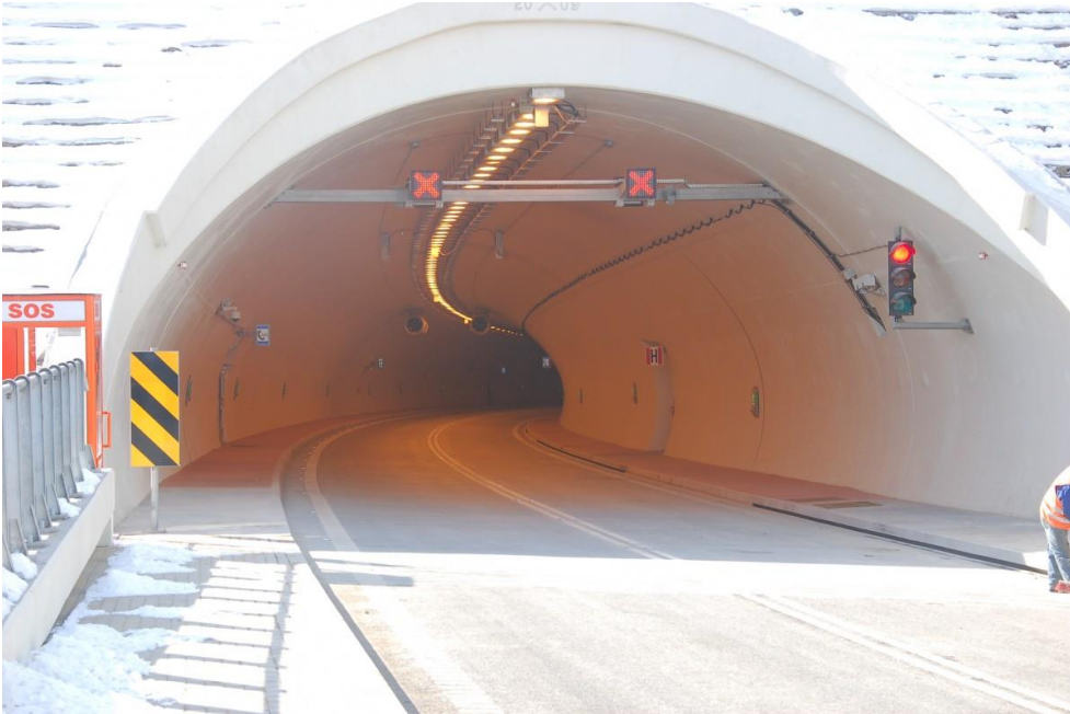
Naw. betonowa – tunel w m. Laliki na drodze S1
