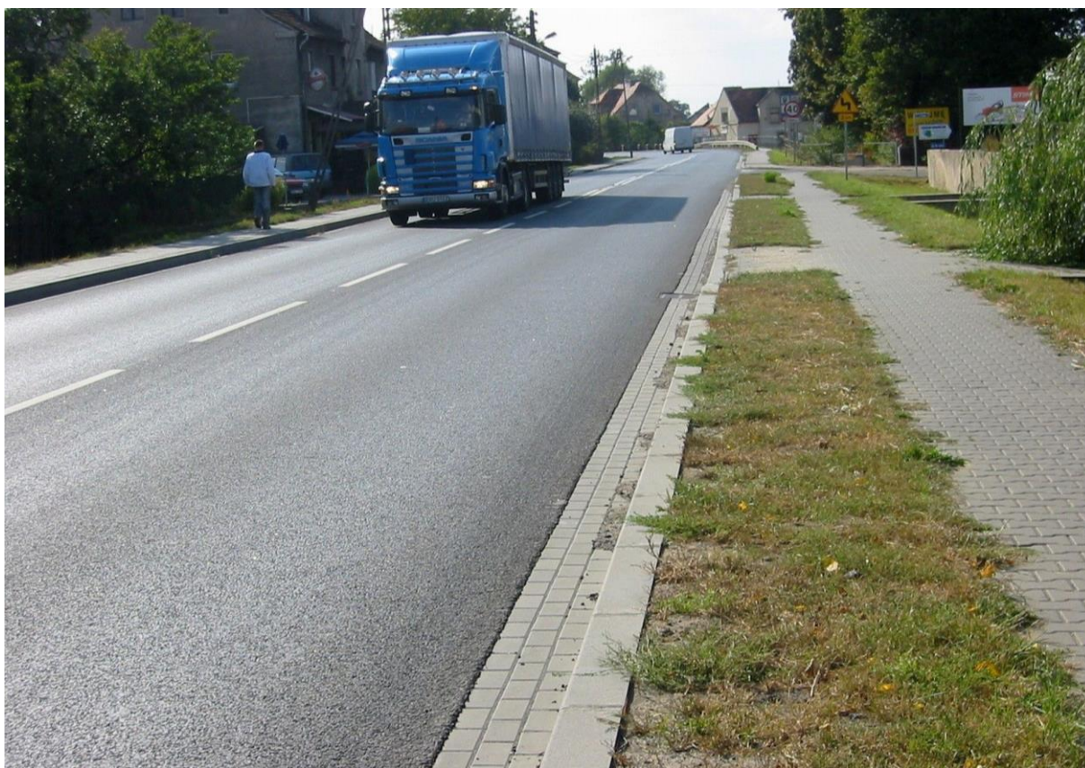
Rys. 7.3. Brak pobocza nieutwardzonego — przykład przekroju ulicznego (w formularzu wpisujemy w kolumnie nr 3 kod „u” oraz w kolumnie nr 15 (ocena) kod 6)
