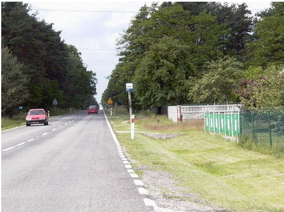
Rys. 4.28. Odwodnienie — stan zły (niedrożny rów odwadniający — zjazd bez przepustu na prywatną posesję)
