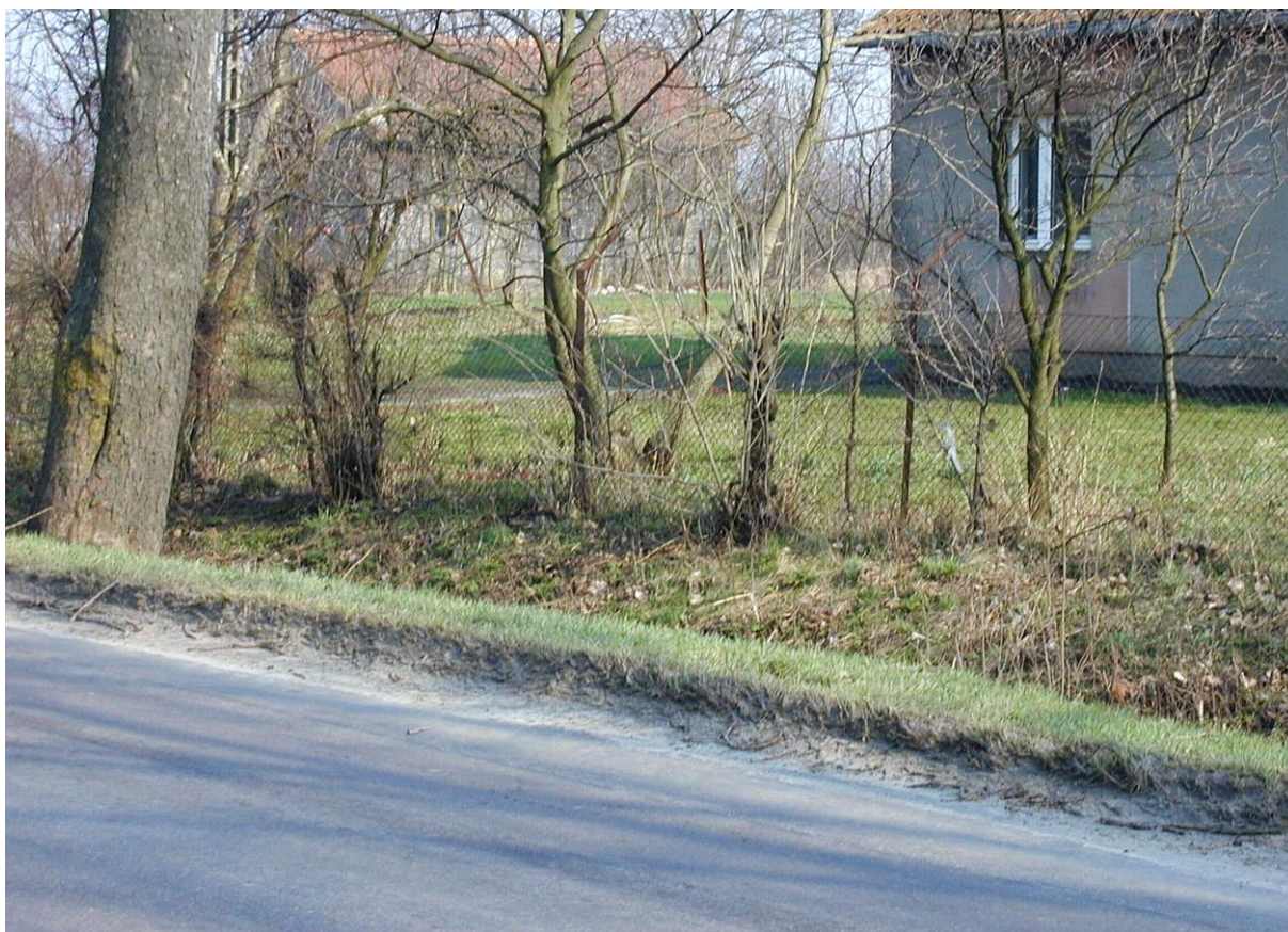
Rys. 5.20. Pobocze — stan zły (zawyżone; sięgające ponad 20 cm nad poziom jezdni)
