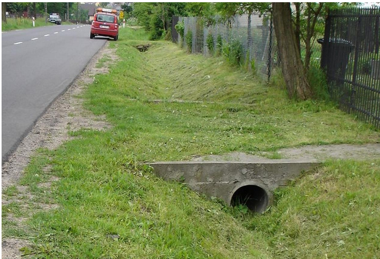
Rys. 4.14. Odwodnienie — stan zadowalający (przepust nieznacznie zamulony)
