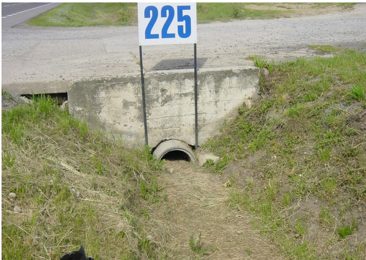
Rys. 4.27. Odwodnienie — stan zły (zamulony rów, przepust zasypany w ponad połowie przekroju)
