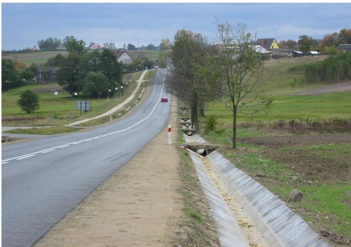
Rys. 4.6. Odwodnienie — stan dobry (odnowiony ciąg systemu odwodnienia; drożne przepusty na wszystkich zjazdach)
