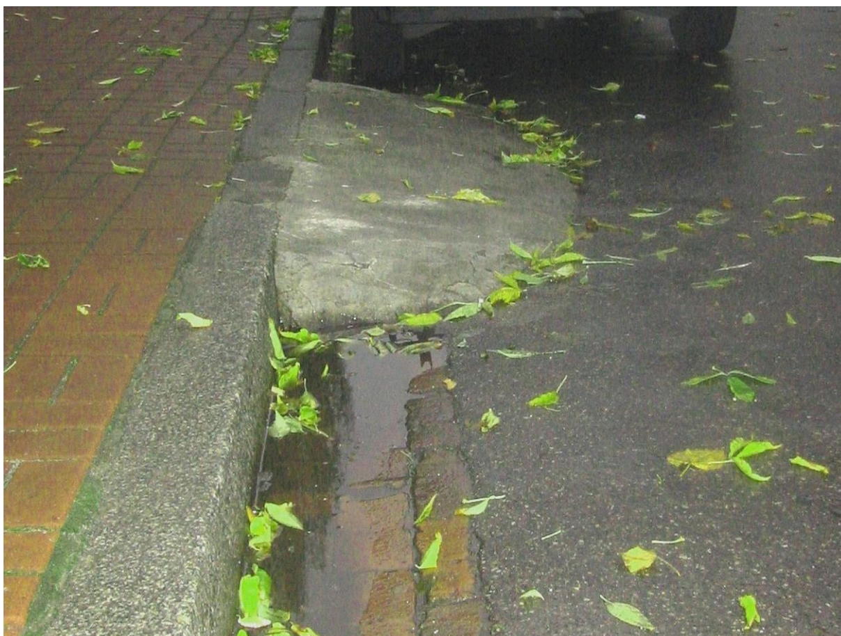
Rys. 4.39. Odwodnienie — stan zły (nielegalny zjazd uniemożliwiający odprowadzenie wody rynną przykrawężnikową)
