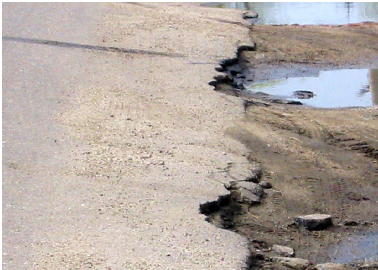
Rys. 5.16. Pobocze — stan zły (uskok; o znacznej wysokości z widocznymi skutkami jego wpływu na nawierzchnię w postaci licznych uszkodzeń krawędzi jezdni)
