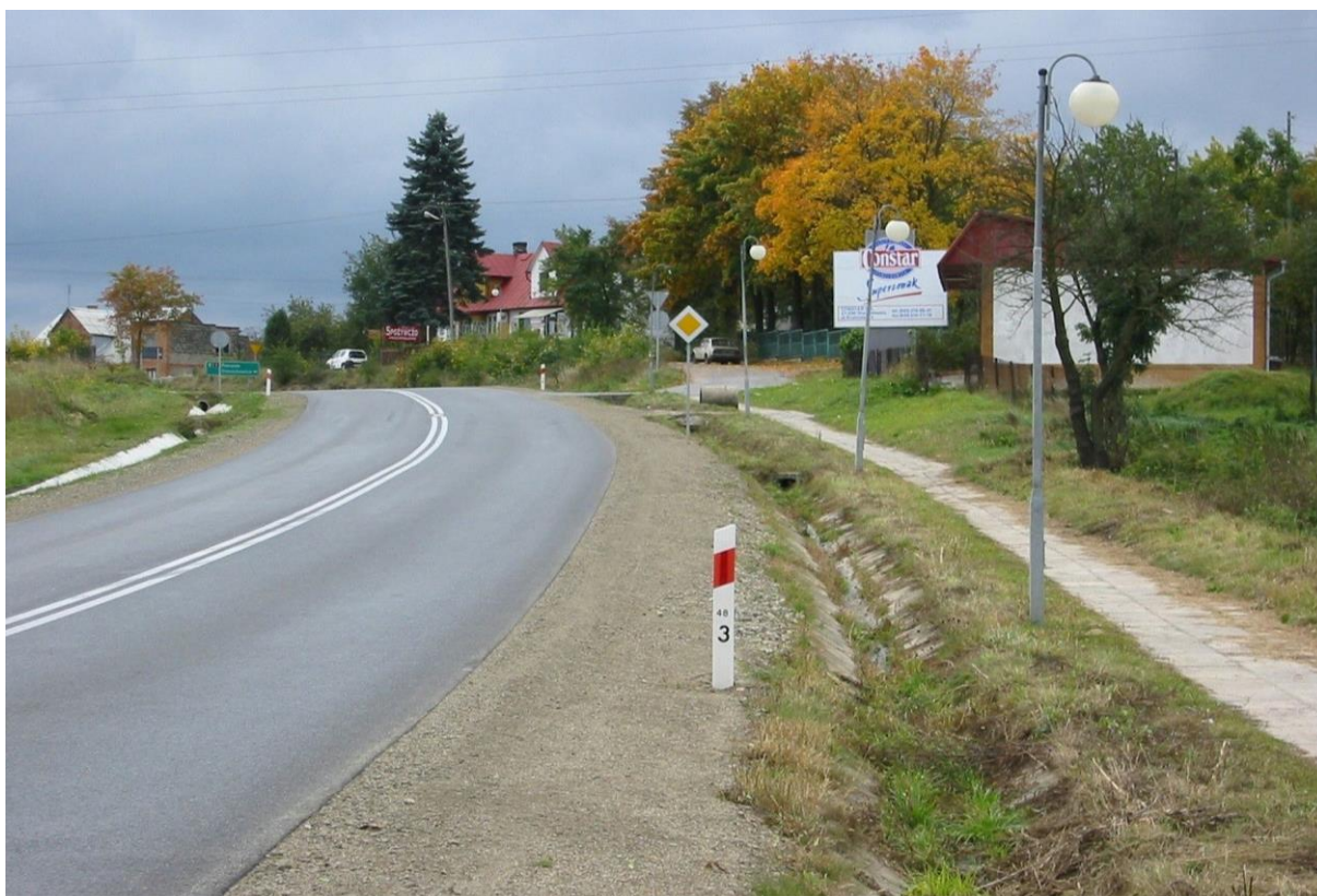
Rys.4.17. Odwodnienie — stan niezadowalający (rów zamulony i zarośnięty kępami roślinności pomiędzy elementami betonowymi)
