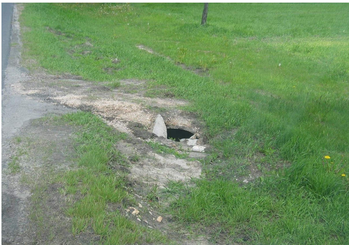
Rys. 4.26. Odwodnienie — stan zły (zarwany przepust pod zjazdem z drogi)
