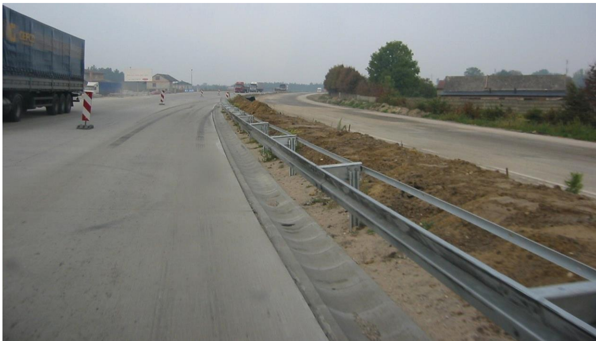
Rys. 4.1. Odwodnienie — stan dobry (rynny odprowadzające na wyremontowanym odcinku drogi o nawierzchni betonowej)
