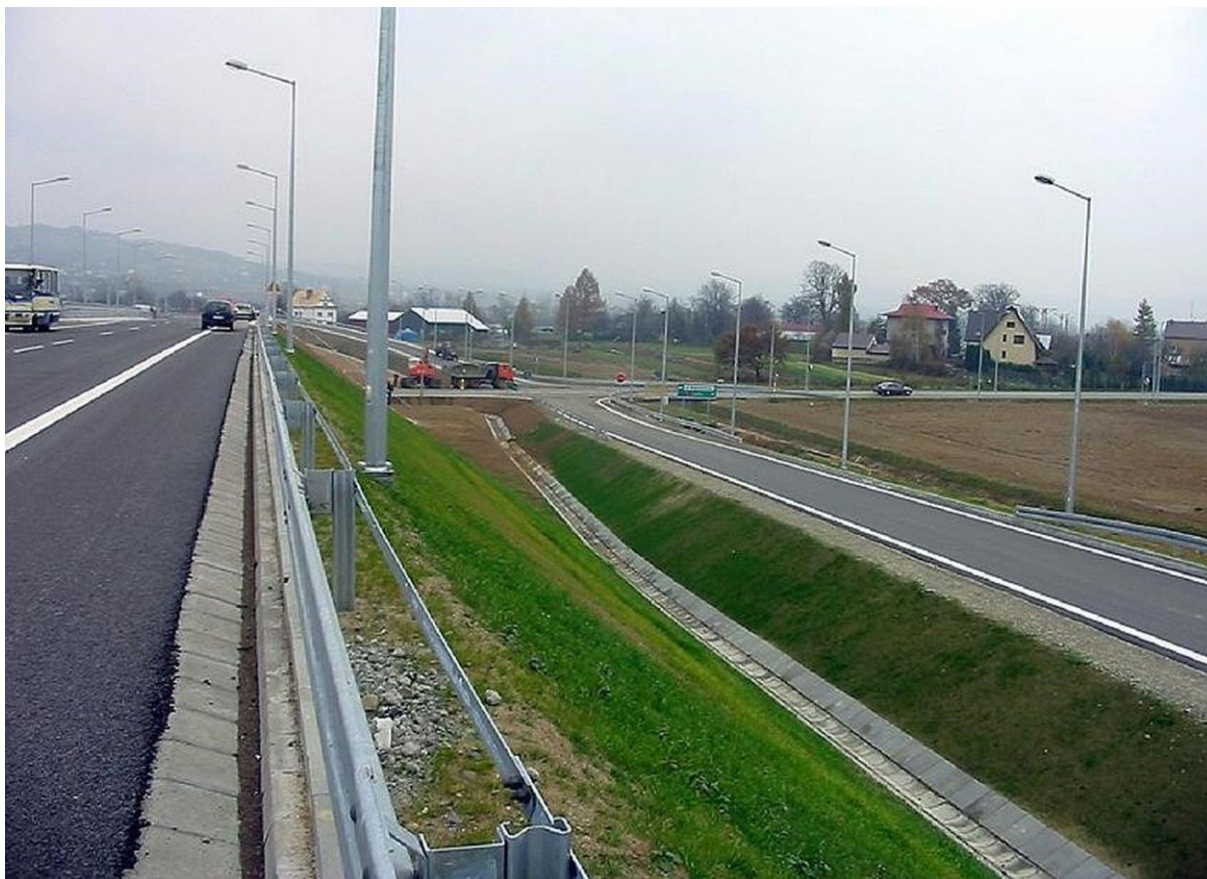
Rys. 6.5. Równoległe elementy odwodnienia — rynna oraz rów w stanie dobrym
