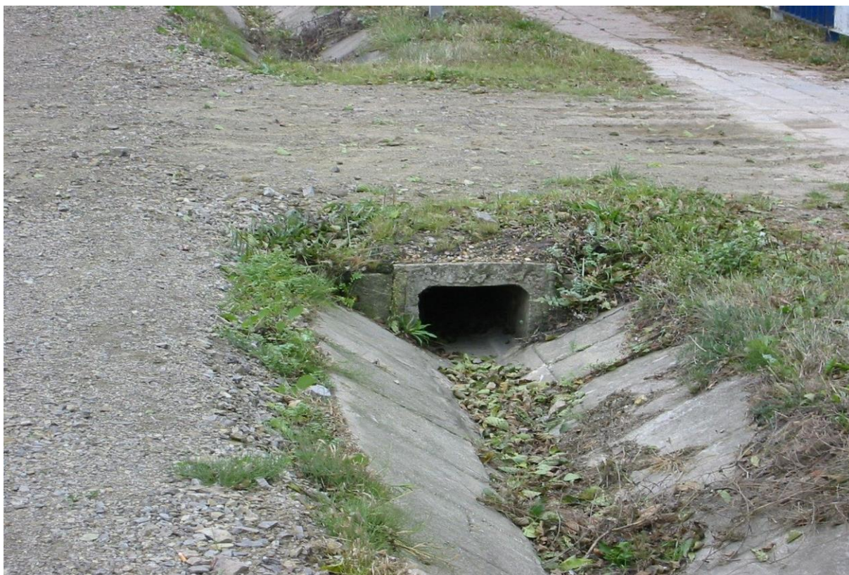
Rys. 4.9. Odwodnienie — stanie zadowalający (przepust w pełni drożny (bez zanieczyszczeń); rów z prefabrykatów betonowych nieznacznie zamulony, z porastającą roślinnością)
