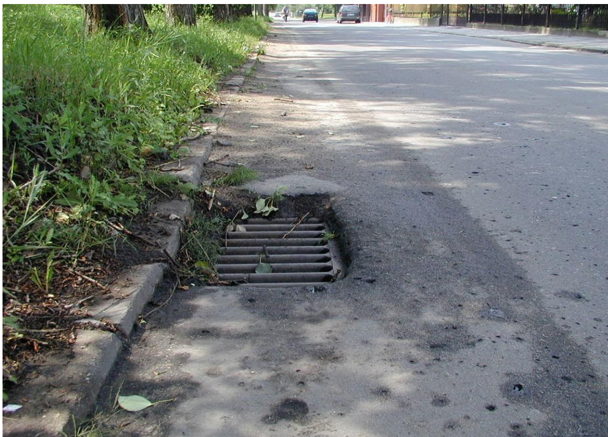
Rys. 4.35. Odwodnienie — stan zadowalający (pomimo obniżenia poziomu kratki studzienki kanalizacyjnej względem nawierzchni jezdni, odwodnienie jest drożne, w formularzu należy wpisać dodatkowy komentarz)
