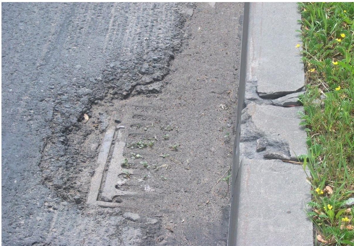
Rys. 4.37. Odwodnienie — stan zły (całkowicie zasypana studzienka łącznie z kratką; brak możliwości odprowadzania wody)
