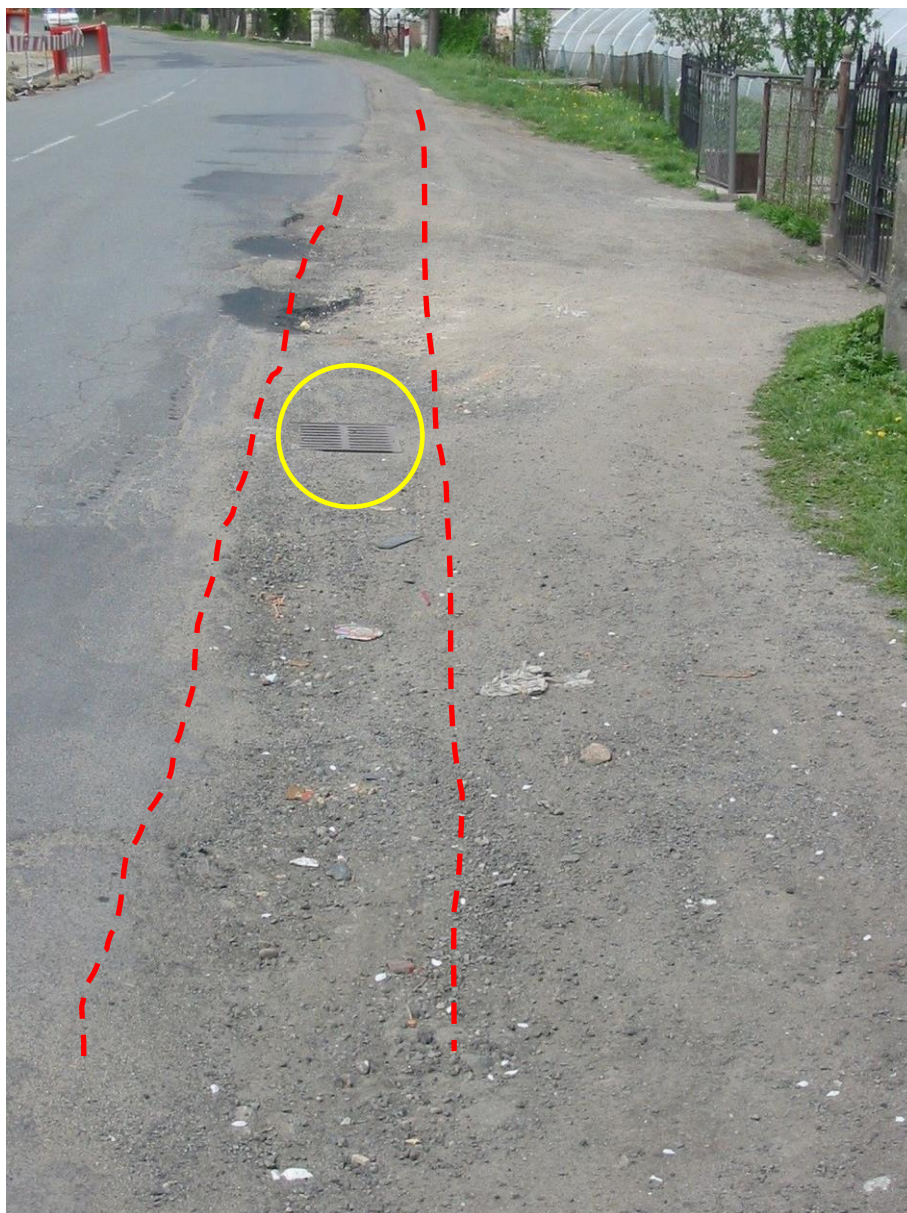
Rys. 4.31. Odwodnienie — stan zły (brak elementów doprowadzających wody opadowe do wpustu studzienki kanalizacyjnej)
