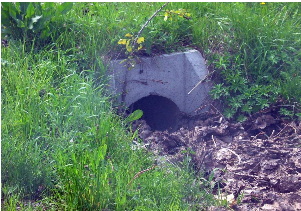
Rys. 4.24. Odwodnienie — stan zły (przepust zamulony powyżej 30% wysokości przekroju)
