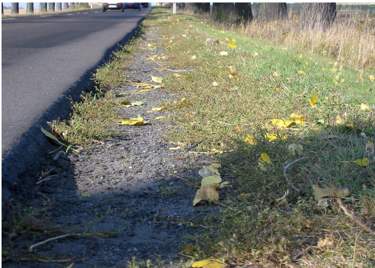
Rys. 5.15. Pobocze — stan zły (uskok; przekraczający 15 cm)
