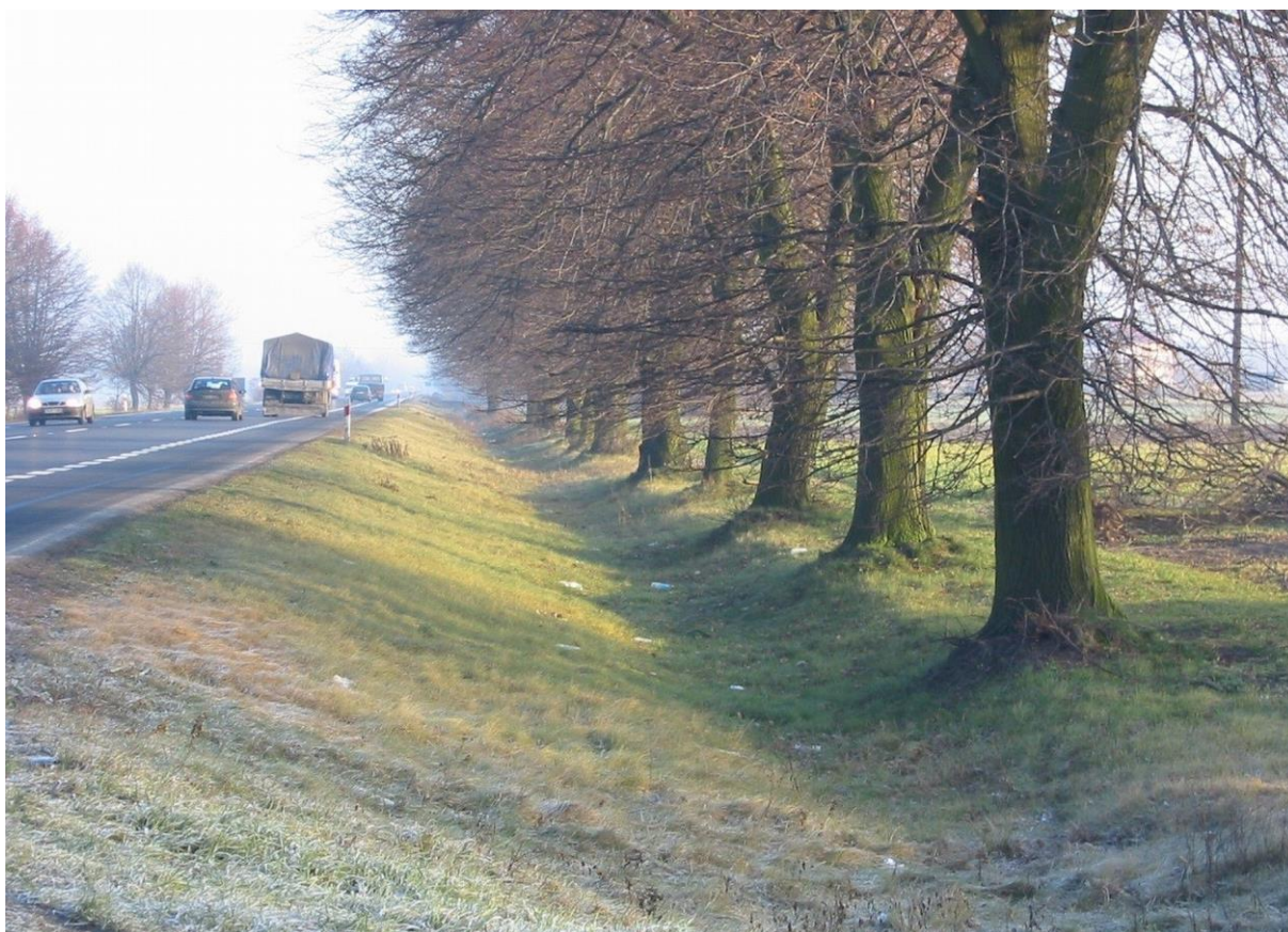
Rys. 4.8. Odwodnienie — stan dobry (mulda trawiasta)
