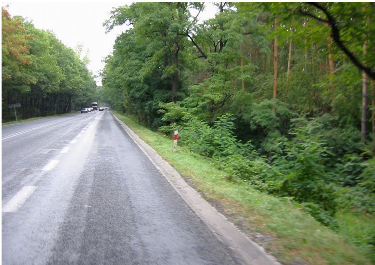
Rys. 7.2. Pobocze nieutwardzone — nie podlega ocenie (usytuowanie elementu odwodnienia, rynny ściekowej, bezpośrednio przy jezdni)
