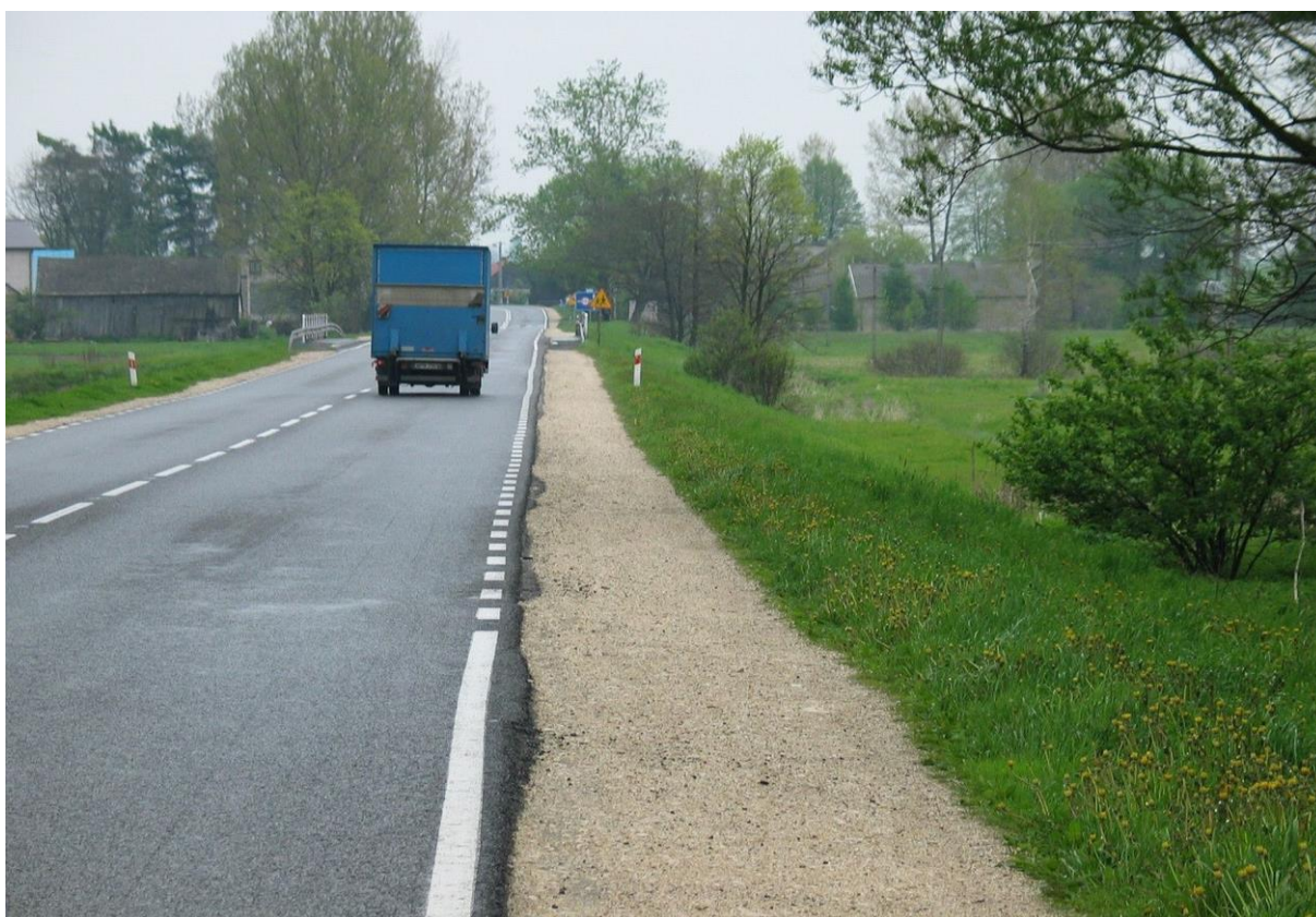
Rys. 5.12. Pobocze — stan niezadowalający
