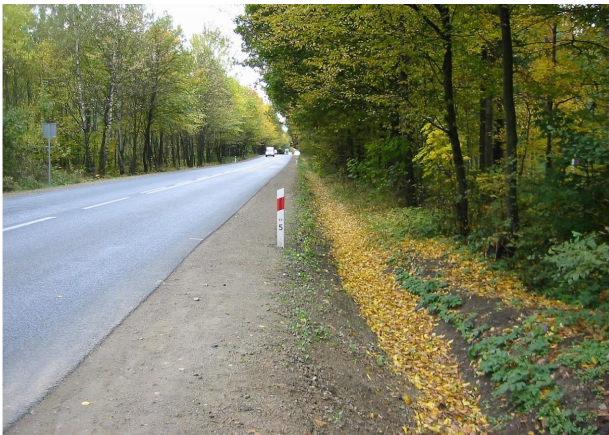
Rys. 5.10. Pobocze — stan zadowalający (uskok; nie przekracza 5 cm)
