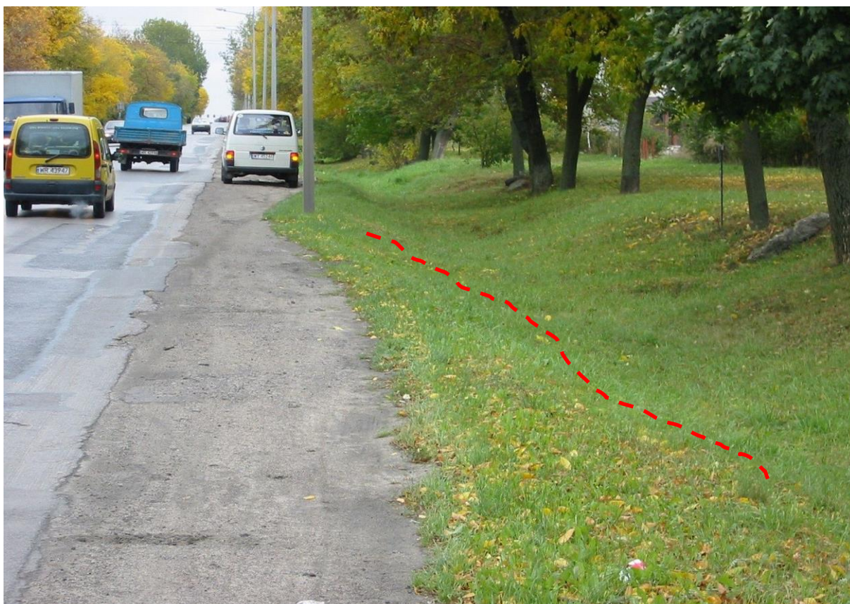
Rys. 4.22. Odwodnienie — stan niezadowalający (mulda o nieregularnej linii dna)
