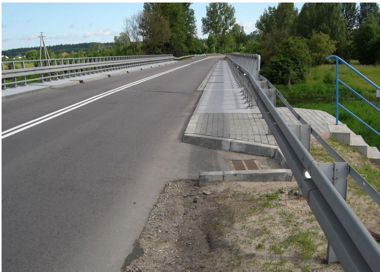
Rys. 6.7. Elementy odwodnienia na mostach — nie podlegają ocenie (jest to wykonywane w ramach przeglądów okresowych obiektów mostowych)
