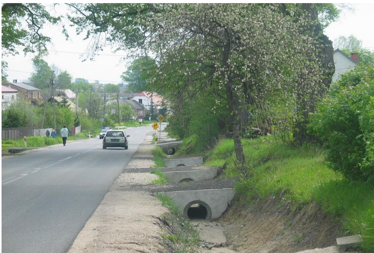
Rys. 4.10. Odwodnienie — stanie zadowalający (wyraźna linia rowu, przepust z widocznym prześwitem, zamulony do 15% wysokości przekroju; miejscowe nieznaczne zamulenie dna rowu)
