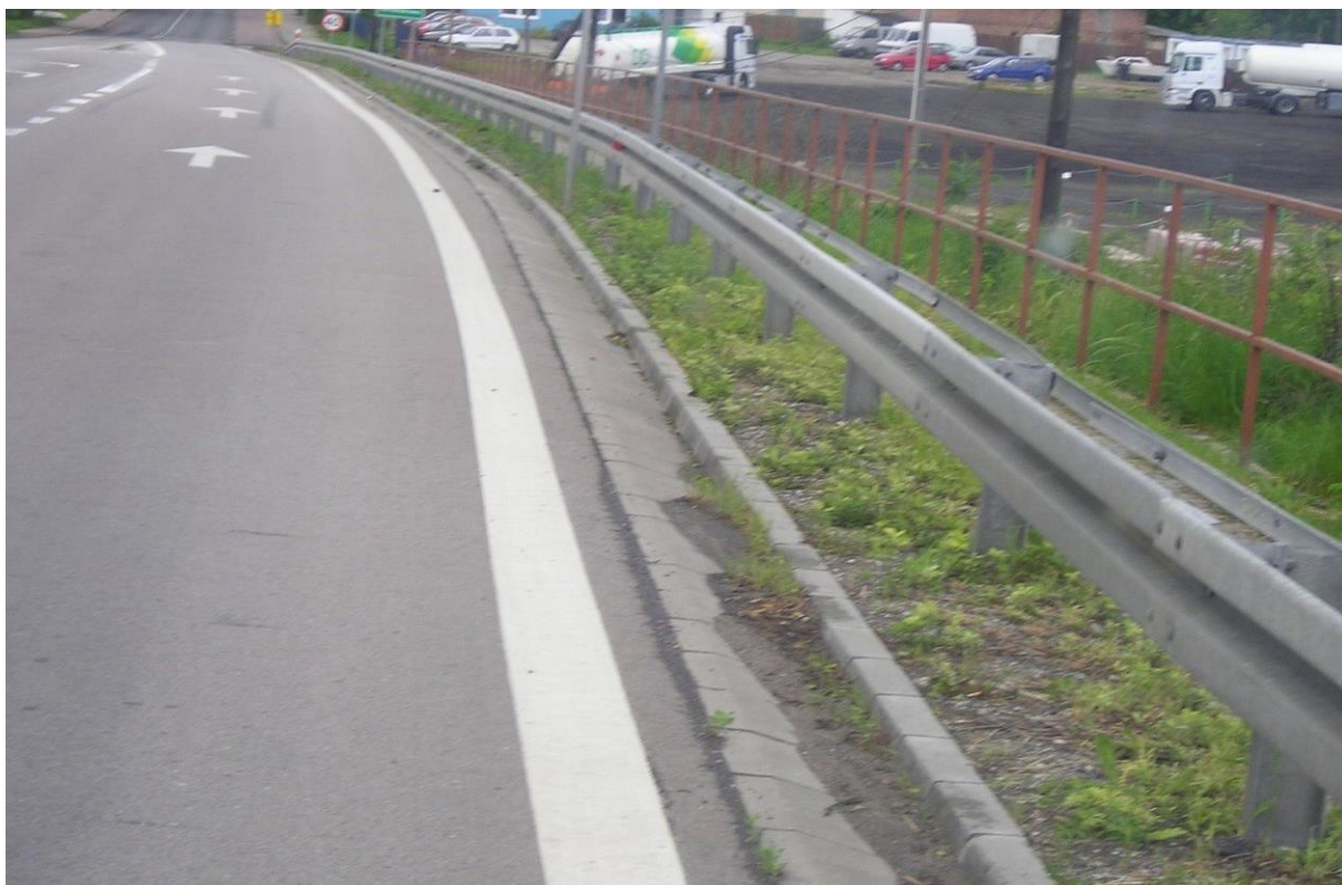
Rys. 4.16. Odwodnienie — stan zadowalający (rynna przykrawężnikowa miejscami zasypana piachem)
