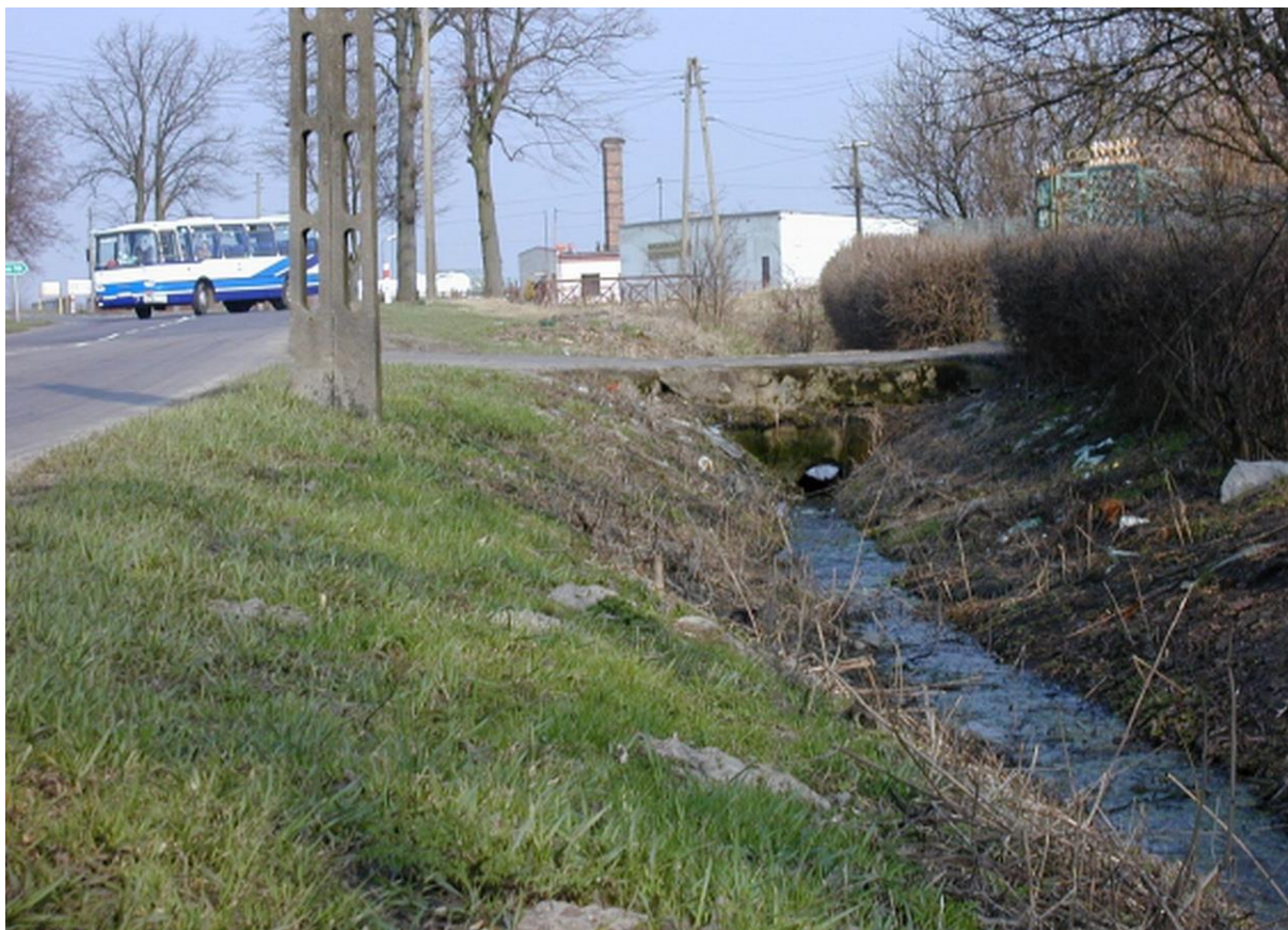
Rys. 4.21. Odwodnienie — stan niezadowalający (elementy odwodnienia częściowo zamulone oraz ograniczone światło przepustu do 30%)
