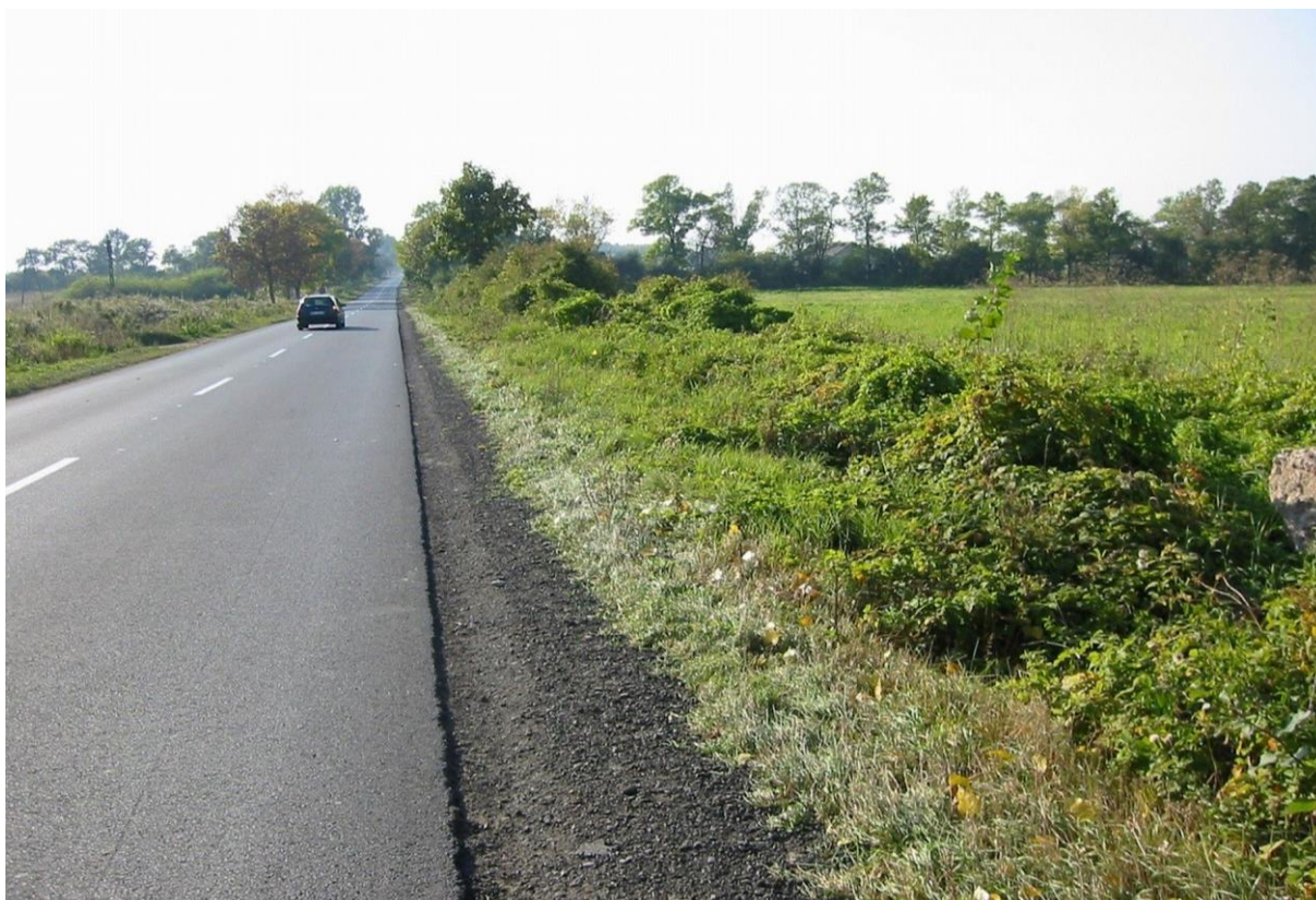
Rys. 5.21. Pobocze — stan niezadowalający (skoleinowane — pomimo wcześniejszego wykonania zabiegu uzupełnienia; dodatkowo widoczne odwodnienie w złym stanie technicznym)
