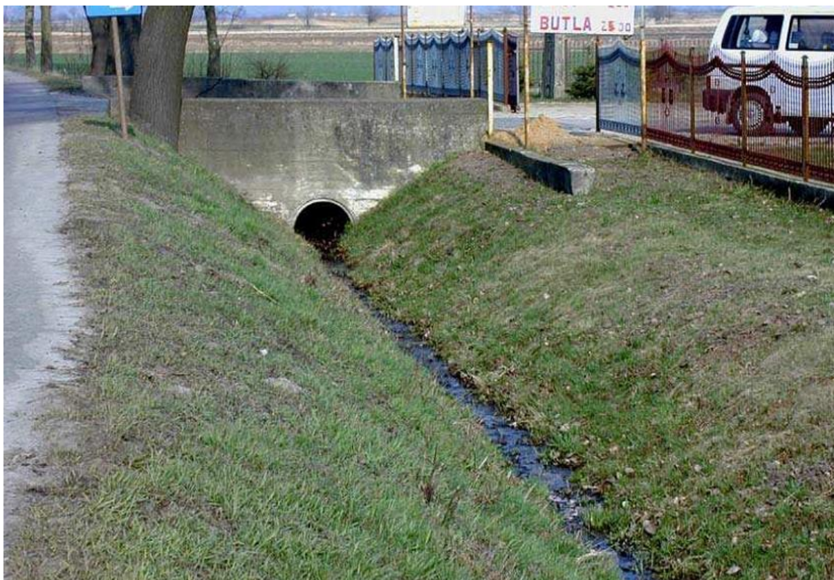
Rys. 6.11. Mimo niewielkiego zamulenia przepustu (rozpatrując wyłącznie wysokość zamulenia przekroju) światło przepustu jest ograniczone do 30% jego przekroju. W takim przypadku należy ocenić stan elementu jako niezadowalający
