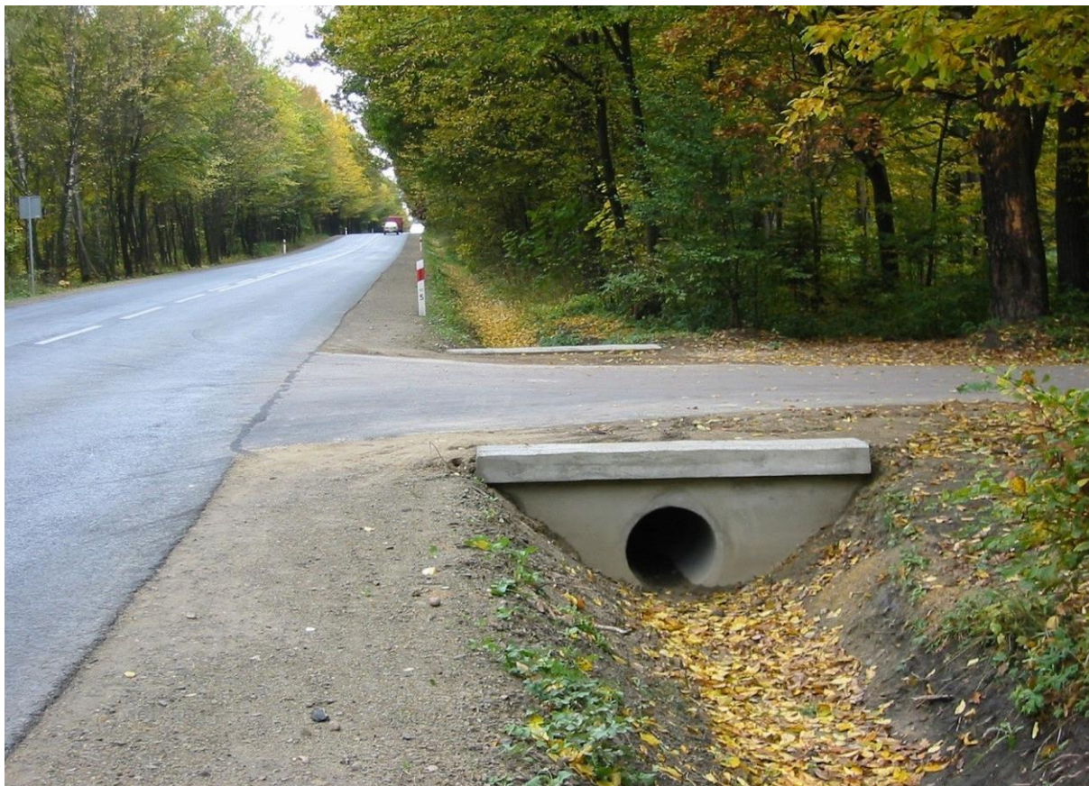
Rys. 4.7. Odwodnienie — stan dobry (przepust)
