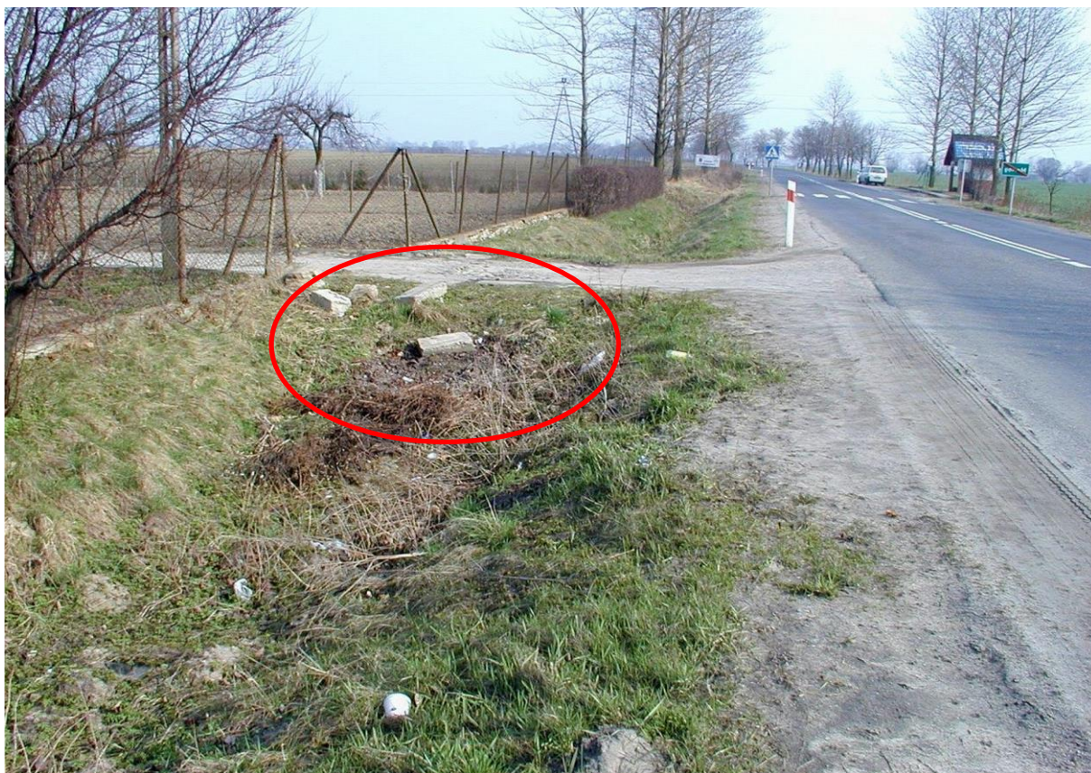
Rys. 6.6. Wystąpienie na ocenianym hektometrze, jednego niedrożnego przepustu — całemu hektometrowi pod względem odwodnienia należy przypisać stan zły
