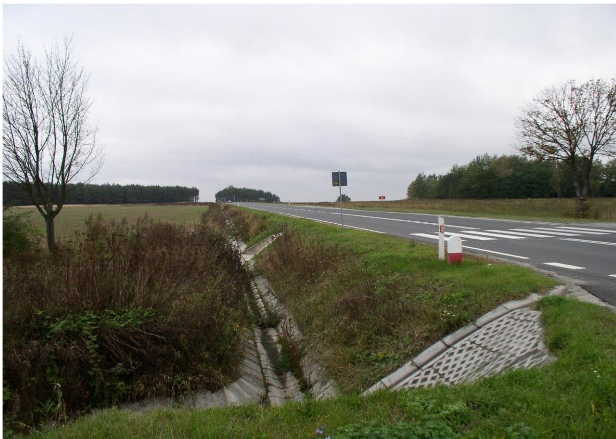
Rys. 4.12. Odwodnienie — stan zadowalający (pomimo roślinności pomiędzy prefabrykatami betonowymi)
