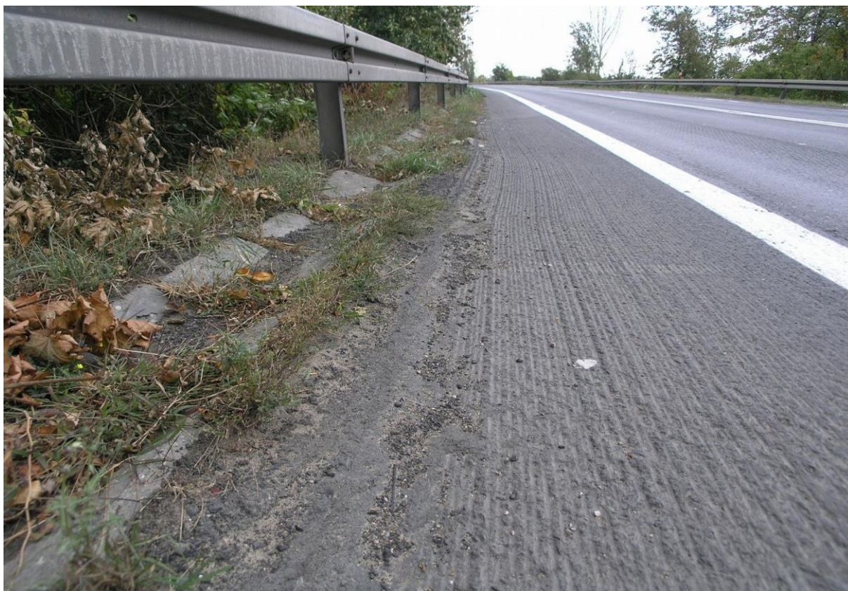
Rys. 4.23. Odwodnienie — stan zły (rynna odprowadzająca zasypana i uszkodzona)
