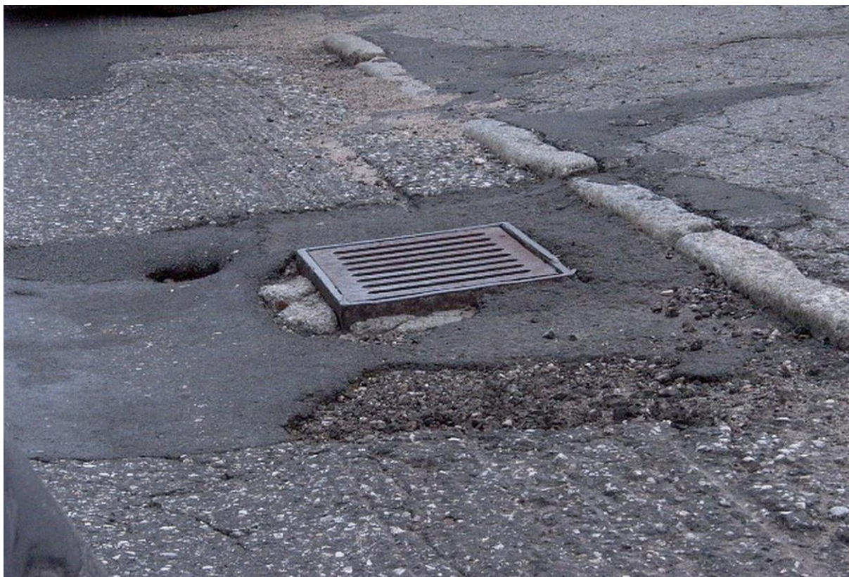
Rys. 4.38. Odwodnienie — stan zły (kratka studzienki zawyżona względem nawierzchni jezdni)
