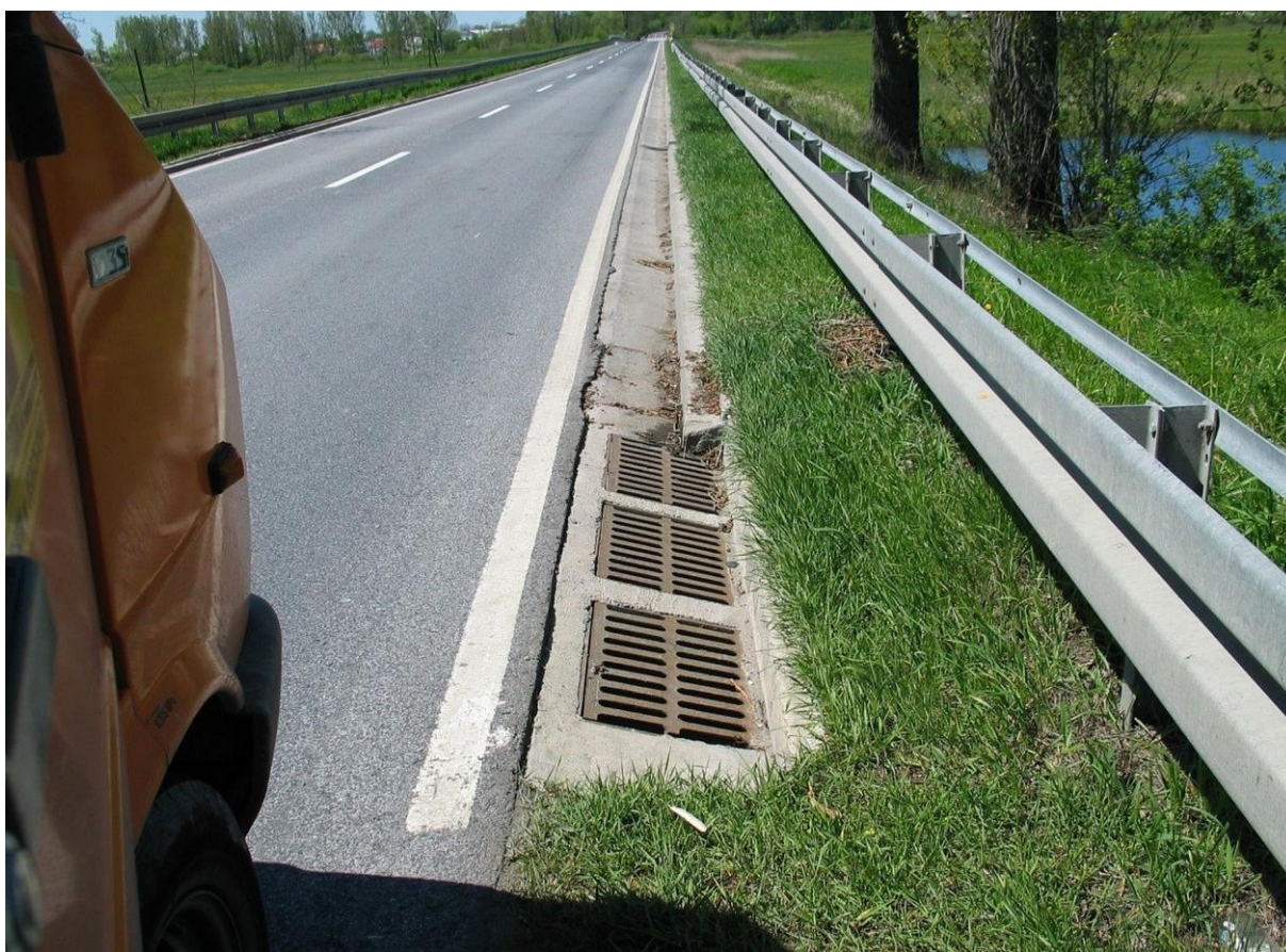
Rys. 4.4. Odwodnienie — stan dobry (rynna przykrawężnikowa zakończona wpustem z kratką ściekową)
