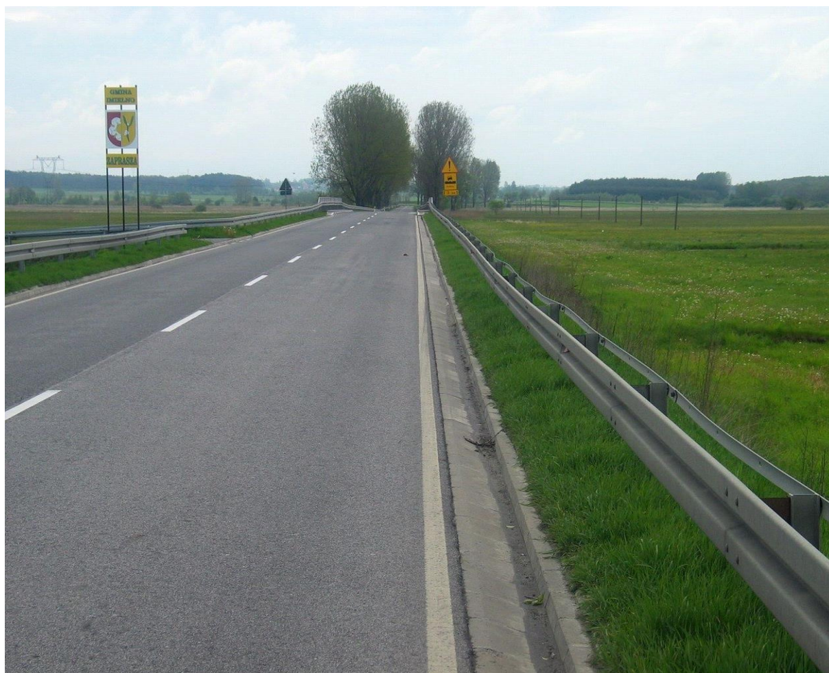
Rys. 7.1. Pobocze nieutwardzone — nie podlega ocenie (usytuowanie elementu odwodnienia, rynny ściekowej, bezpośrednio przy jezdni)
