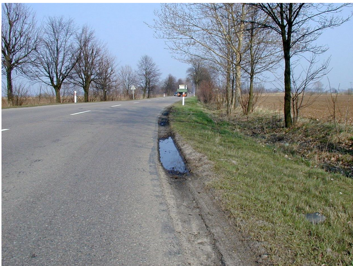
Rys. 5.22. Pobocze — stan zły (skoleinowane; odwodnienie w stanie niezadowalającym)
