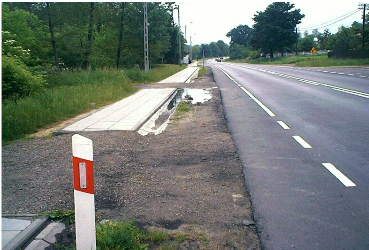
Rys. 4.36. Odwodnienie — stan zły (rynienka częściowo zasypana, niedrożna na kilku odcinkach)
