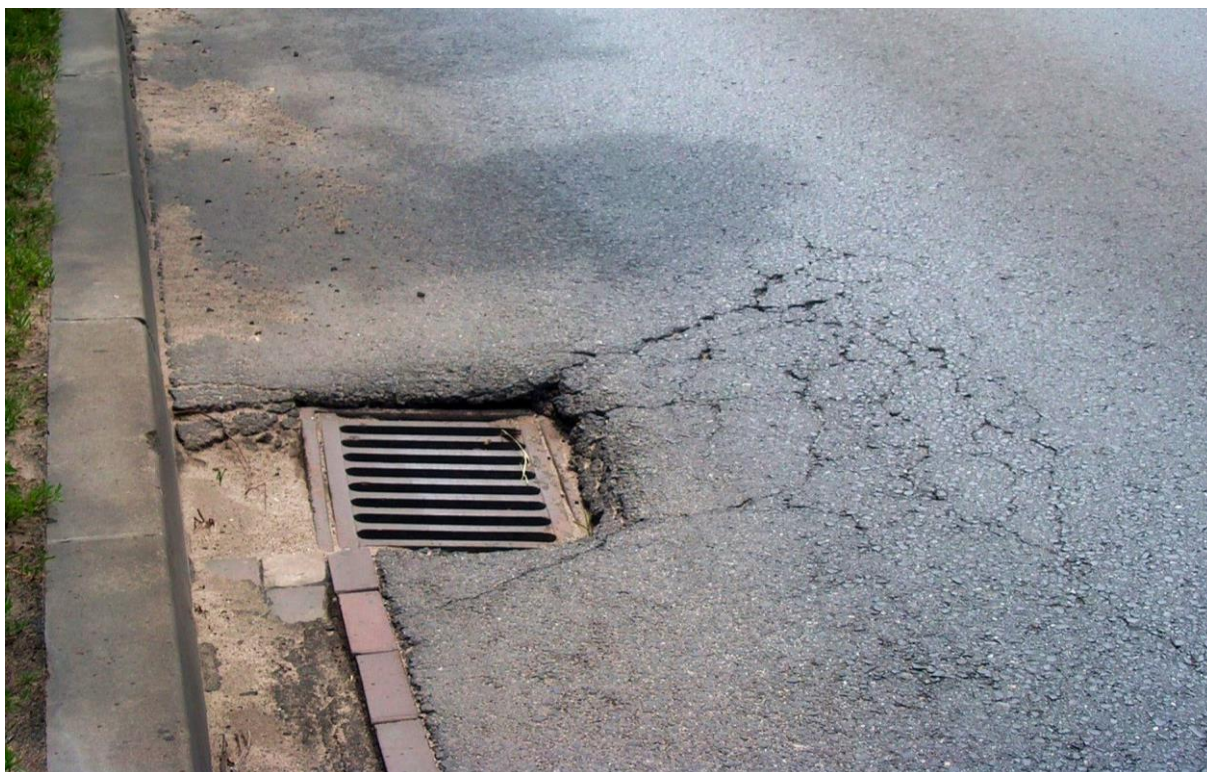
Rys. 4.34. Odwodnienie — stan zadowalający (mimo występujących spękań nawierzchnia wokół wpustu studzienki kanalizacyjnej, odwodnienie jest drożne, w formularzu oceny wpisać dodatkowy komentarz)
