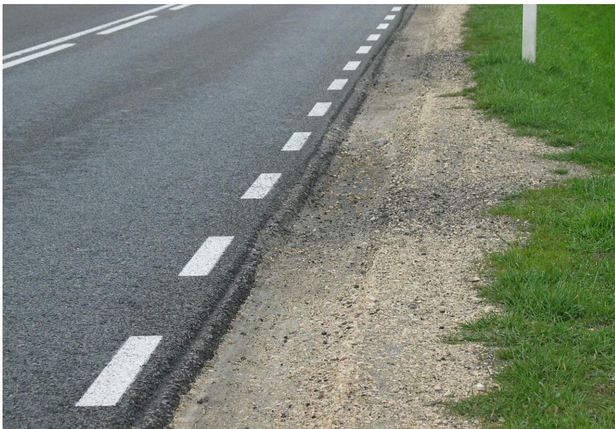
Rys. 5.11. Pobocze — stan niezadowalający (zaniżone; w przedziale 5–15 cm)
