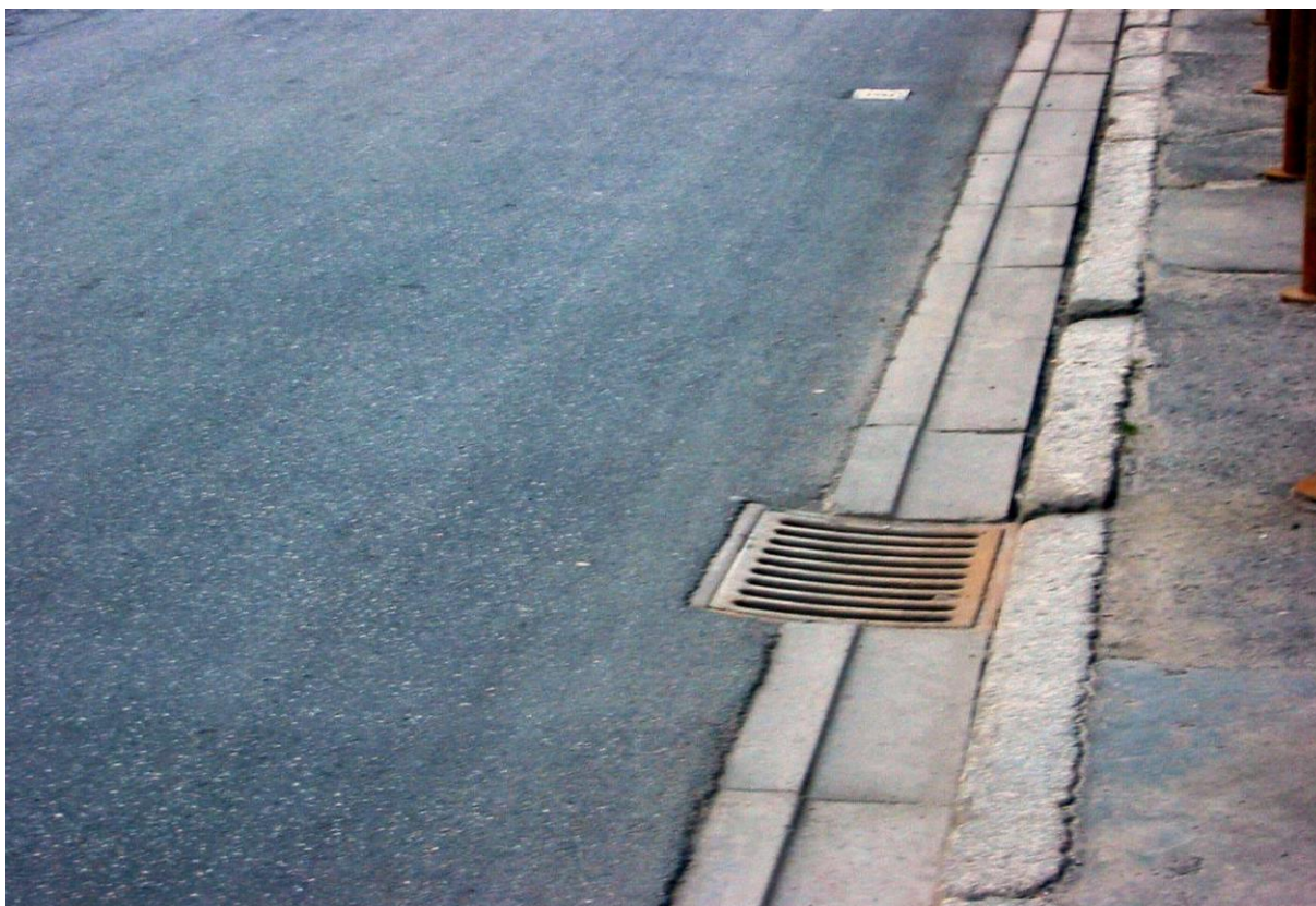
Rys. 4.32. Odwodnienie — stan dobry (rynna przykrawężnikowa wraz z kratką studzienki)
