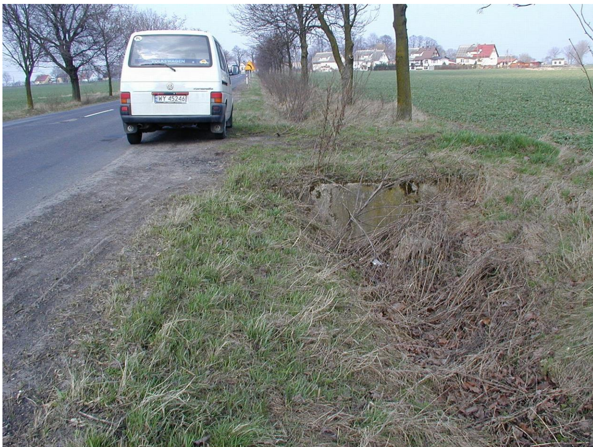
Rys. 4.25. Odwodnienie — stan zły (rów odwadniający z całkowicie zasypanym przepustem)
