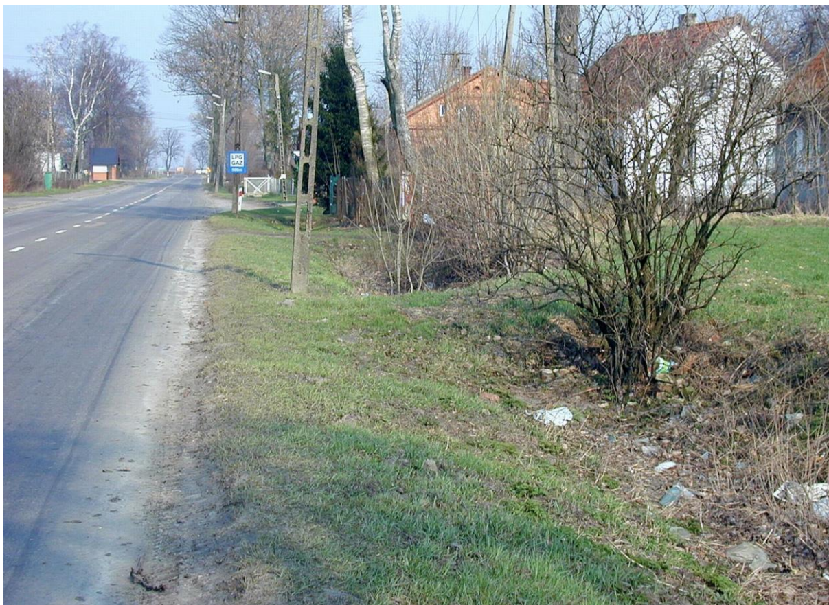
Rys. 4.30. Odwodnienie — stan zły (rów zasypany i zarośnięty niewielkimi drzewami)
