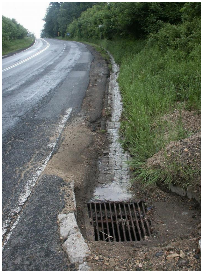
Rys. 4.15. Odwodnienie — stan zadowalający (rynna odprowadzająca nieznacznie zasypana piachem, zakończona wpustem z kratką ściekową spełniającą swoją funkcję)
