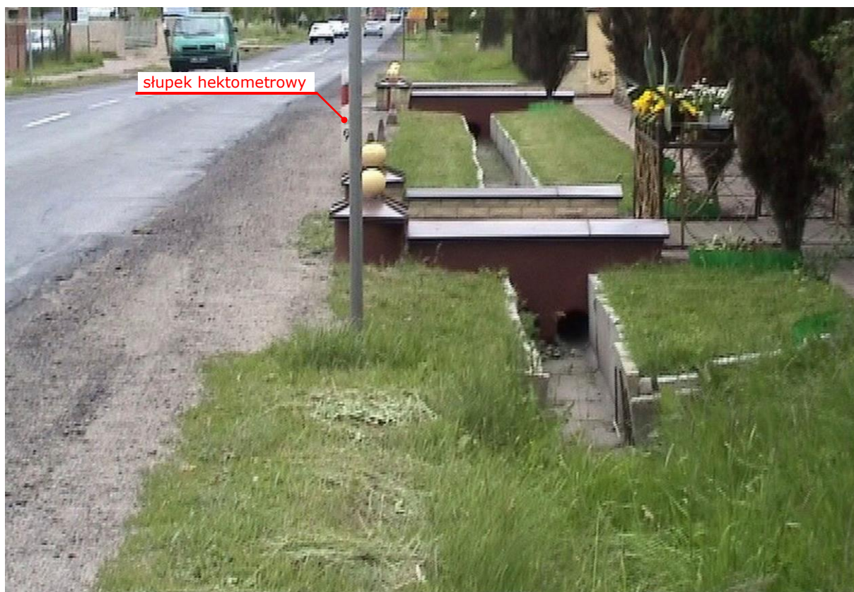
Rys. 6.13. Dwa kolejne hektometry w stanie złym — pomimo istniejących częściowo elementów odwodnienia (na początku i końcu brak ciągłości, rowy wymagają odtworzenia)
