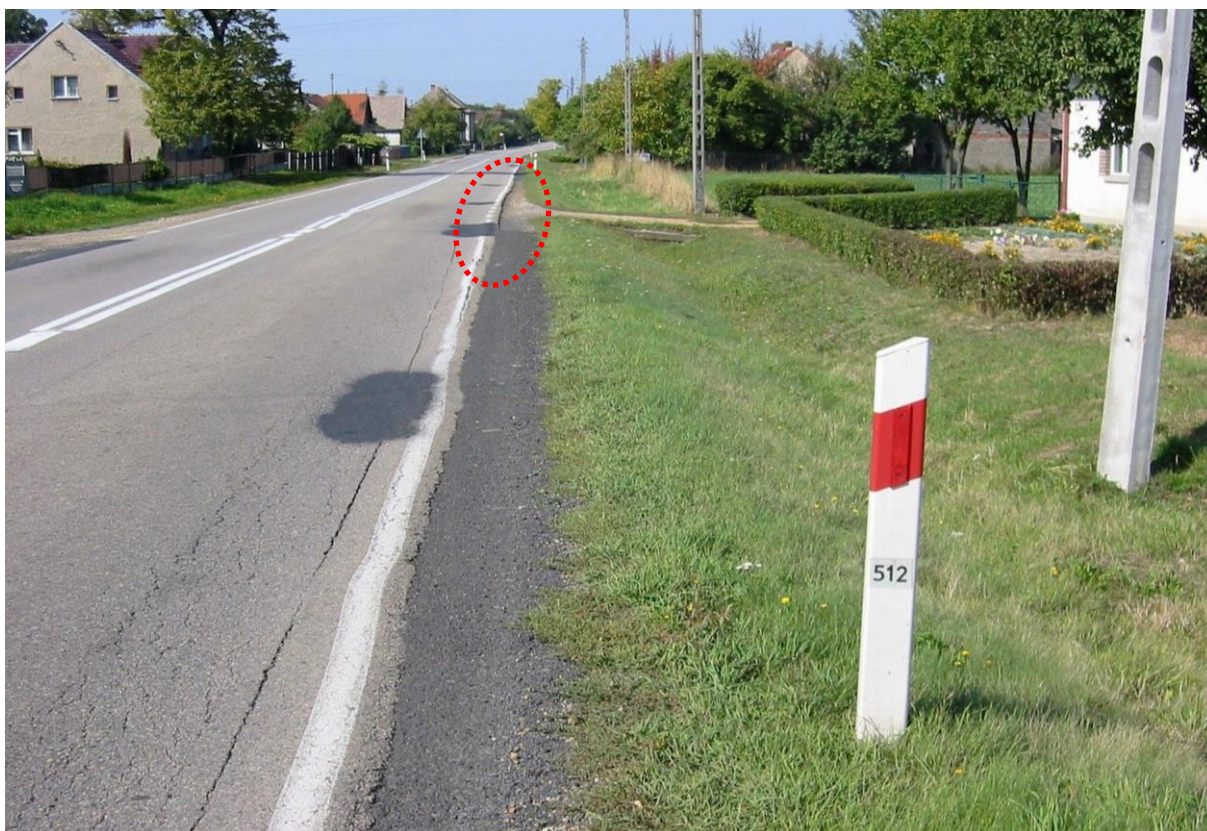
Rys. 5.8. Pobocze — na granicy stanu dobrego i zadowalającego (wyraźny uskok w dalszej, nieznacznej części hektometra)
