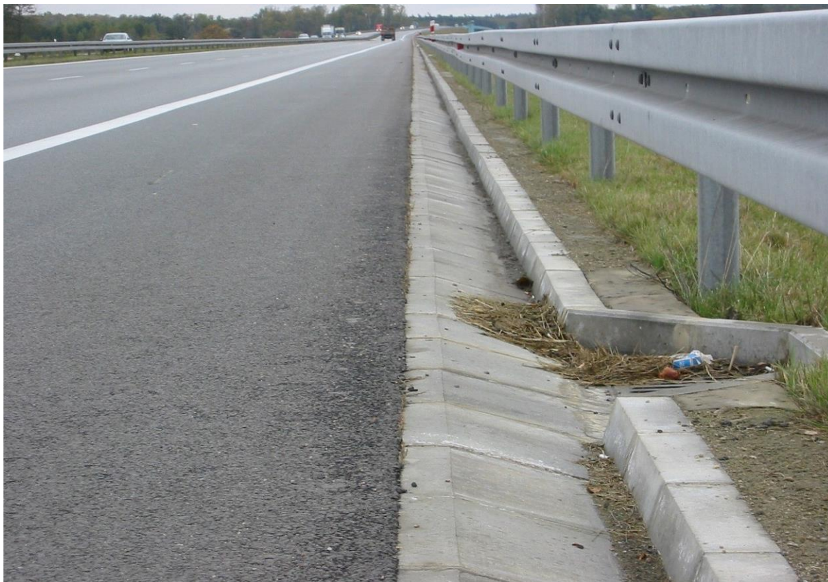
Rys. 4.5. Odwodnienie — stan dobry (pomimo zalegania niewielkiej ilości naniesionych zanieczyszczeń na części rynny odprowadzającej)
