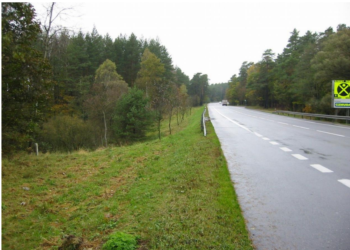
Rys. 6.9. Odwodnienie naturalne
