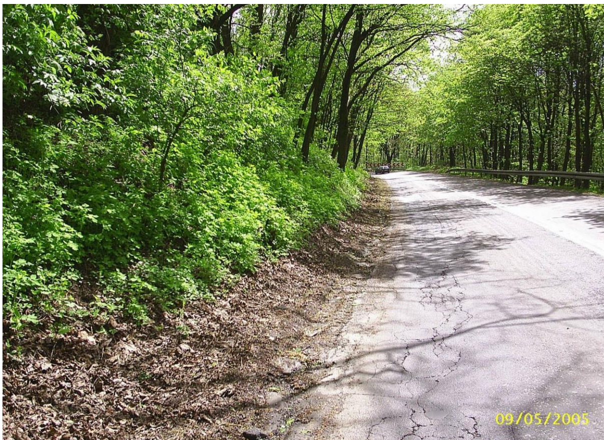
Rys. 4.29. Odwodnienie — stan zły (brak elementu odwodnienia; niezbędne indywidualne rozwiązanie)
