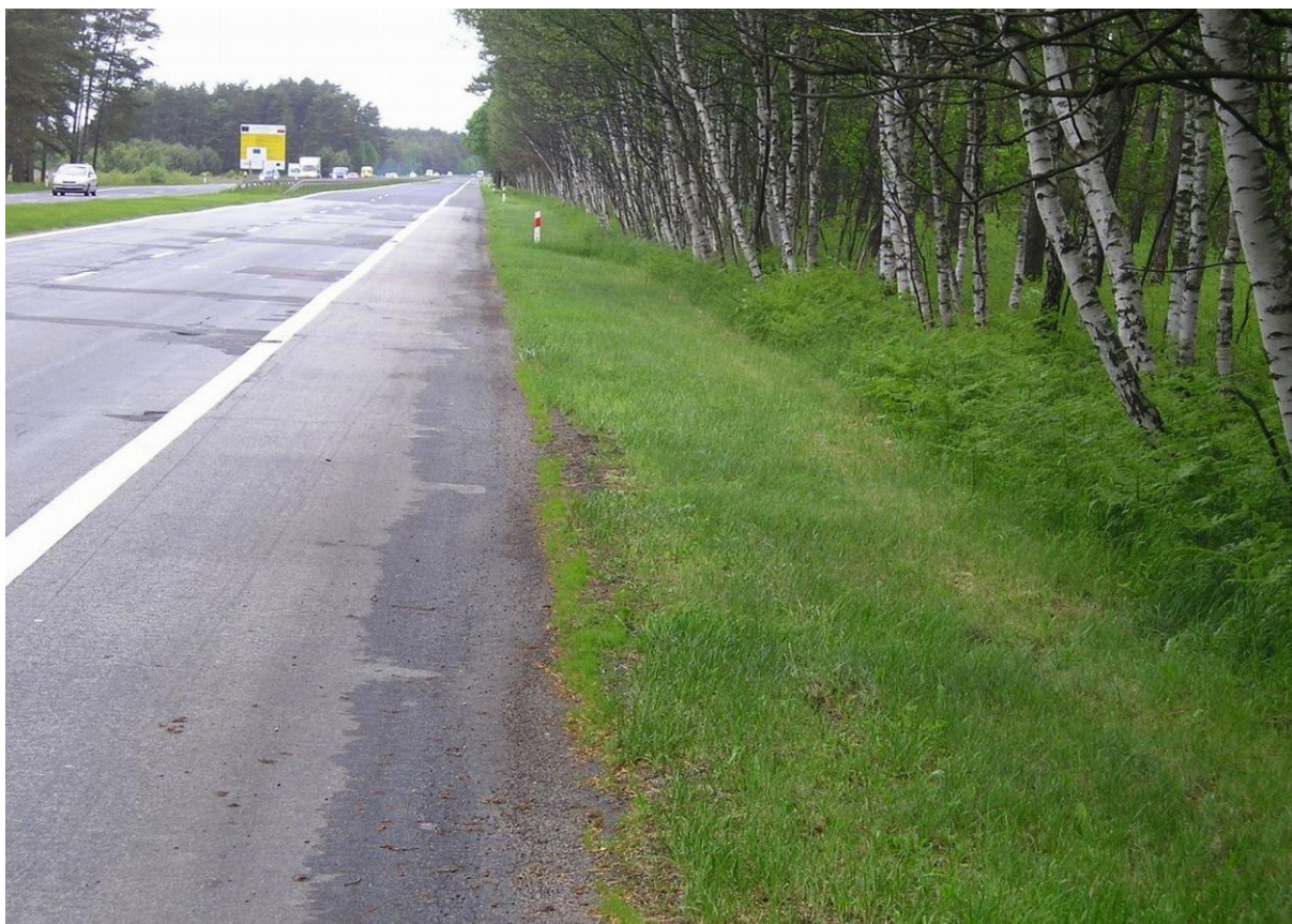
Rys. 7.4. Pobocze nieutwardzone — podlega ocenie (zlokalizowane za poboczami utwardzonymi, pasami dodatkowymi)
