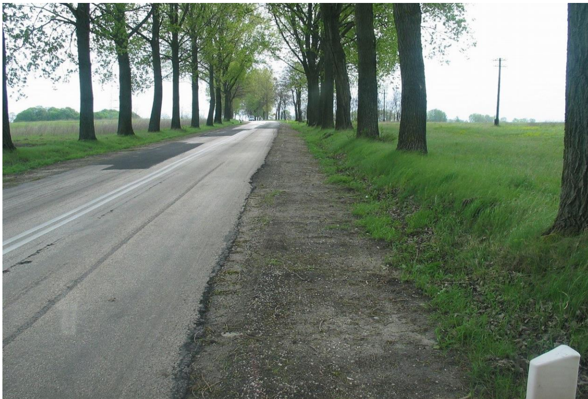
Rys. 5.13. Pobocze — stan niezadowalający (z wyraźnym uskokiem i licznymi uszkodzeniami krawędzi)
