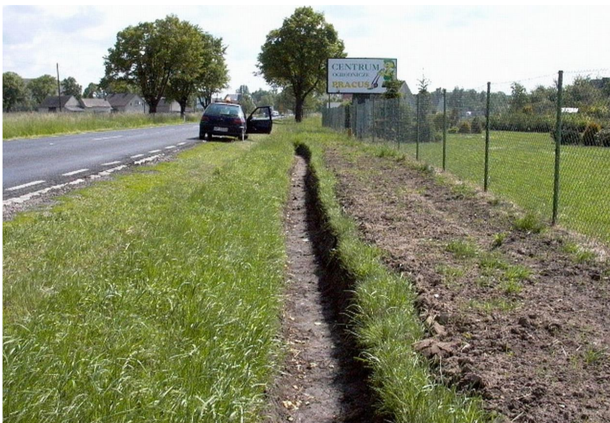
Rys. 6.12. Odwodnienie w stanie złym — prawdopodobnie tymczasowy element odwodnienia został wykonany przez właściciela przylegającej posesji
