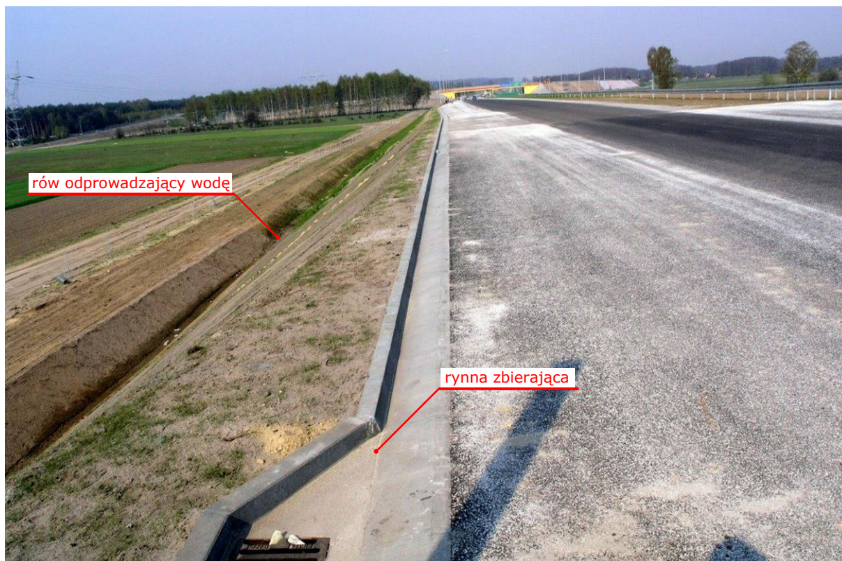
Rys. 6.2. Równoległe elementy odwodnienia wzdłuż drogi
