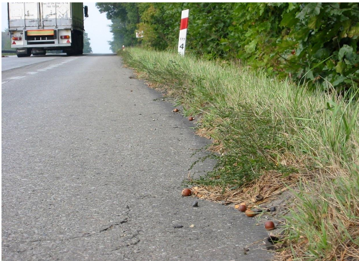
Rys. 5.17. Pobocze — stan zły (zawyżone; widoczne fragmenty gruntu znajdujące się na jezdni)
