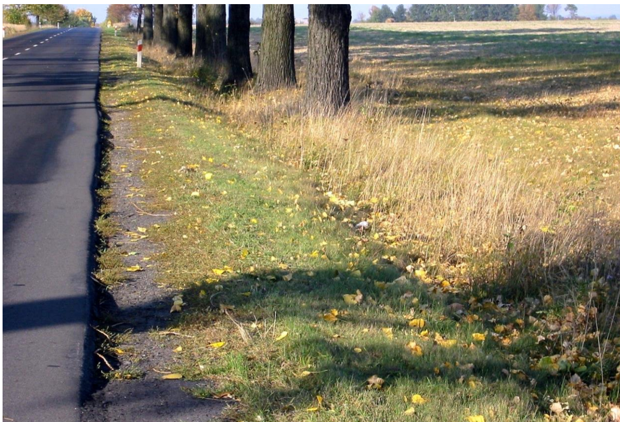
Rys. 5.14. Pobocze — stan zły (na pierwszym planie; przejście w stan niezadowalający w kolejnych dwóch hektometrach)
