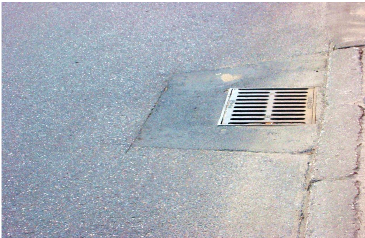
Rys. 4.33. Odwodnienie —stan dobry (studzienka po wykonanym remoncie)
