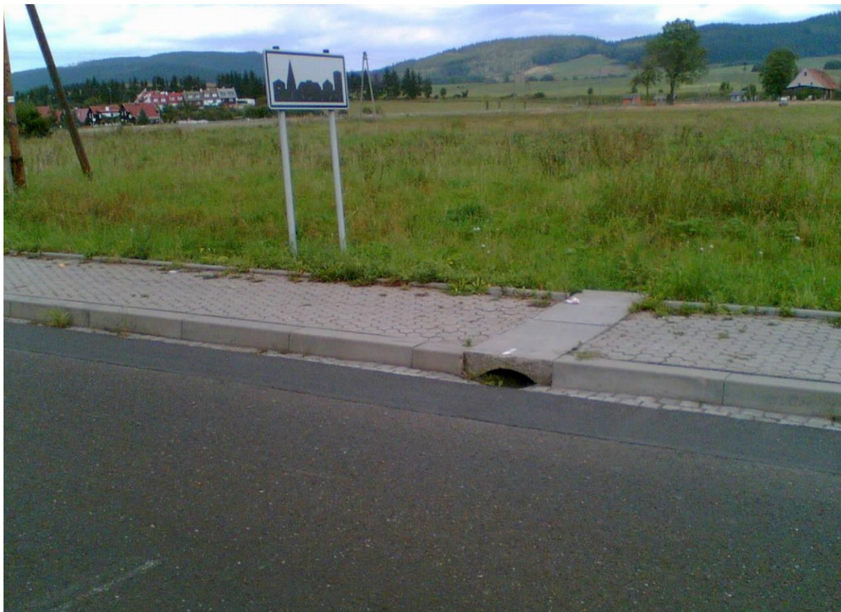
Rys. 6.3. Równoległe elementy odwodnienia — rynna w stanie zadowalającym, rów w stanie złym
