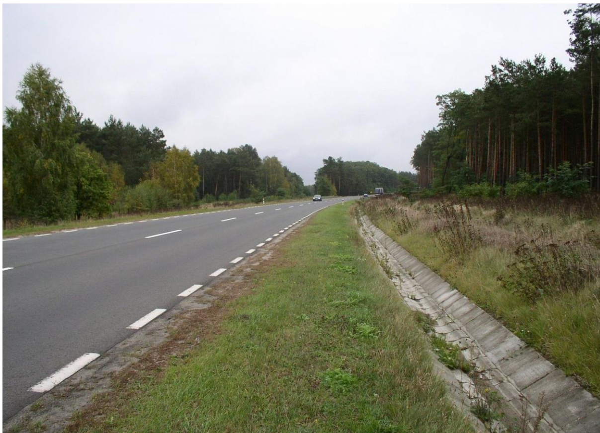
Rys. 4.11. Odwodnienie — stan zadowalający (między betonowymi prefabrykatami widoczne kępy roślinności, nie utrudniające odprowadzania wody)
