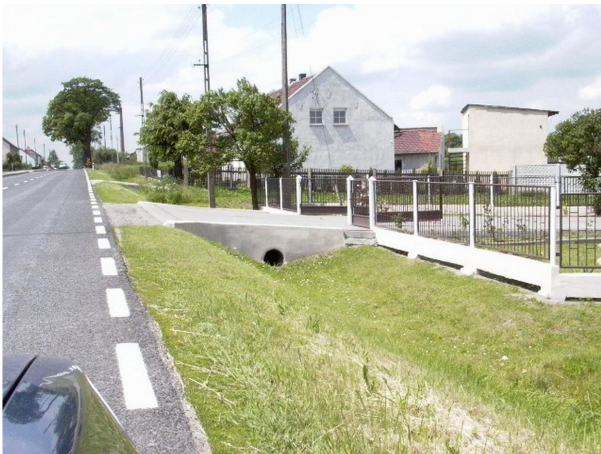
Rys. 4.13. Odwodnienie — stan zadowalający (wyraźna linia rowu oraz drożny przepust, zamulony poniżej 15% wysokości przekroju)
