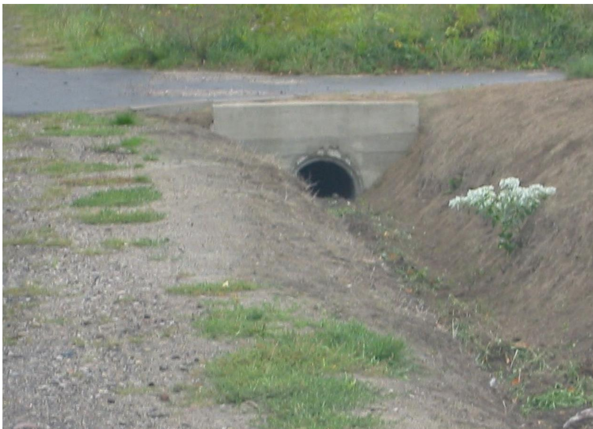
Rys. 4.19. Odwodnienie — stan niezadowalający (przepust zamulony powyżej 15% przekroju)
