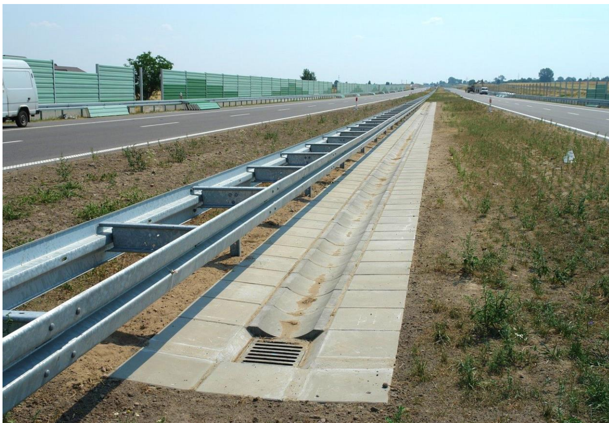
Rys. 6.14. Odwodnienie zlokalizowane w pasie rozdziálu — w przypadku braku możliwości dokonania oceny elementów zlokalizowanych wzdłuż lewego pasa jezdni w wypełnianym formularzu należy pozostawić pustą rubrykę oznaczającą brak oceny
