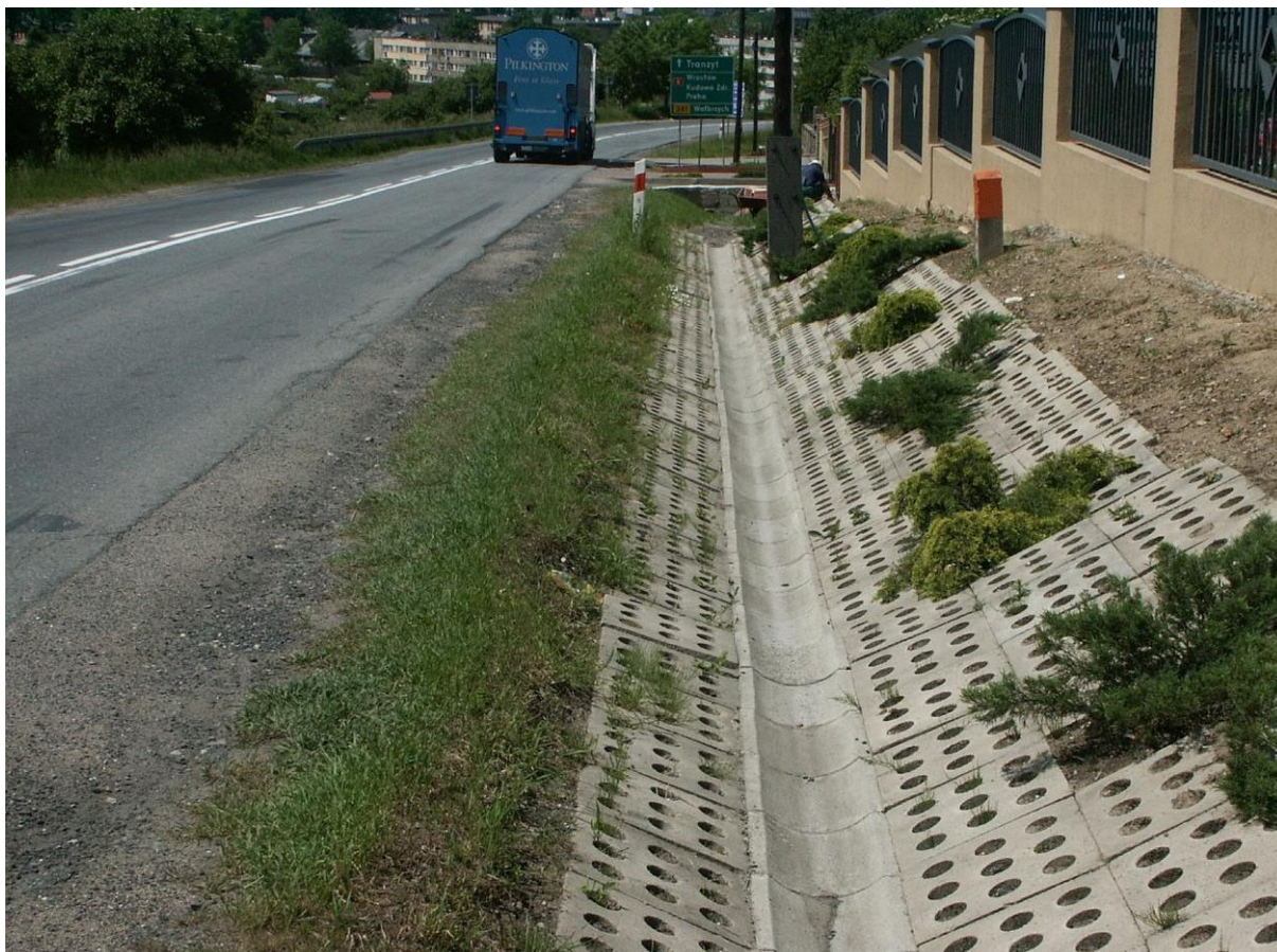
Rys. 4.2. Odwodnienie — stan dobry (odnowiony ciąg odwodnienia)
