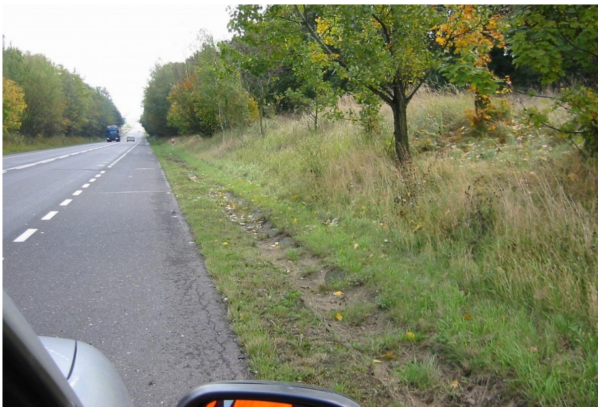
Rys. 4.18. Odwodnienie — stan niezadowalający (rynna odprowadzająca zasypana, zarośnięta kępami roślinności)
